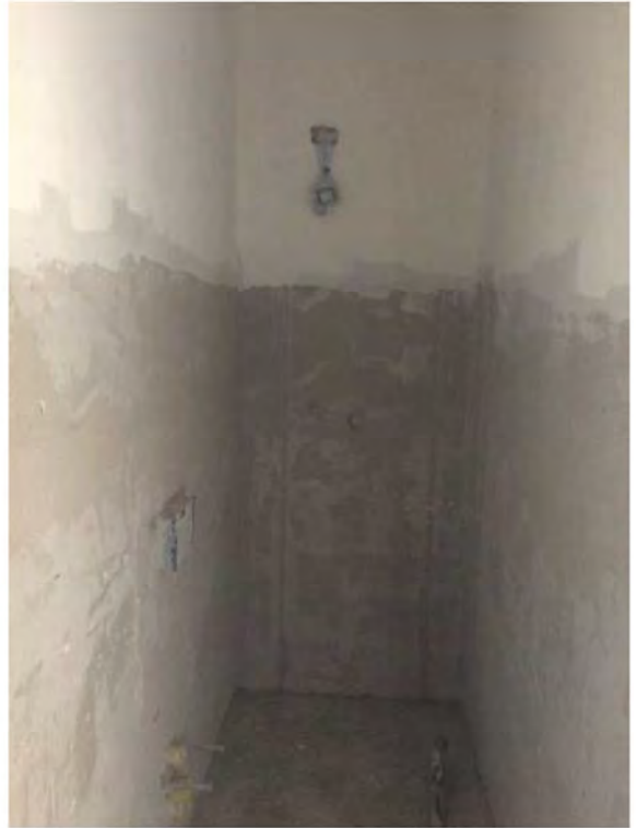
FOTO 88: PIANO PRIMO SOTTOSTRADA-BAGNO
