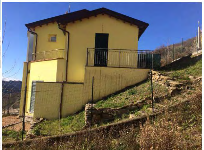
FOTO 81: VEDUTA ESTERNA LATERALE
