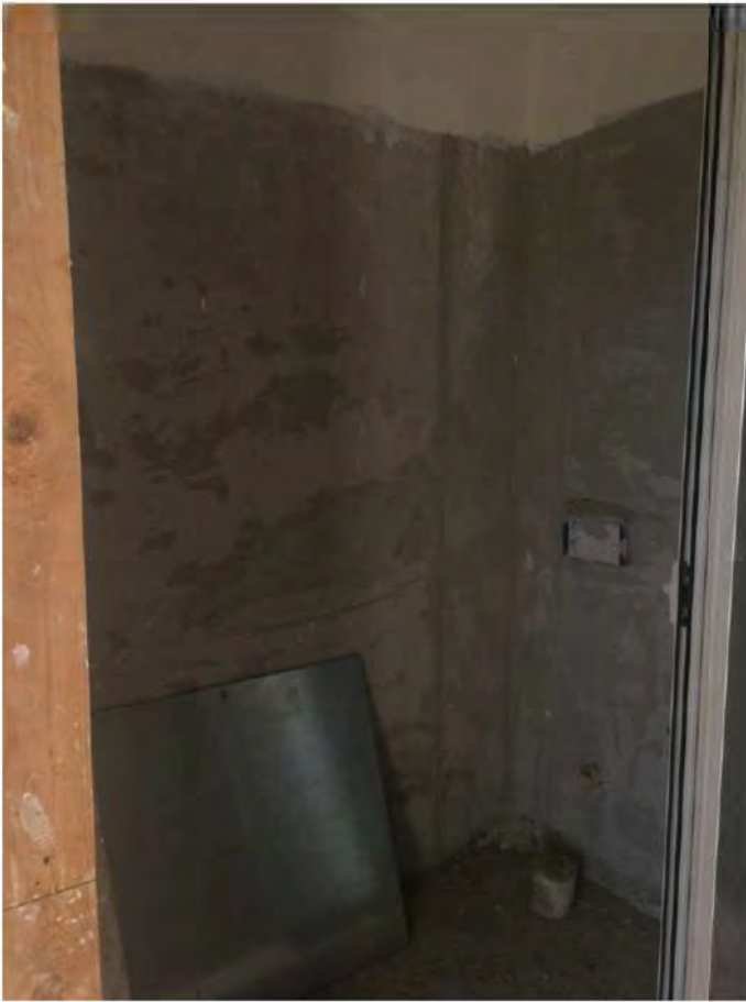
FOTO 92: PIANO TERRA - BAGNO
