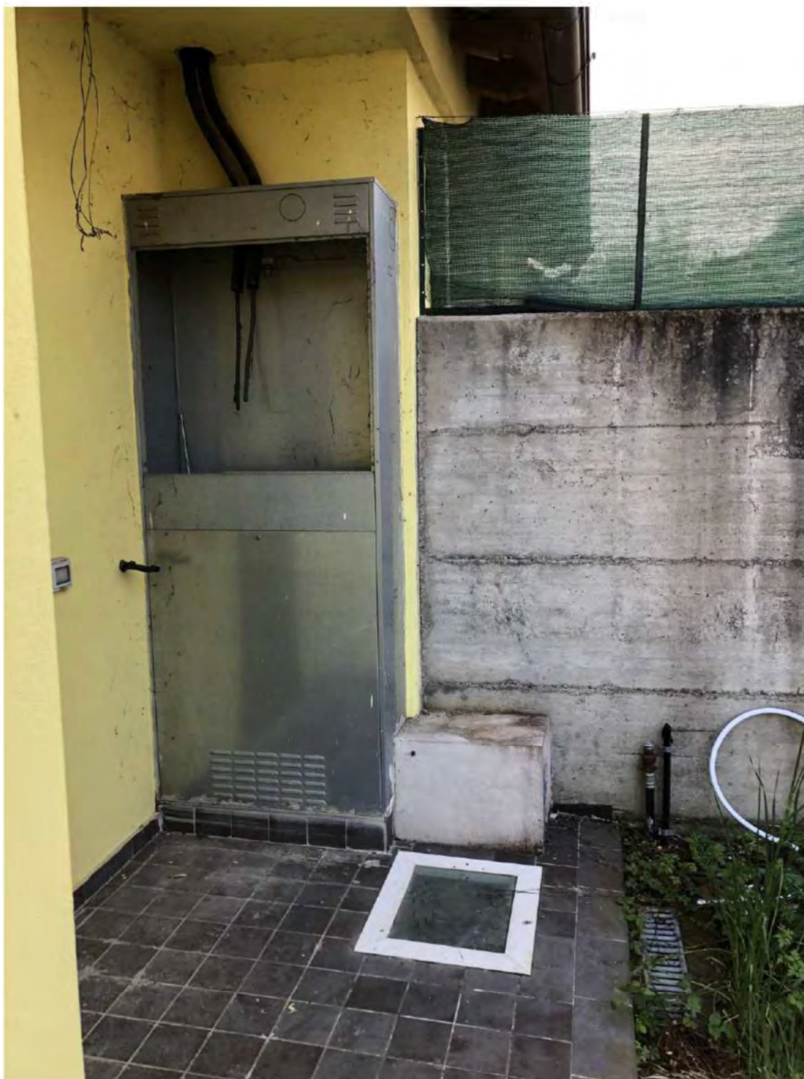
FOTO 96: PORTICO ESTERNO – ALLOGGIO CALDAIA
