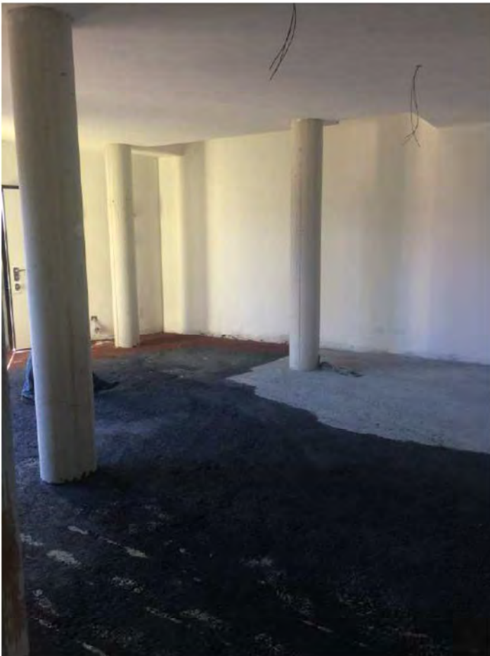
FOTO 89: PIANO PRIMO SOTTOSTRADA-
