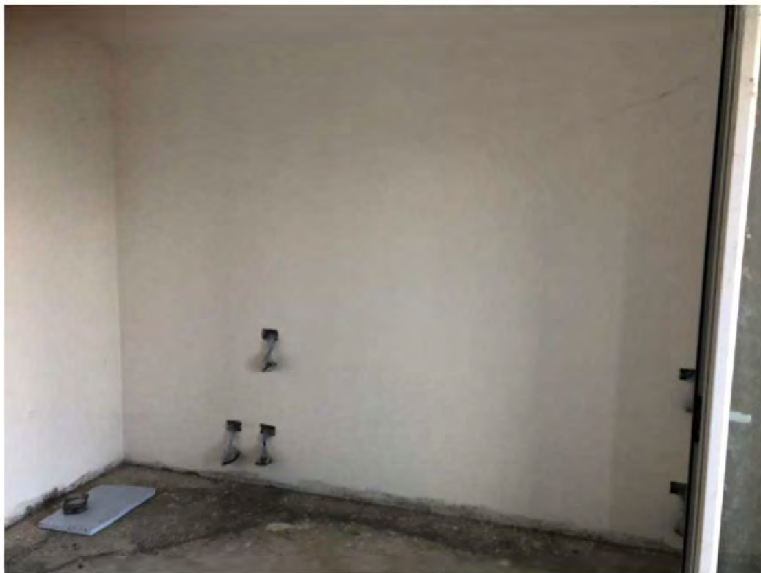
FOTO 94: PIANO TERRA - CUCINA
