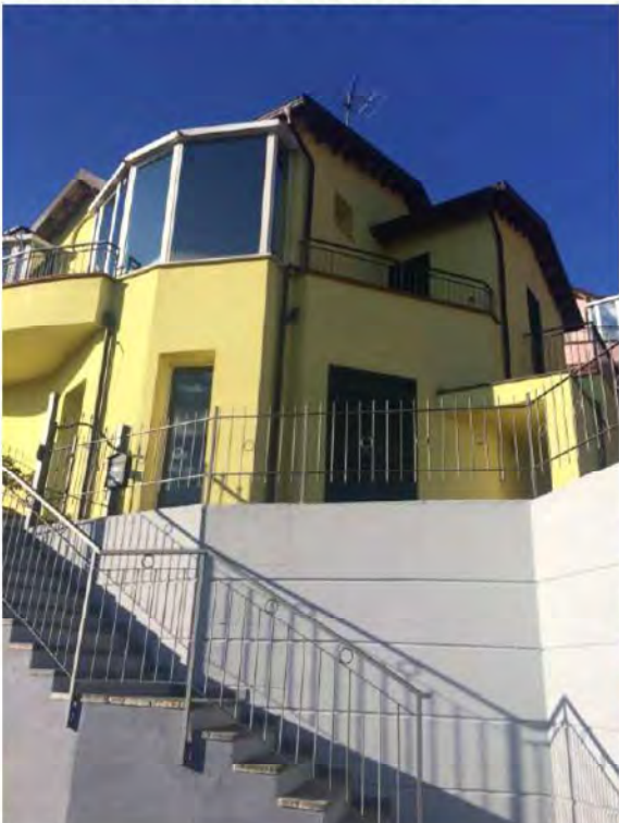
FOTO 80: VEDUTA DA SOTTO
