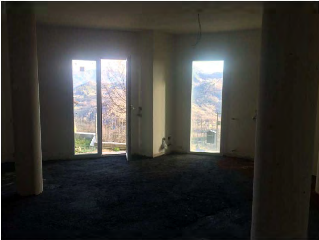
FOTO 85: VISTA INTERNA - PIANO PRIMO SOTTOSTRADA
