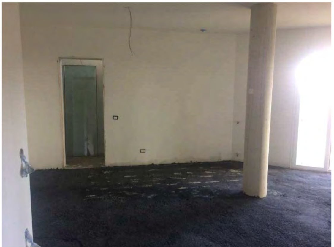
FOTO 86: VISTA INTERNA - PIANO PRIMO SOTTOSTRADA
