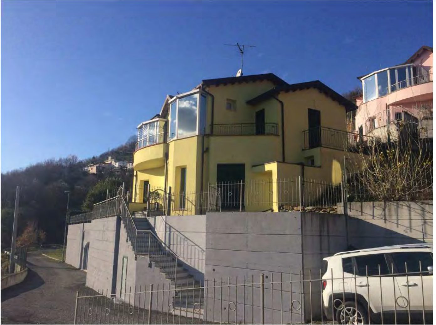
FOTO 79: VISTA DA SOTTO - PROSPETTO ESTERNO
