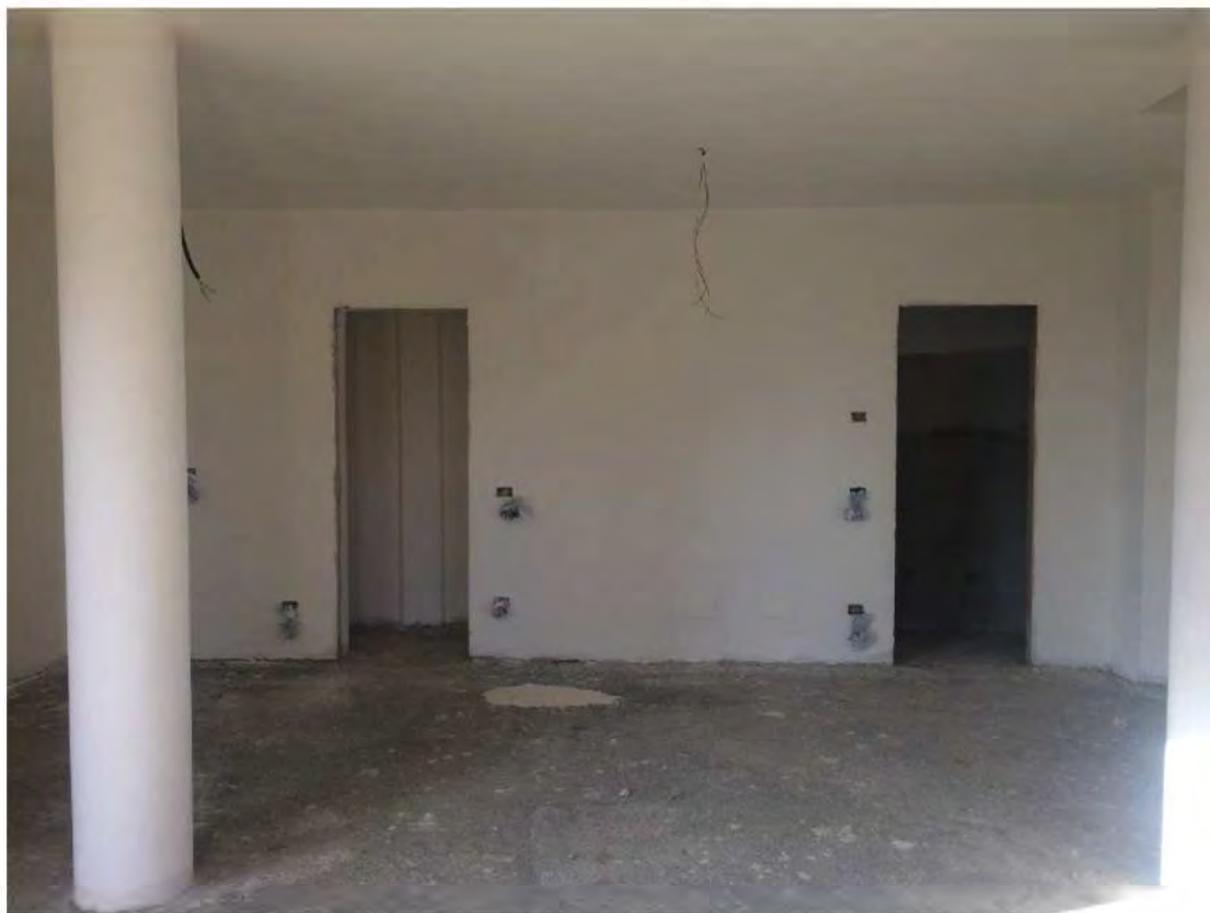
FOTO 104 - VISTA INTERNA - PIANO PRIMO SOTTOSTRADA
