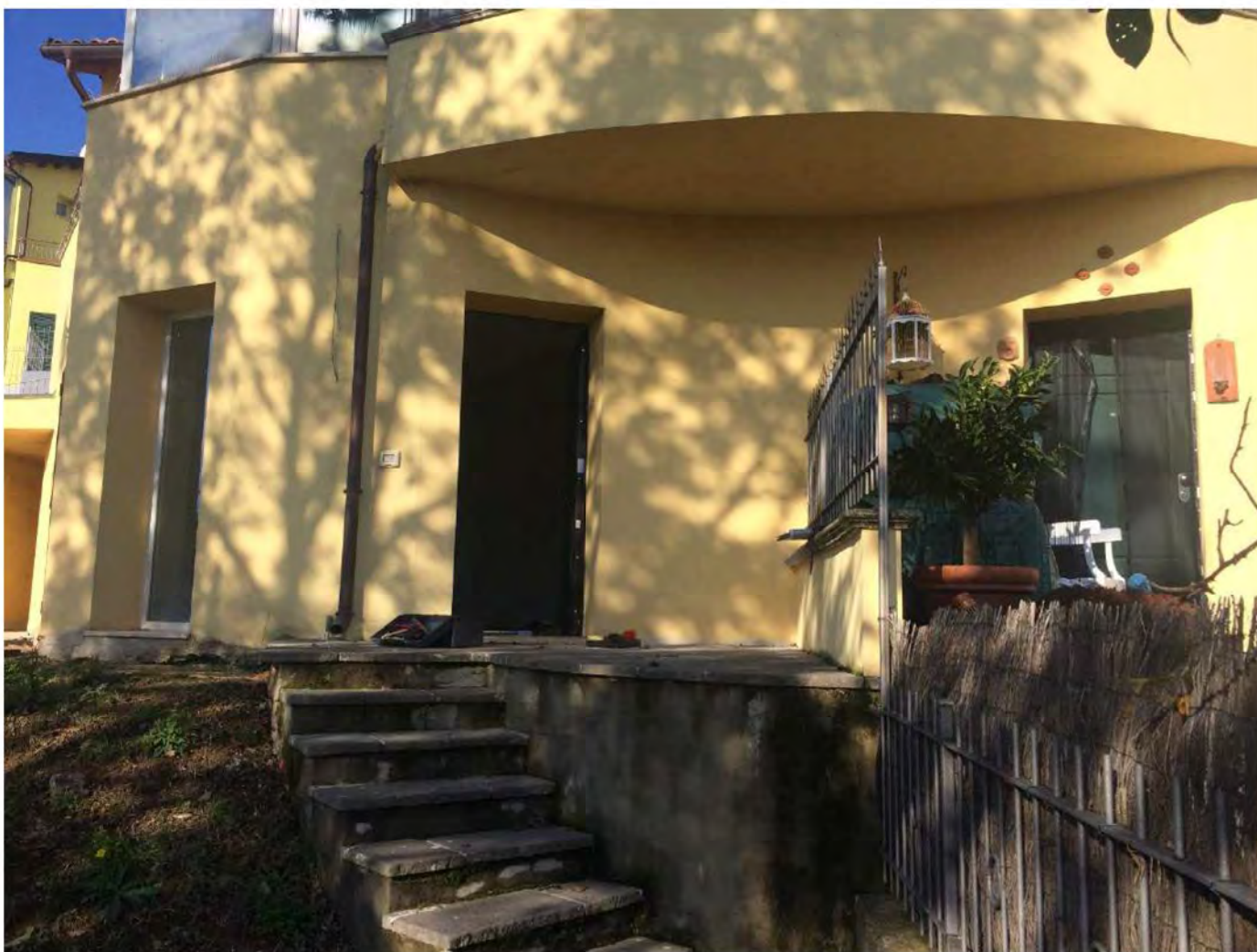
FOTO 100 - VISTA ESTERNA - INGRESSO PIANO PRIMO SOTTOSTRADA
