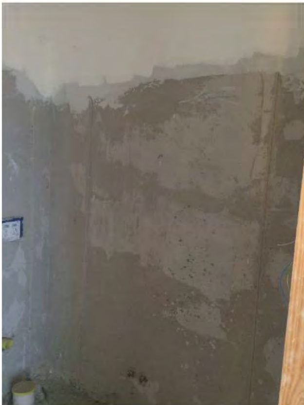
FOTO 117: PIANO TERRA - BAGNO
