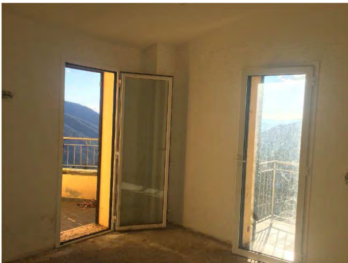
FOTO 112: PIANO TERRA - CUCINA
