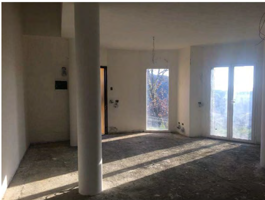
FOTO 105 - VISTA INTERNA -PIANO PRIMO SOTTOSTRADA
