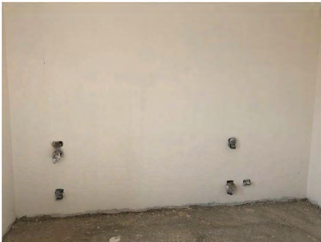
FOTO 115: PIANO TERRA - CUCINA
