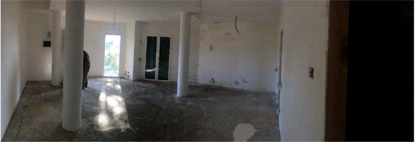
FOTO 109 -PIANO PRIMO SOTTOSTRADA
