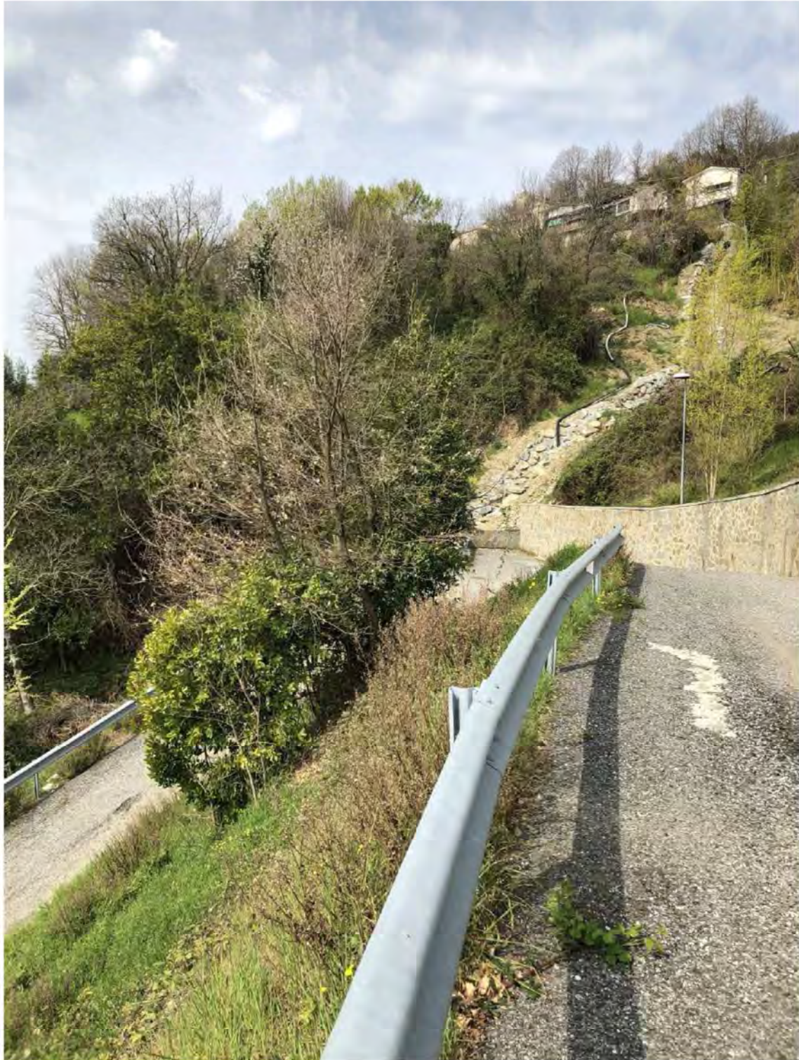
FOTO 144 – TORNANTE DELLA STRADA DI ARRIVO ALLE ABITAZIONI
