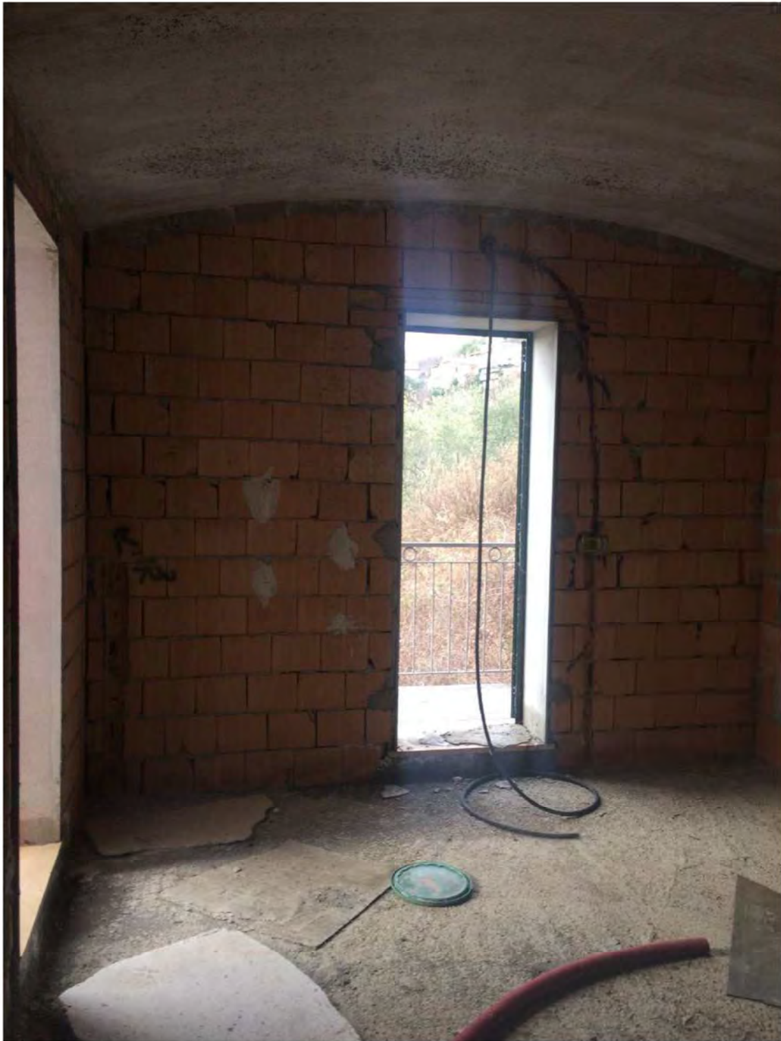
FOTO 7 -PIANO TERRA (CUCINA)
