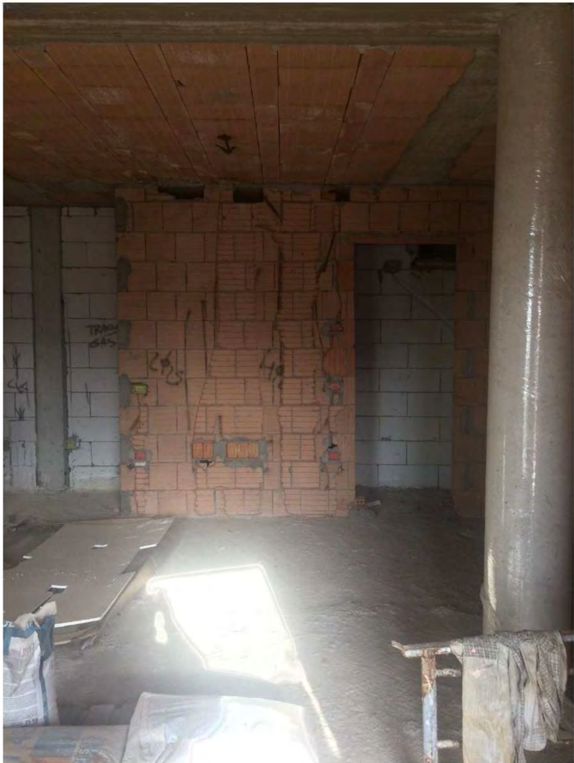
FOTO 4 -PIANO PRIMO SOTTOSTRADA
