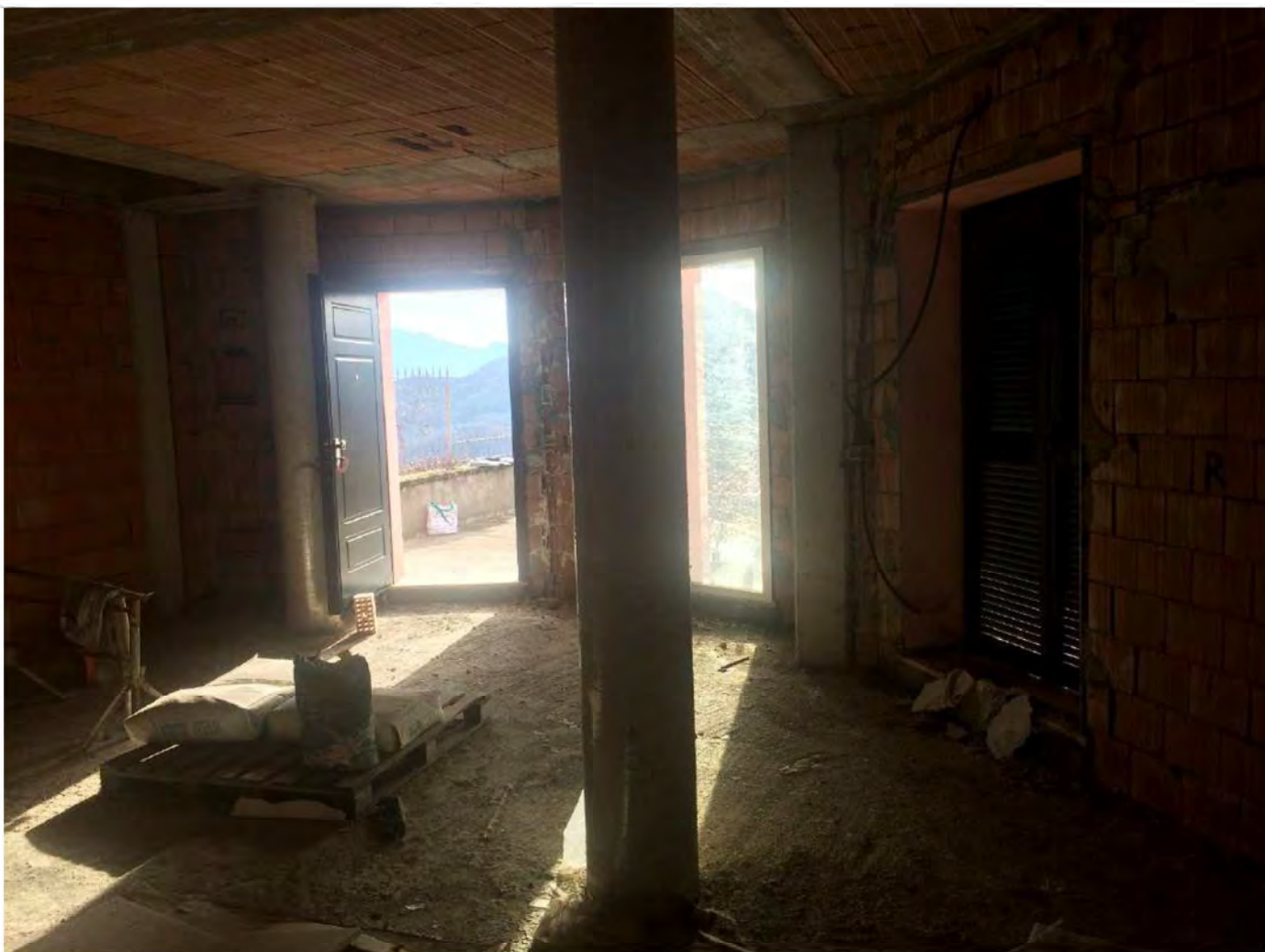
FOTO 5 -PIANO PRIMO SOTTOSTRADA
