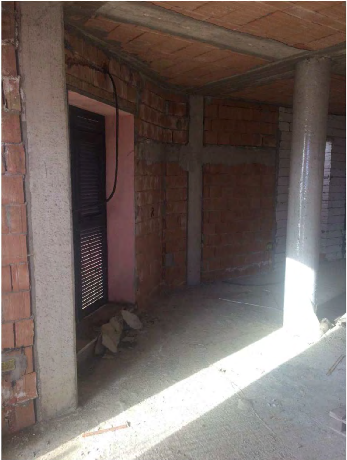
FOTO 2 -PIANO PRIMO SOTTOSTRADA
