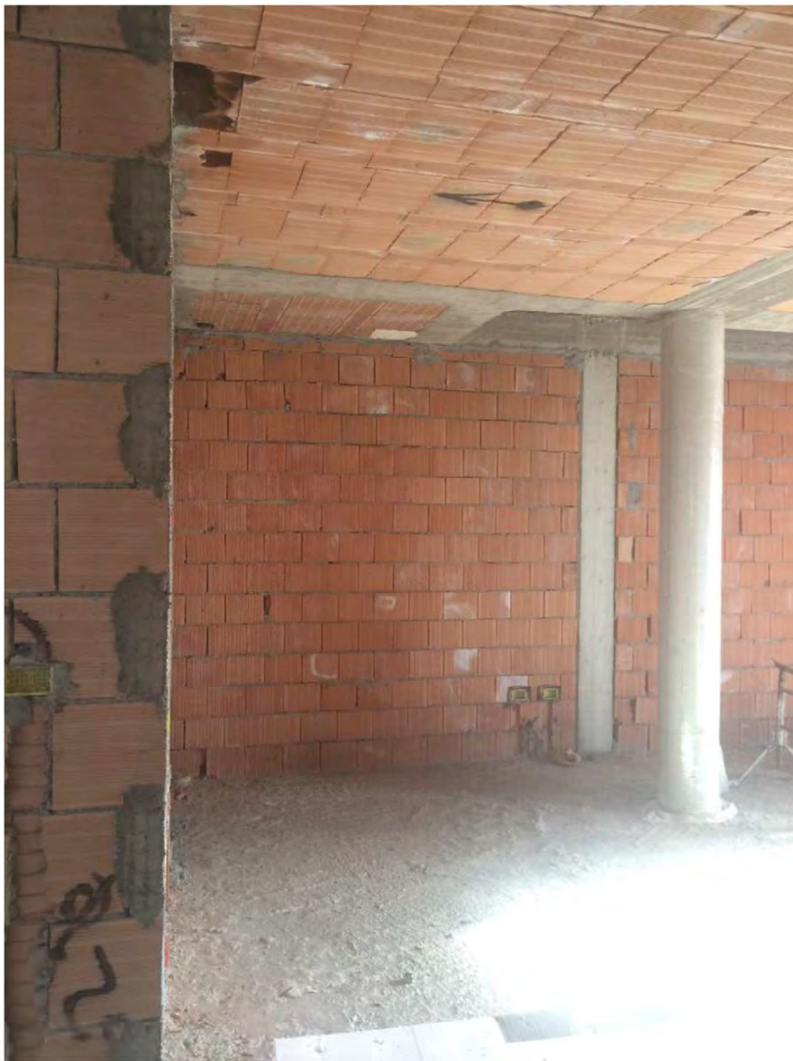
FOTO 3 -PIANO PRIMO SOTTOSTRADA
