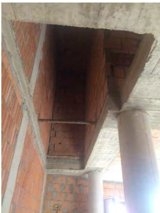
FOTO 6 -PIANO PRIMO SOTTOSTRADA
