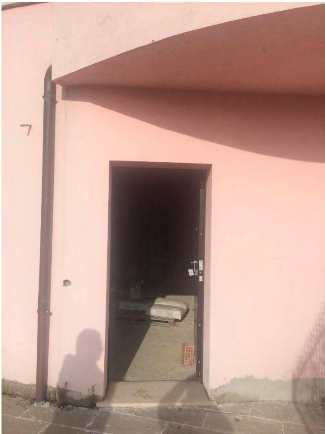
FOTO 1 - PORTONE DI INGRESSO - PIANO PRIMO SOTTOSTRADA
