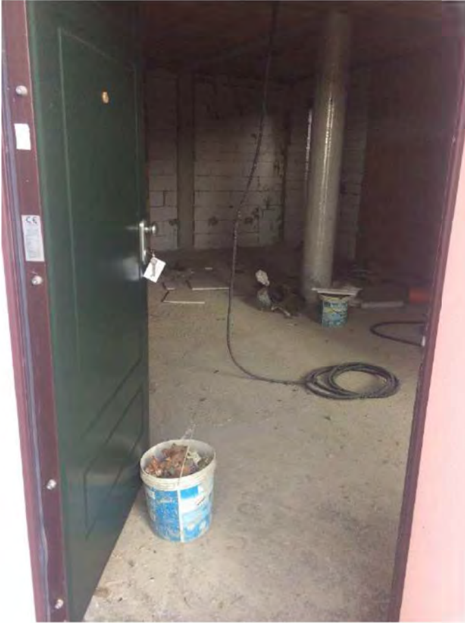
FOTO 21 -PIANO PRIMO SOTTOSTRADA PORTONE DI INGRESSO
