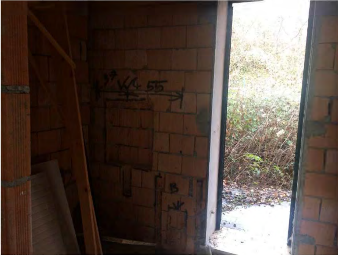
FOTO 33: PIANO TERRA – BAGNO
