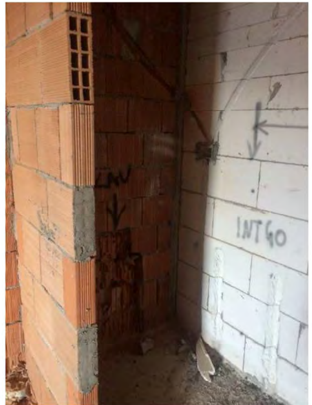
FOTO 24 - PIANO PRIMO SOTTOSTRADA (BAGNO)
