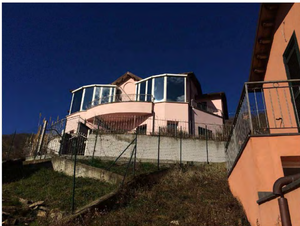
FOTO 28 - PROSPETTO ESTERNO (PORZIONE LATO DX)
