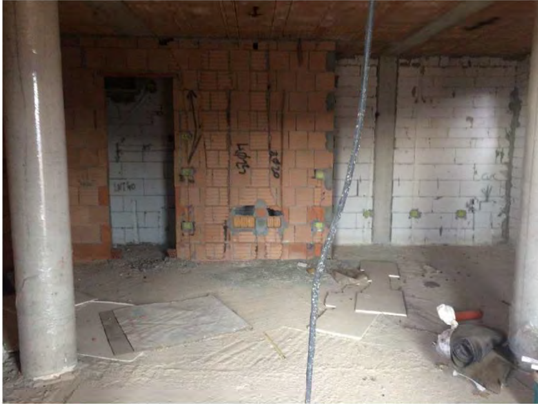
FOTO 23 -PIANO PRIMO SOTTOSTRADA
