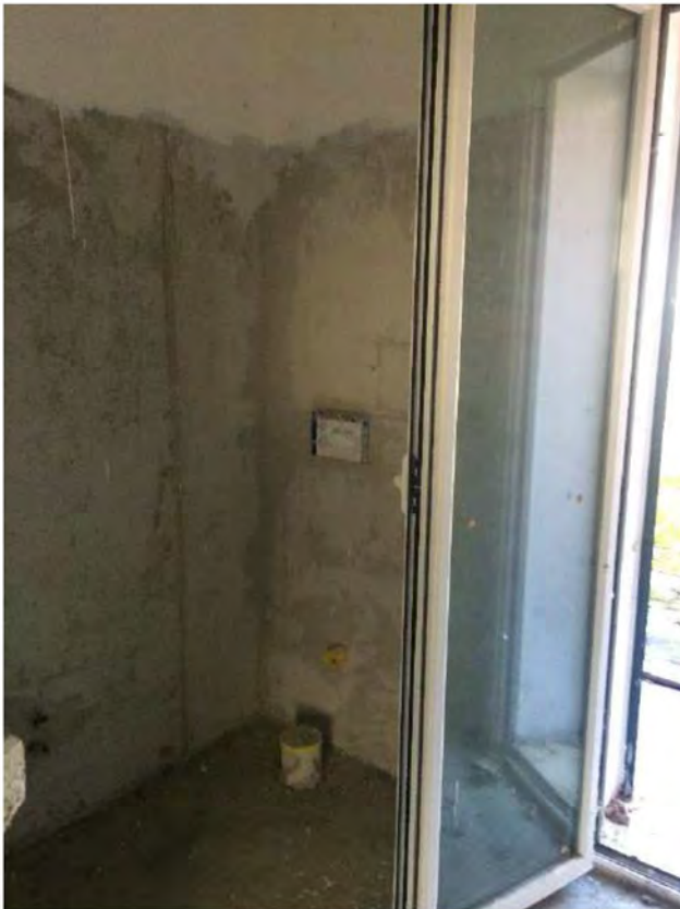
FOTO 52: PIANO TERRA - BAGNO
