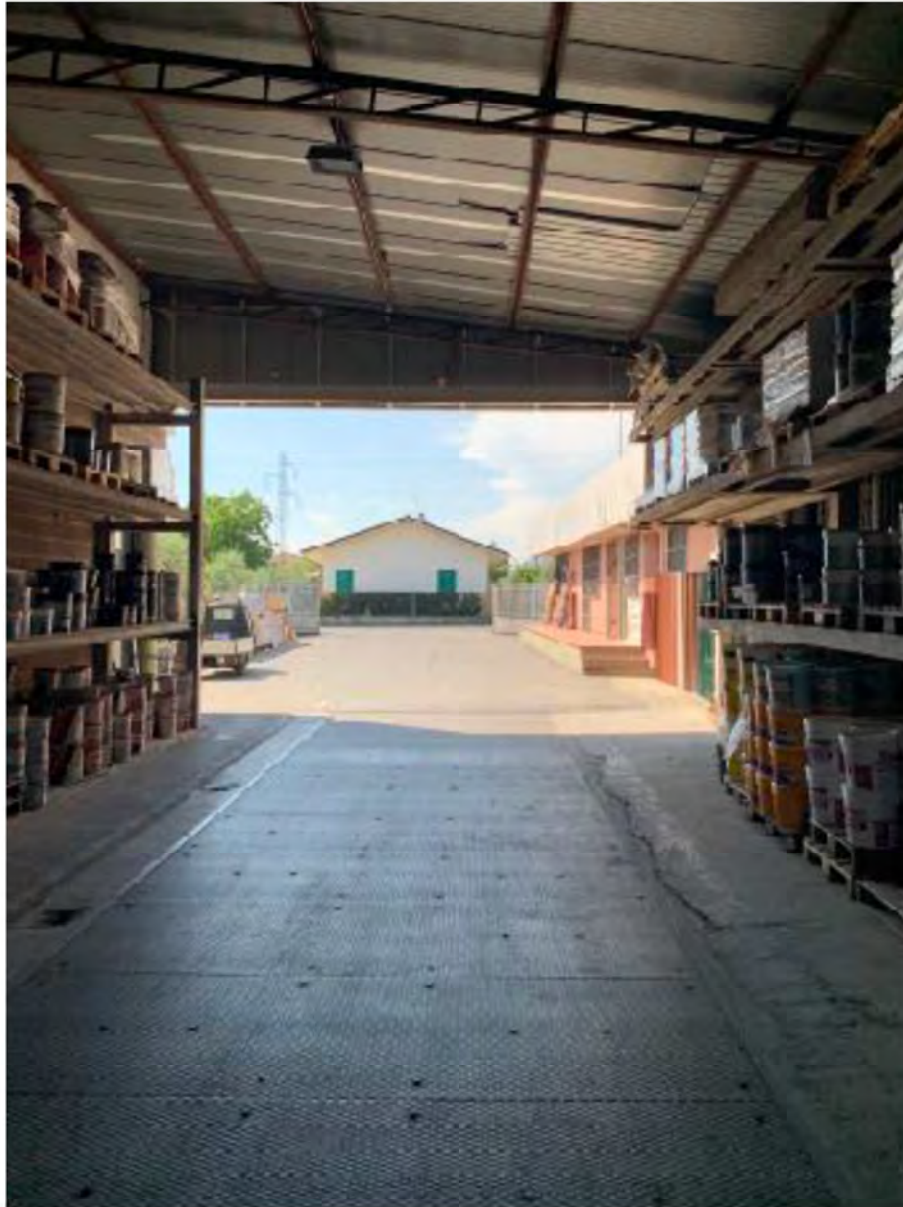
Foto 17: Massa, Viale della Repubblica n. Lotto 001. - Tettoia corpo centrale
