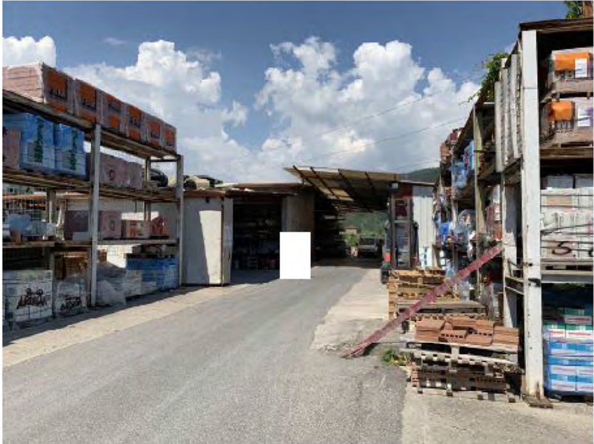
Foto 24: Massa, Viale della Repubblica n. Lotto 001. - Tettoia chiusa lato est e piazzale
