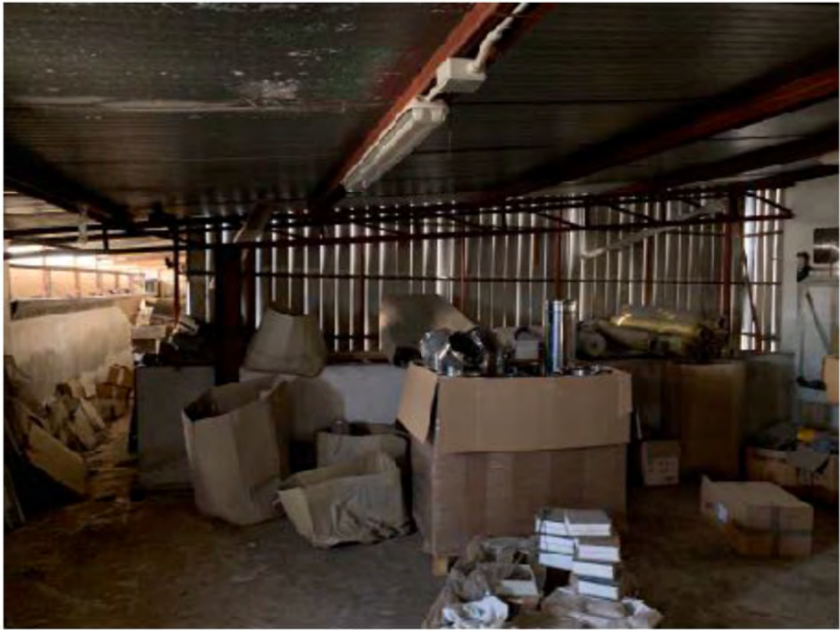
Foto 14: Massa, Viale della Repubblica n. Lotto 001. - Locale deposito (piano primo)
