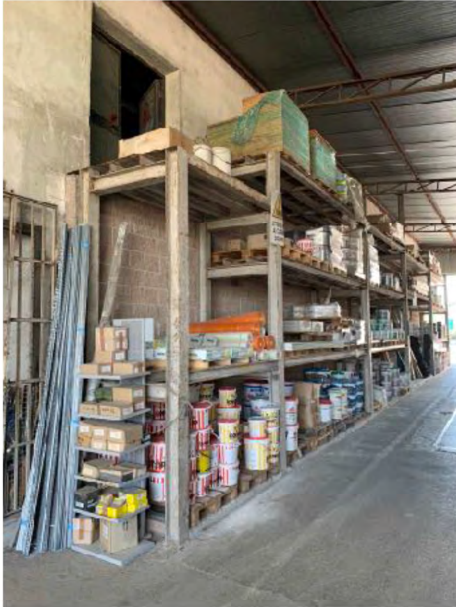
Foto 18: Massa, Viale della Repubblica n. Lotto 001. - Tettoia corpo centrale
