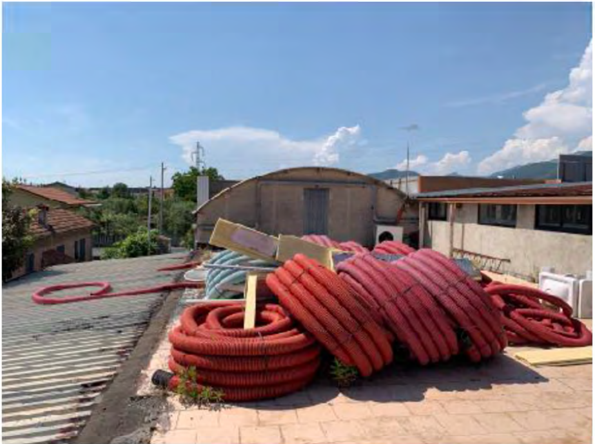
Foto E6: Massa, Viale della Repubblica n. Lotto 001. -Terrazza area deposito (piano primo).
