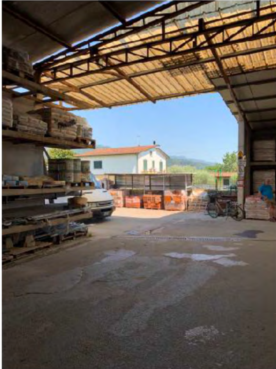
Foto 19: Massa, Viale della Repubblica n. Lotto 001. - Tettoia corpo centrale
