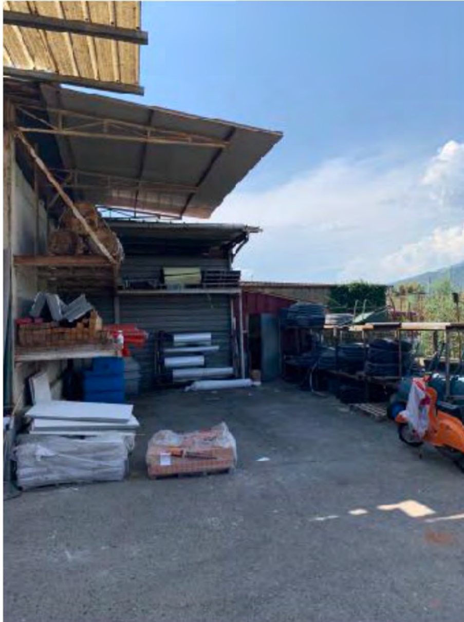
Foto 20: Massa, Viale della Repubblica n. Lotto 001. - Tettoia chiusa e deposito lato nord.
