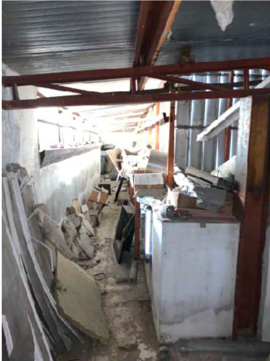
Foto 16: Massa, Viale della Repubblica n. Lotto 001. - Locale deposito (piano primo)
