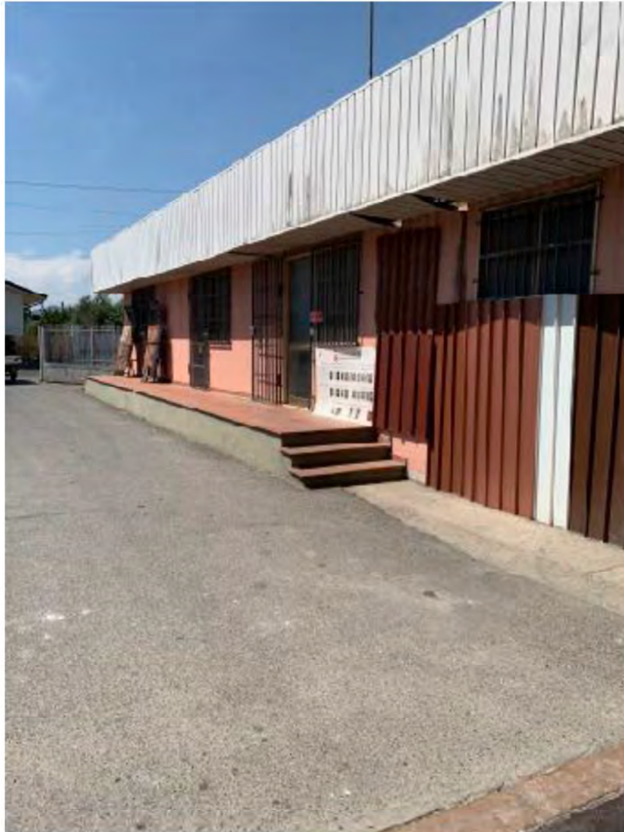
Foto E3: Massa, Viale della Repubblica n. Lotto 001. Edificio Uffici, lato sud.
