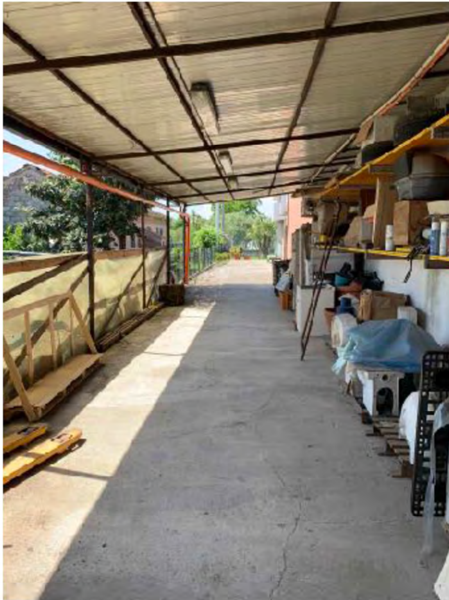
Foto 21: Massa, Viale della Repubblica n. Lotto 001. - Tettoia lato sud.
