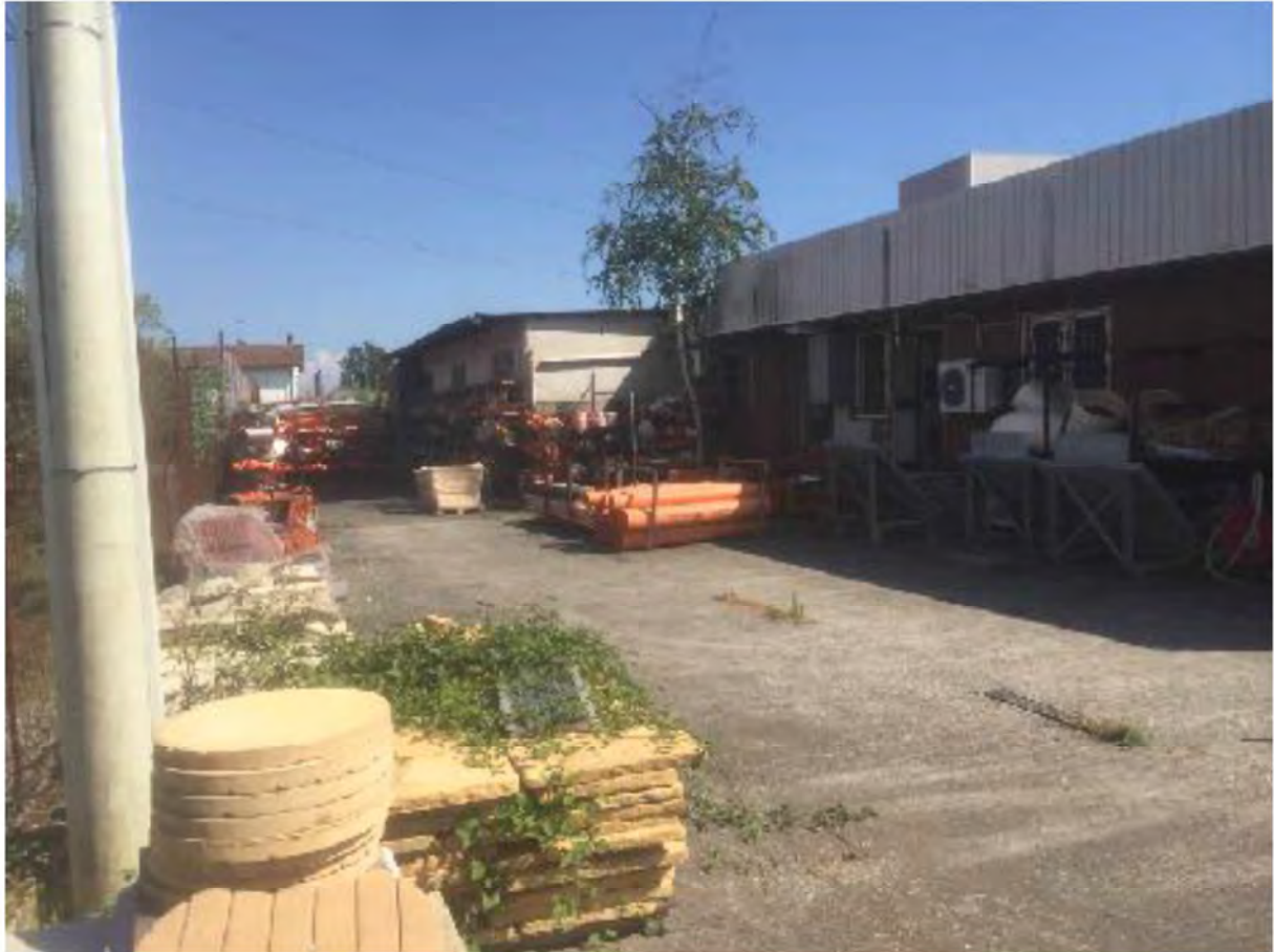
Foto E4: Massa, Viale della Repubblica n. Lotto 001. - Edificio Uffici, lato nord. - Cortile esterno pertinenziale. Lato nord
