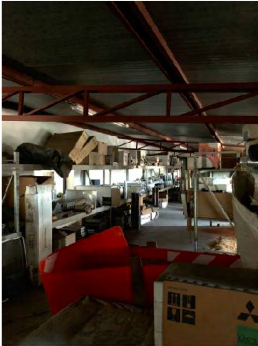
Foto 15: Massa, Viale della Repubblica n. Lotto 001. - Locale deposito (piano primo)
