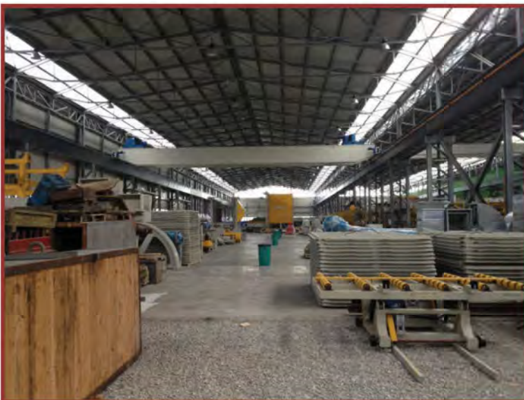
Edificio industriale – Vista interna
