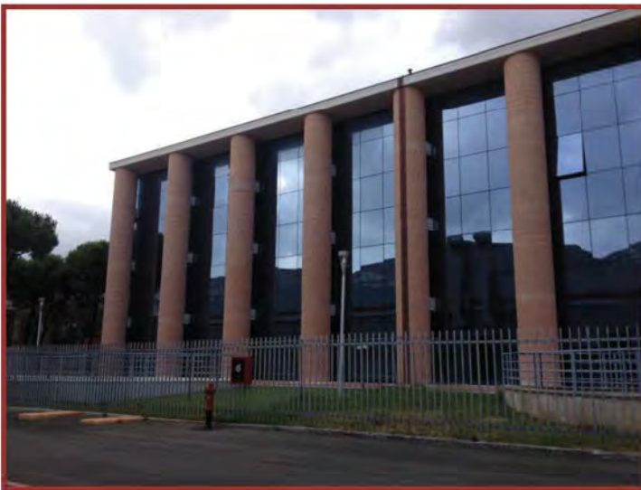
Edificio direzionale – Vista esterna
