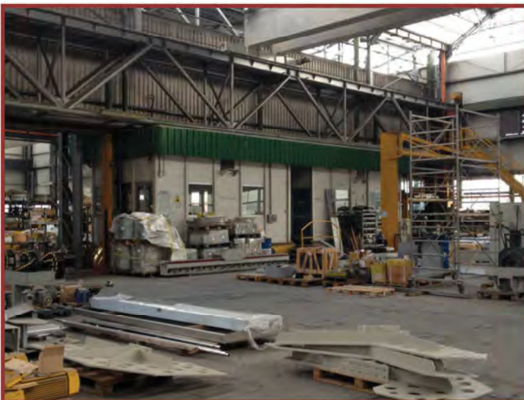
Edificio industriale – Vista interna
