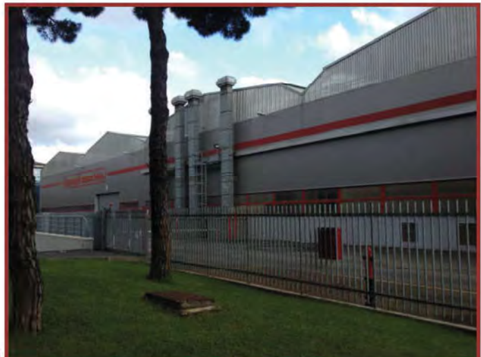
Edificio industriale – Vista laterale
