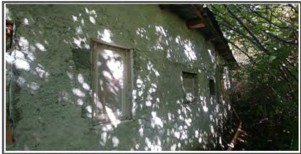
Foto n. 7 – Facciata lato EST
