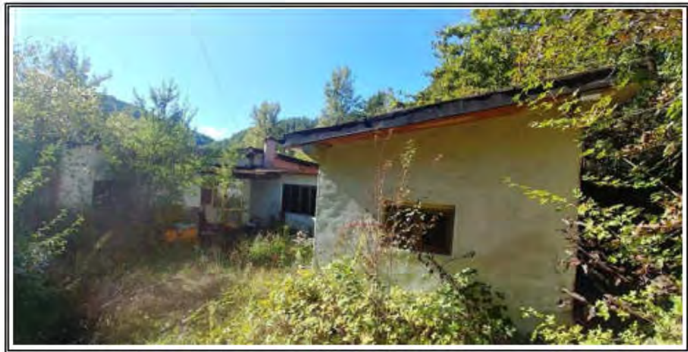
Foto n. 4 – Vista del fabbricato – Angolo NORD
