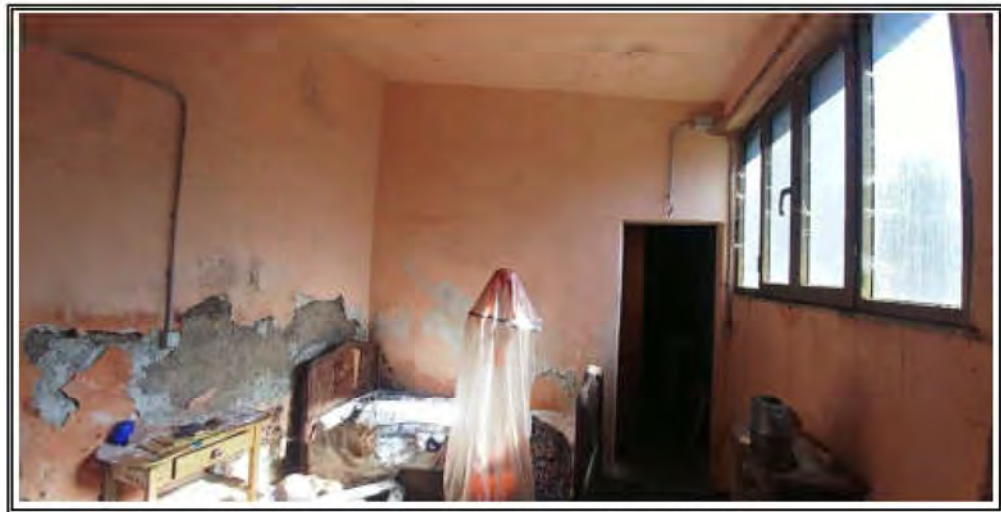
Foto n. 19 – Locale accessorio (Catastalmente Cantina)
