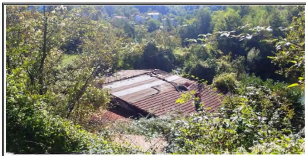
Foto n. 3 – Vista della copertura del fabbricato
