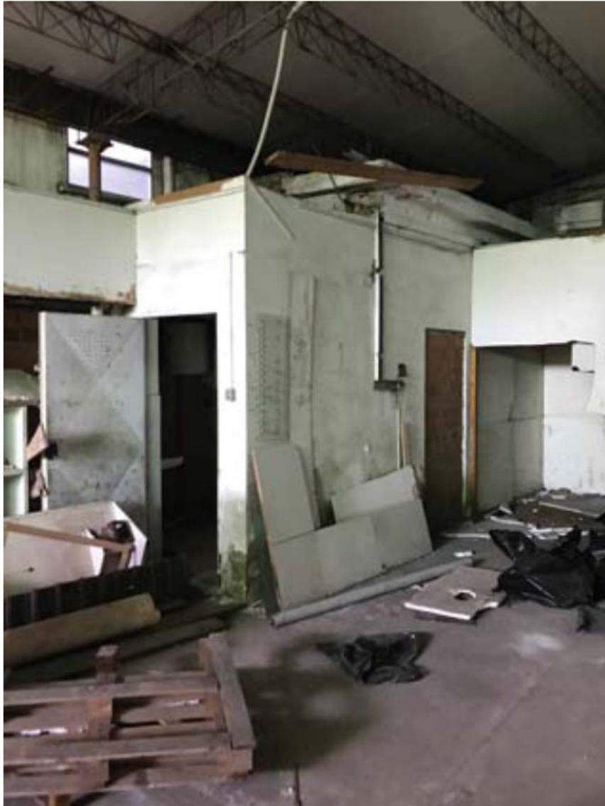
Foto 3: Via Provinciale Avenza-Sarzana. Zona laboratorio.
