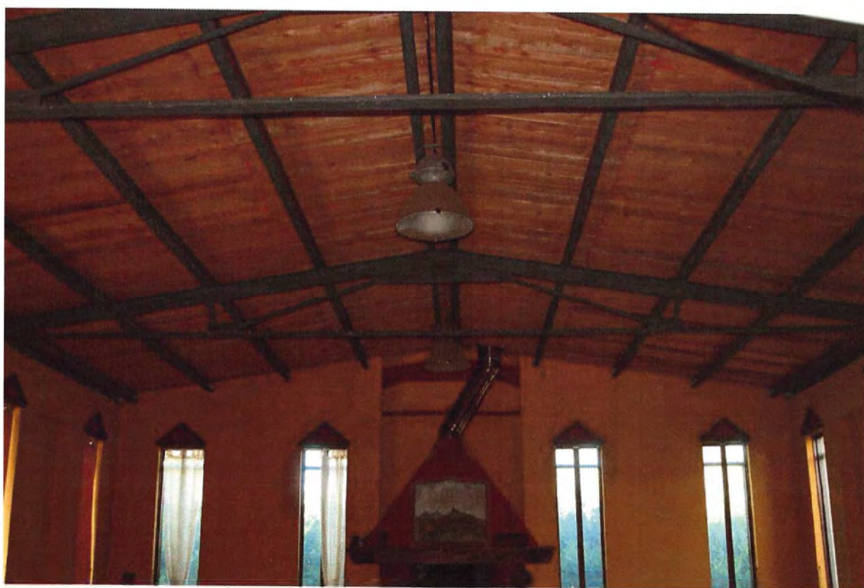
Foto 27 e 28. Magazzino corpo 3, sub.8
