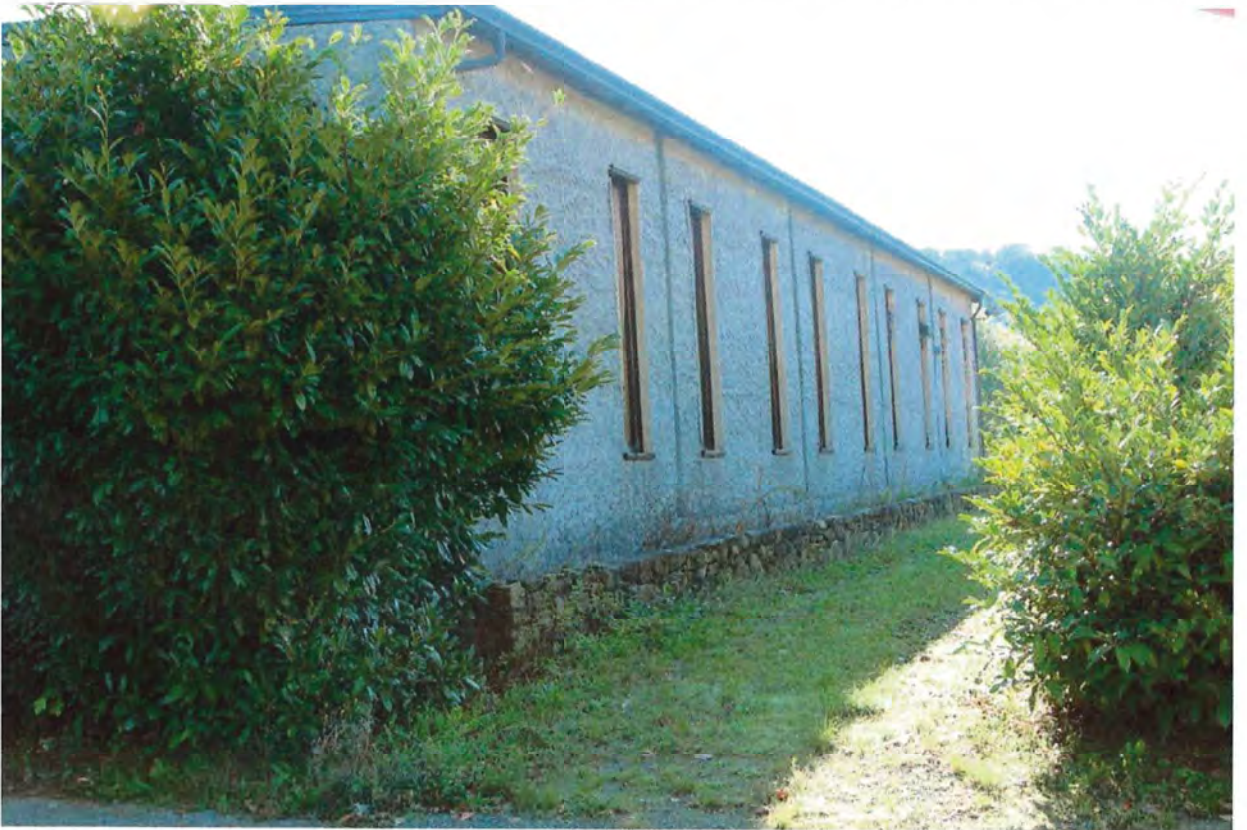
Foto 42. Esterno fabbricato sud-ovest
