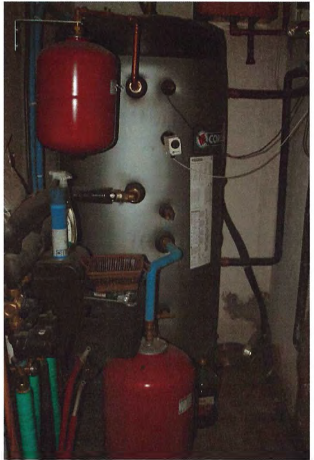
Foto 23. Vano tecnico corpo 2, sub.7
