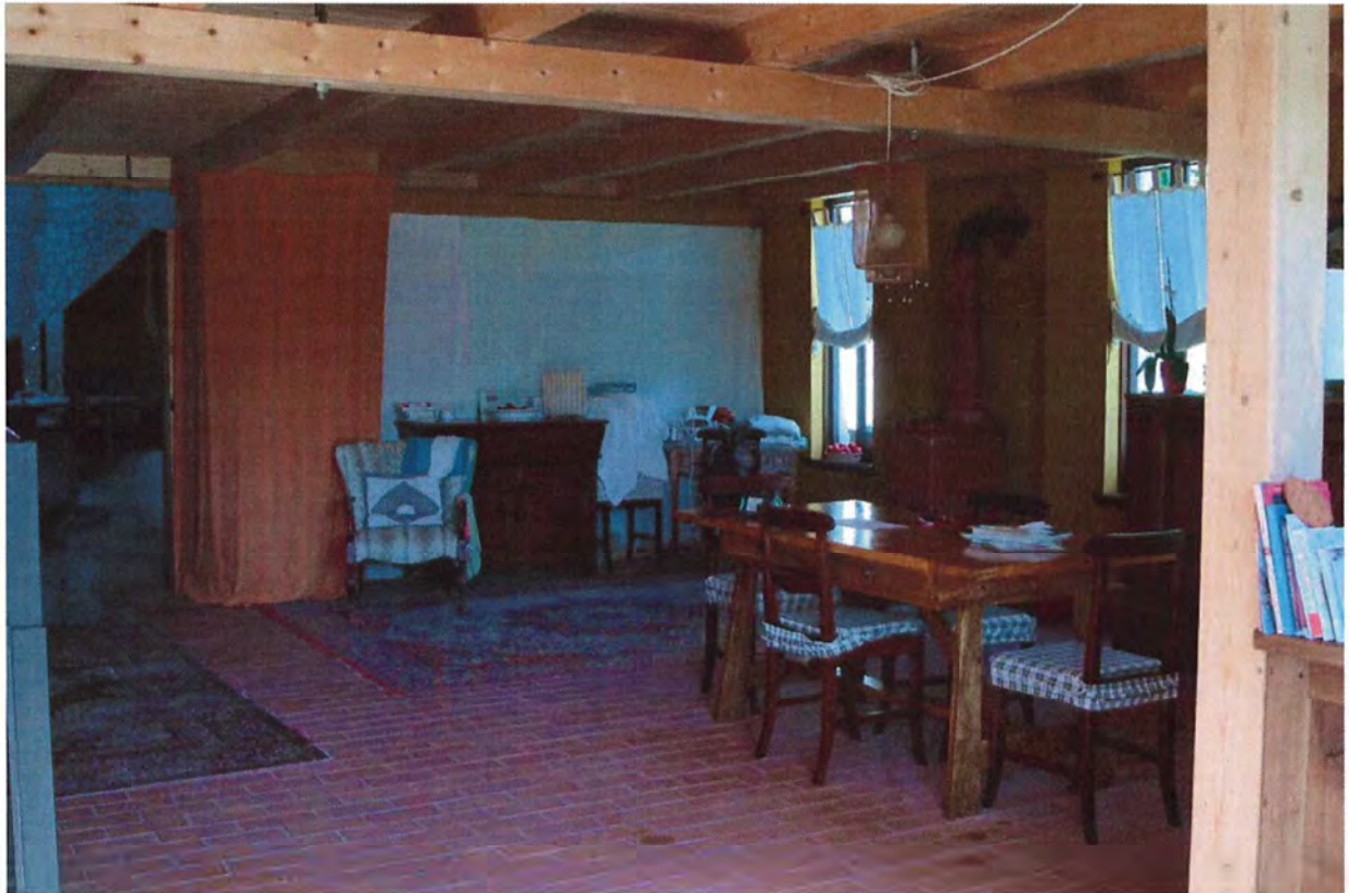
Foto 18 e 19. Laboratorio artigianale corpo 2, sub.7. Attualmente impropriamente utilizzato come residenza
