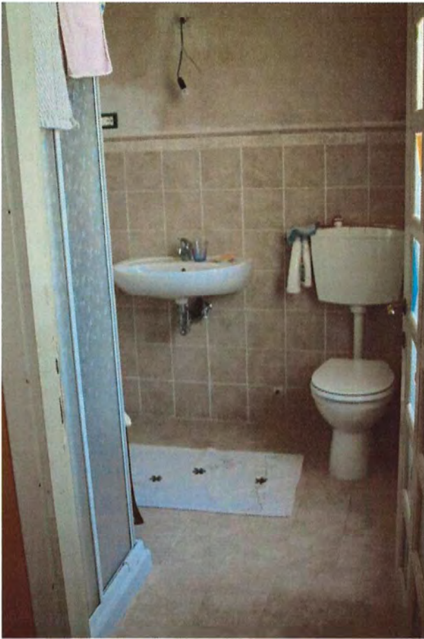
Foto 22. Bagno corpo 2, sub.7
