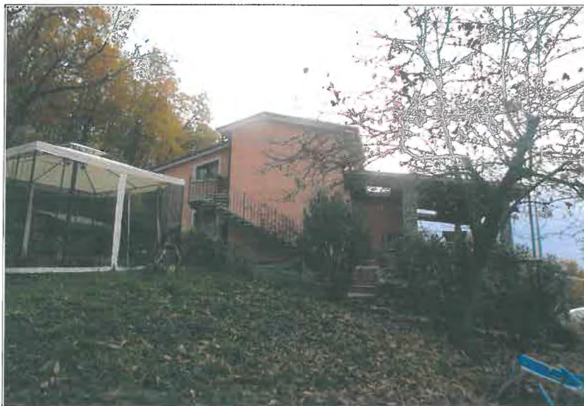
Vista esterna dell'immobile lato Nord
