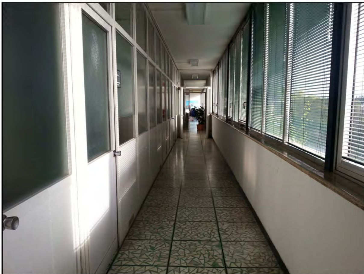
Figura 3. Veduta della zona uffici ripresa dal corridoio. A sinistra si vedono le divisioni interne ed a destra le ampie vetrate con infissi in alluminio anodizzate che si affacciano su via Catagnina.
