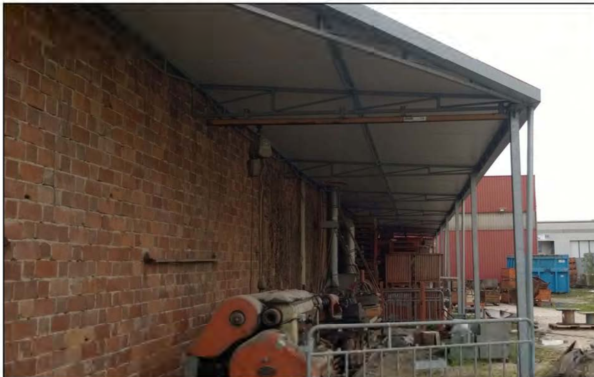
Figura 5. Tettoia presente sul lato monte dell'immobile principale.
