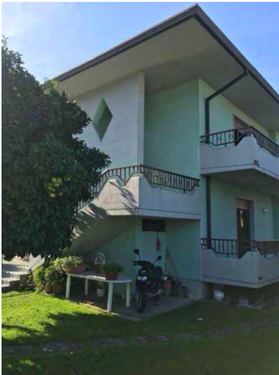
Foto E1: Marina di Massa, Massa (MS). Lotto 001. Esterno Abitazione lato.
