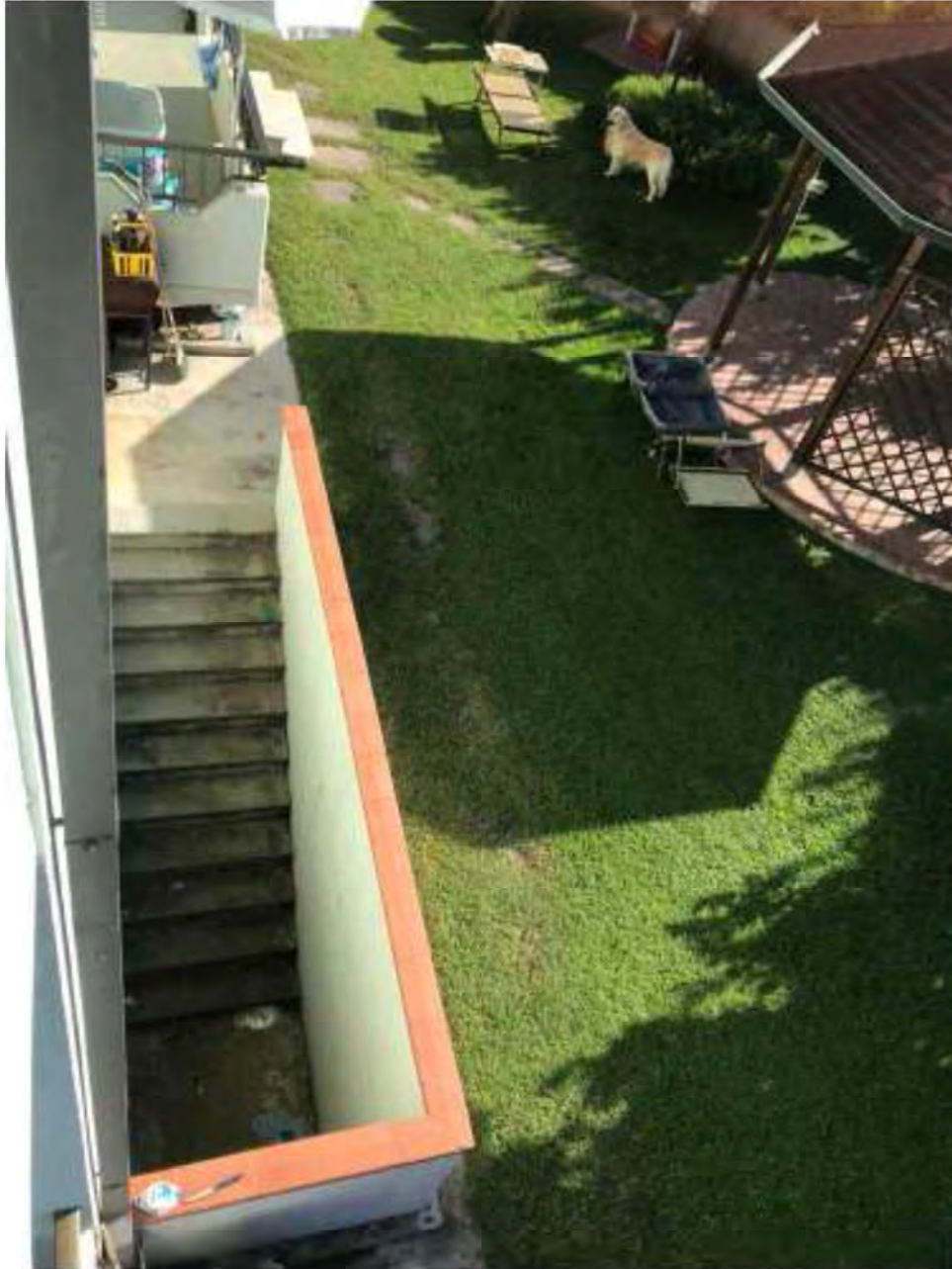
Foto E5: Marina di Massa, Massa. Lotto 001. Accesso centrale termica.
