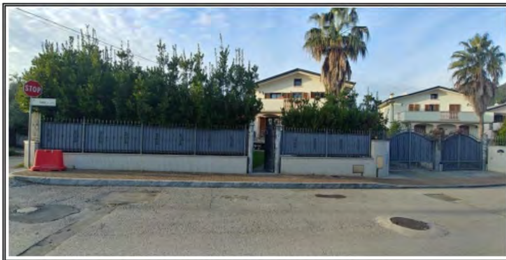
Foto n. 1 – Vista della proprietà dalla strada Via Del Lago
