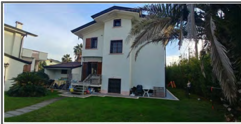
Foto n. 4 – Vista del Fabbricato – Angolo OVEST
