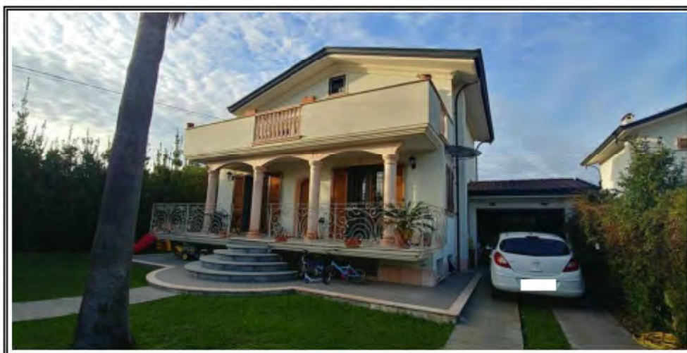
Foto n. 3 – Vista del Fabbricato – Angolo EST
