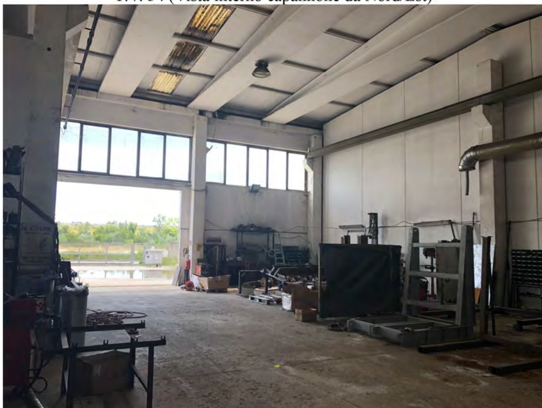
P.V. 34 (Vista interno capannone da Nord/Est)
