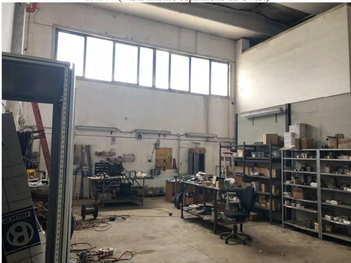
P.V. 37 (Vista interno capannone da Ovest)
