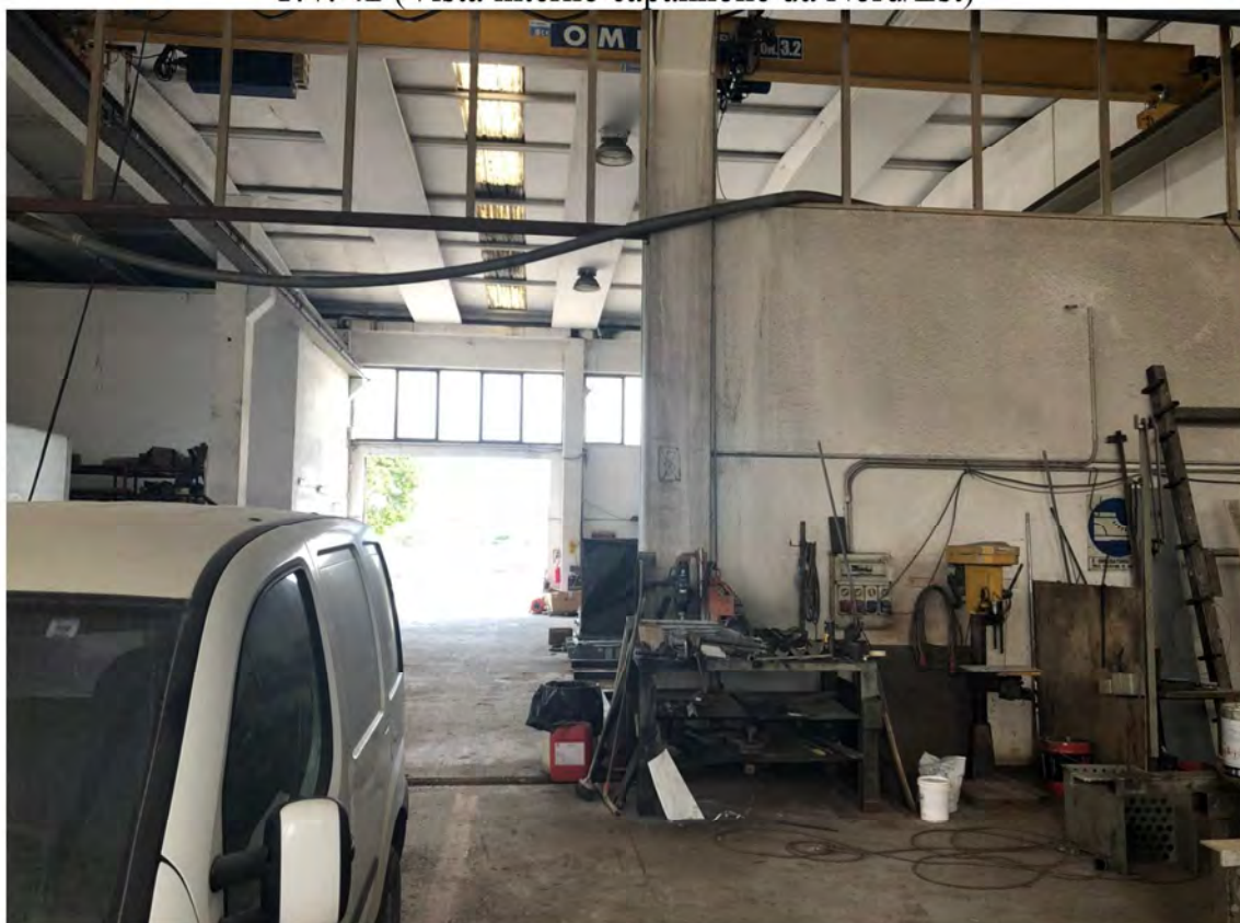
P.V. 42 (Vista interno capannone da Nord/Est)
