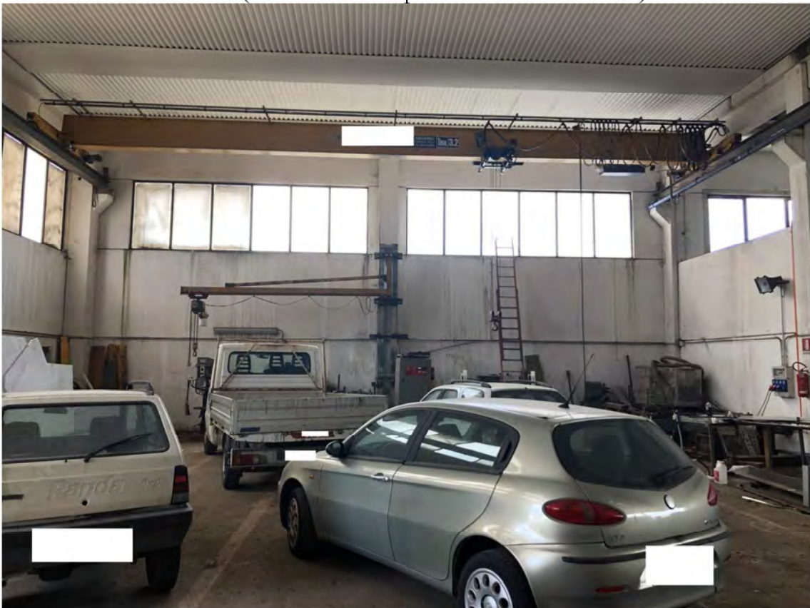
P.V. 44 (Vista interno capannone da Nord/Ovest)
