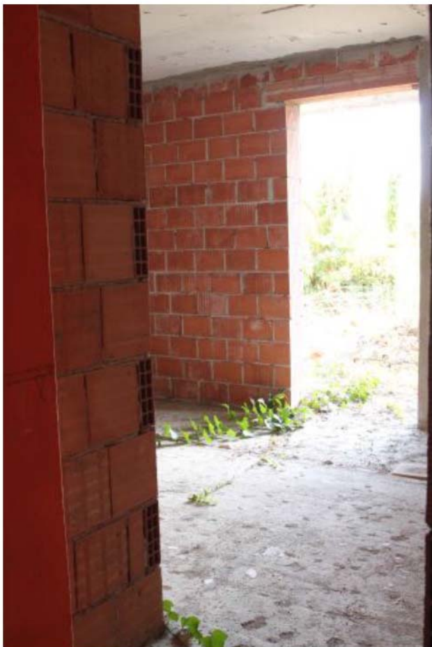
Foto 13. Interno, camera sub.32
