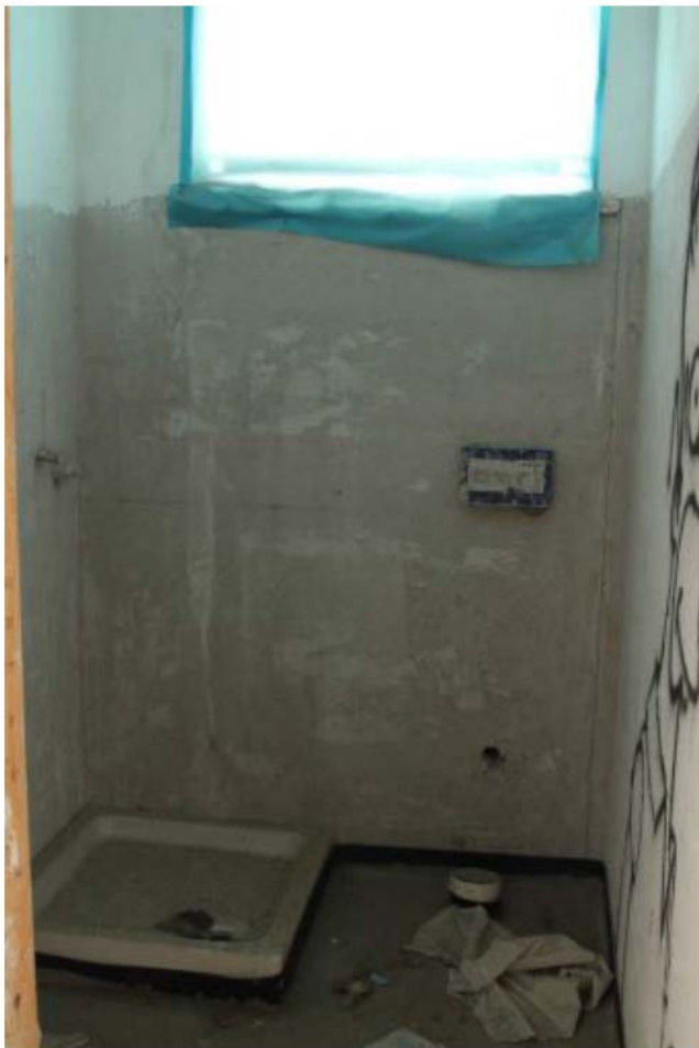
Foto 3. Interno, bagno sub.38
