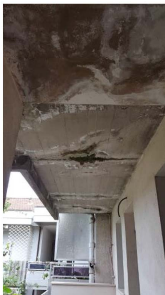
Foto 3. Esterno, sottogonda retro
