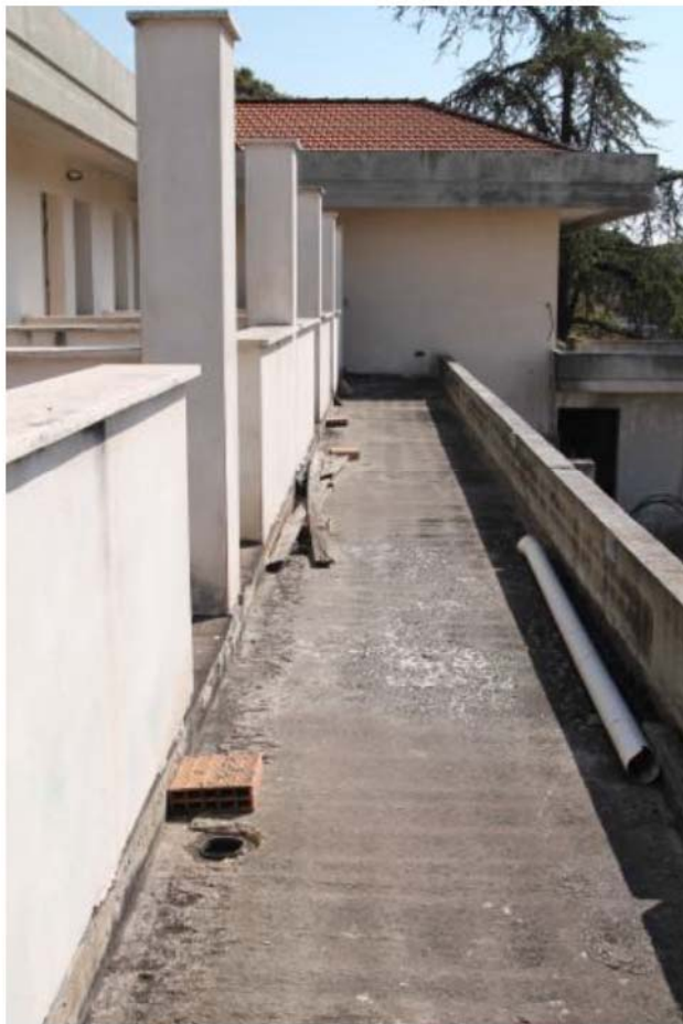
Foto 10. Esterno piano primo
