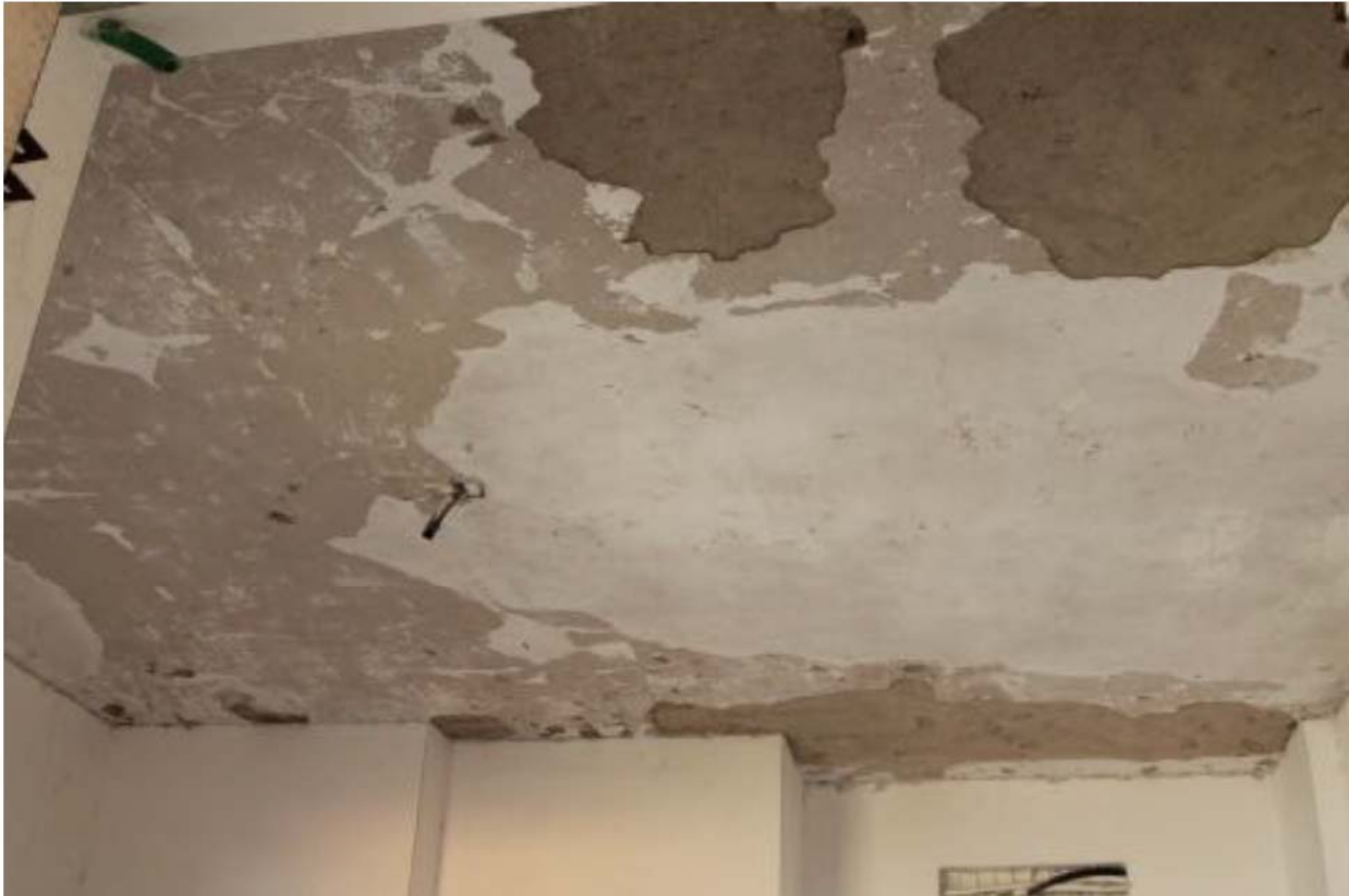
Foto 3. Interno, soffitto soggiorno sub.39
