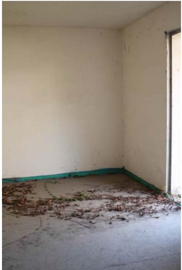
Foto 6. Interno, camera sub.36
