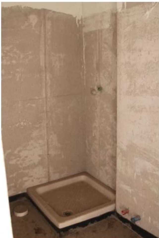
Foto 5. Interno, bagno sub.45
