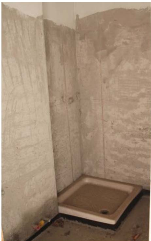
Foto 3. Interno, bagno sub.42
