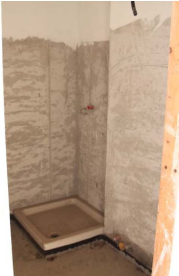
Foto 4. Interno, bagno sub.43
