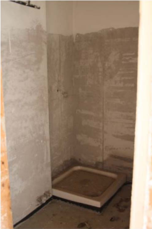
Foto 1. Interno, bagno sub.41
