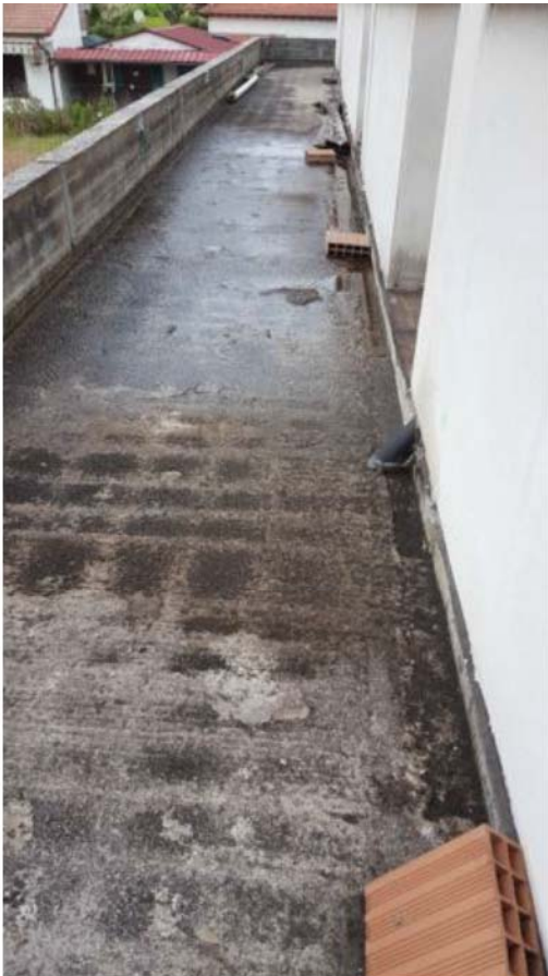
Foto 6. Esterno, area condominiale esterna piano primo lato mare
