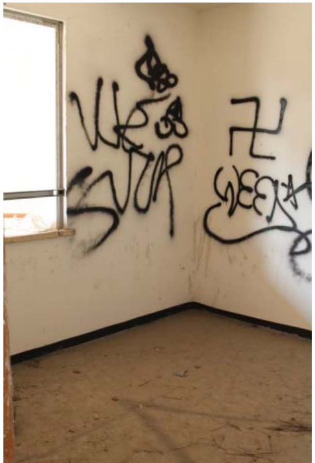
Foto 4. Interno, camera sub.38
