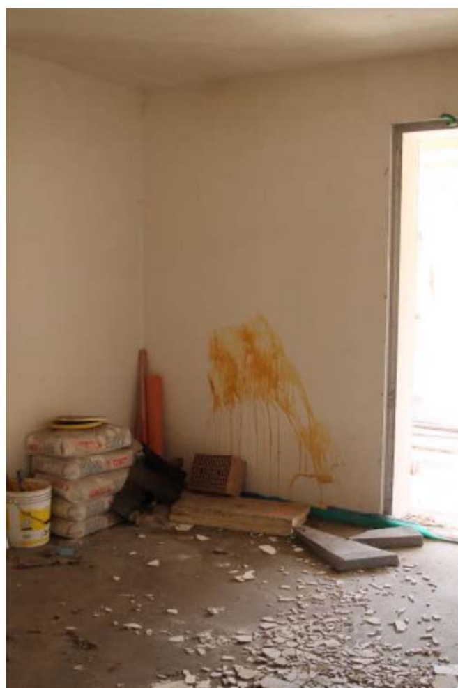
Foto 3. Interno, camera sub.35
