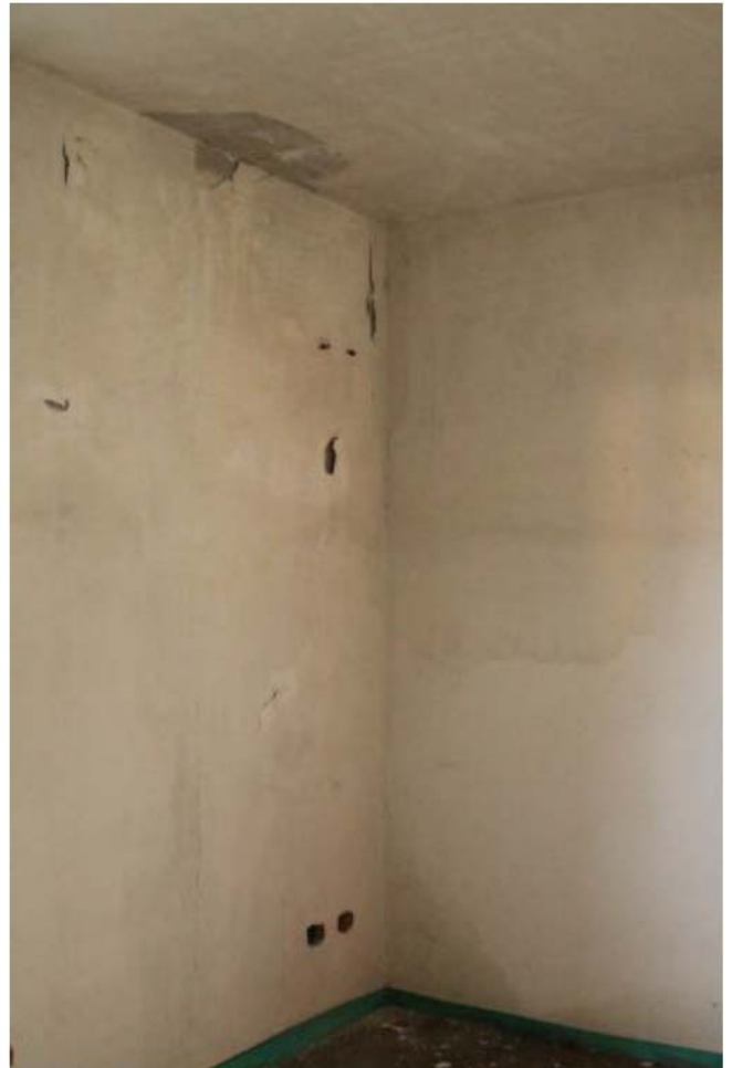
Foto 7. Interno, camera sub.35
