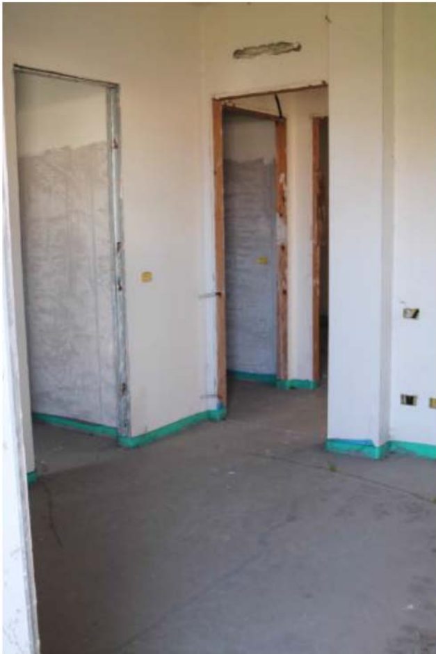
Foto 5. Interno, camera sub.36
