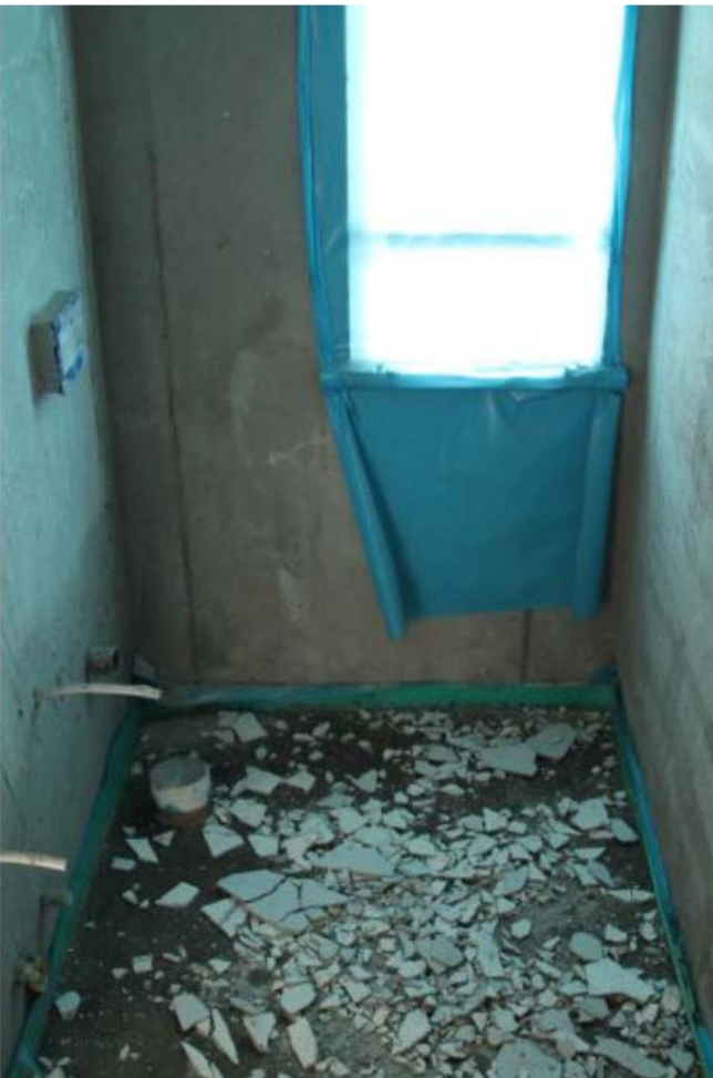
Foto 7. Interno, bagno sub.34
