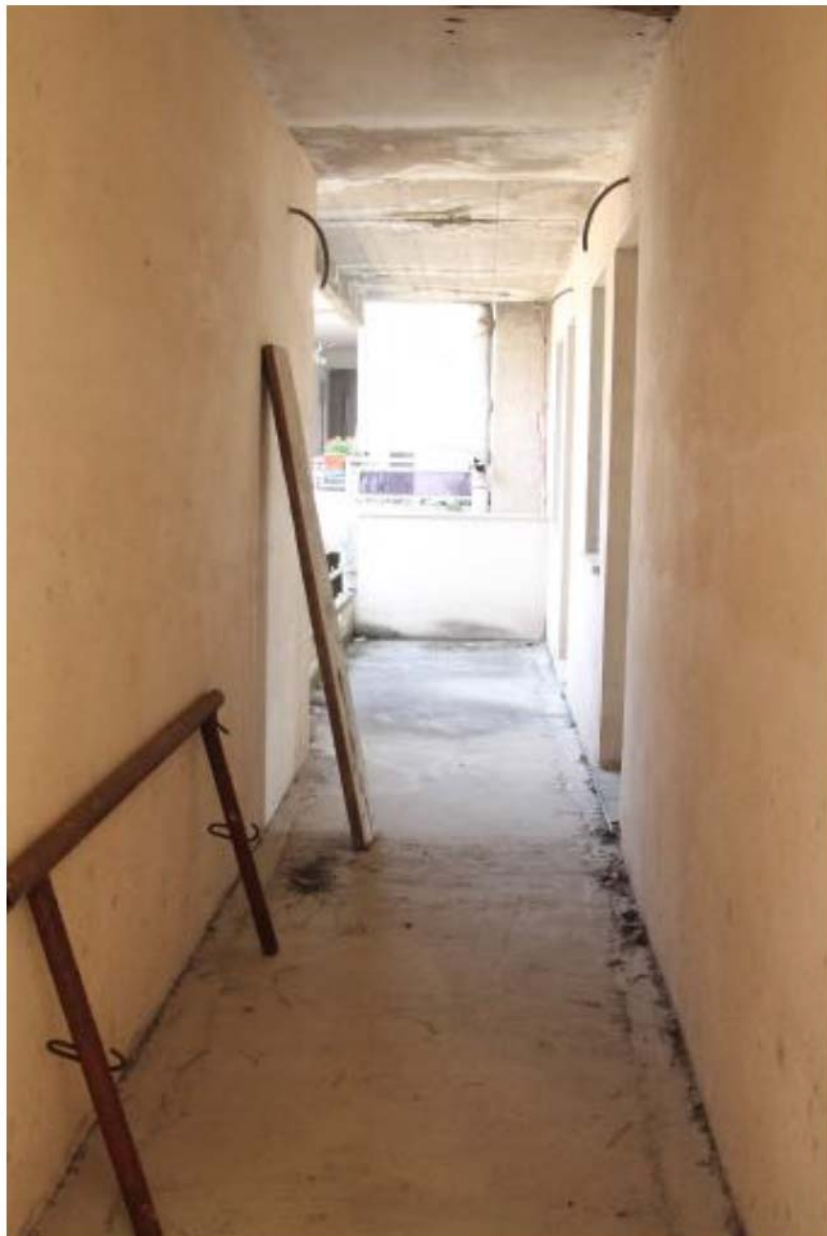
Foto 5. Corridoio di accesso a sub.38
