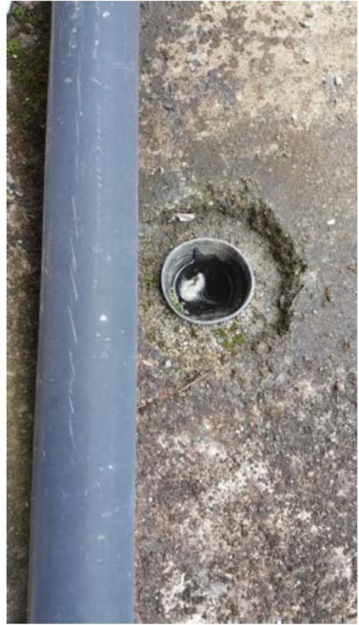
Foto 5. Canale di scolo
