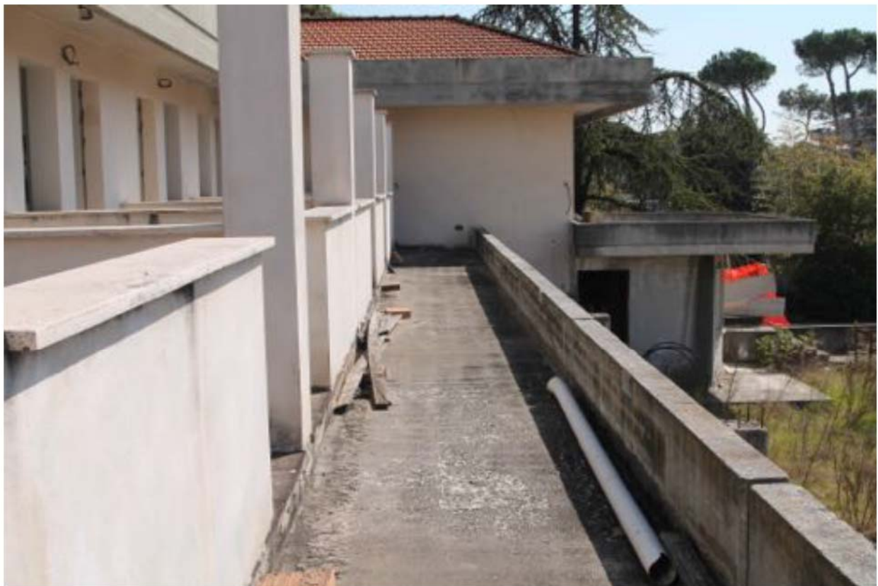
Foto 9. Esterno piano primo
