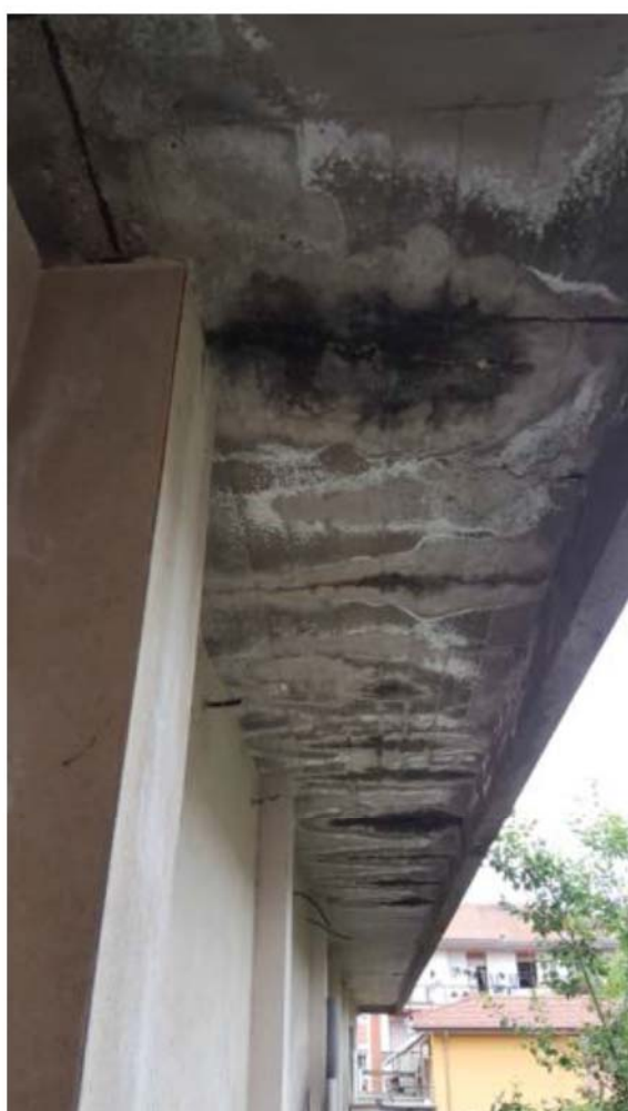
Foto 2. Esterno, sottogonda retro
