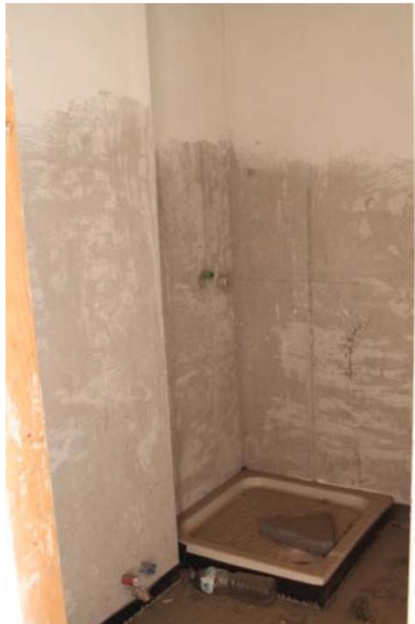
Foto 4. Interno, bagno sub.46
