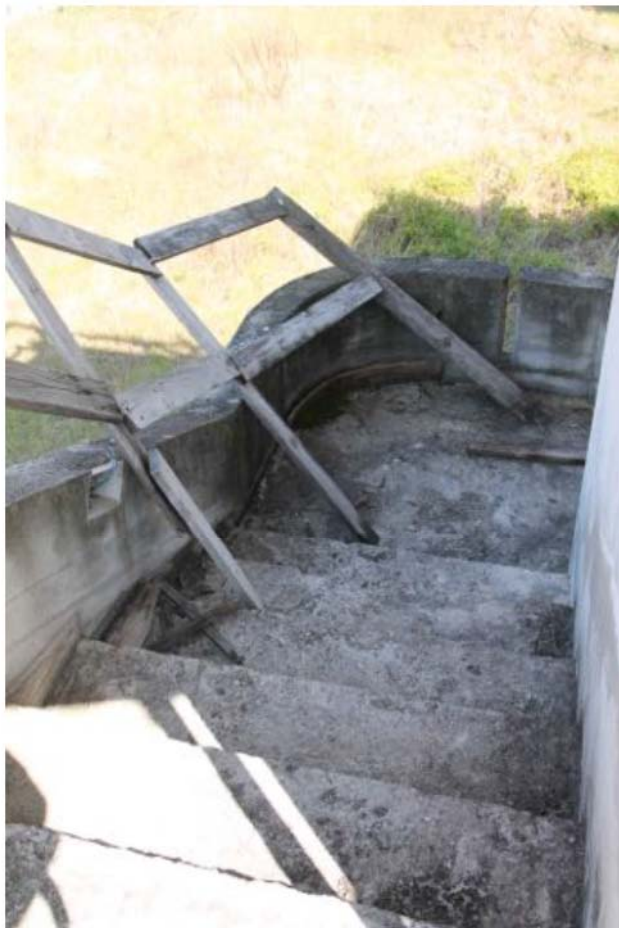
Foto 12. Esterno scala esterna
