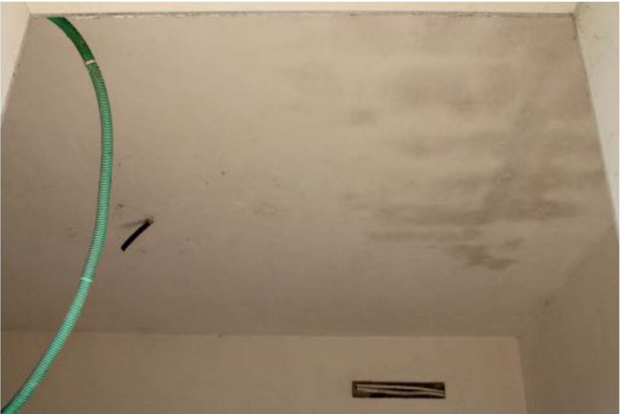
Foto 6. Interno, soffitto sub.40
