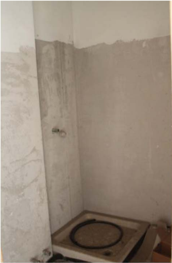
Foto 4. Interno, bagno sub.39
