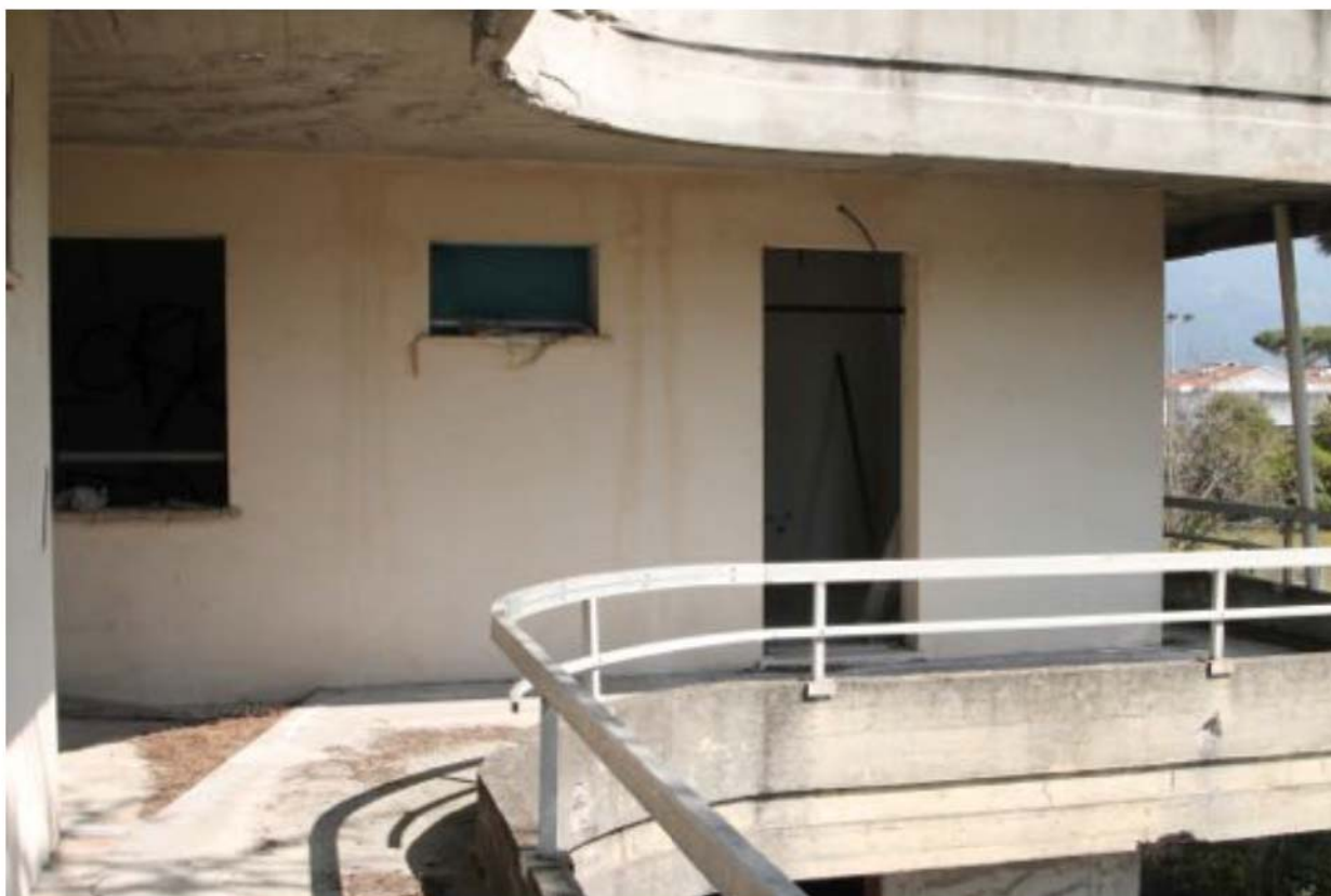
Foto 14. Esterno piano primo
