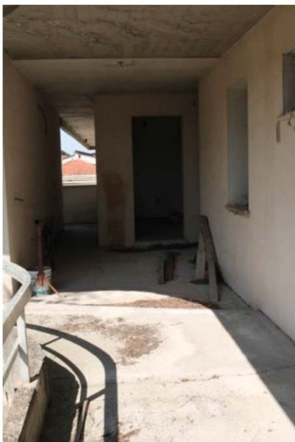
Foto 15. Esterno piano primo
