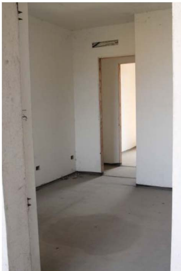
Foto 1. Interno, camera sub.40
