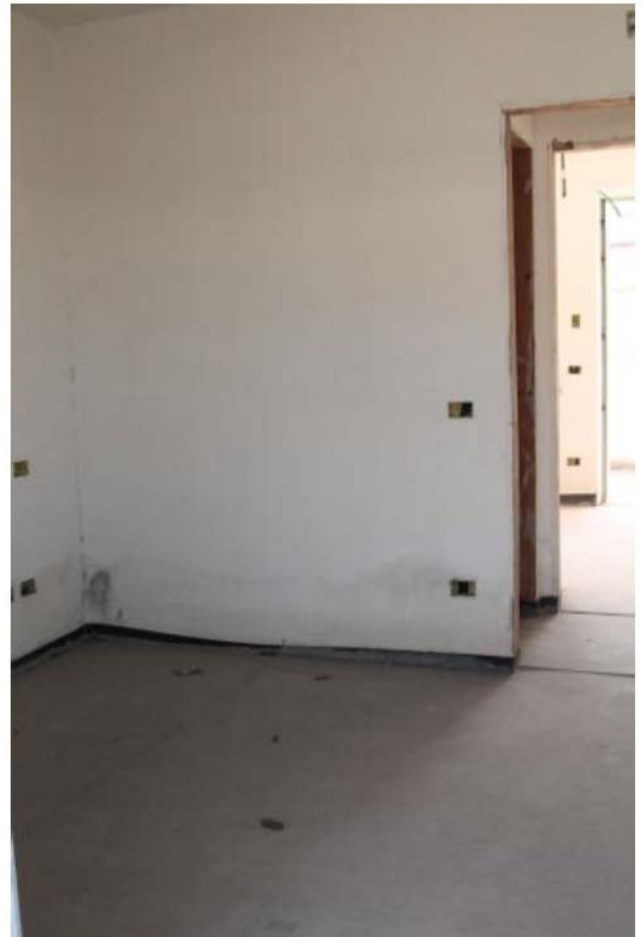
Foto 5. Interno, camera sub.43
