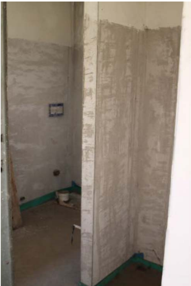
Foto 7. Interno, bagno sub.36
