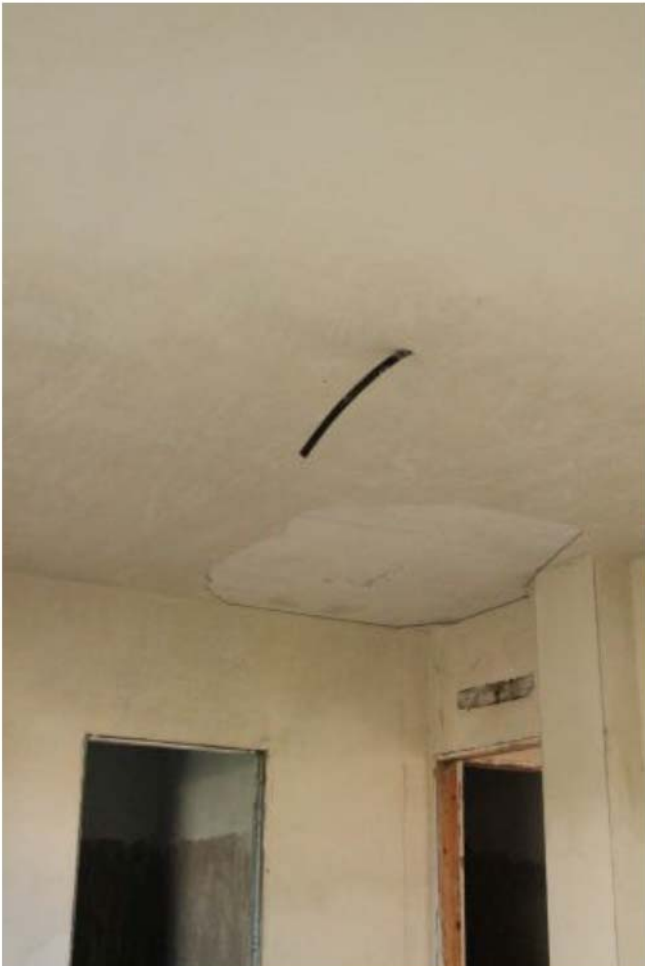
Foto 6. Interno, soffitto camera sub.35
