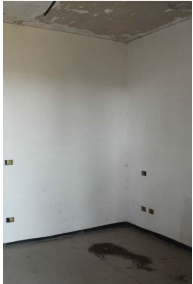
Foto 5. Interno, camera sub.39
