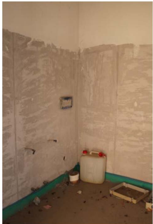
Foto 4. Interno, bagno sub.36
