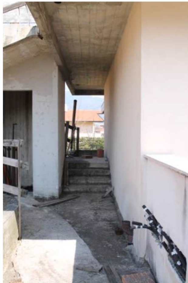
Foto 11. Esterno piano primo
