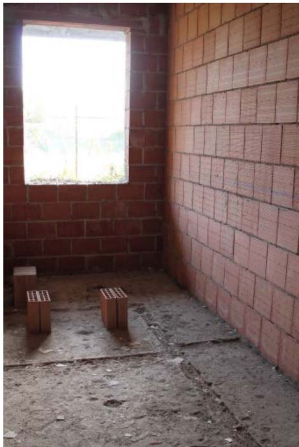
Foto 5. Interno, bagno sub.32
