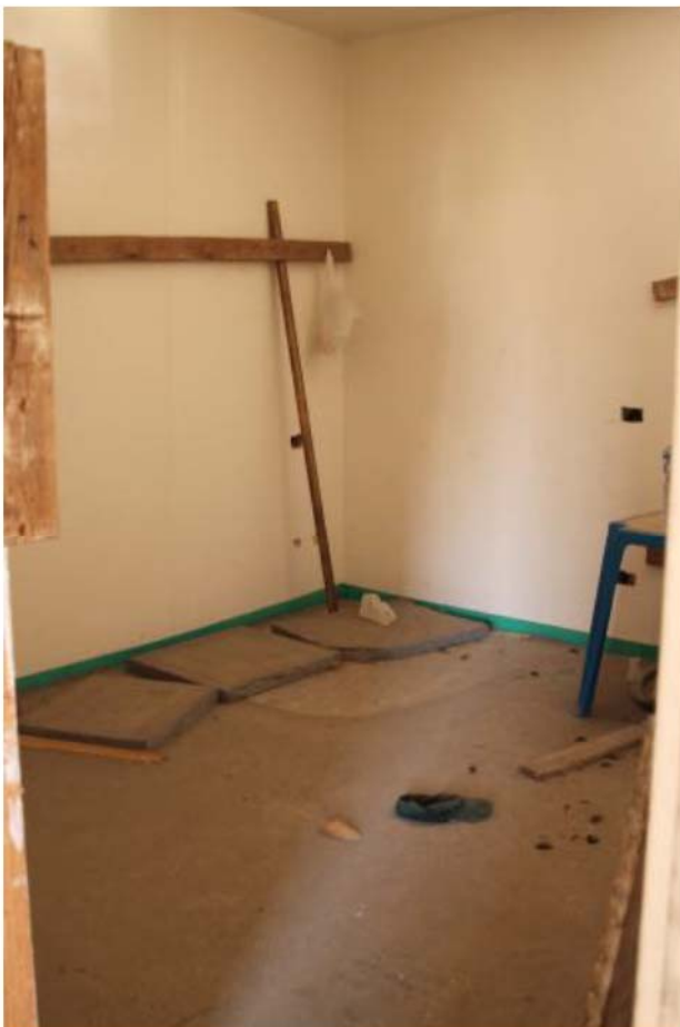
Foto 3. Interno, camera sub.36
