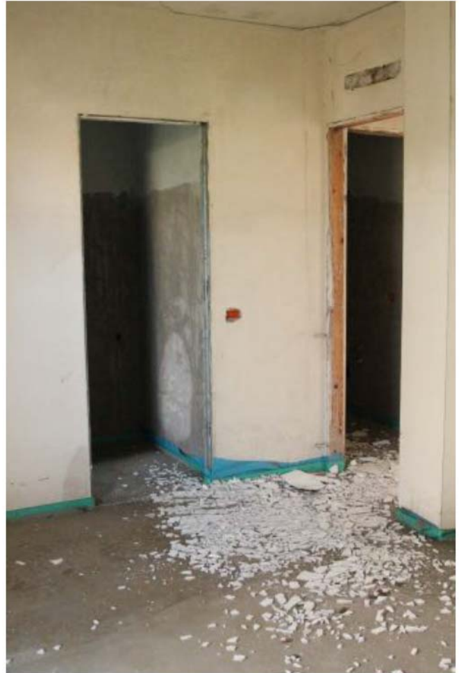
Foto 5. Interno, camera sub.35
