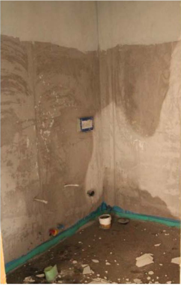
Foto 4. Interno, bagno sub.35
