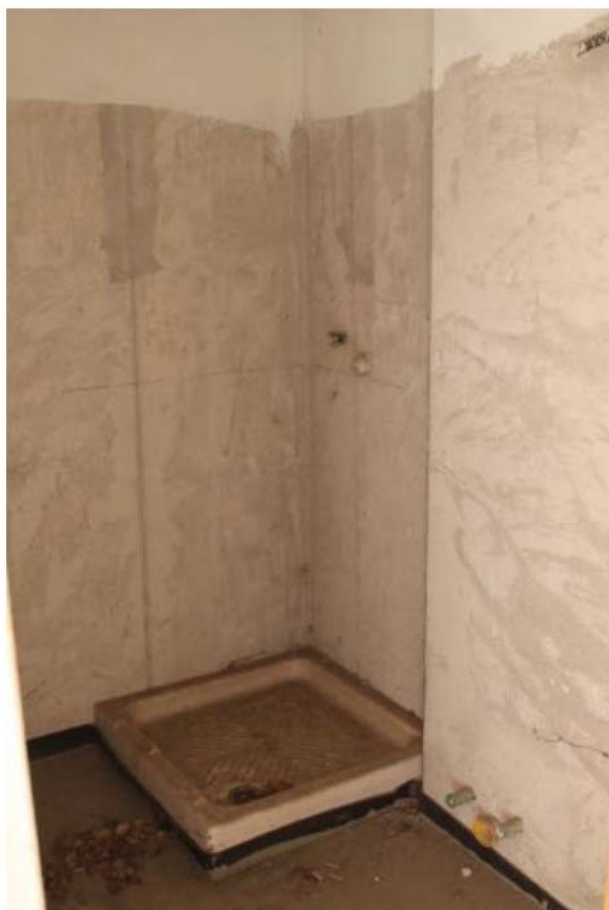
Foto 3. Interno, bagno sub.40
