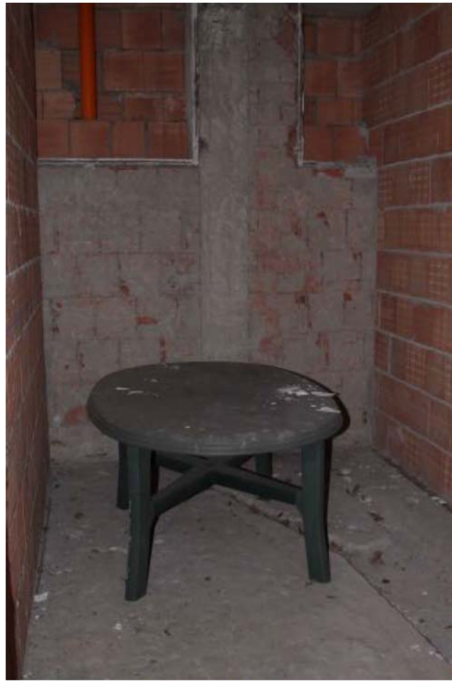
Foto 8. Interno, bagno sub.32
