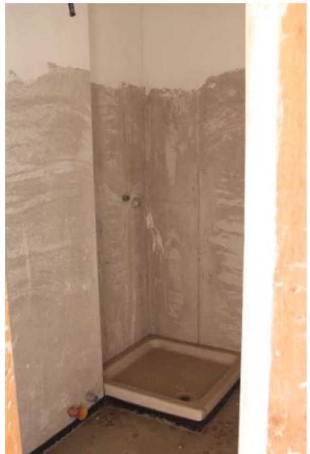
Foto 4. Interno, bagno sub.44
