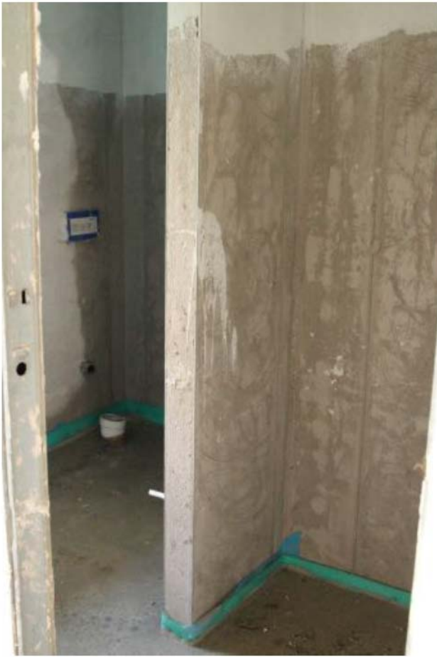
Foto 8. Interno, bagno sub.35
