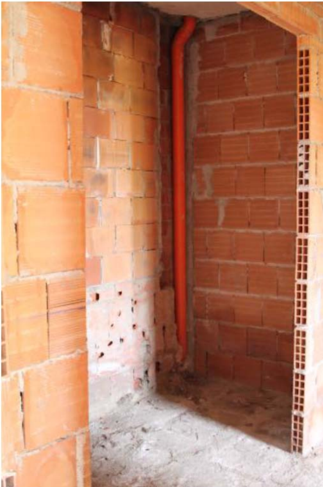
Foto 4. Interno, bagno sub.33
