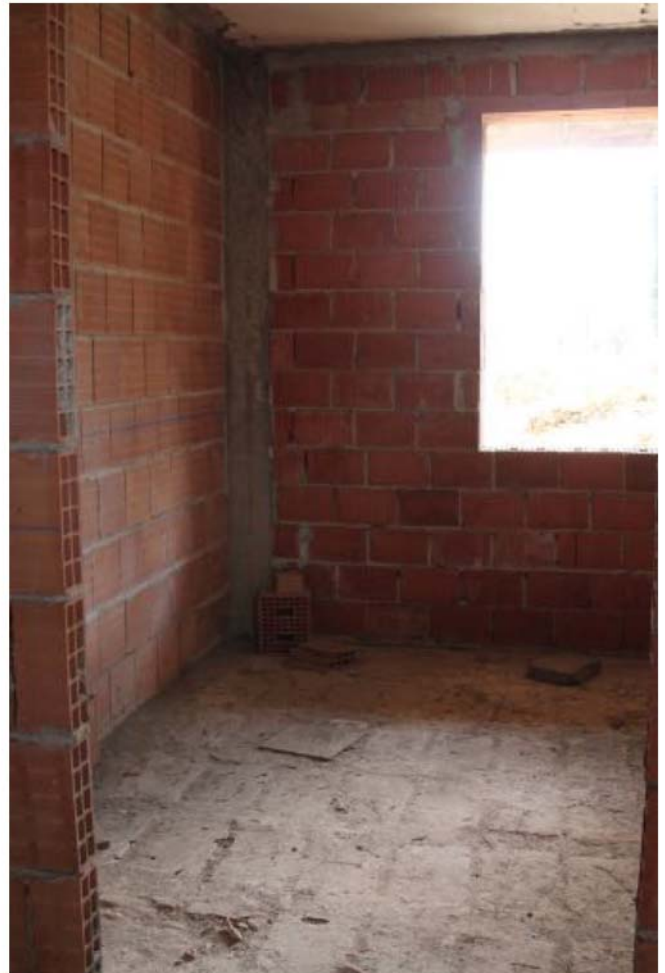
Foto 5. Interno, camera sub.33
