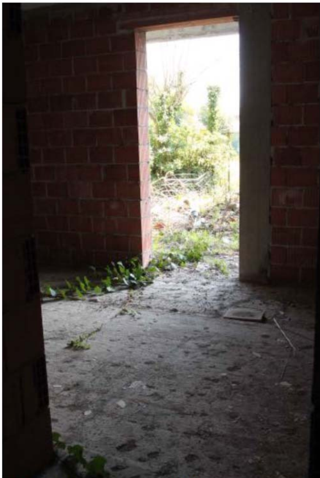
Foto 7. Interno, camera sub.32
