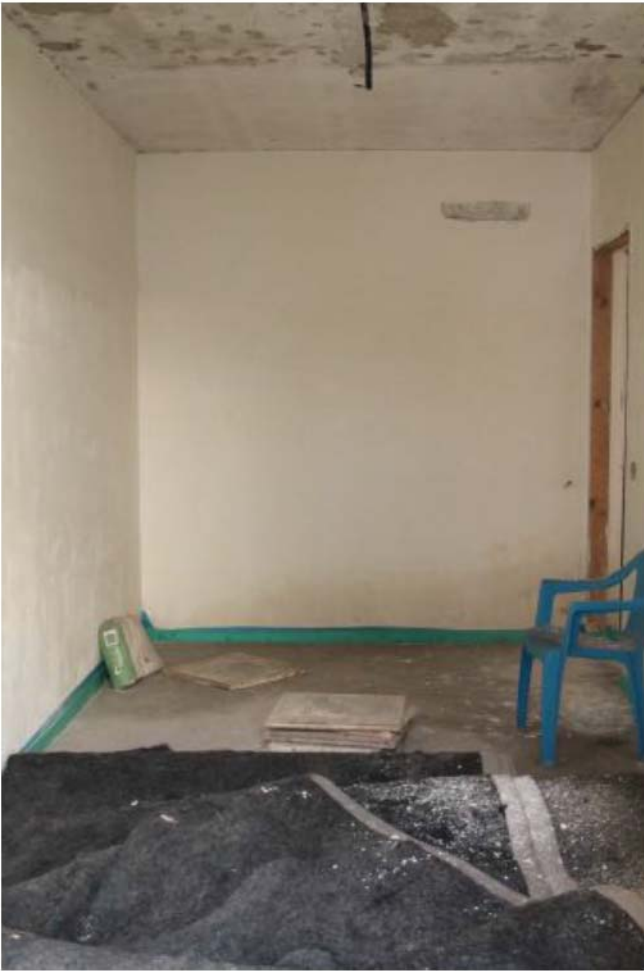
Foto 5. Interno, camera sub.34
