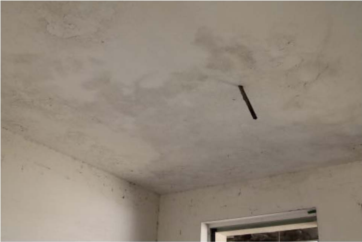
Foto 7. Interno, soffitto sub.40
