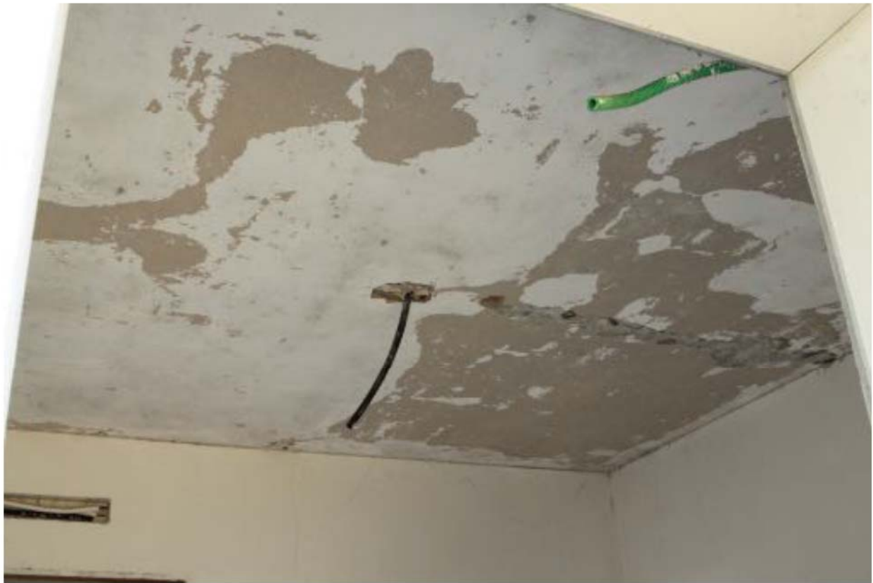
Foto 6. Interno, soffitto camera sub.39
