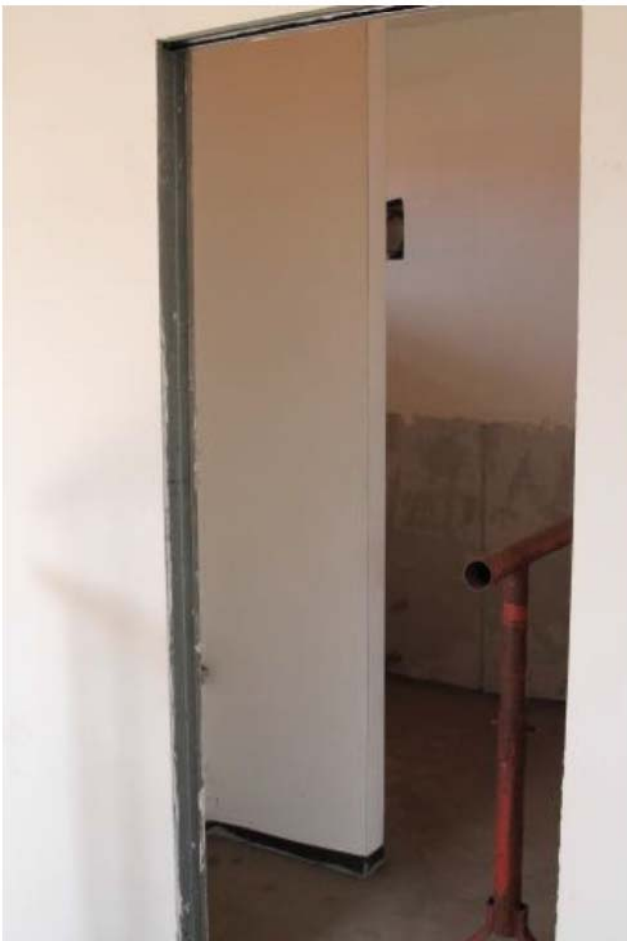
Foto 5. Interno, bagno sub.37
