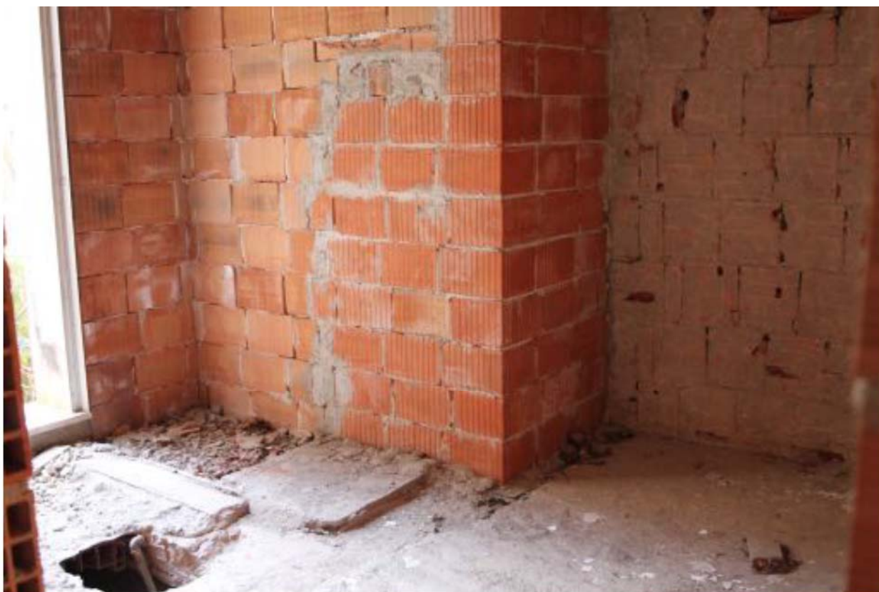
Foto 9. Interno, camera sub.32
