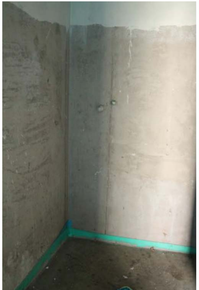
Foto 8. Interno, bagno sub.34
