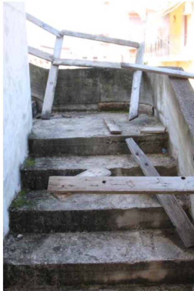
Foto 13. Esterno scala esterna
