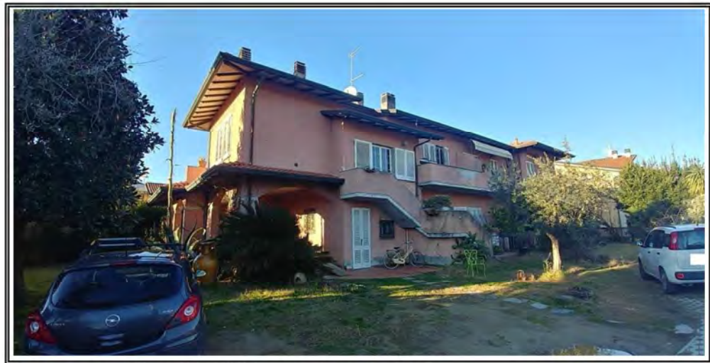
Foto n. 1 – Vista del fabbricato – Angolo SUD
