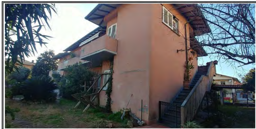
Foto n. 2 – Vista del fabbricato – Angolo EST
