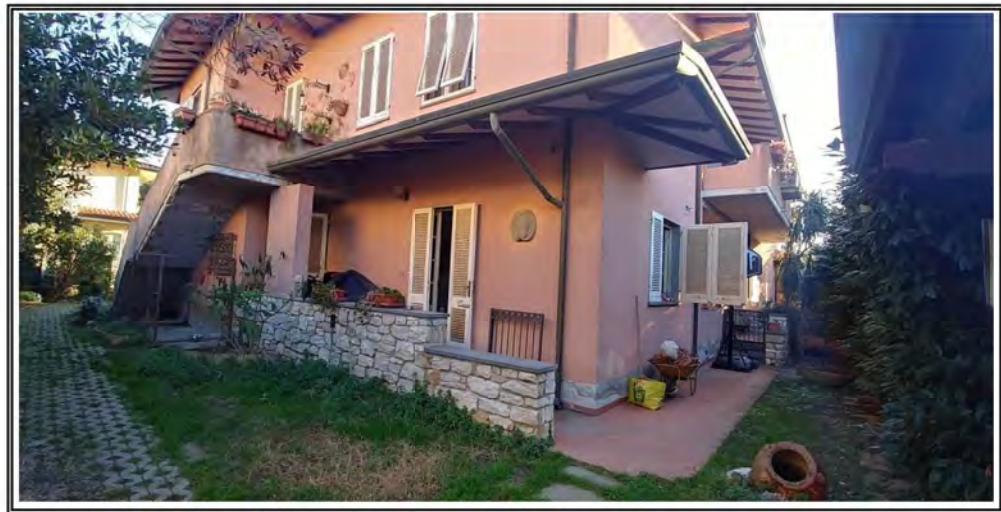
Foto n. 4 – Vista dell'appartamento dall'esterno
