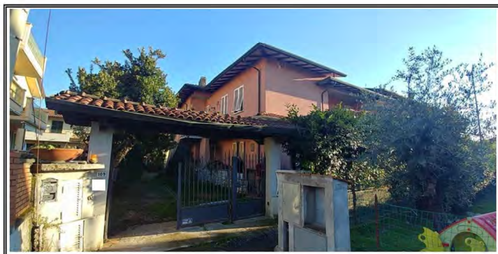
Foto n. 3 – Vista del fabbricato – Angolo NORD
