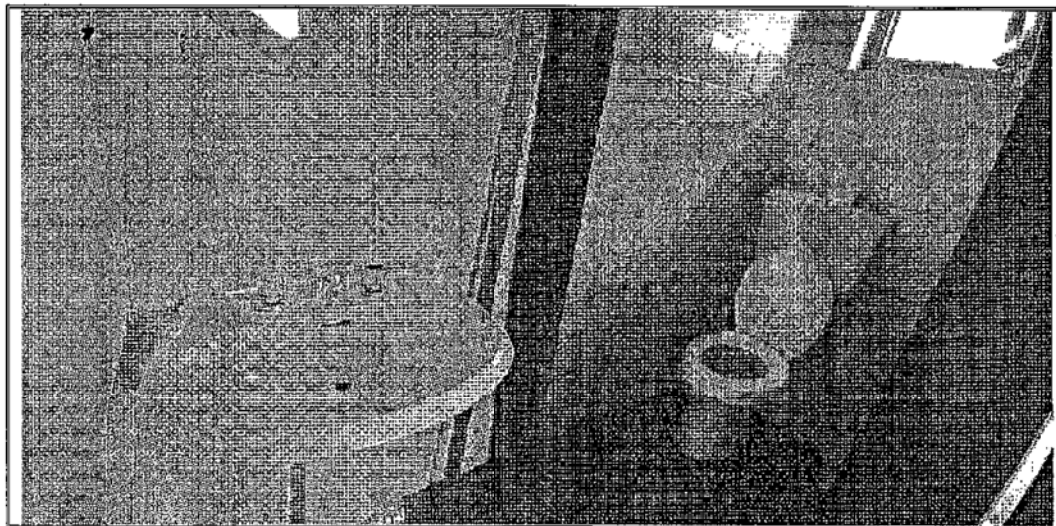
██████████ Servizio igienico al piano primo – corpo uffici
