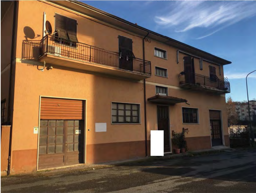
esterno fronte strada Via Marconi 23
