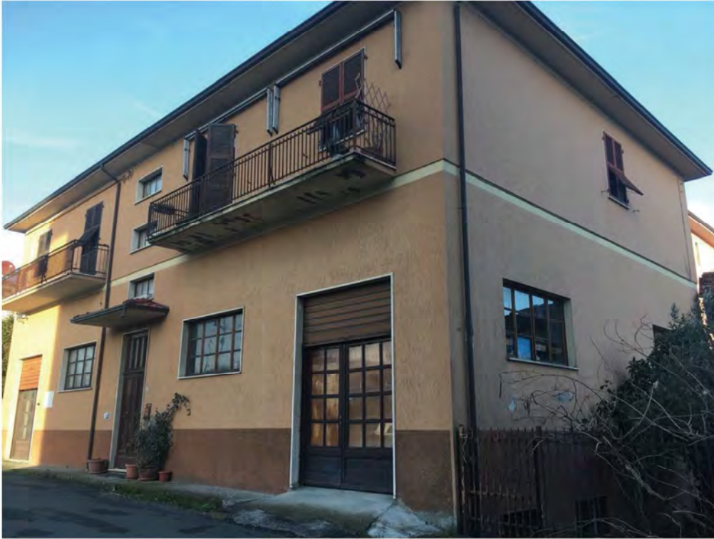
esterno fronte strada Via Marconi 23
