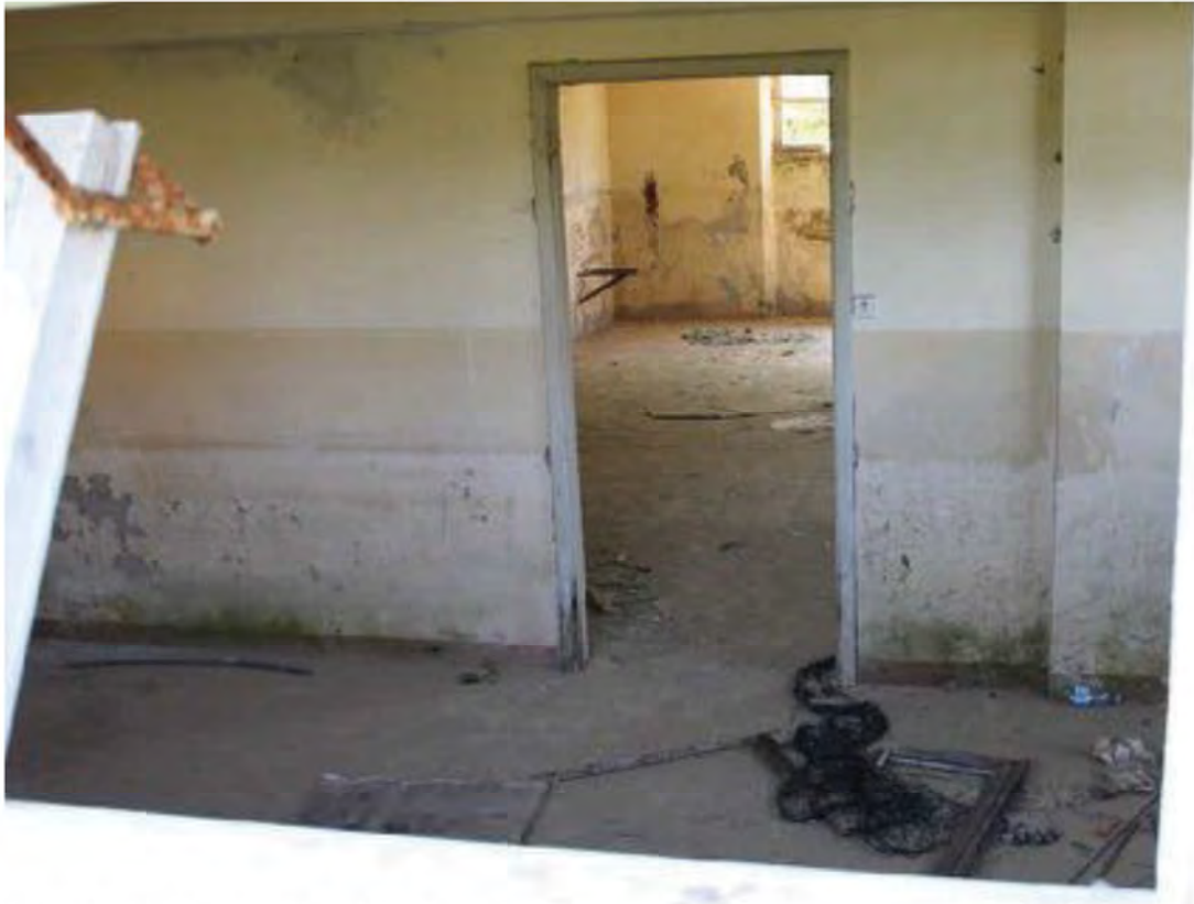
Foto 16. Interno edificio n°20, seminterrato
