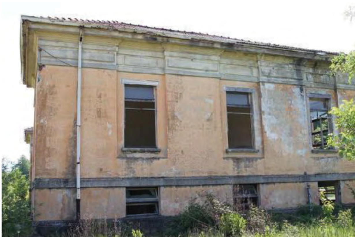
Foto 33. Esterno edificio n°20
