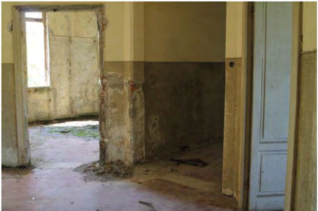
Foto 17. Interno edificio n°20
