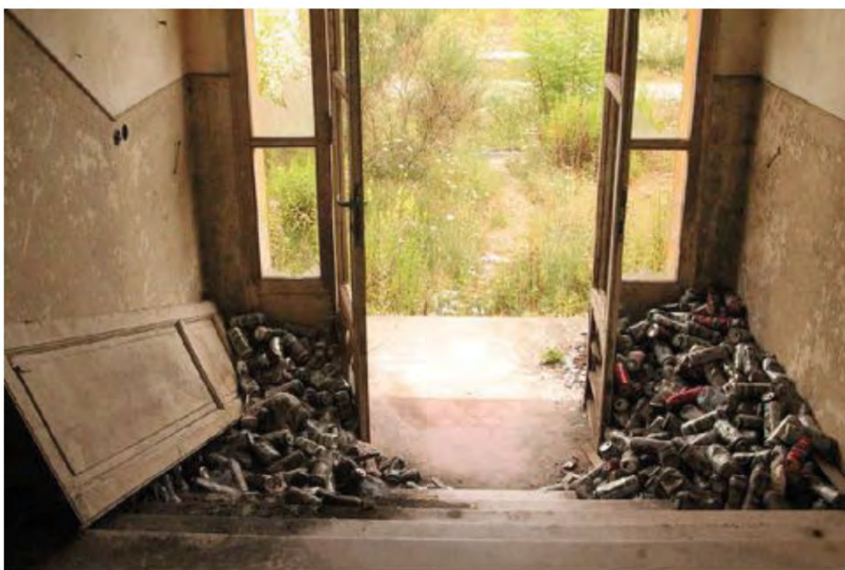
Foto 19. Interno edificio n°20
