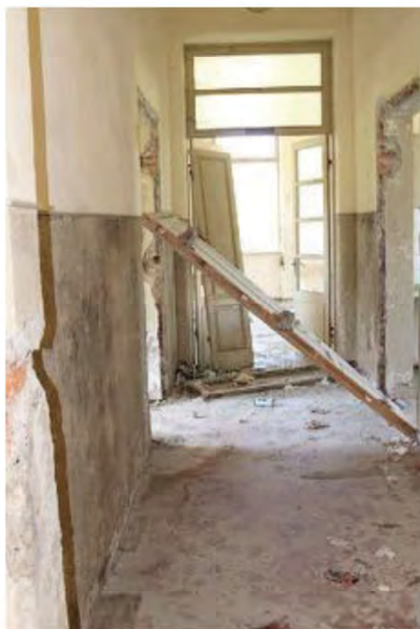
Foto 25. Interno edificio n°20
