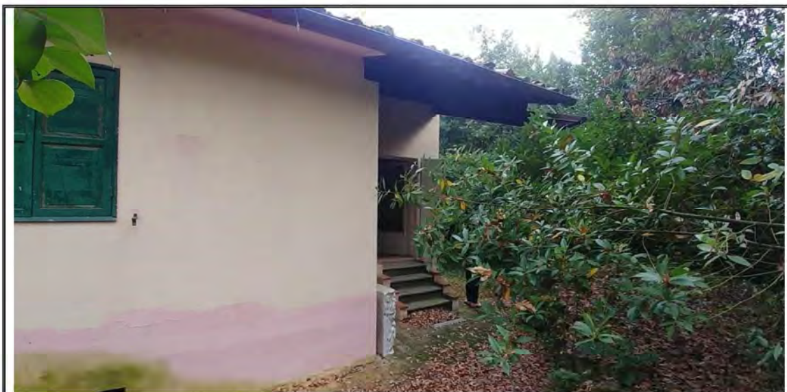
Foto n. 4 – Vista del fabbricato – Portico d'ingresso
