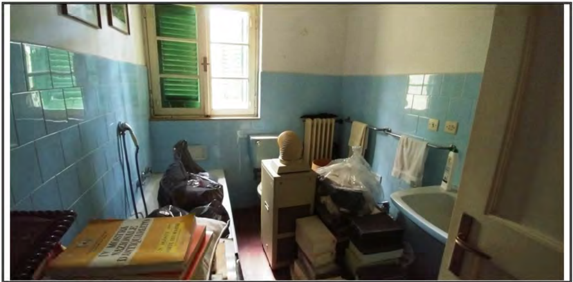
Foto n. 10 – Piano terra - Bagno
