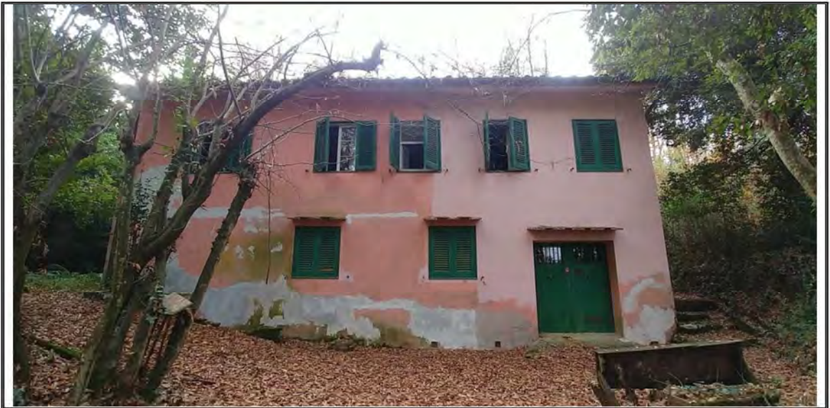
Foto n. 3 – Vista del fabbricato – Facciata lato NORD-EST
