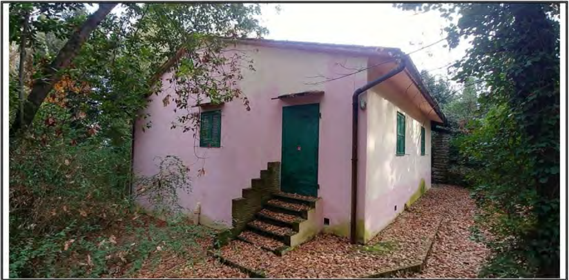
Foto n. 1 – Vista del fabbricato – Angolo OVEST
