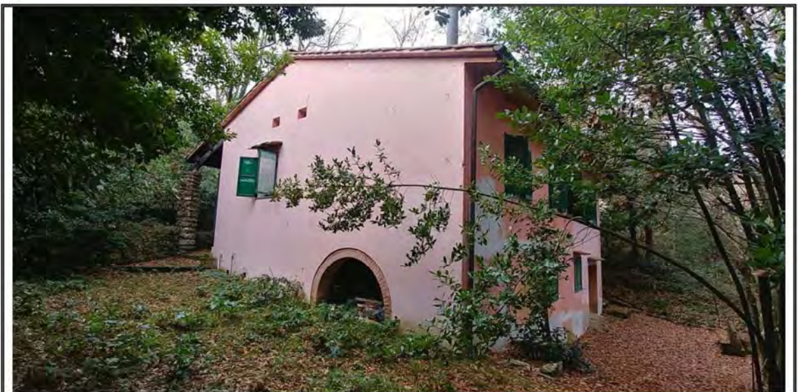
Foto n. 3 – Vista del fabbricato – Angolo EST
