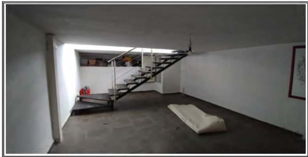
Foto n. 22 – Piano interrato - Cantina
