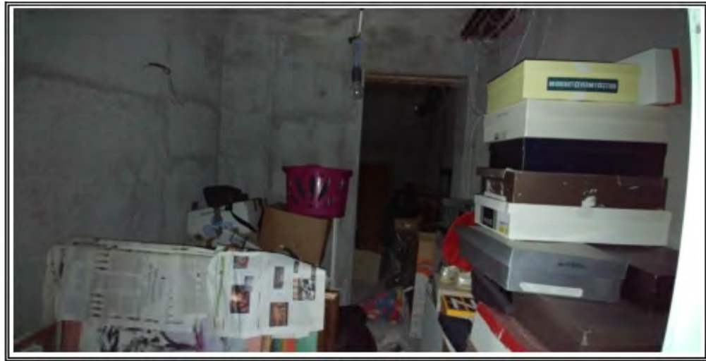
Foto n. 19 – Piano seminterrato - Ripostiglio
