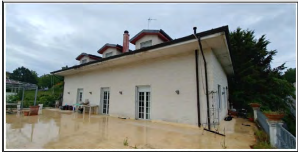
Foto n. 4 – Vista del fabbricato angolo NORD-OVEST – Piano terra
