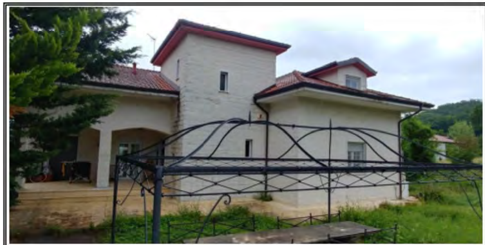
Foto n. 2 – Vista del Fabbricato, facciata lato SUD
