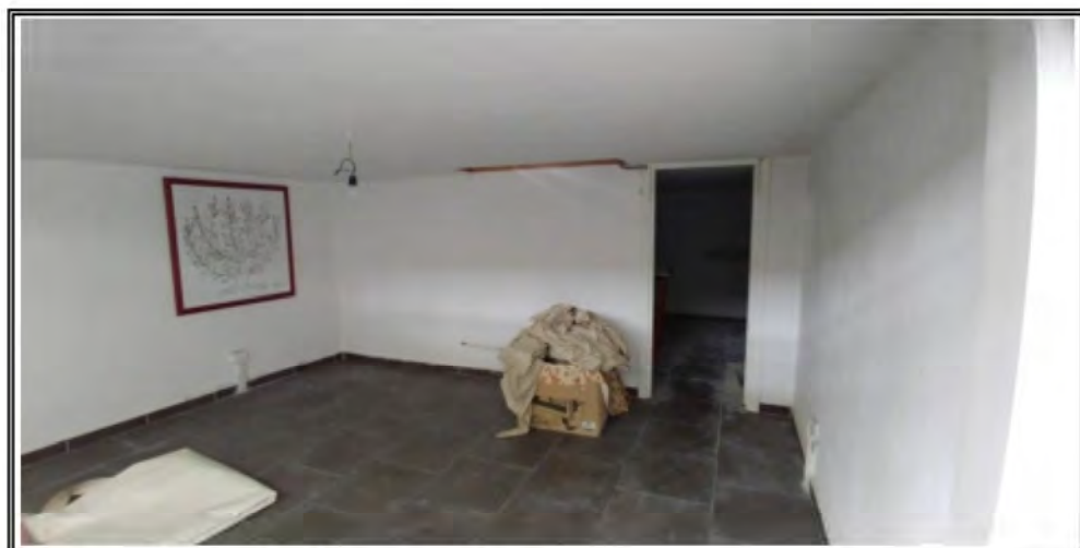
Foto n. 23 – Piano interrato - cantina
