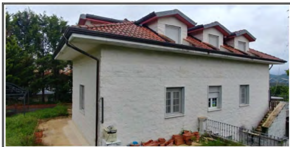
Foto n. 3 – Vista del fabbricato angolo SUD-EST
