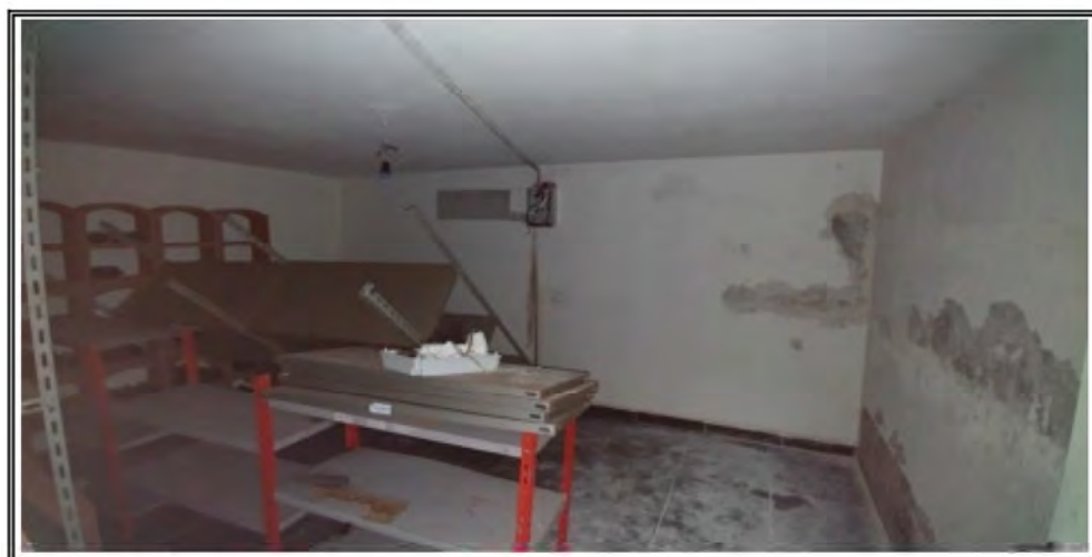
Foto n. 24 – Piano interrato - cantina
