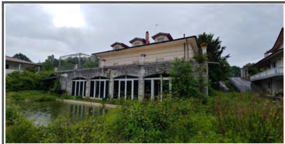
Foto n. 5 – Vista del fabbricato angolo NORD-OVEST
