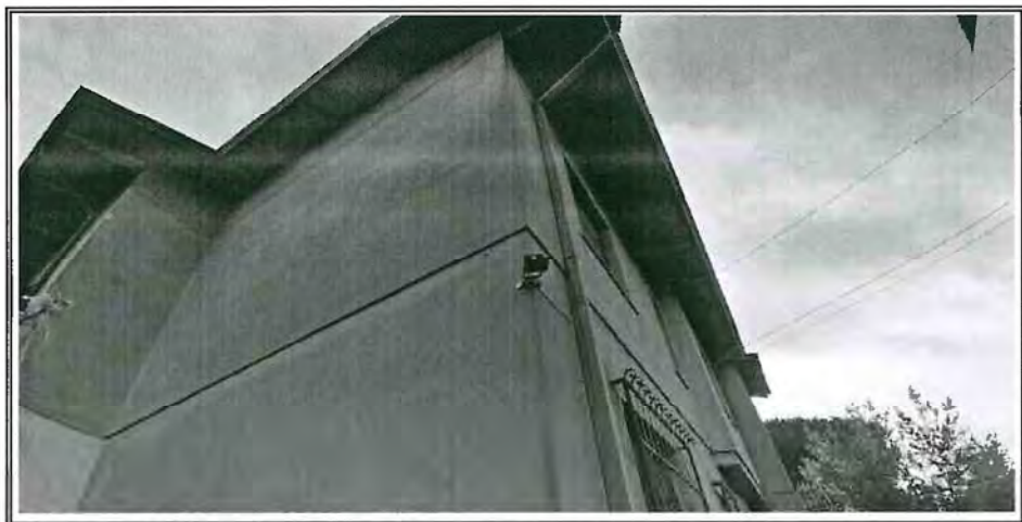
Foto n. 3 – Vista del fabbricato angolo Nord
