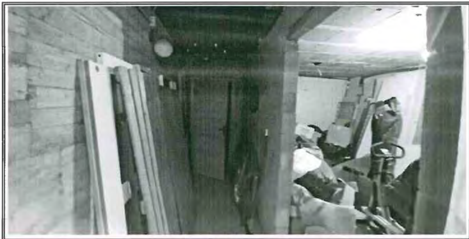
Foto n. 9 – Piano seminterrato – Corridoio comune
