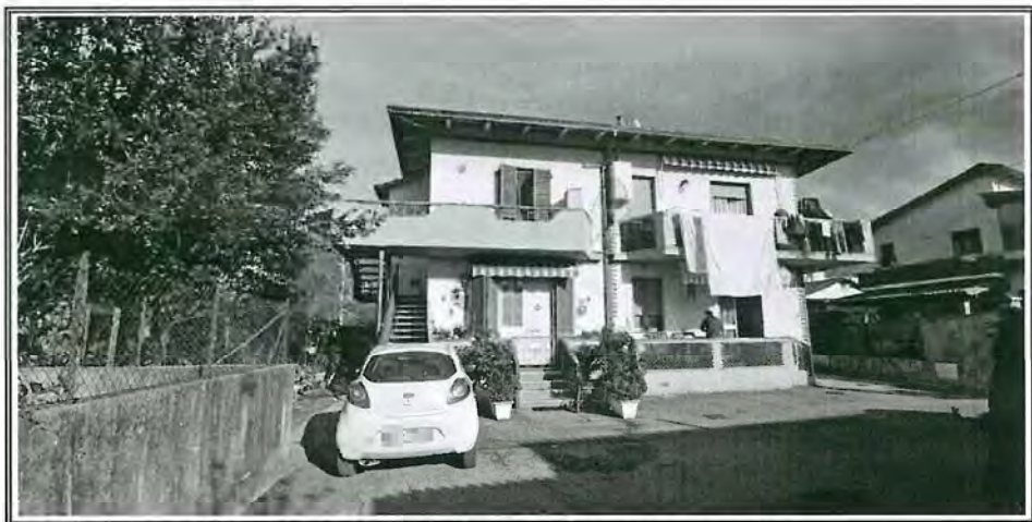
Foto n. 2 – Vista del Fabbricato, facciata lato SUD-OVEST
