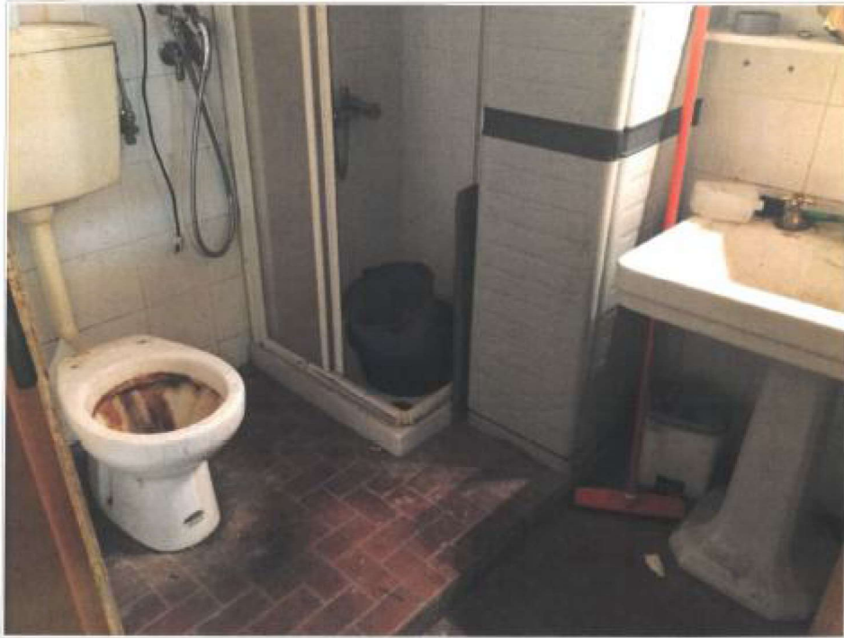
Wc piano terra subalterno 2
