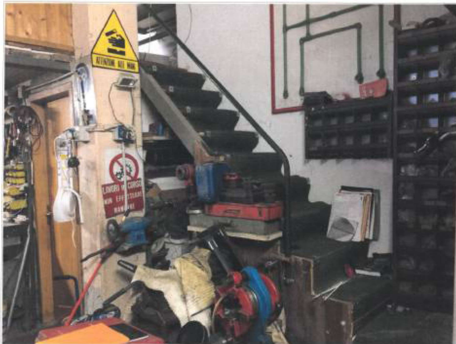
Scale di accesso al piano soppalcato subalterno 2
