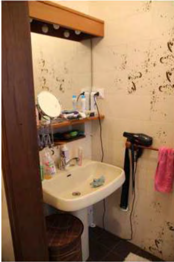
FOTO 22. Bagno 2 interno a camera 2
