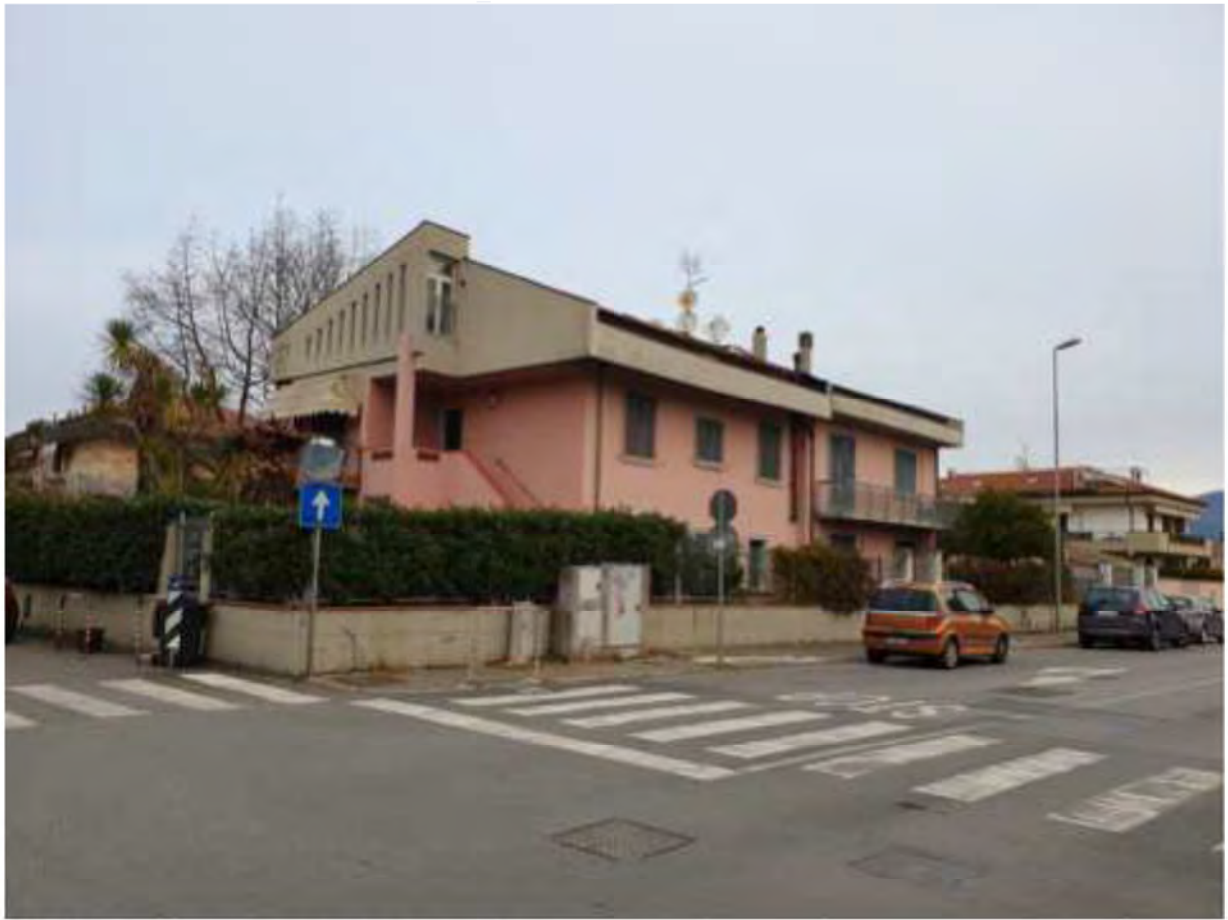
FOTO 44. Fabbricato angolo via Micheli via Bassagrande
