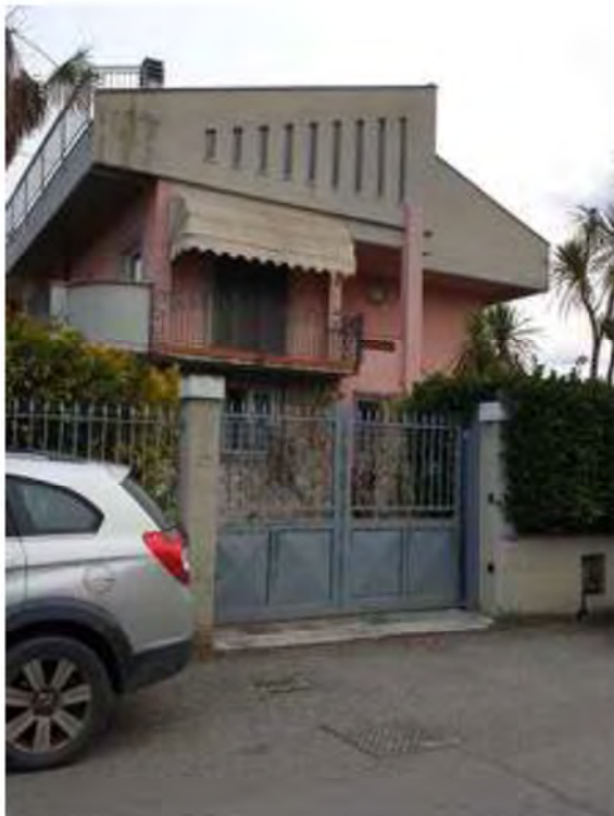
FOTO 41, 42 e 43. Prospetto fabbricato lato mare
