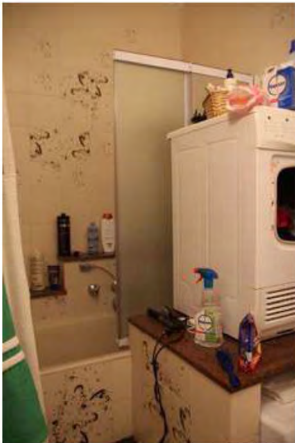
FOTO 20. Bagno 2 interno a camera 2
