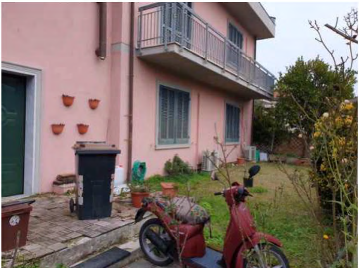
FOTO 41. Pertinenza esterna lato Massa (ingresso)
