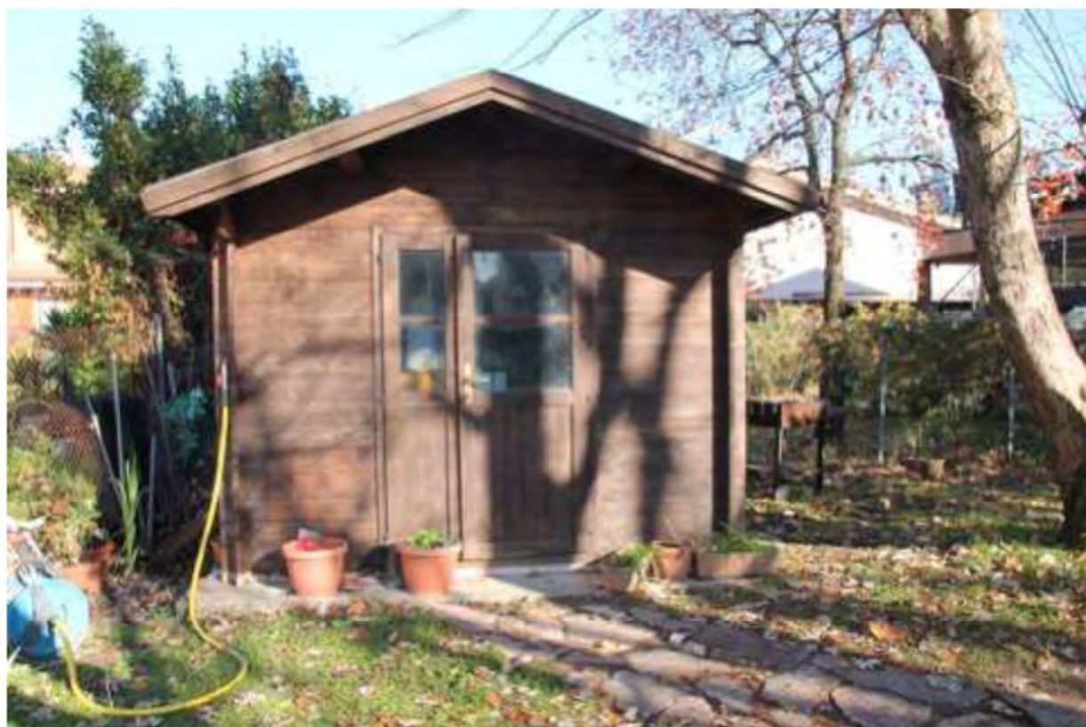
FOTO 36. Piccolo fabbricato abusivo
