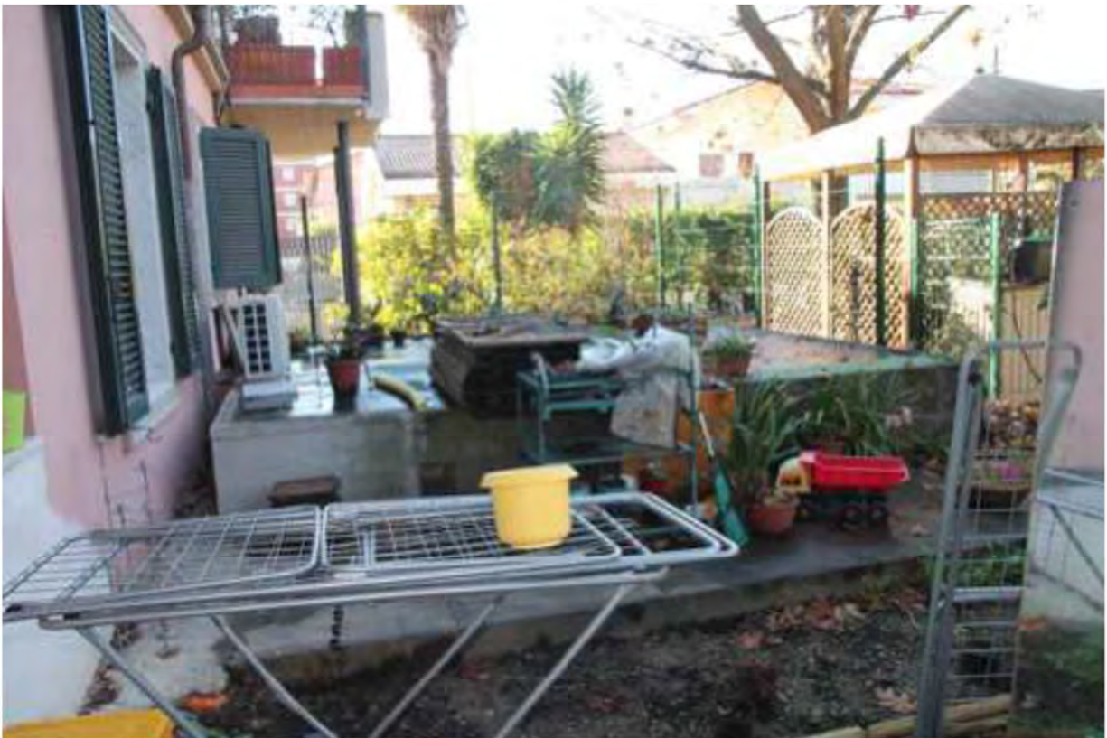
FOTO 33. Lastrico solare mapp.246 sub.7
