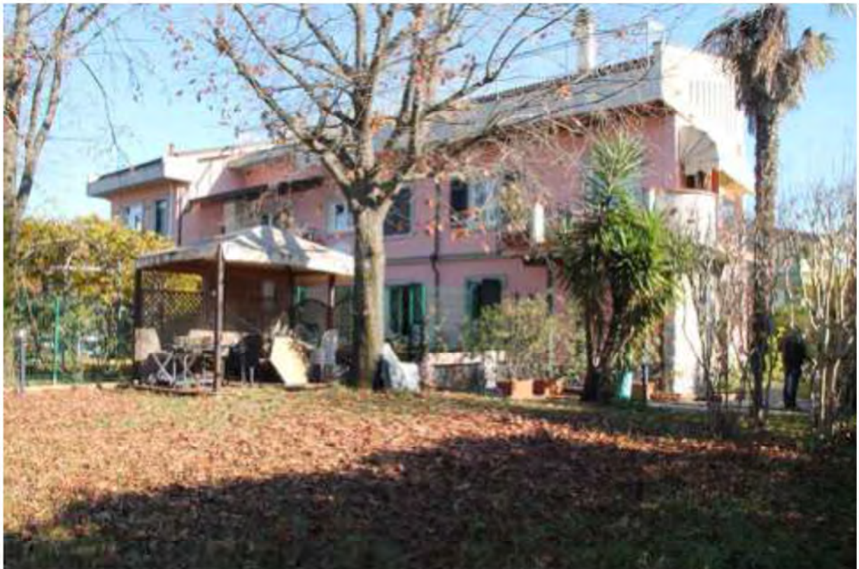
FOTO 40. Prospetto fabbricato lato Spezia
