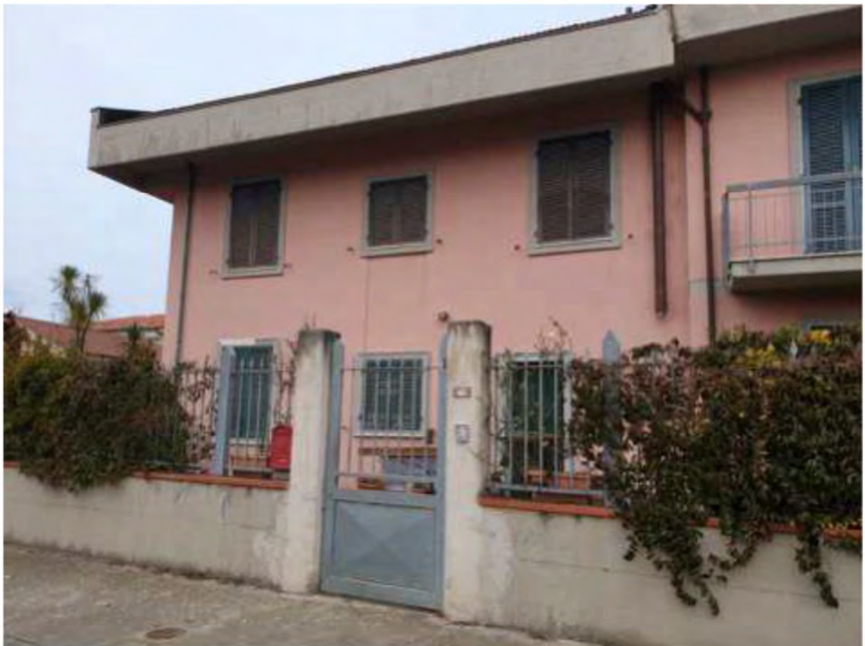
FOTO 39. Pertinenza esterna lato Massa (ingresso)
