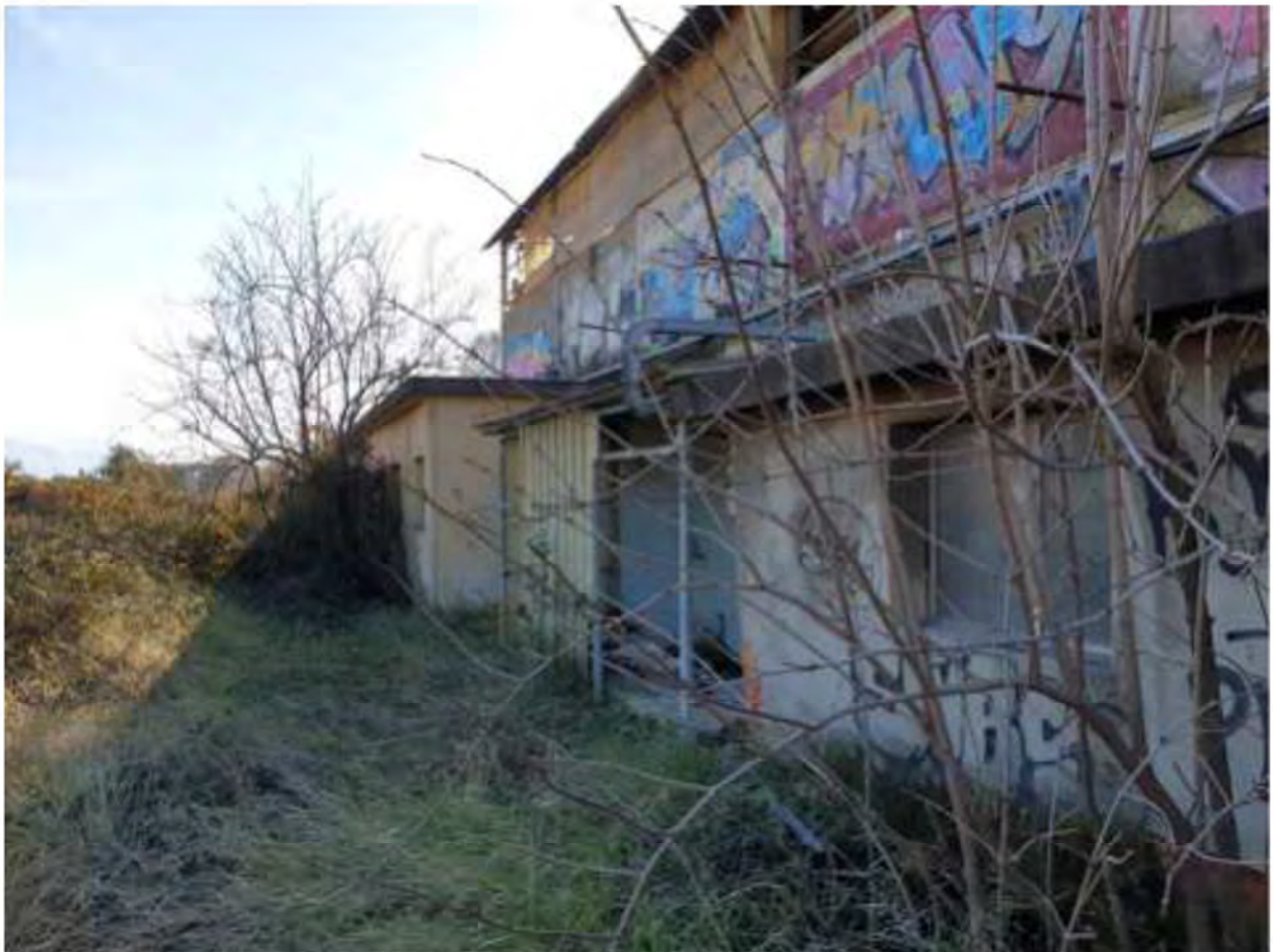
FOTO 40. Esterno lato monti capannone principale mapp.54 (ampliamenti 2, 3 e 4)
