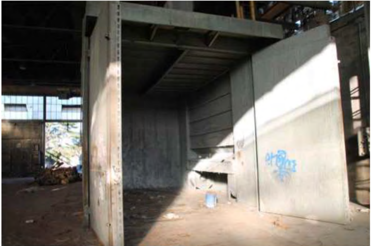
FOTO 7. Cabina di lavoro interna al capannone principale mapp.50
