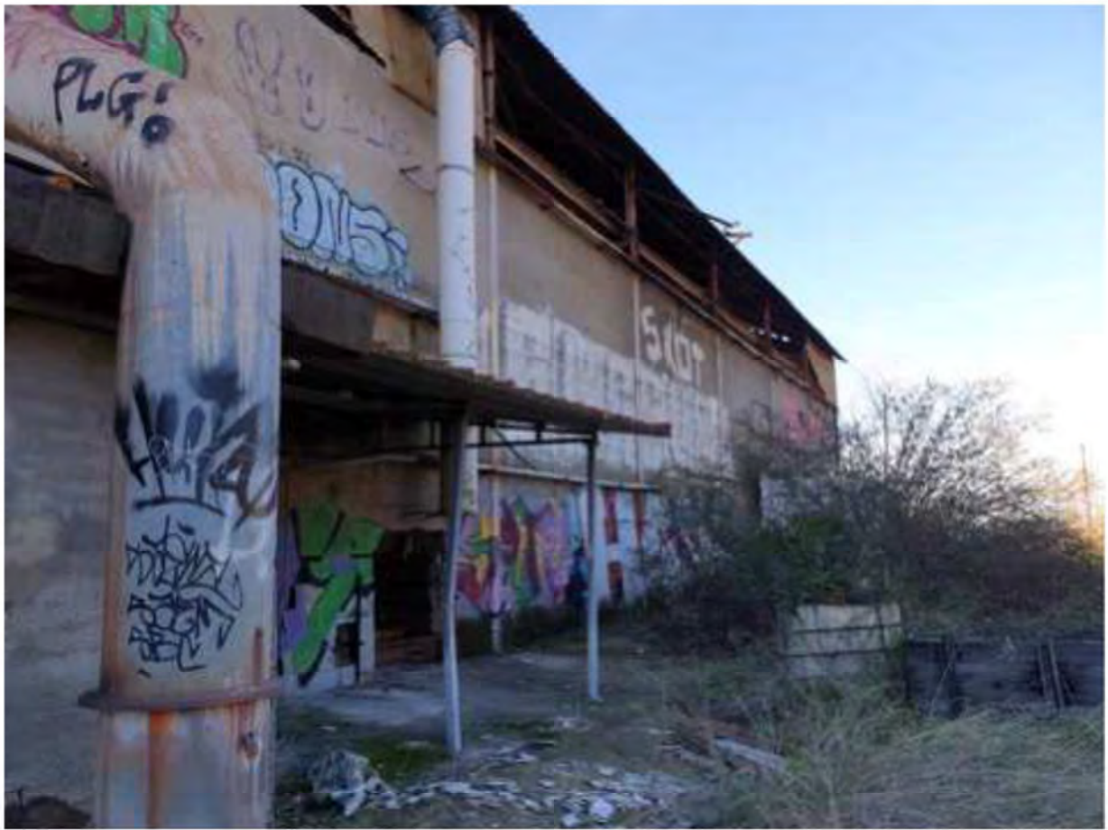
FOTO 34. Esterno lato monti capannone principale mapp.54
