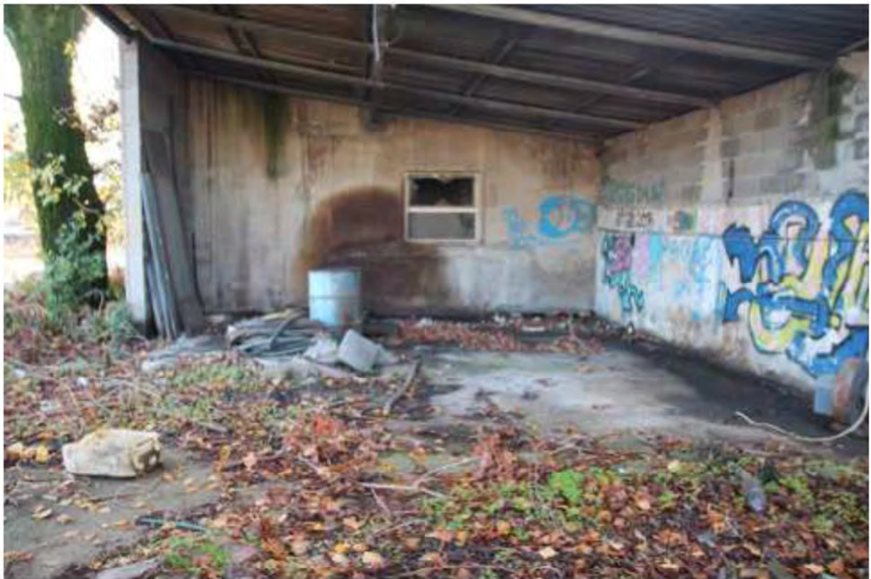
FOTO 25. Tettoia posta in aderenza a via Bordigona (tettoia 4)
