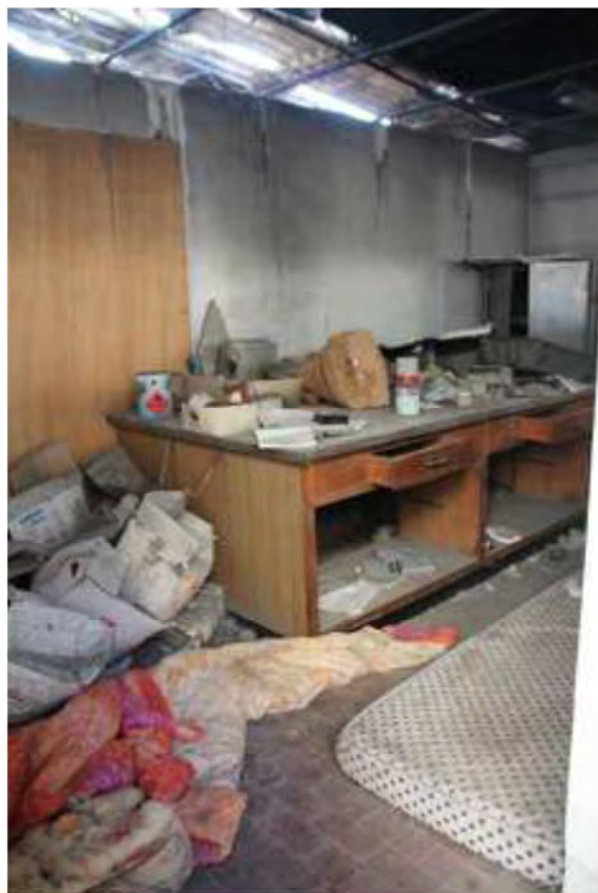
FOTO 26. Interno dei volumi posti in aderenza a via Bordigona (magazzini 1)
