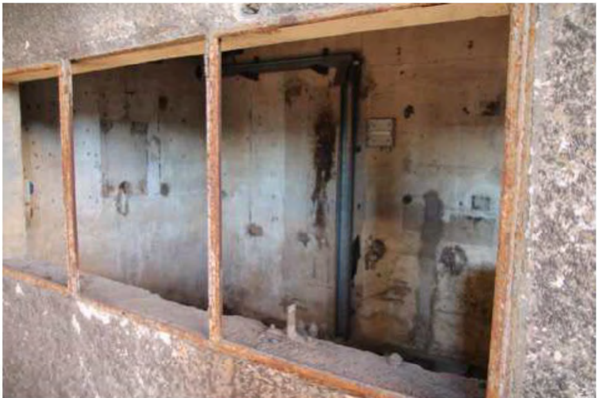
FOTO 53. Interno capannone principale mapp.54 (ampliamento 3)
