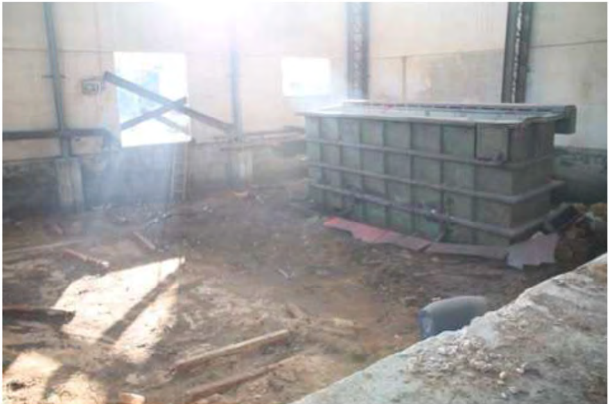
FOTO 6. Spazio ribassato all'interno del capannone principale mapp.50
