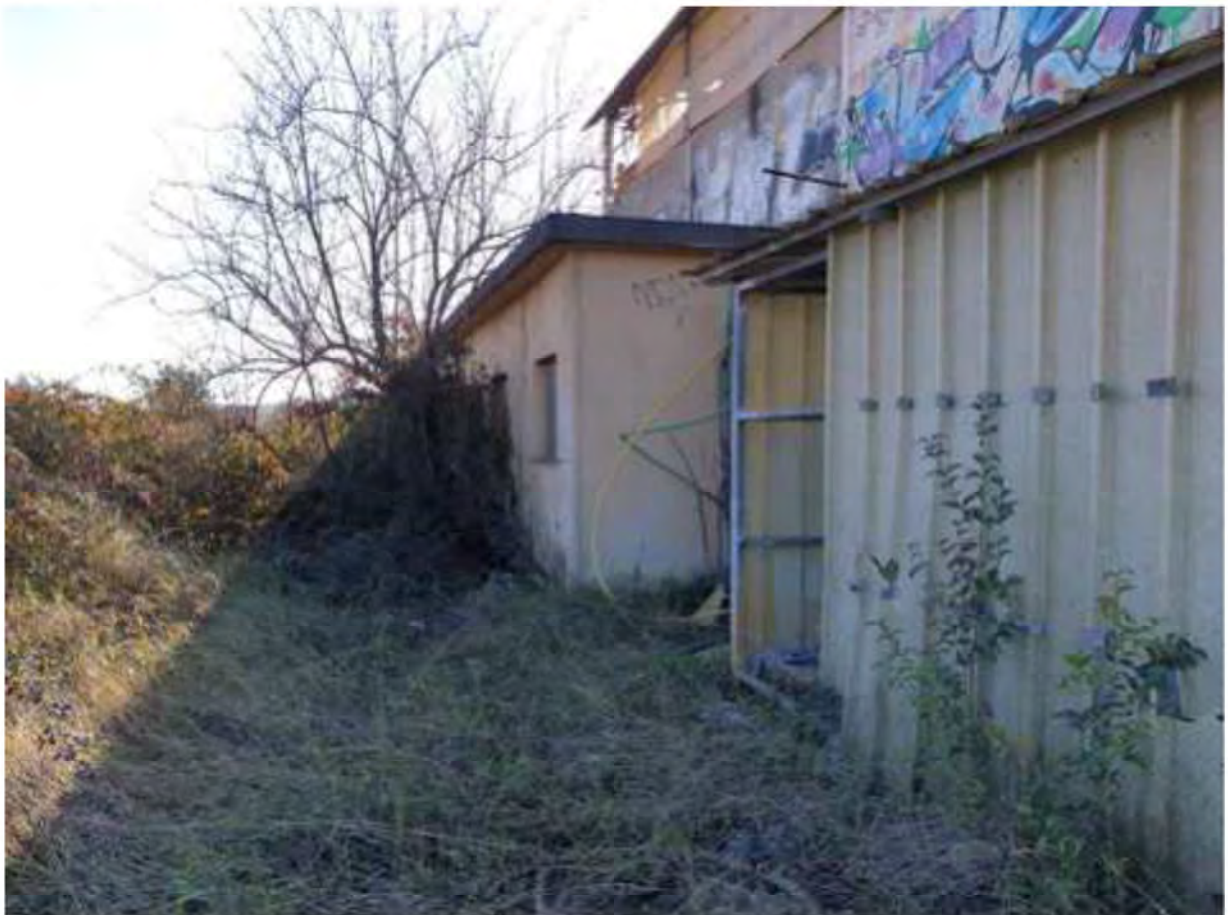
FOTO 37. Esterno lato monti capannone principale mapp.54 (ampliamento 4)
