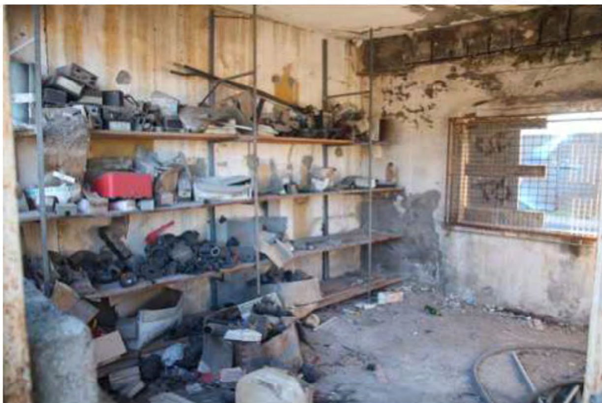
FOTO 27. Interno dei volumi posti in aderenza a via Bordigona (magazzini 2)
