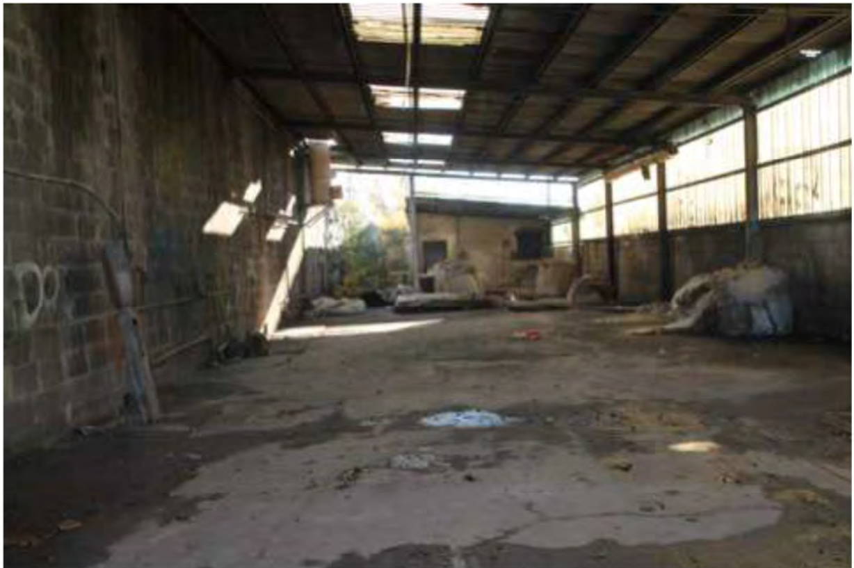
FOTO 12. Tettoia posta lato mare del capannone principale mapp.50 (tettoia 1)
