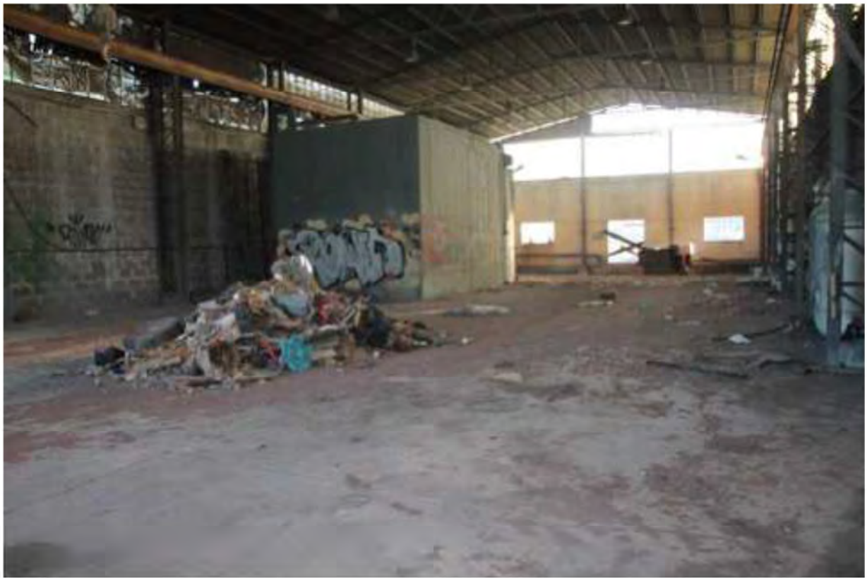
FOTO 11. Interno capannone principale mapp.50
