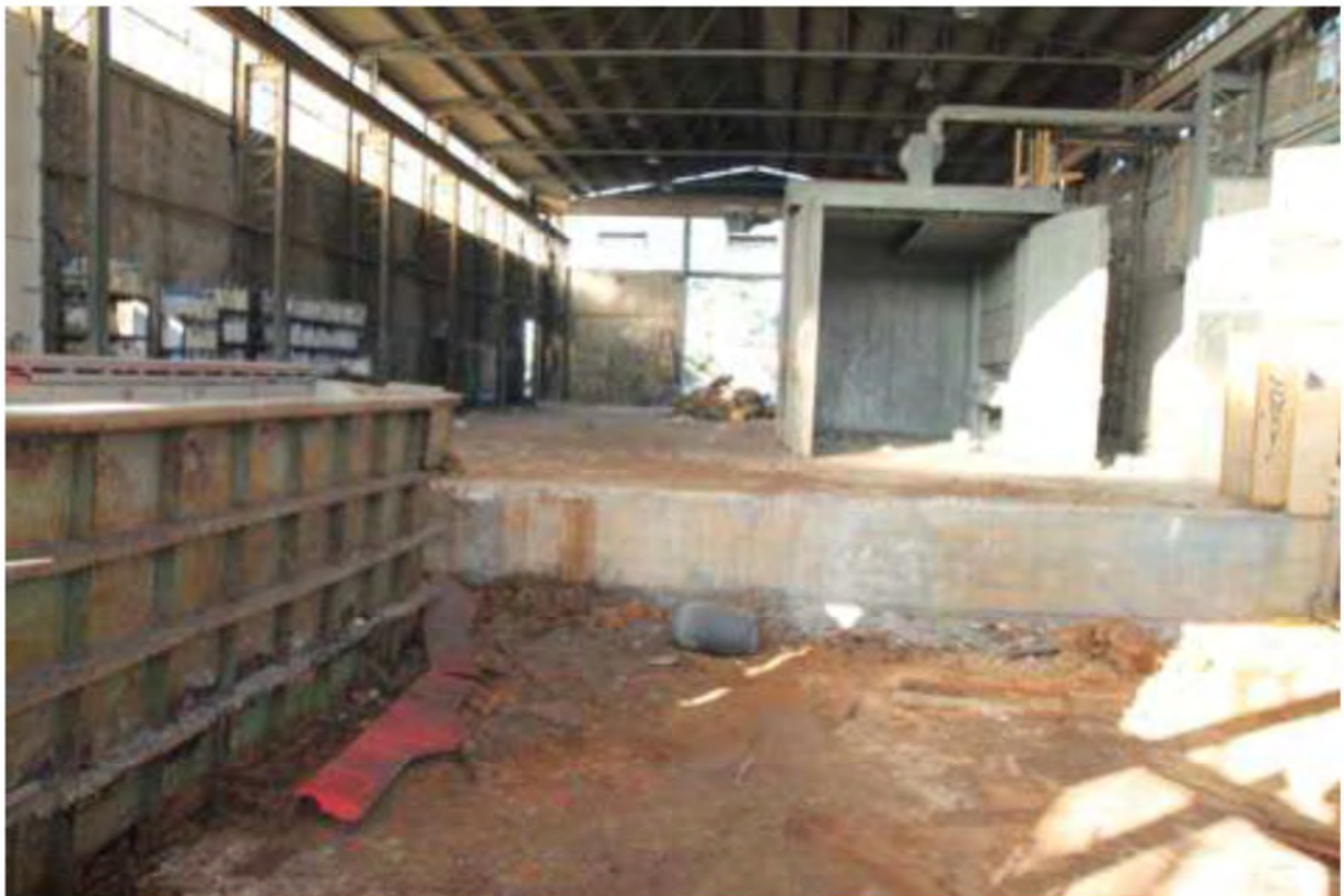
FOTO 10. Interno capannone principale mapp.50
