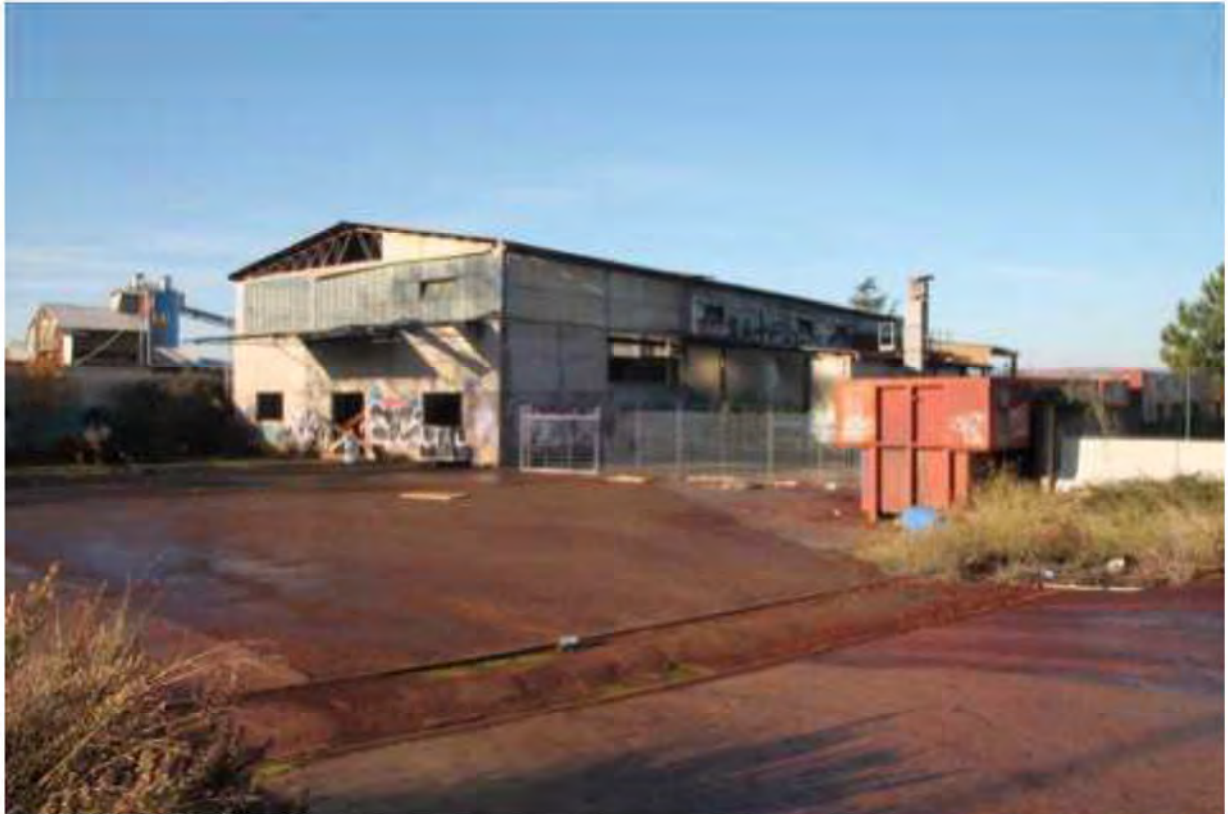
FOTO 1. Capannone principale su mapp.50
