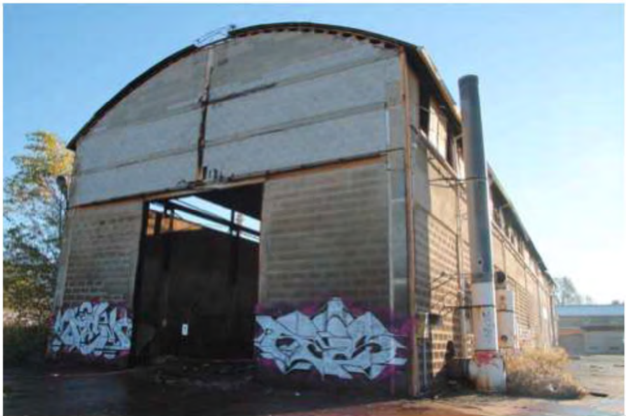
FOTO 31. Esterno capannone principale mapp.54
