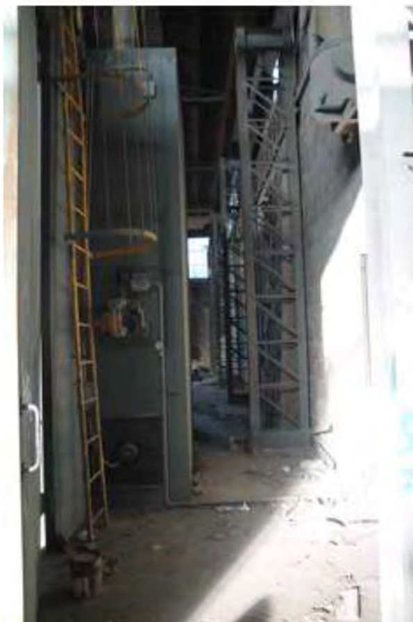
FOTO 8. Spazio laterale a cabina di lavoro interna al capannone principale mapp.50
