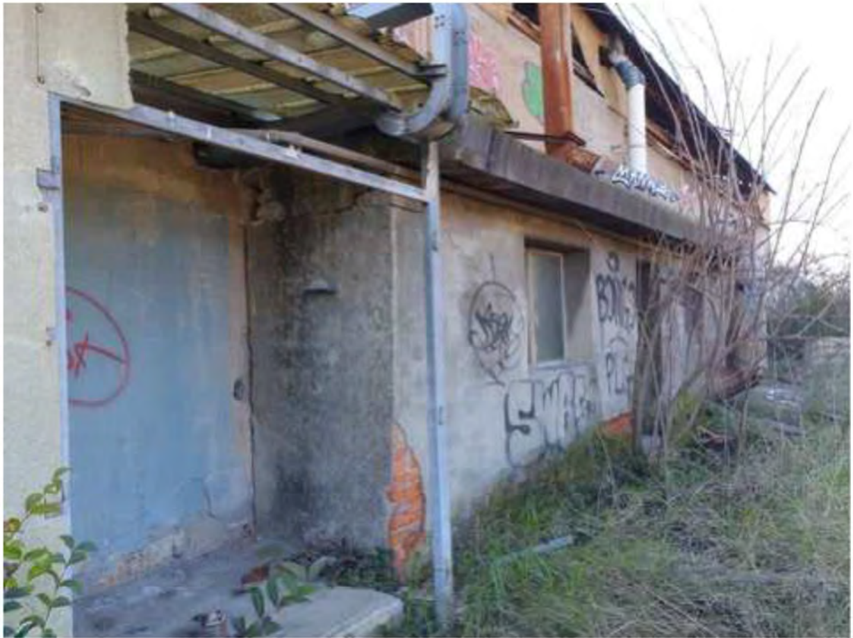
FOTO 36. Esterno lato monti capannone principale mapp.54 (ampliamento 2 e 3)
