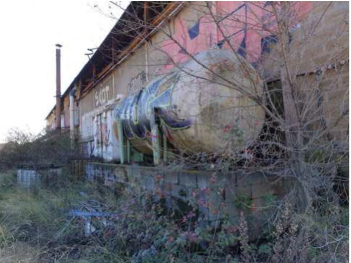
FOTO 33. Esterno lato monti capannone principale mapp.54
