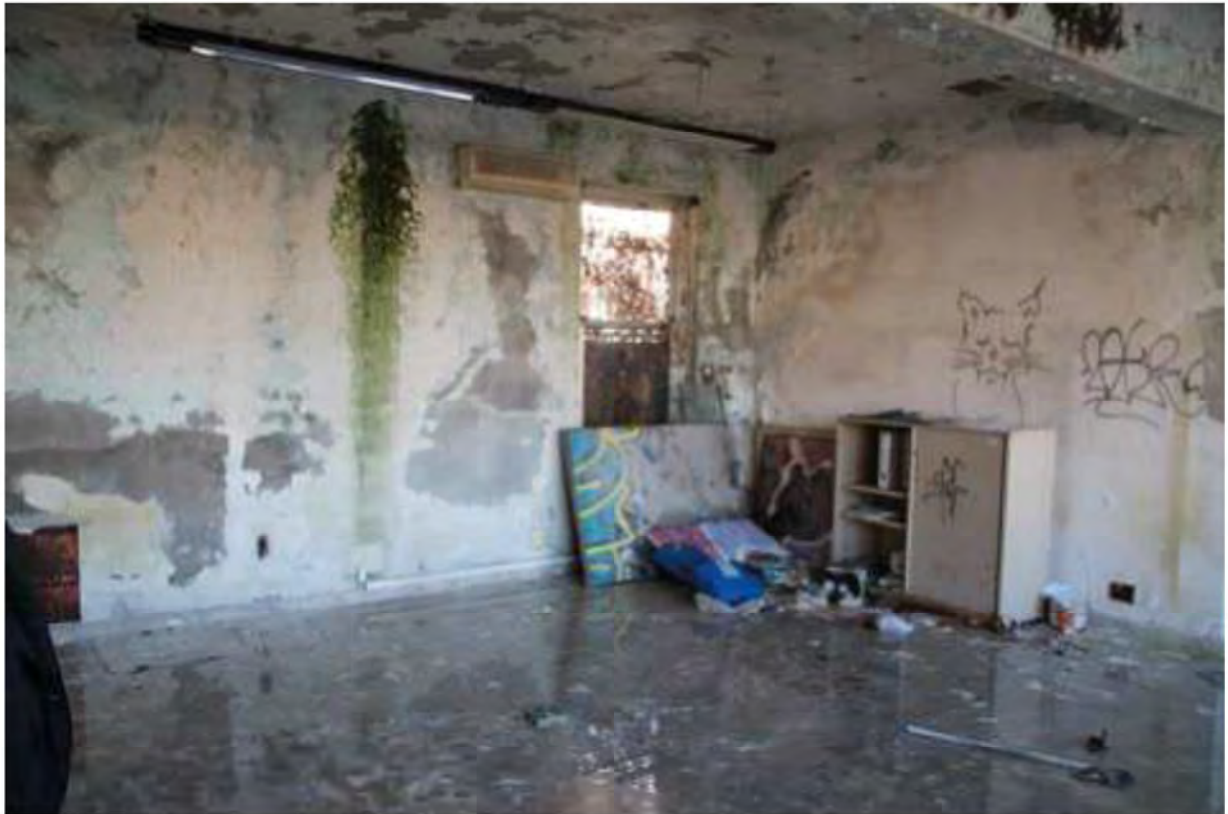
FOTO 63. Interno palazzina uffici
