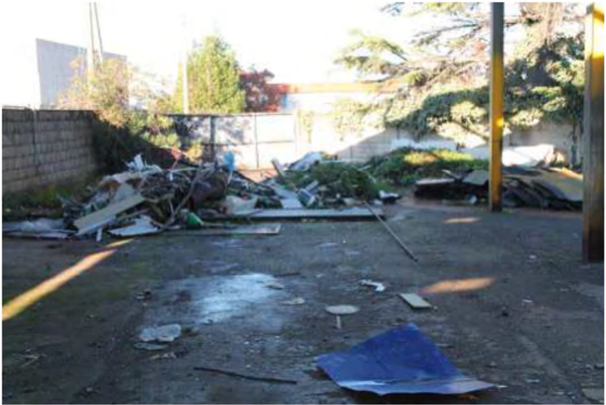
FOTO 13 Tettoia posta lato mare del capannone principale mapp.50 (tettoia 2)
