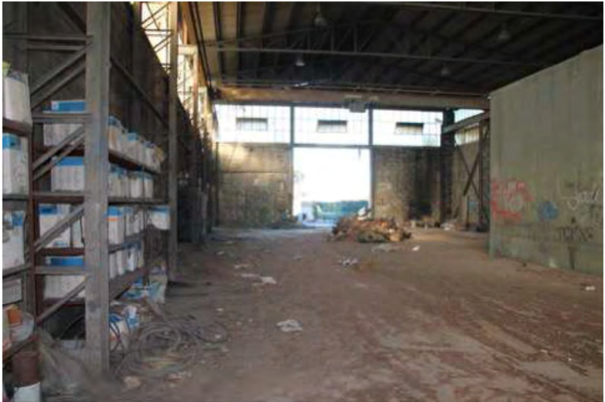
FOTO 9. Interno capannone principale mapp.50
