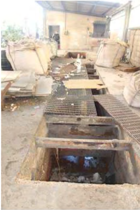
FOTO 16. Tettoia posta lato mare del capannone principale mapp.50 (tettoia 1 e 3)
