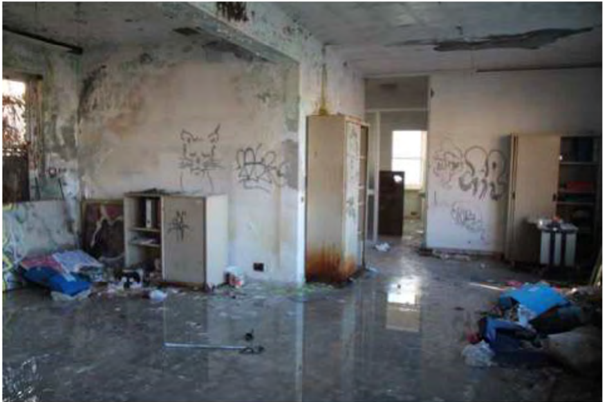
FOTO 54. Interno palazzina uffici
