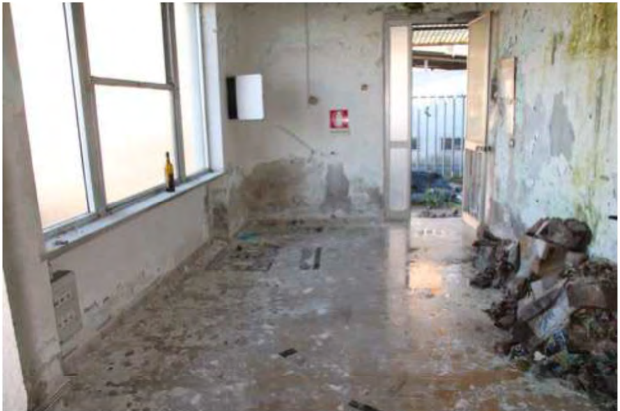
FOTO 61. Interno palazzina uffici
