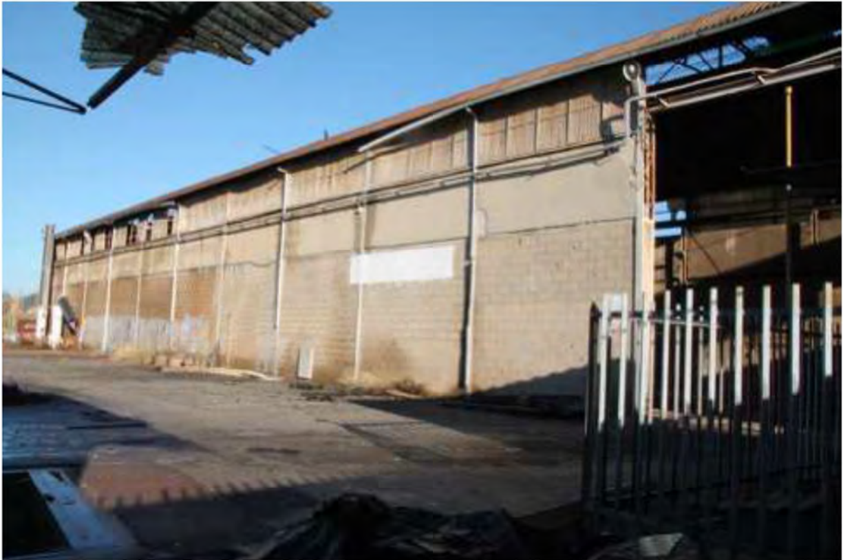
FOTO 32. Esterno capannone principale mapp.54
