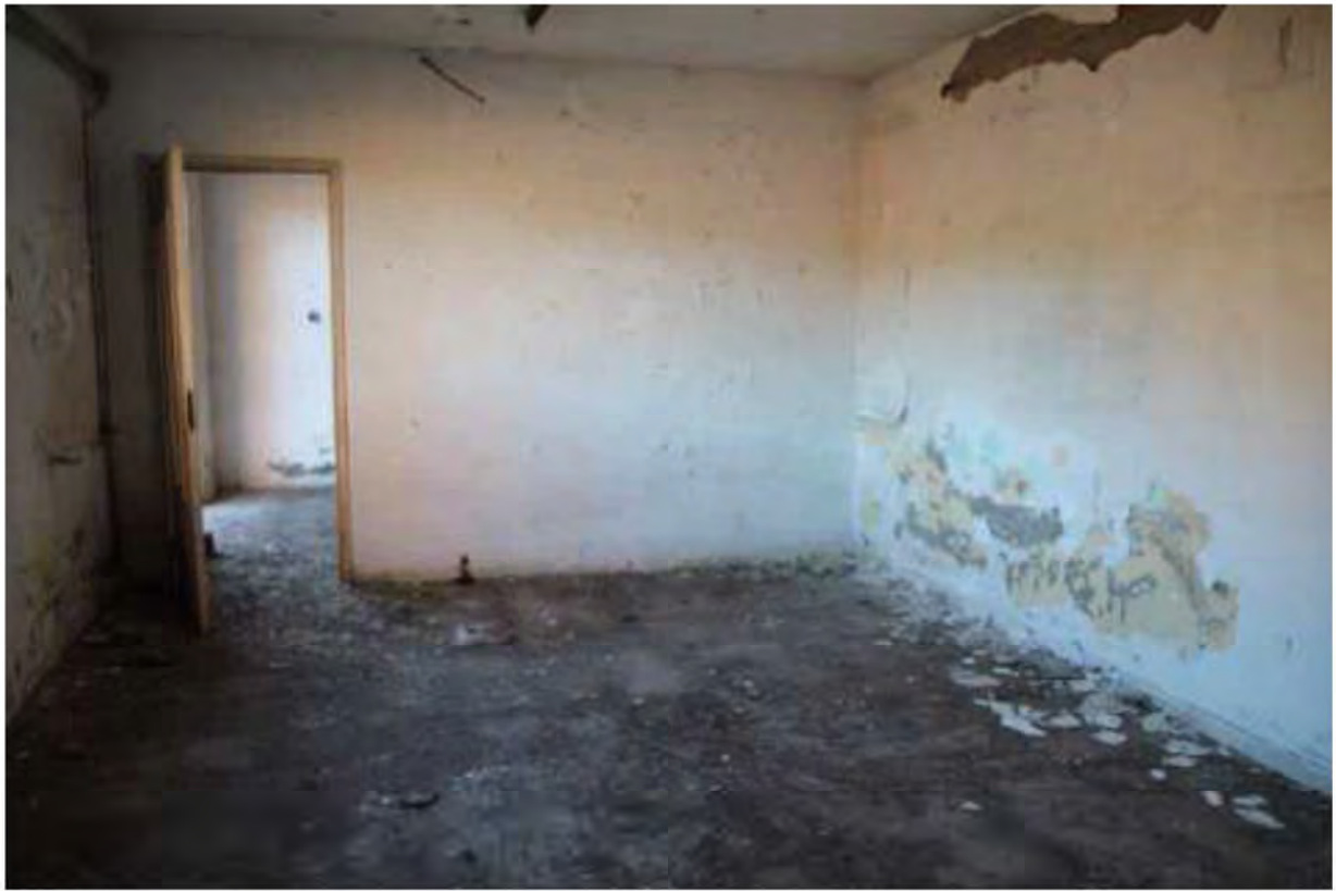
FOTO 28. Interno dei volumi posti in aderenza a via Bordigona (magazzini 2)
