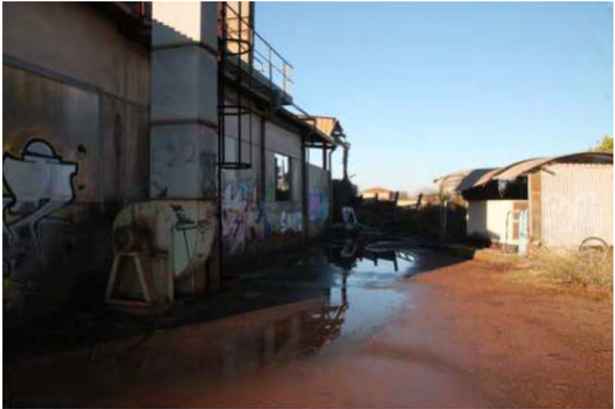
FOTO 5. Prospetto lato monti capannone principale mapp.50
