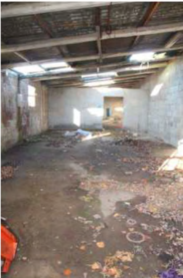
FOTO 22. Interno dei volumi posti in aderenza a via Bordigona (magazzini 1)
