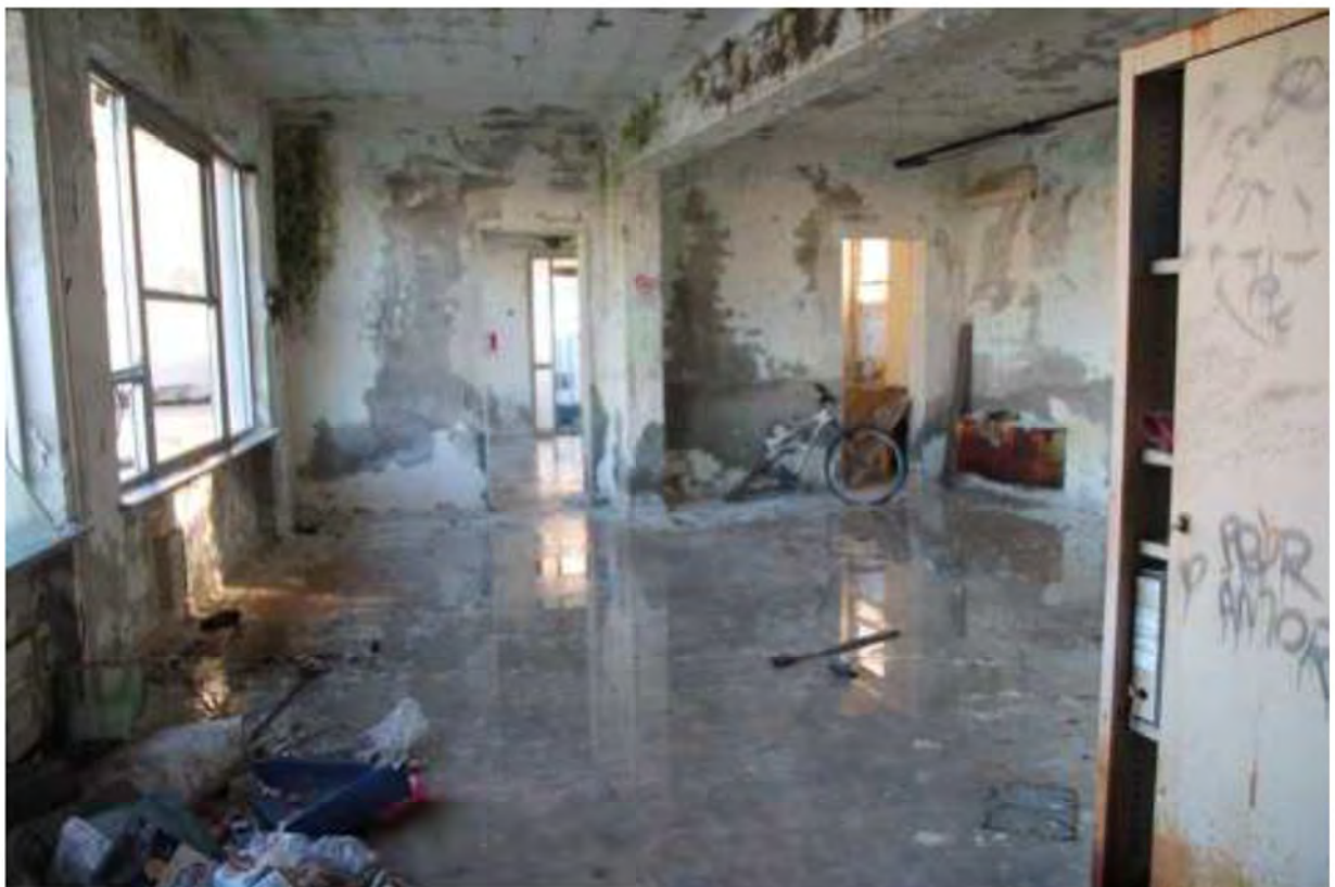
FOTO 62. Interno palazzina uffici
