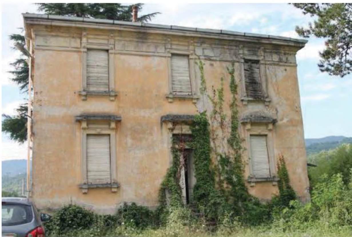
Foto 4. Fabbricato 2 prospetti nord-nord-ovest
