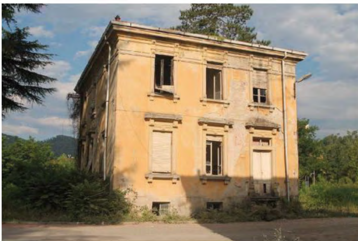
Foto 2. Fabbricato 2 prospetti est-nord-est
