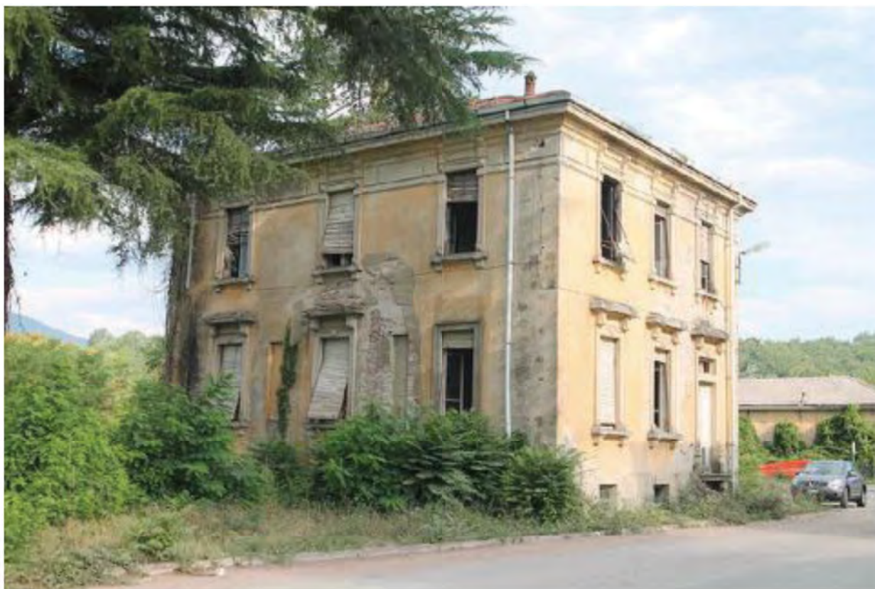
Foto 3. Fabbricato 2 prospetti sud-sud-est e est-nord-est
