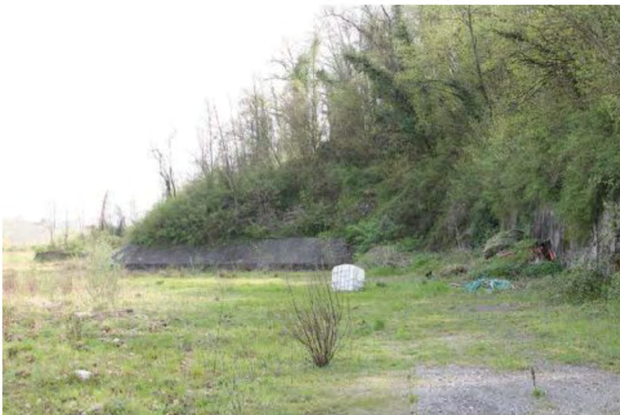
Foto 5. Muro di contenimento della pozione collinare del mapp.1677
