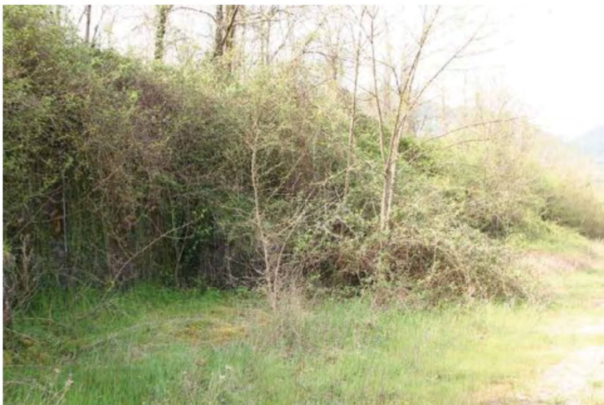
Foto 6. Vegetazione in corrispondenza del muro di contenimento della porzione collinare del mappale
