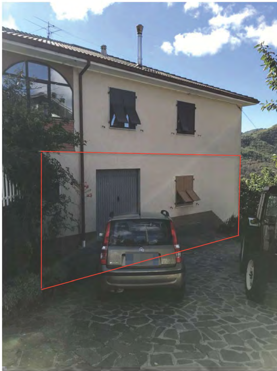
Foto E3: Frazione Castoglio, Zeri. Lotto 001. Cortile esterno lato nord-ovest.
