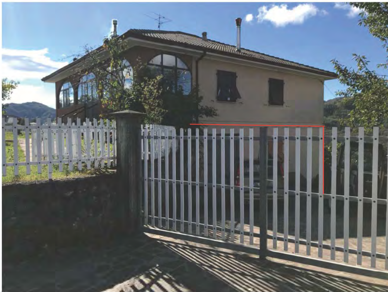
Foto E4: Frazione Castoglio, Zeri. Lotto 001. Esterno Abitazione, ingresso carrabile lato nord-ovest.
