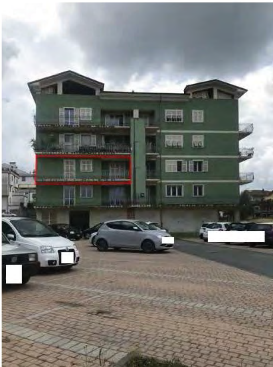
Foto E1: Largo Altiero Spinelli, Licciana Nardi, Località Masero, Terra Rossa Lotto 004 . Esterno.
