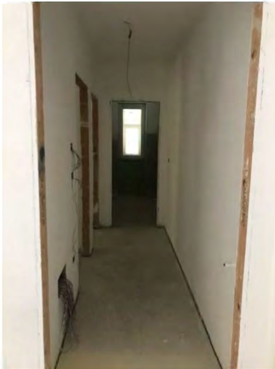
Foto 1: Largo Altiero Spinelli, Licciana Nardi, Località Masero, Terra Rossa Lotto 004 . Disimpegno.
