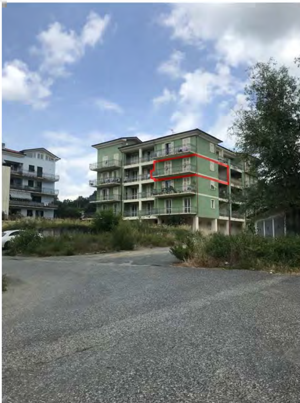
Foto E1: Largo Altiero Spinelli, Licciana Nardi, Località Masero, Terra Rossa Lotto 005 . Esterno.
