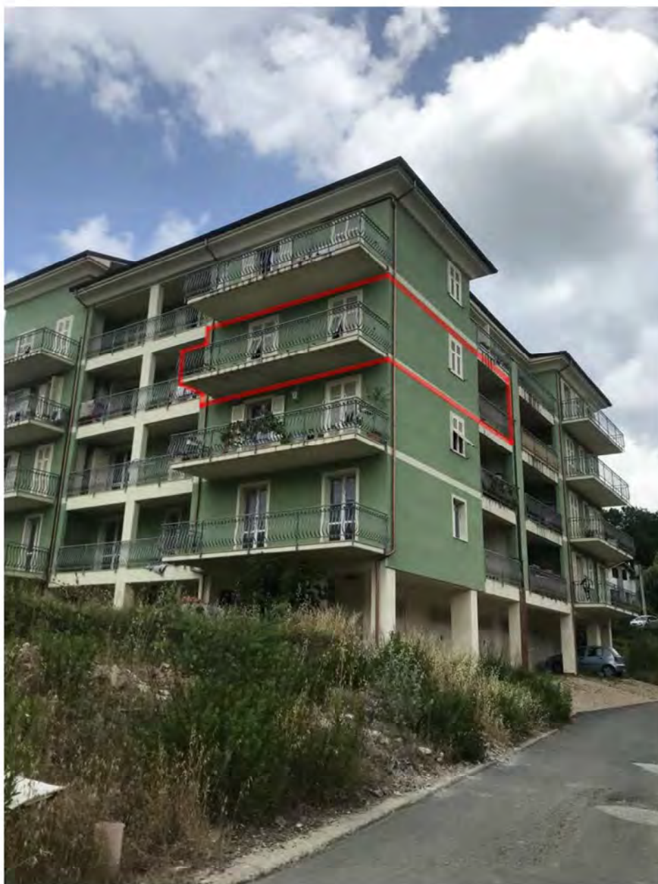
Foto E2: Largo Altiero Spinelli, Licciana Nardi, Località Masero, Terra Rossa Lotto 005 . Esterno.
