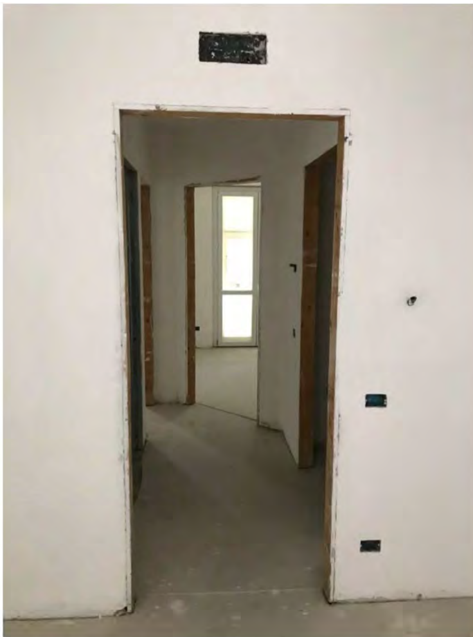
Foto 3: Largo Altiero Spinelli, Licciana Nardi, Località Masero, Terra Rossa Lotto 005 . Disimpegno.
