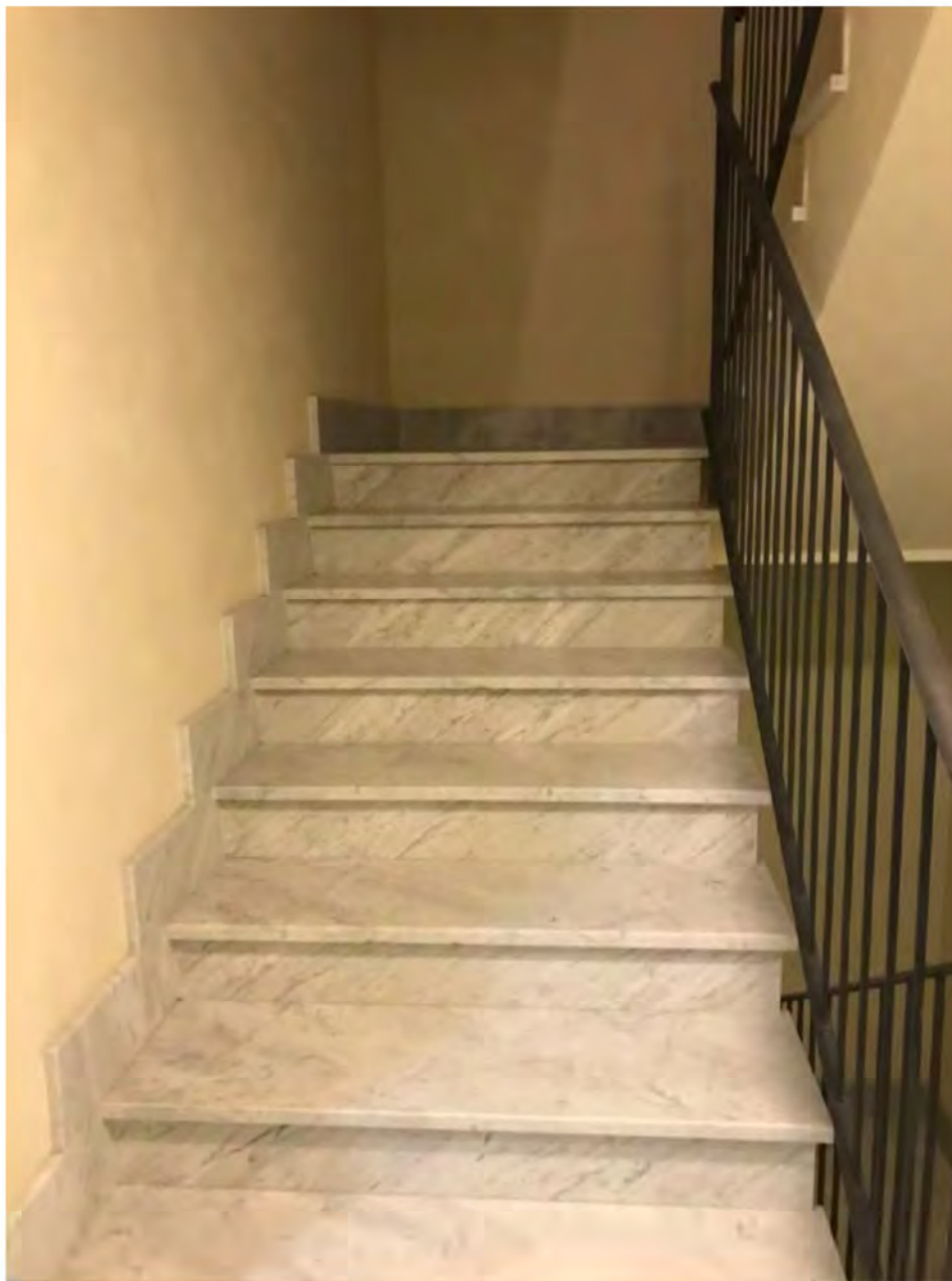
Foto E7: Largo Altiero Spinelli, Licciana Nardi, Località Masero, Terra Rossa Lotto 005 . Vano scala
