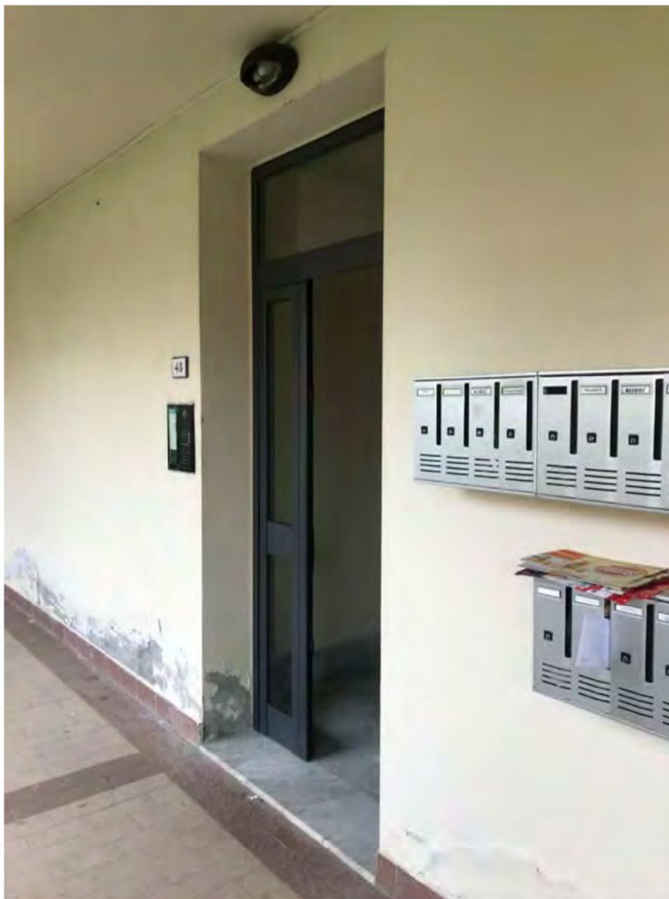
Foto E3: Largo Altiero Spinelli, Licciana Nardi, Località Masero, Terra Rossa Lotto 006 . Vano Scala Ingresso abitazione.
