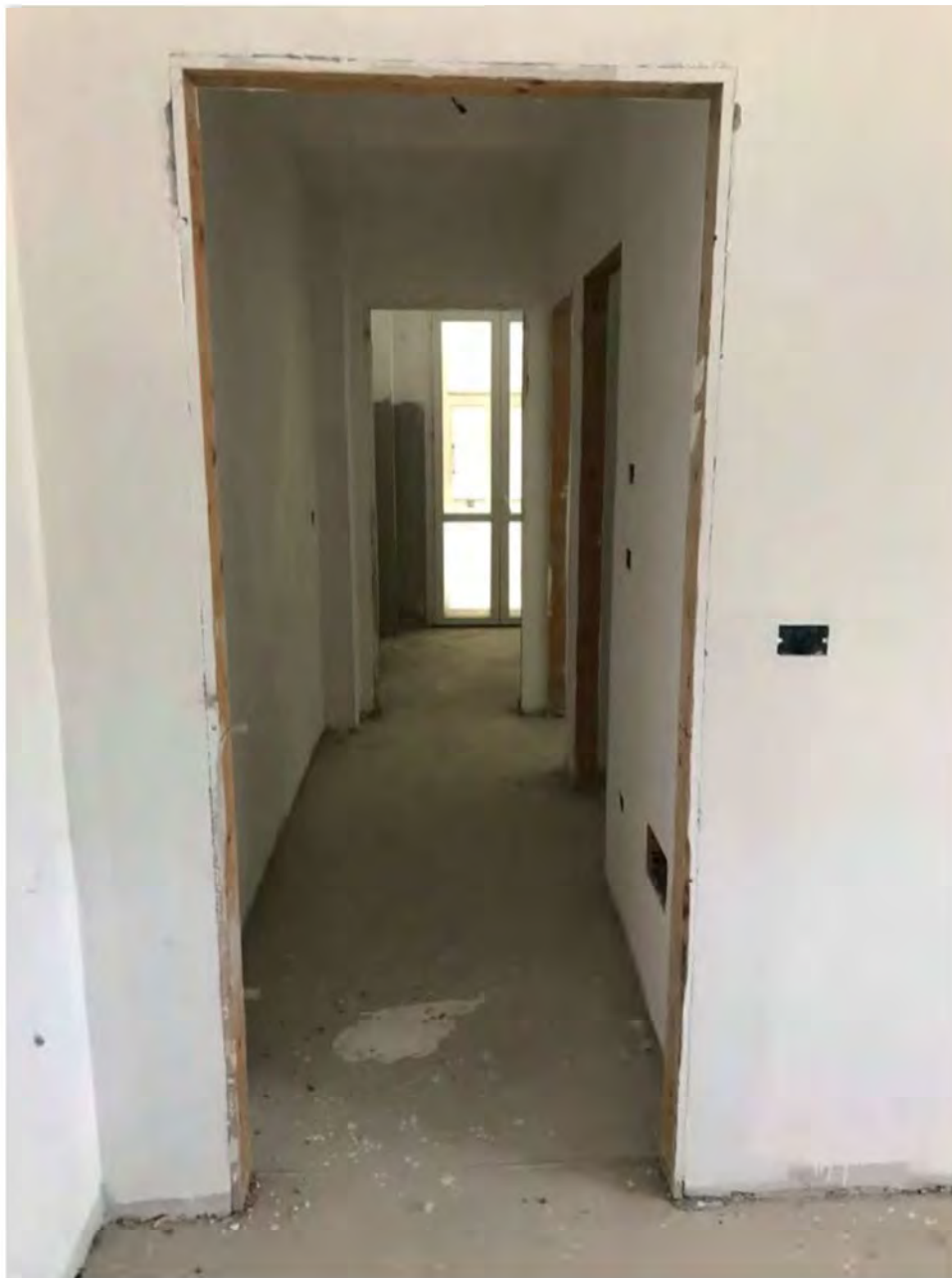
Foto 1: Largo Altiero Spinelli, Licciana Nardi, Località Masero, Terra Rossa Lotto 006 . Disimpegno.
