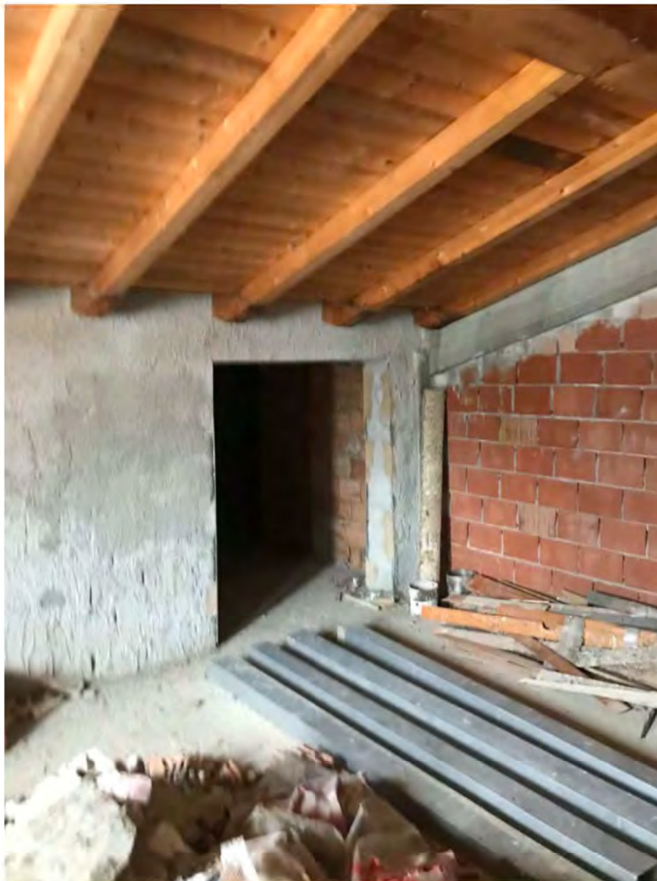
Foto 9: Largo Altiero Spinelli, Licciana Nardi, Località Masero, Terra Rossa Lotto 007 . Sottotetto.
