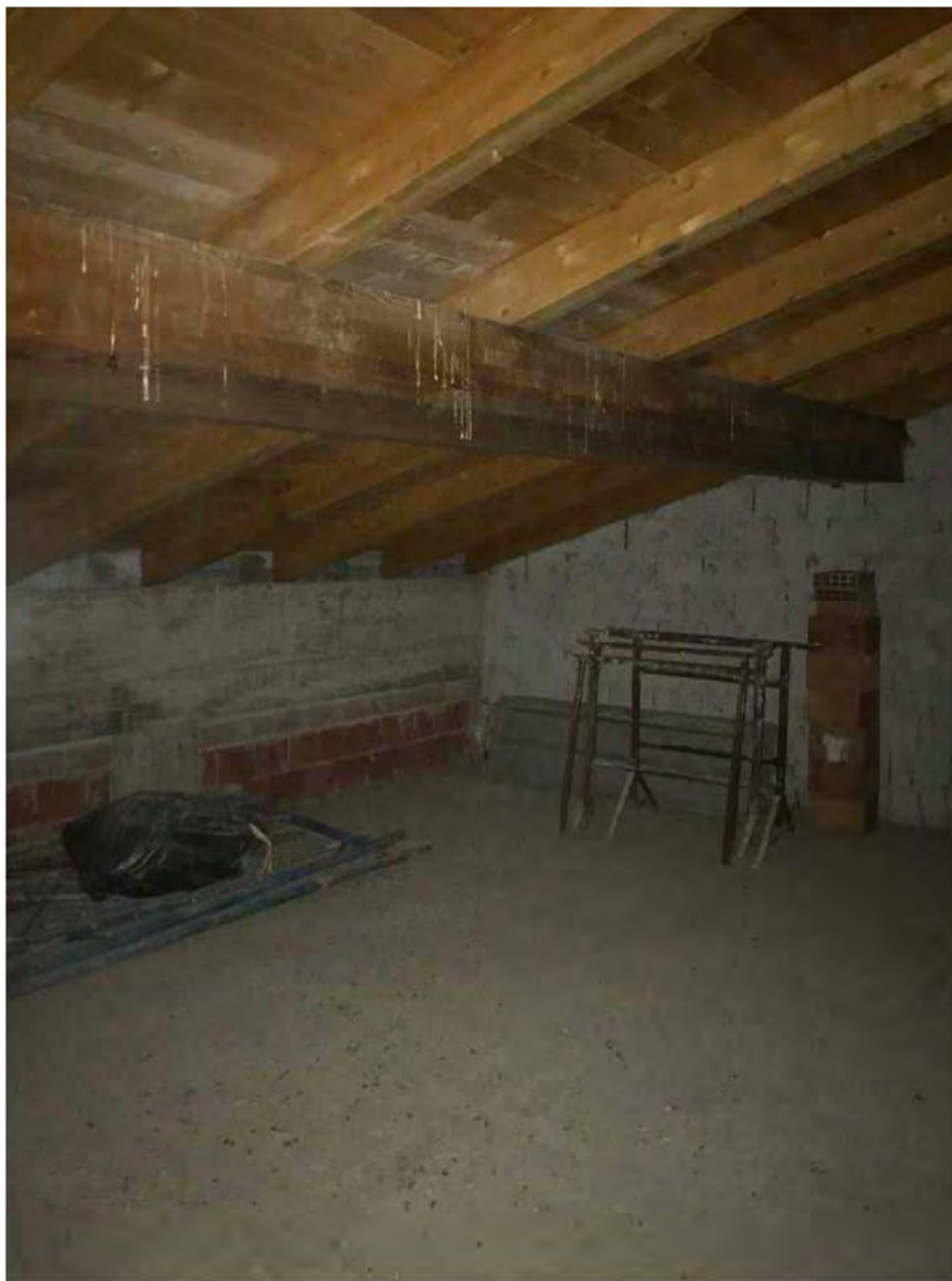
Foto 8: Largo Altiero Spinelli, Licciana Nardi, Località Masero, Terra Rossa Lotto 001 . Sottotetto.
