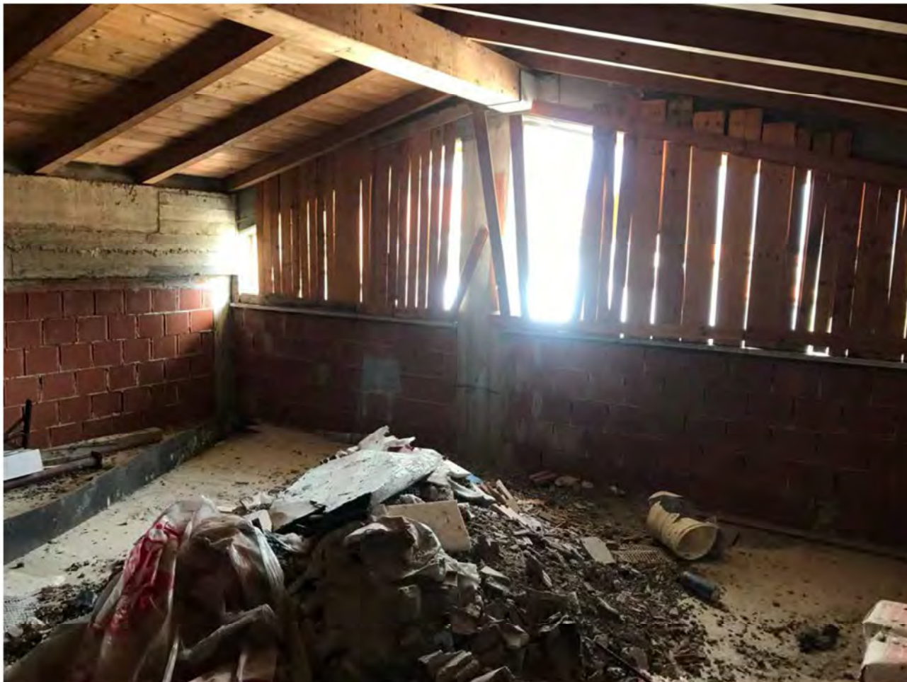
Foto 7: Largo Altiero Spinelli, Licciana Nardi, Località Masero, Terra Rossa Lotto 007 . Sottotetto.
