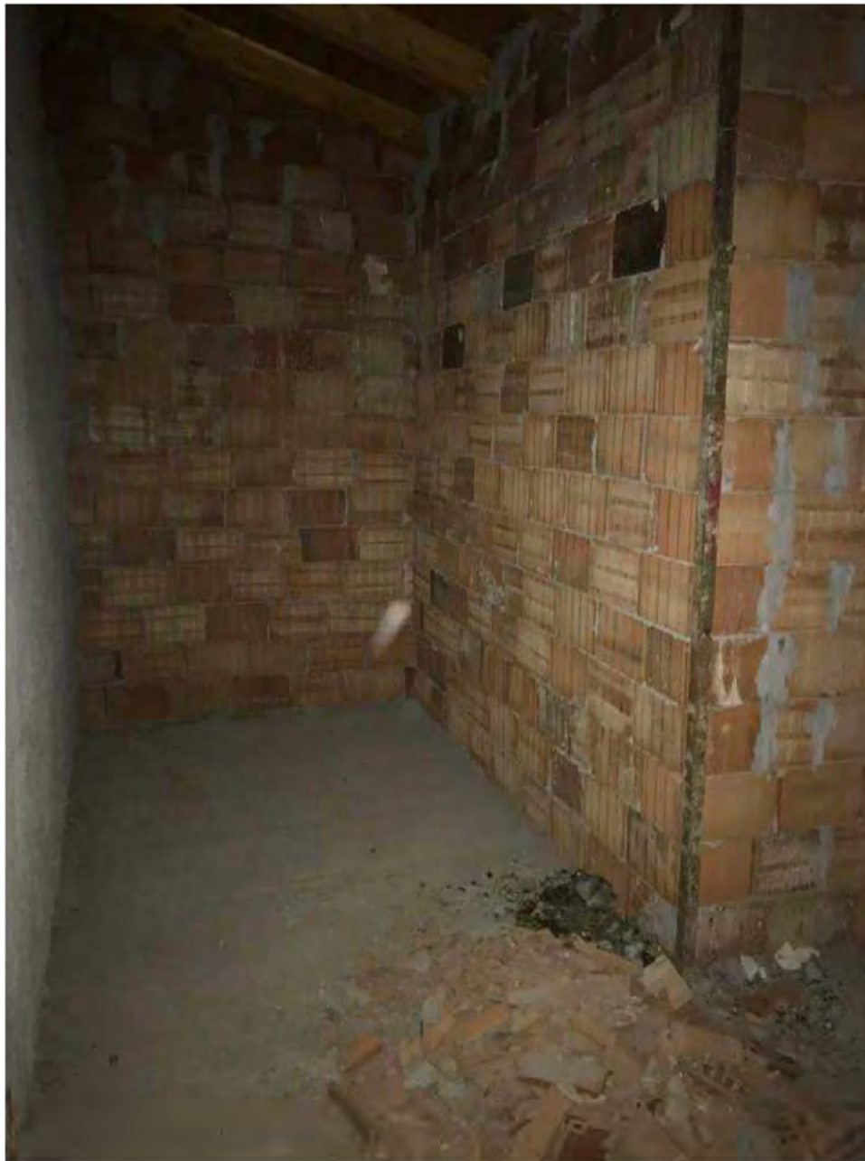
Foto 3: Largo Altiero Spinelli, Licciana Nardi, Località Masero, Terra Rossa Lotto 007 . Sottotetto.
