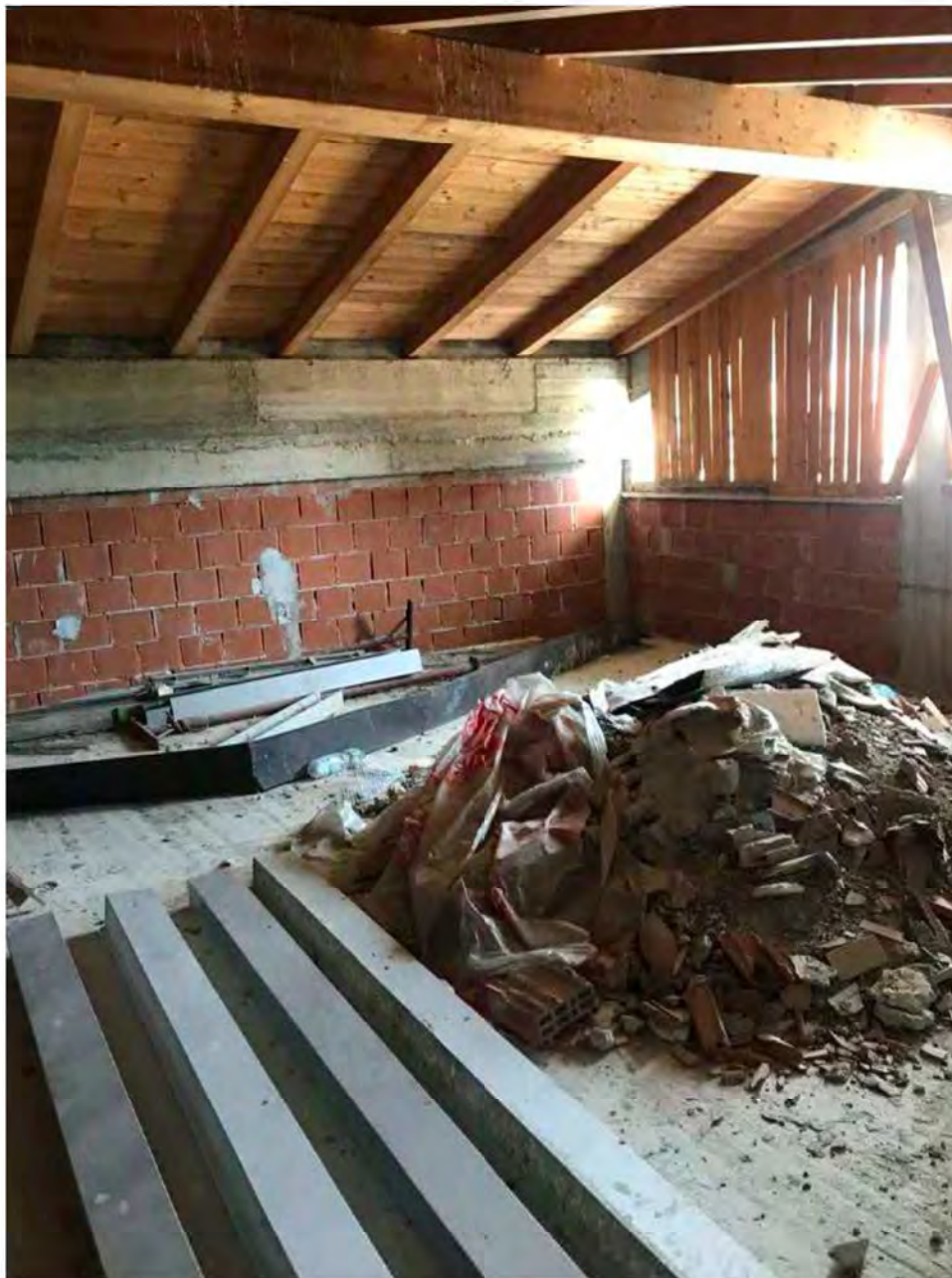
Foto 6: Largo Altiero Spinelli, Licciana Nardi, Località Masero, Terra Rossa Lotto 007 . Sottotetto.
