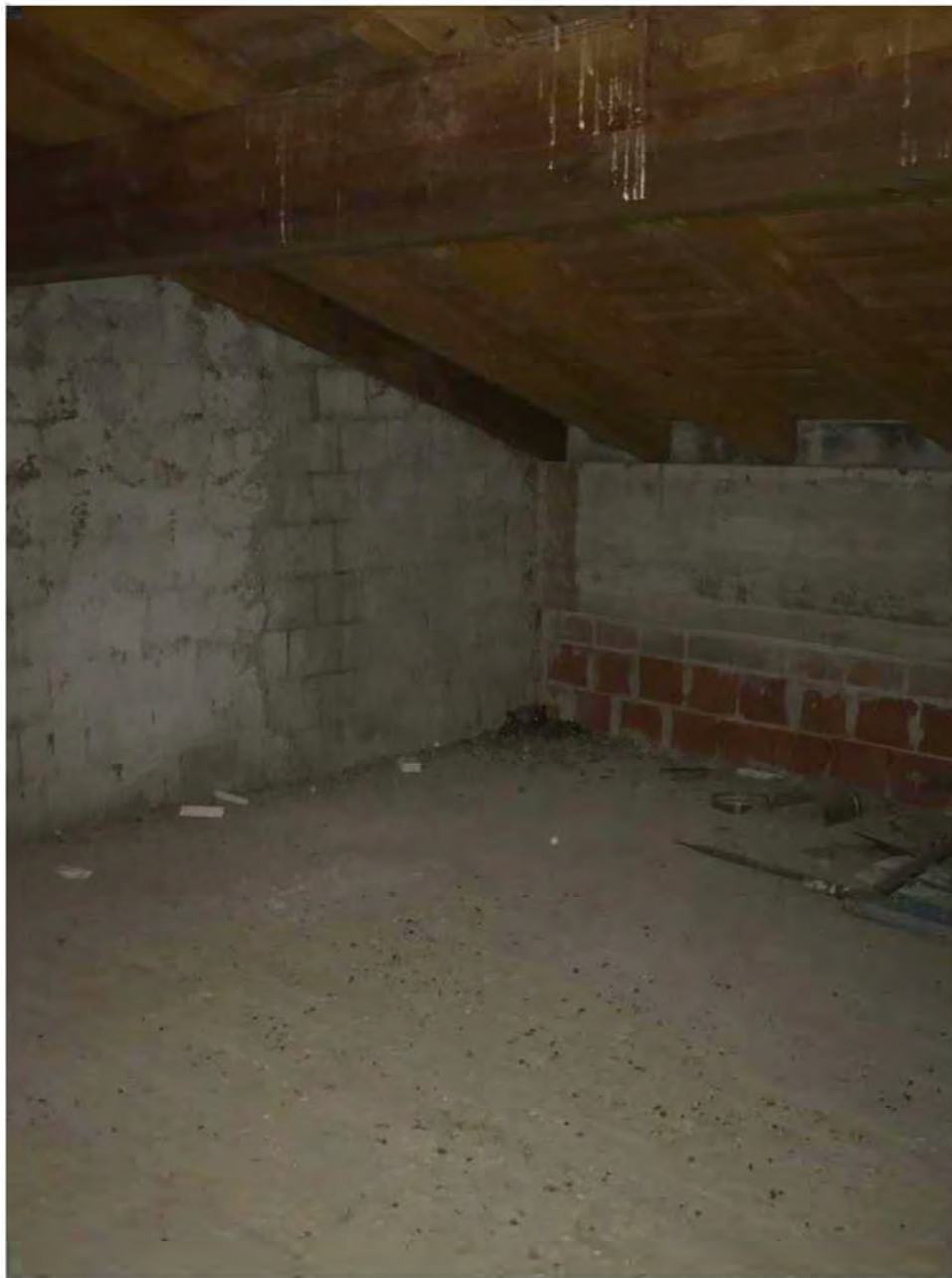
Foto 11: Largo Altiero Spinelli, Licciana Nardi, Località Masero, Terra Rossa Lotto 007 . Sottotetto.
