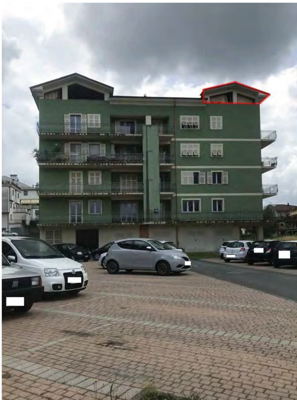
Foto E1: Largo Altiero Spinelli, Licciana Nardi, Località Masero, Terra Rossa Lotto 007 . Esterno.
