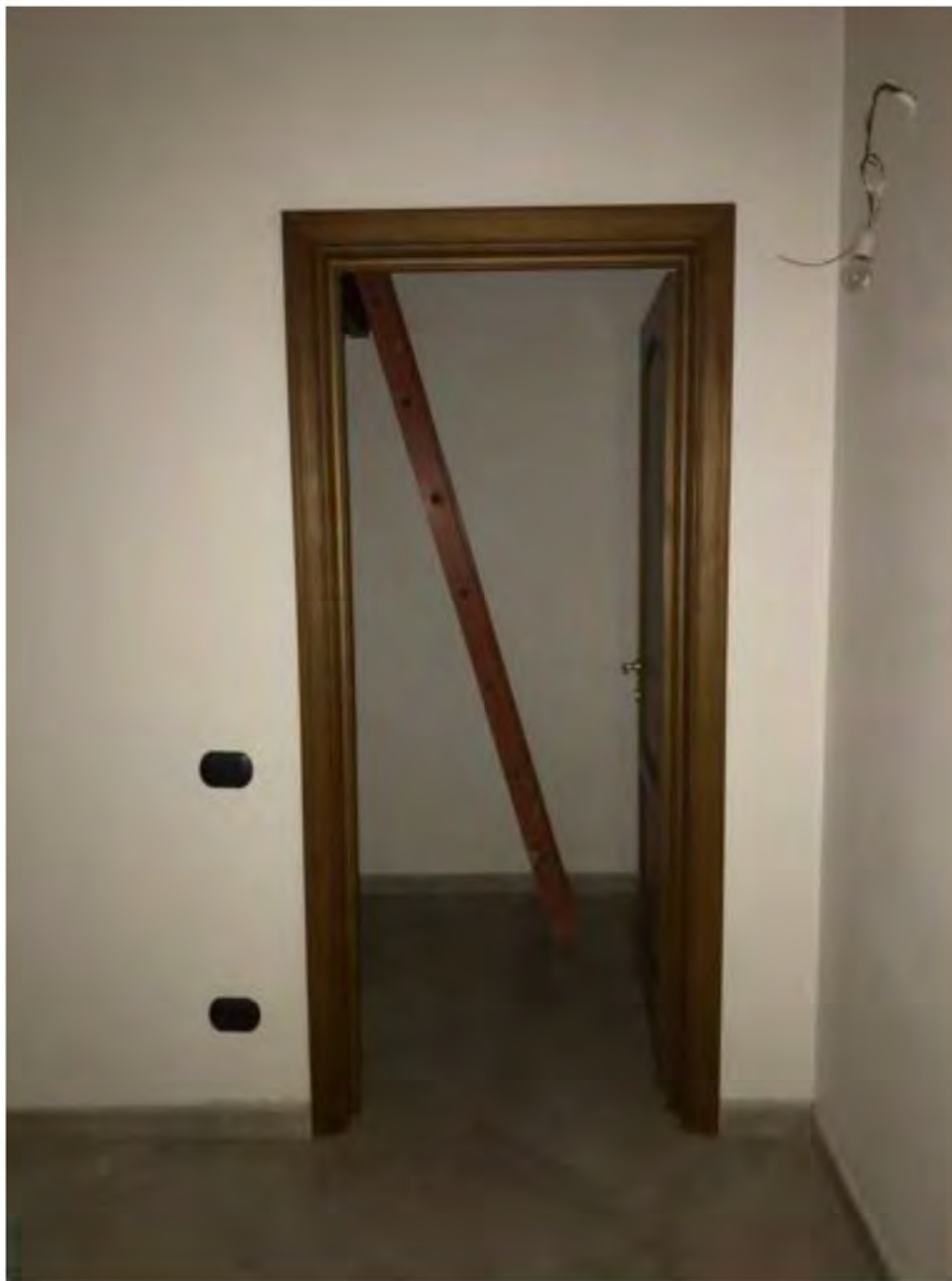
Foto 18: Via dei Pini Licciana Nardi. Lotto 002. Interno Piano Primo Camera 1 accesso soppalco.
