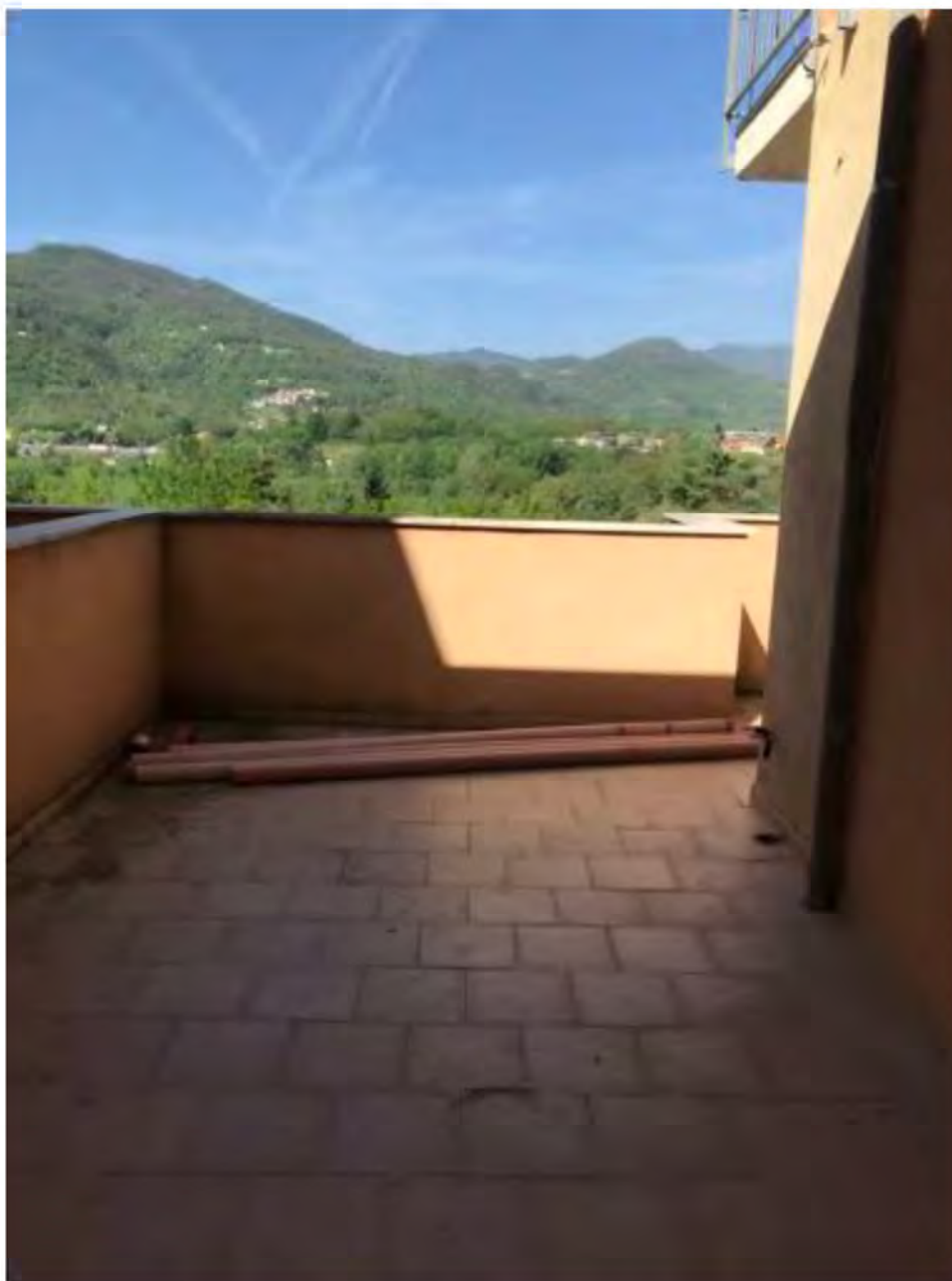
Foto E7: Via dei Pini Licciana Nardi. Lotto 002. Esterno.Terrazza-Portico (3639).
