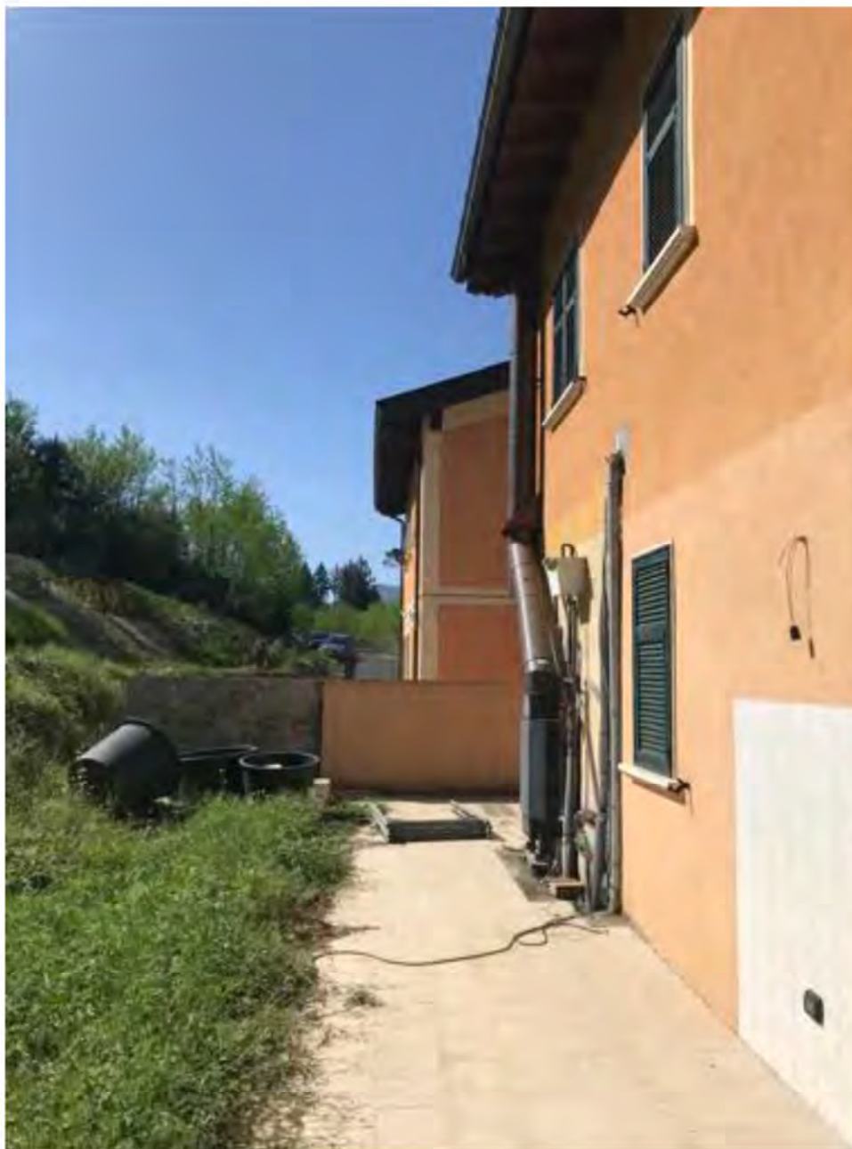
Foto E5: Via dei Pini, Licciana Nardi. Lotto 002. Esterno.
