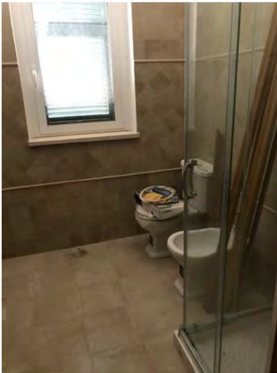
Foto 14: Via dei Pini Licciana Nardi. Lotto 002. Interno Piano Terra. Bagno.
