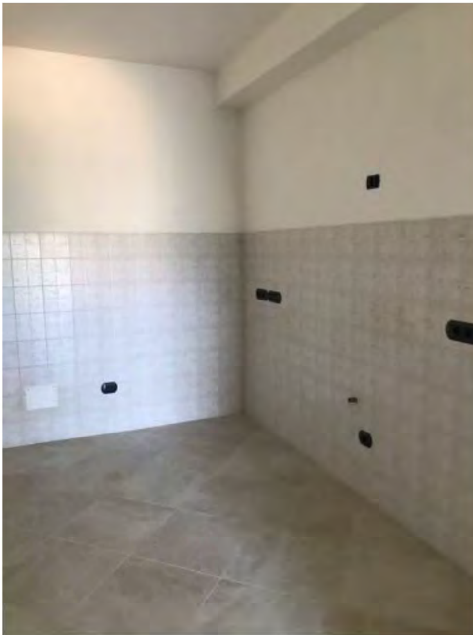
Foto 17: Via dei Pini Licciana Nardi. Lotto 002. Interno Piano Terra Cucina.
