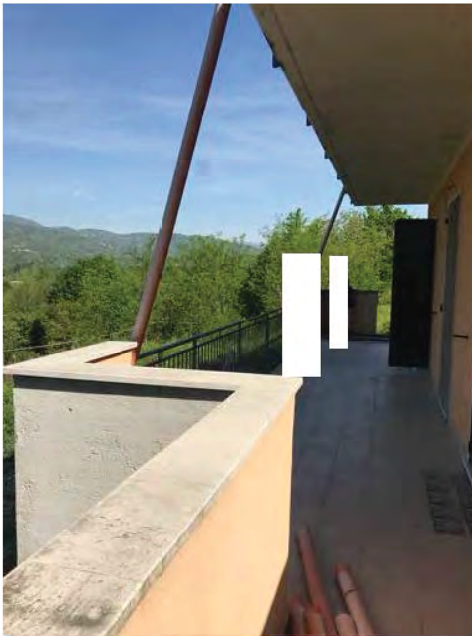
Foto E8: Via dei Pini Licciana Nardi. Lotto 002. Esterno. Terrazza.
