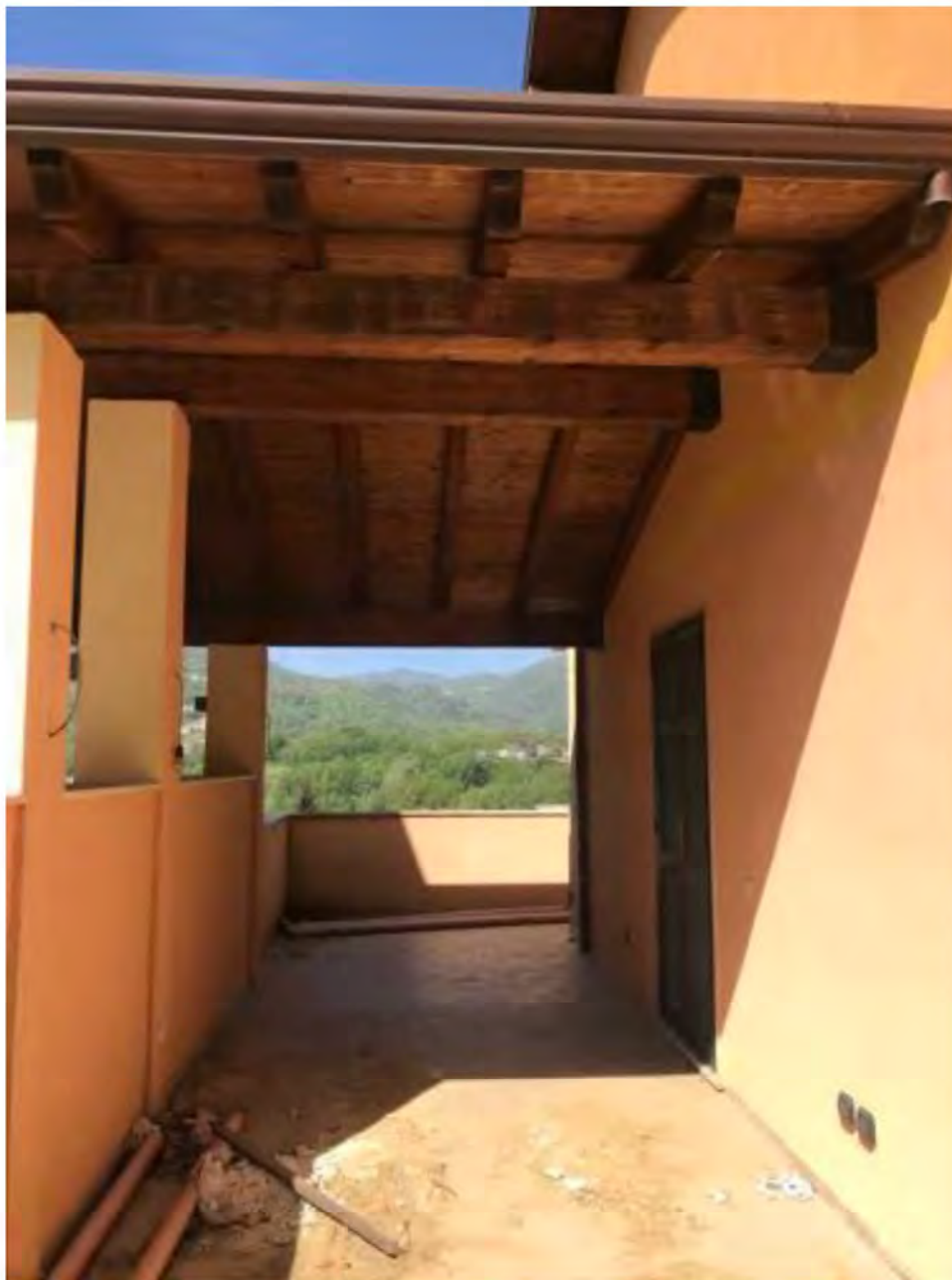
Foto E6: Via dei Pini Licciana Nardi. Lotto 002. Esterno, Portico (3637) .
