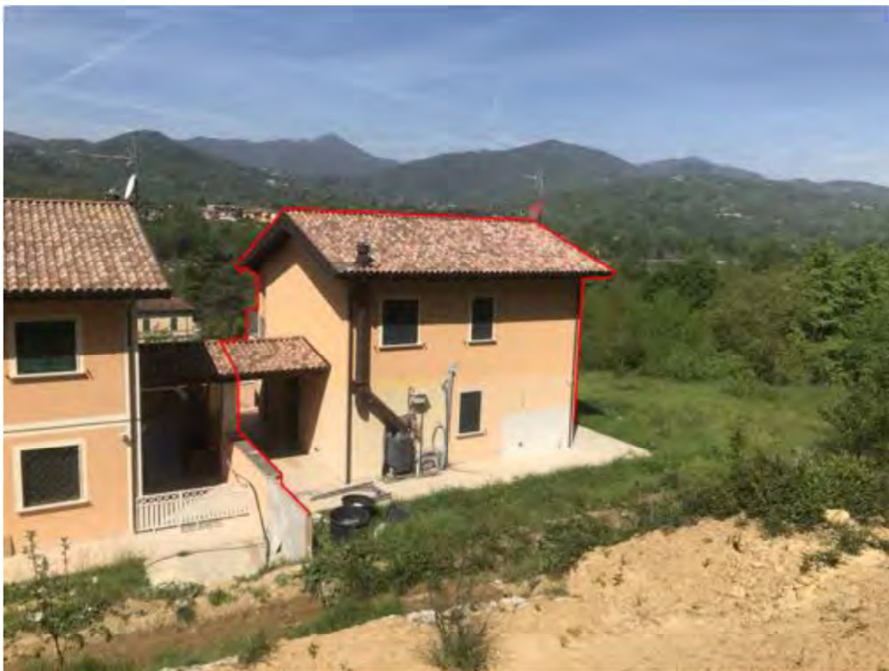
Foto E1: Via dei Pini, Licciana Nardi. Lotto 002. Esterno.
