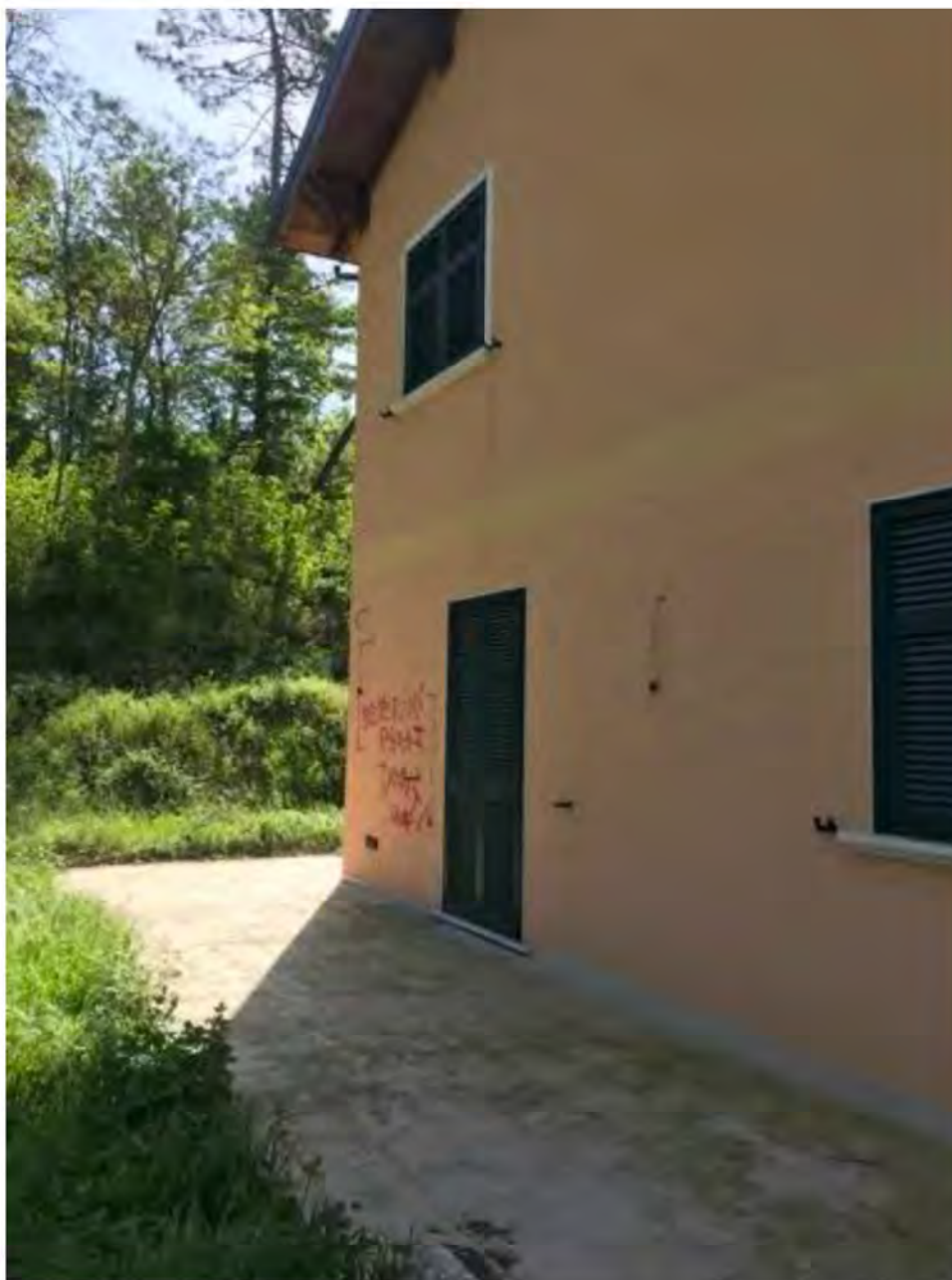
Foto E3: Via dei Pini, Licciana Nardi. Lotto 002. Esterno. Ingresso.
