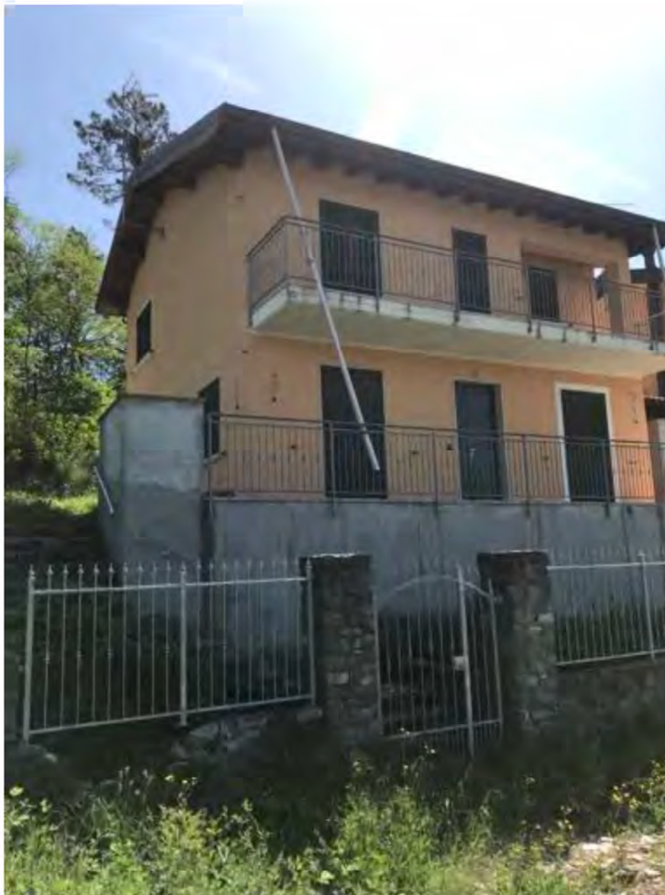
Foto E2: Via dei Pini, Licciana Nardi. Lotto 002. Esterno.
