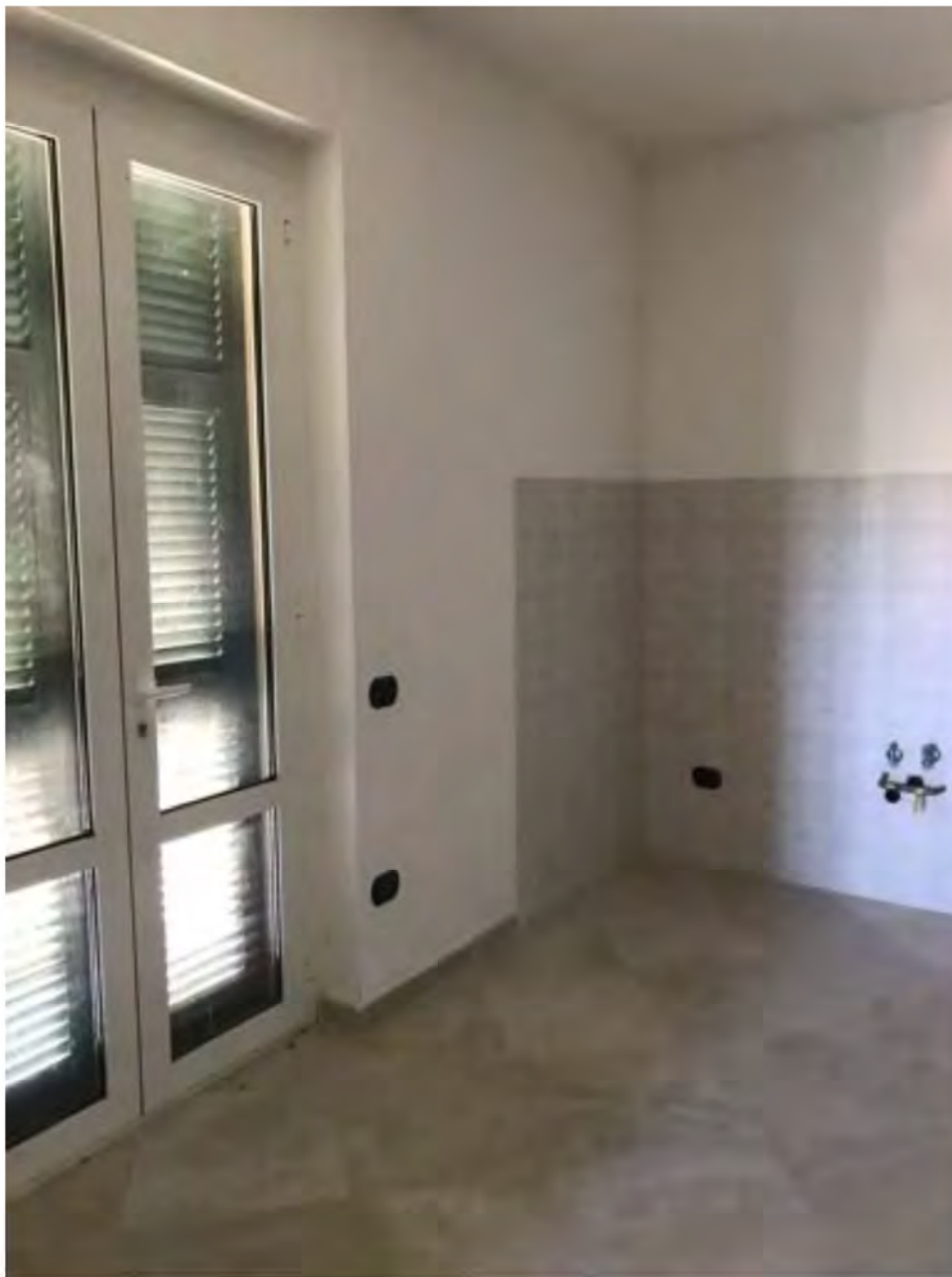
Foto 16: Via dei Pini Licciana Nardi. Lotto 002. Interno Piano Terra Cucina.
