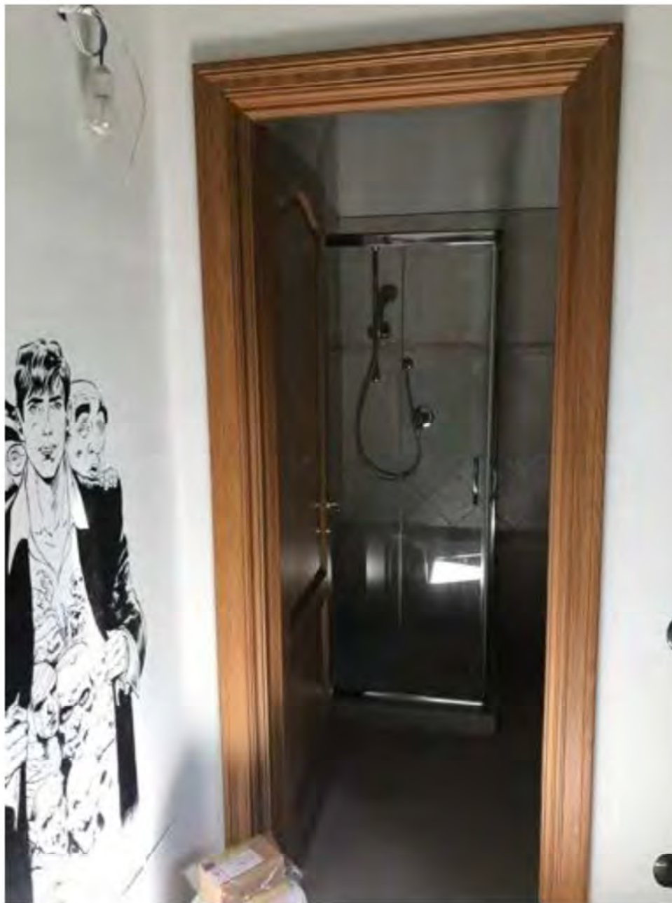
Foto 20: Via dei Pini Licciana Nardi. Lotto 002. Interno Piano Primo Camera 2.
