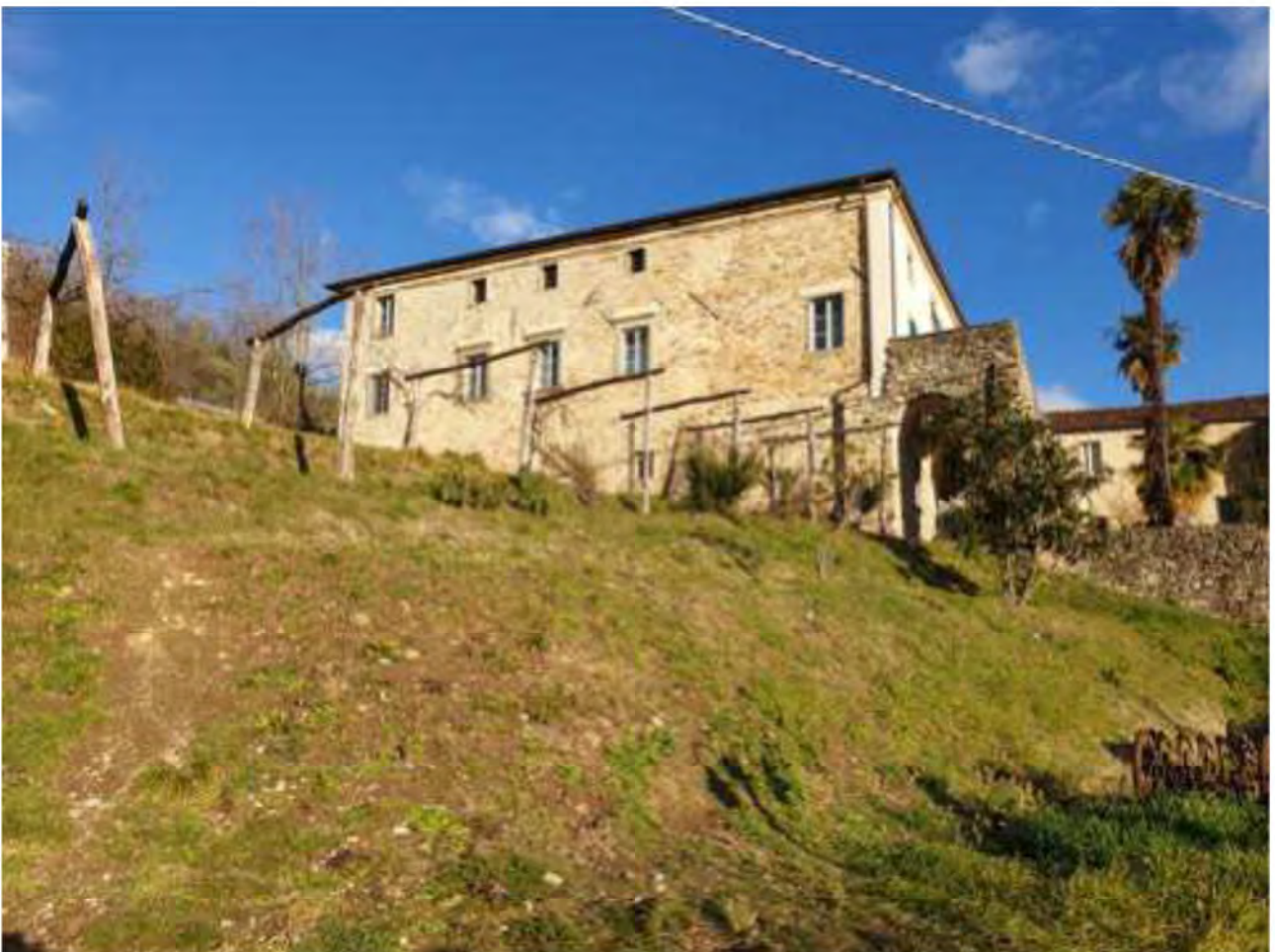
FOTO 138. Vista esterna della residenza
