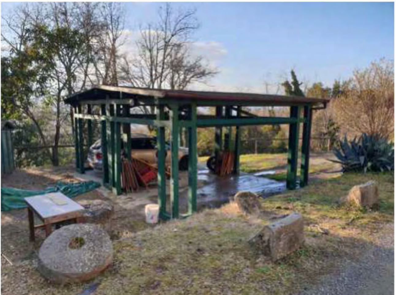
FOTO 142. Tettoia per ricovero veicoli abusiva
