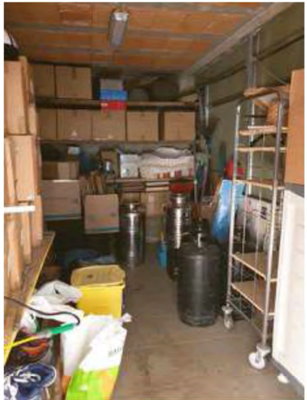
FOTO 153. Porzione di portico esterno chiuso con parete in cartongesso
