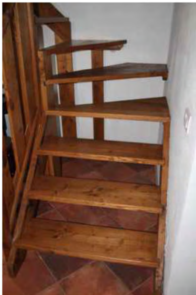
FOTO 50. Scale accesso a soppalco camera 2
