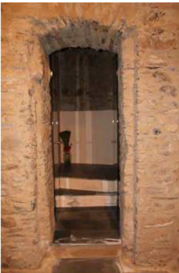
FOTO 124. Accesso a W.C. piano terra
