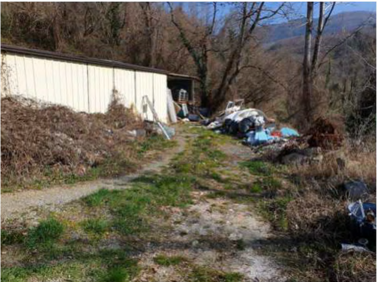
FOTO 213. Baracche da smantellare su mapp. 620
