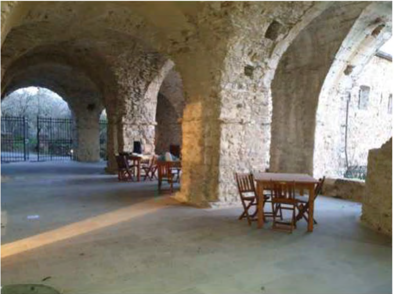
FOTO 143. Loggiato di ingresso alla residenza
