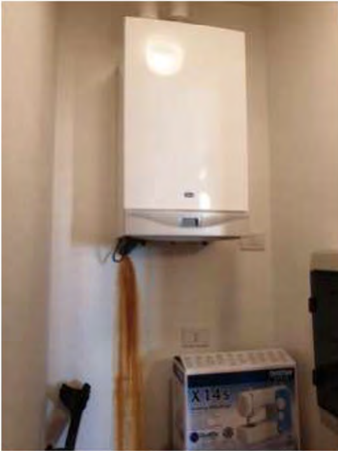
FOTO 160. Antibagno bagno B
