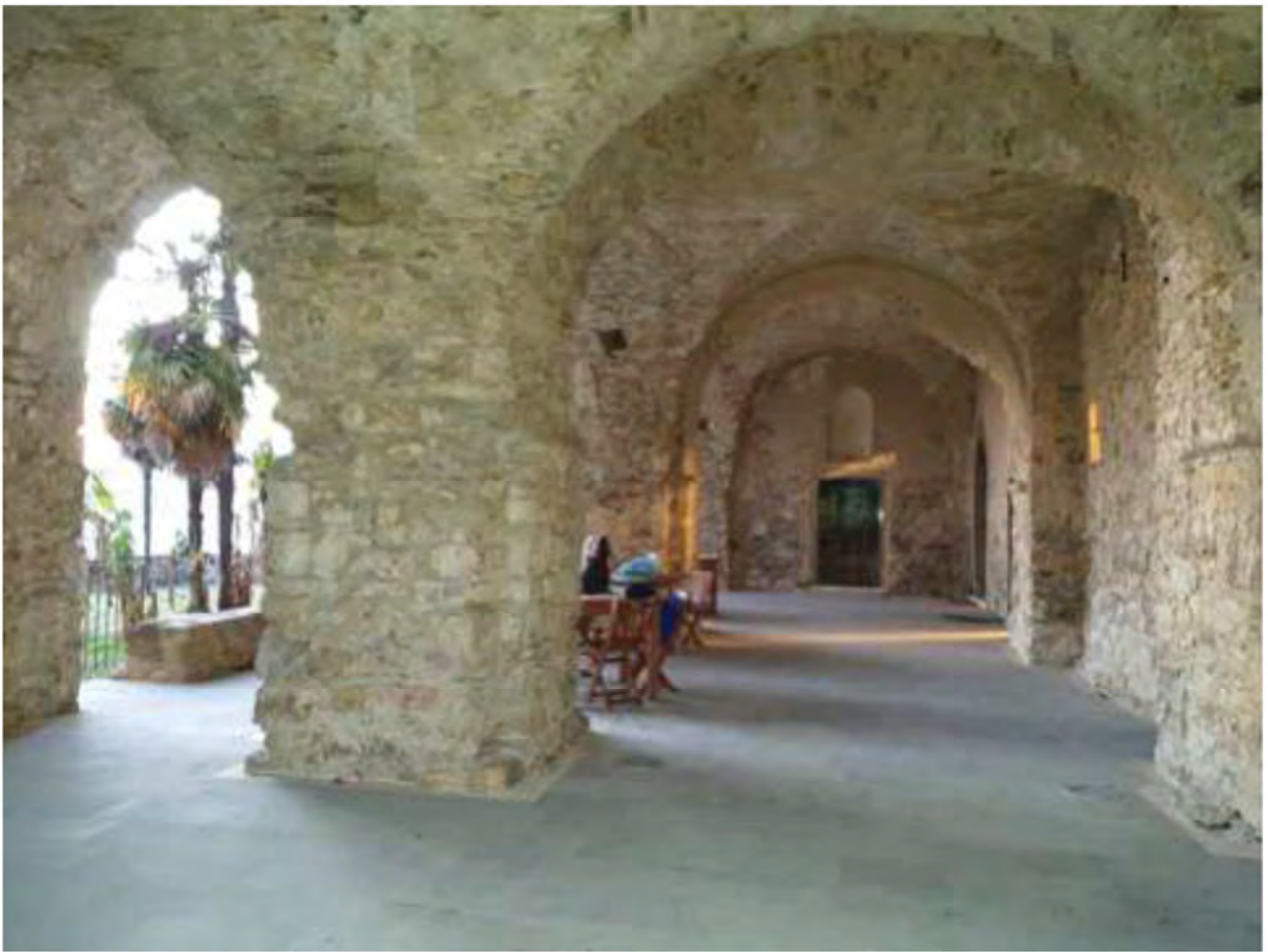
FOTO 146. Loggiato di ingresso alla residenza
