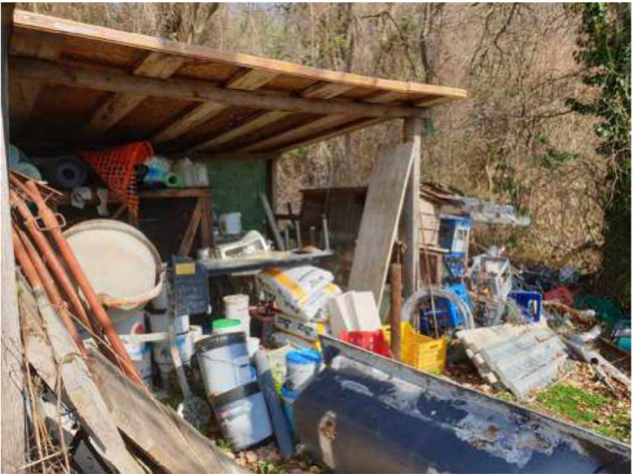
FOTO 212. Baracche da smantellare su mapp. 620
