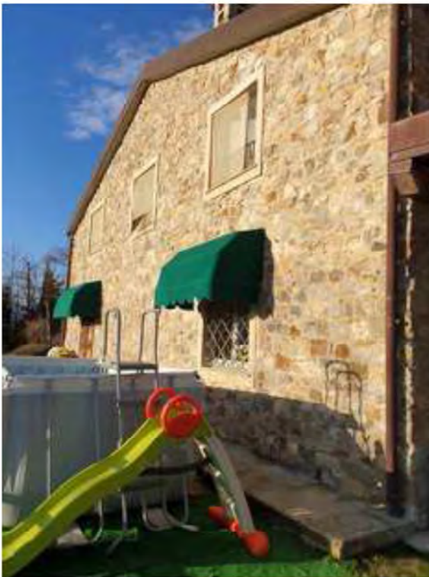
FOTO 149. Vista esterna ex frantoio
