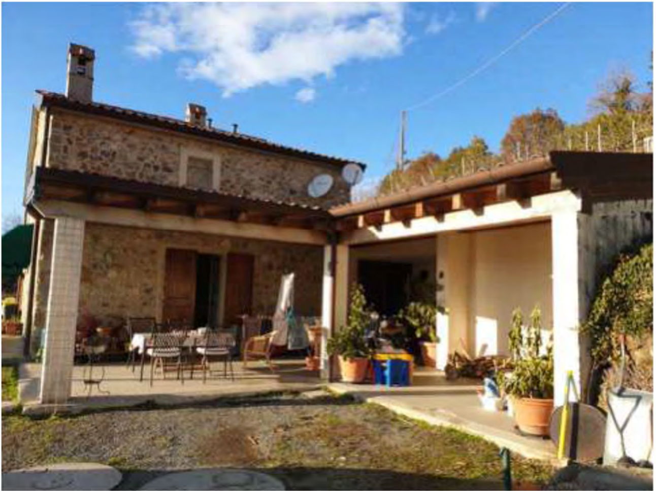
FOTO 151. Vista esterna ex frantoio
