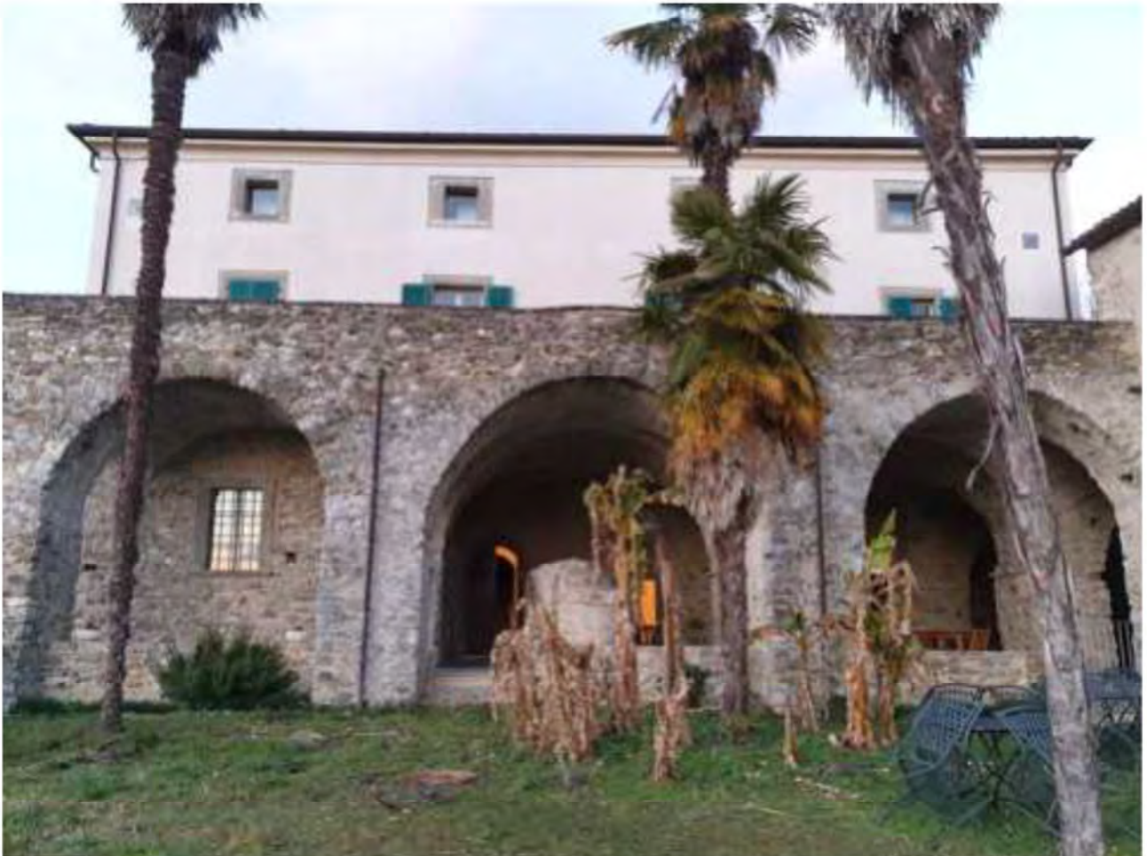
FOTO 139. Vista esterna della residenza
