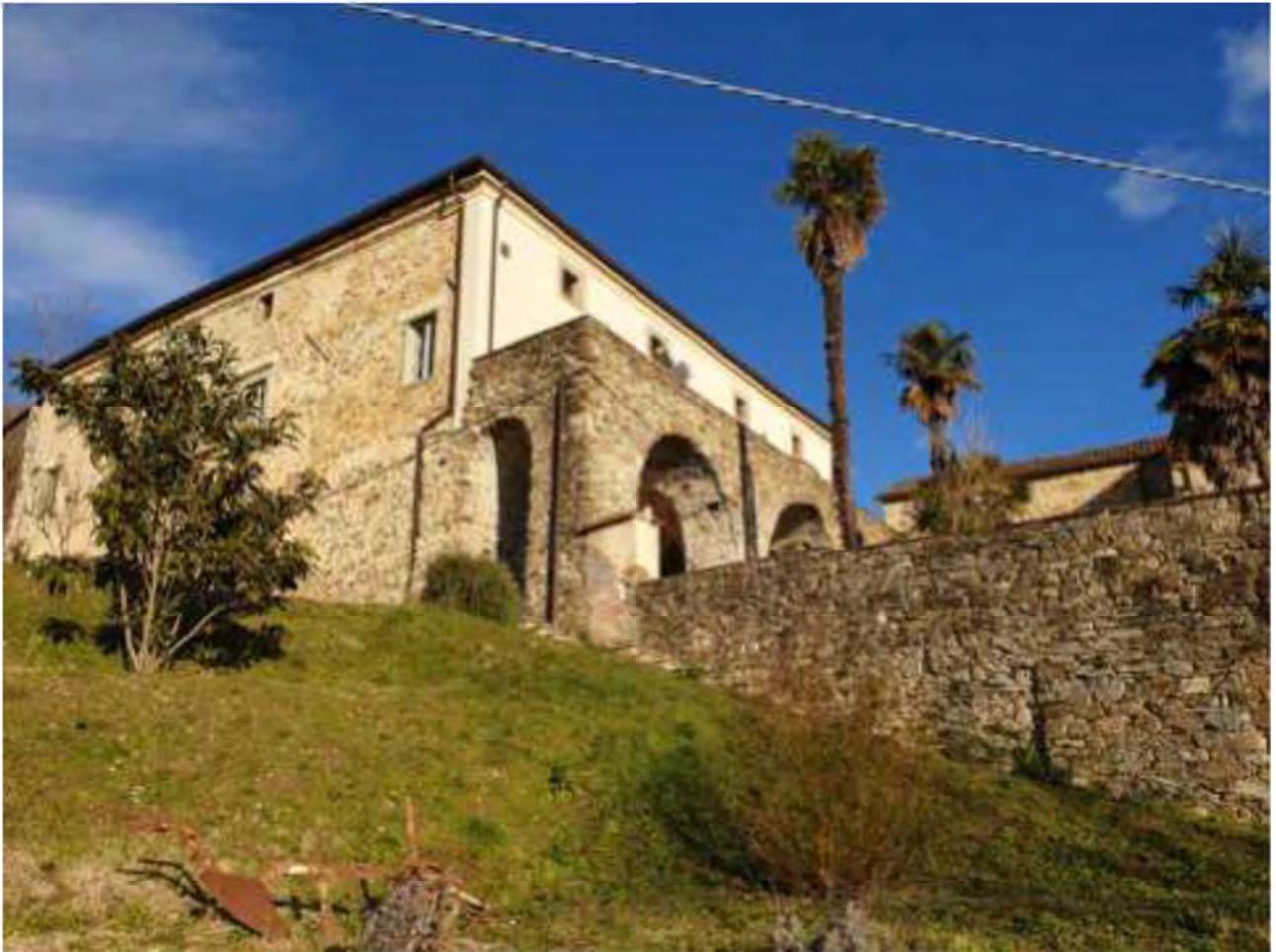
FOTO 141. Vista esterna della proprietà
