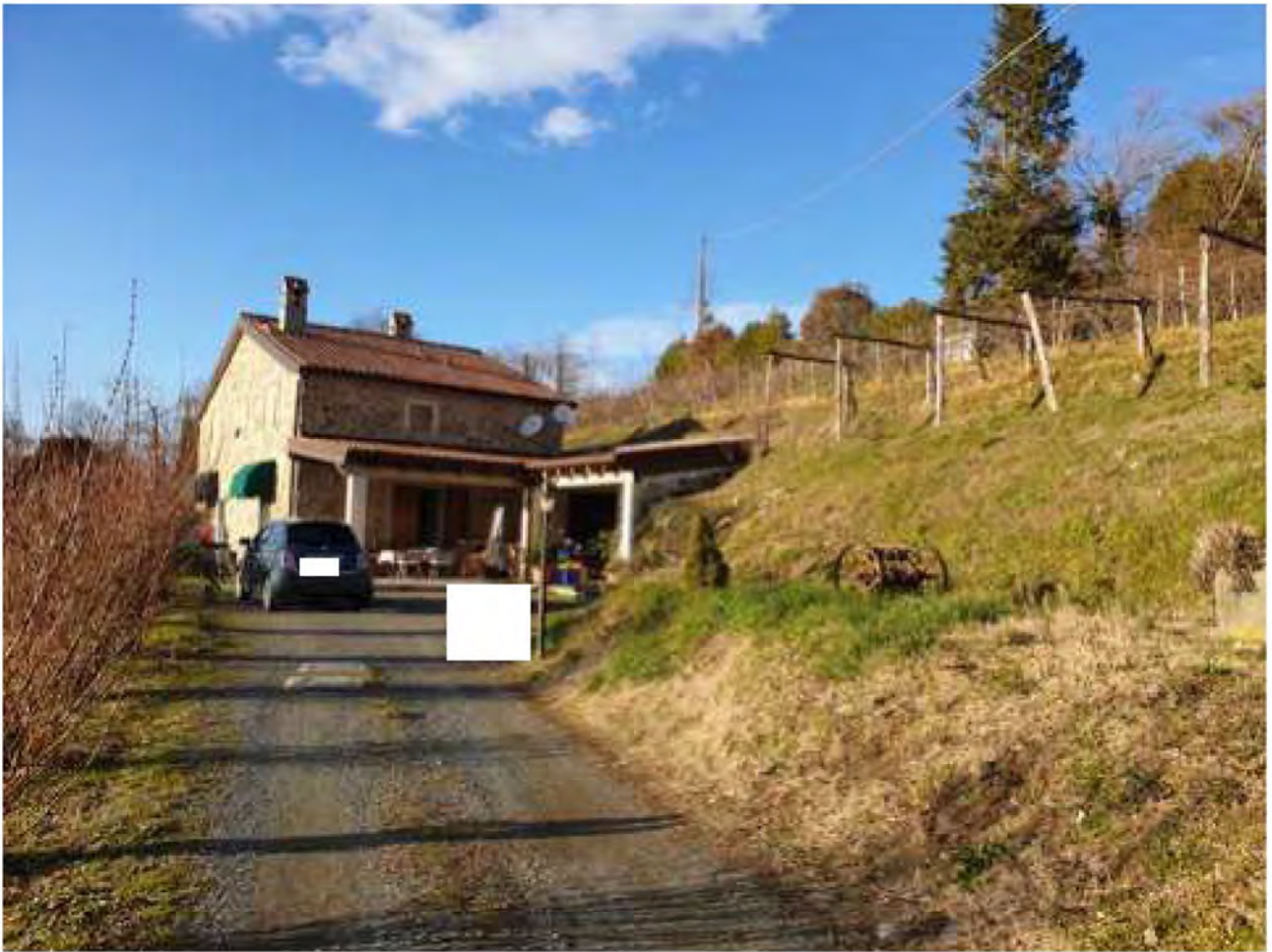
FOTO 148. Vista esterna ex frantoio
