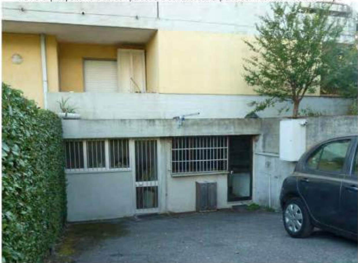
FOTO 3: prospetto nord est con particolare dell'accesso al piano seminterrato mediante rampa
