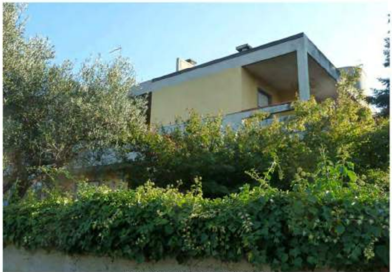
FOTO 2: prospetto nord est fabbricato
