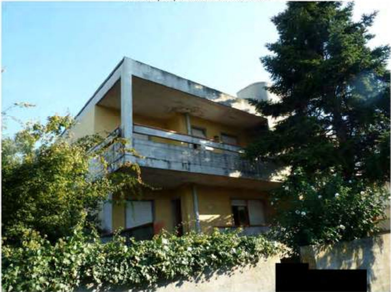
FOTO 1: prospetto sud ovest fabbricato
