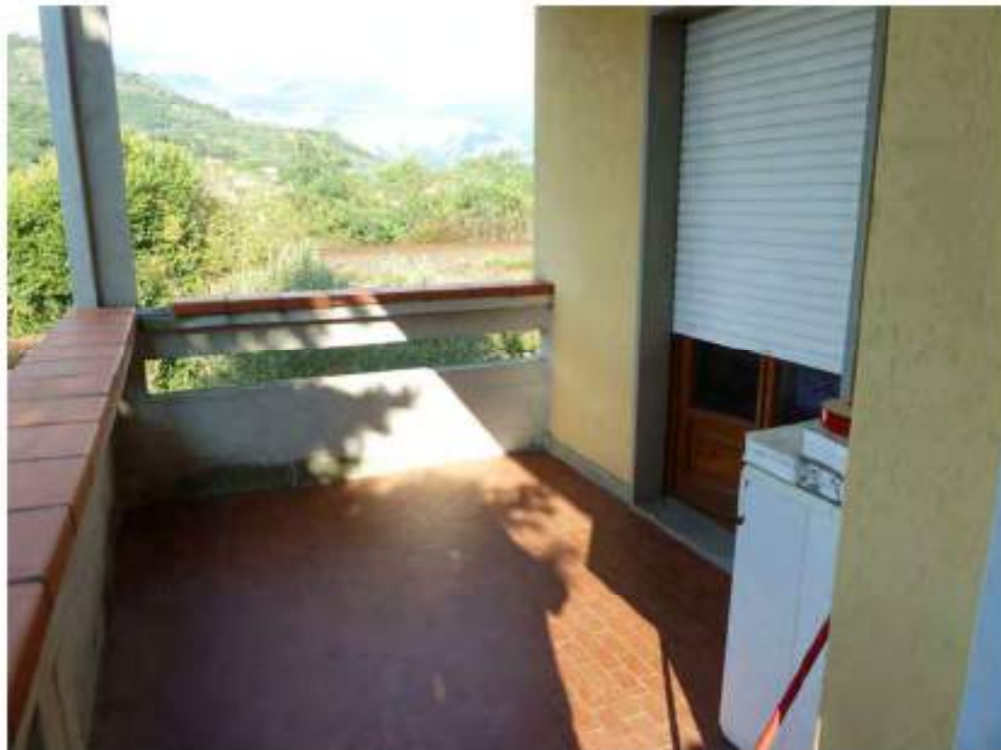
FOTO 26: piano primo – terrazzo
