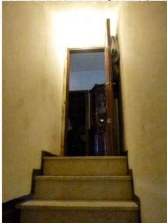
FOTO 9: seminterrato – scala interna collegamento con piano rialzato
