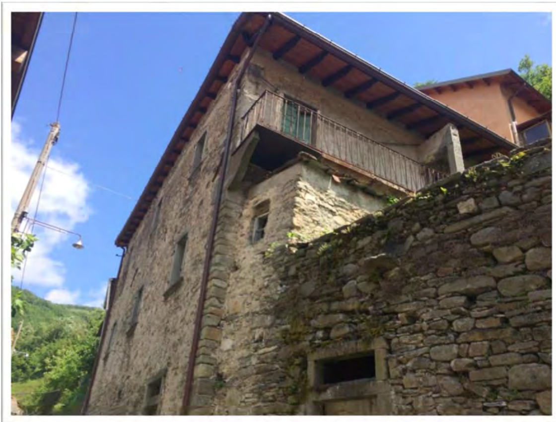
Foto 2 –Fabbricato mappale 310 e corte mappale 311 (corpo A)
