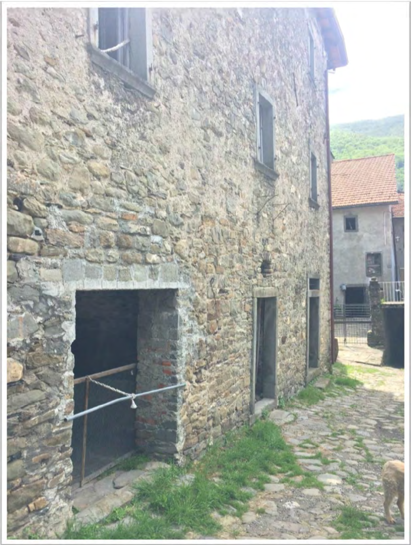
Foto 1bis –Fabbricato mappale 310 (corpo A) – prospetto lato strada di paese
