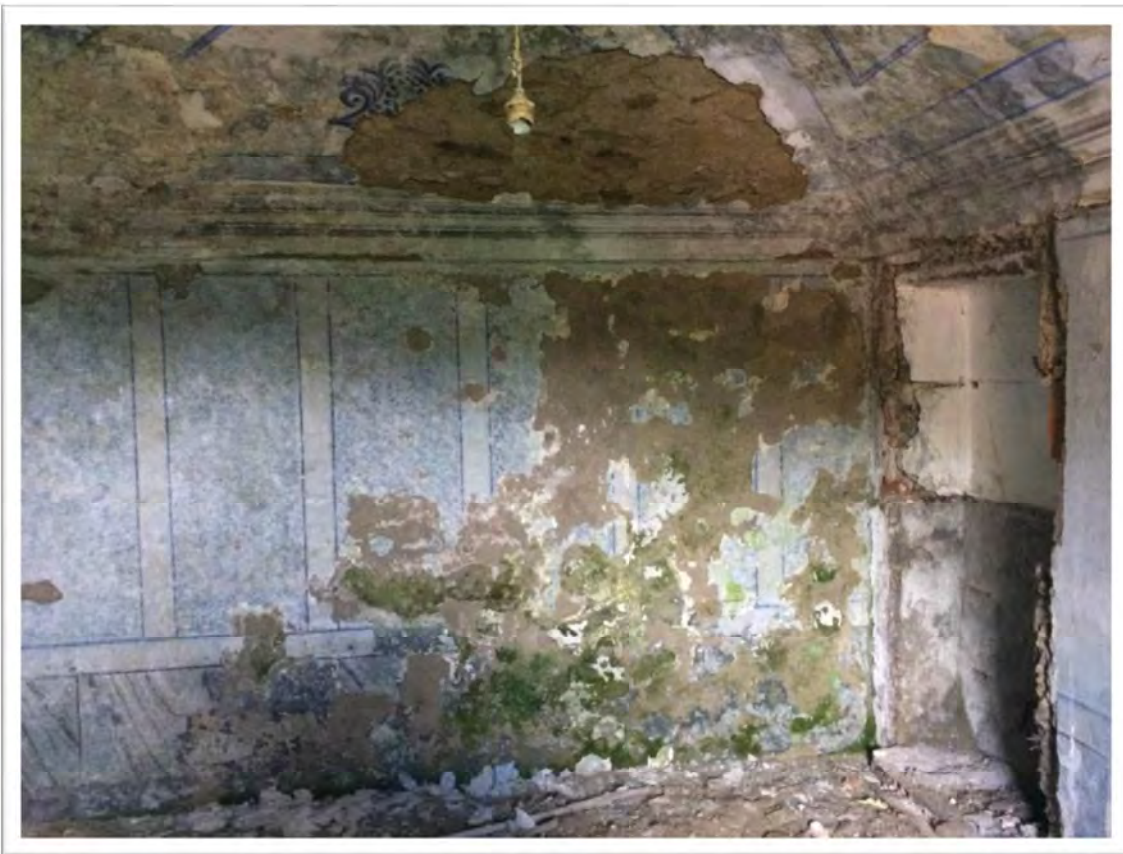
Foto 13—locali piano primo (corpo A)
