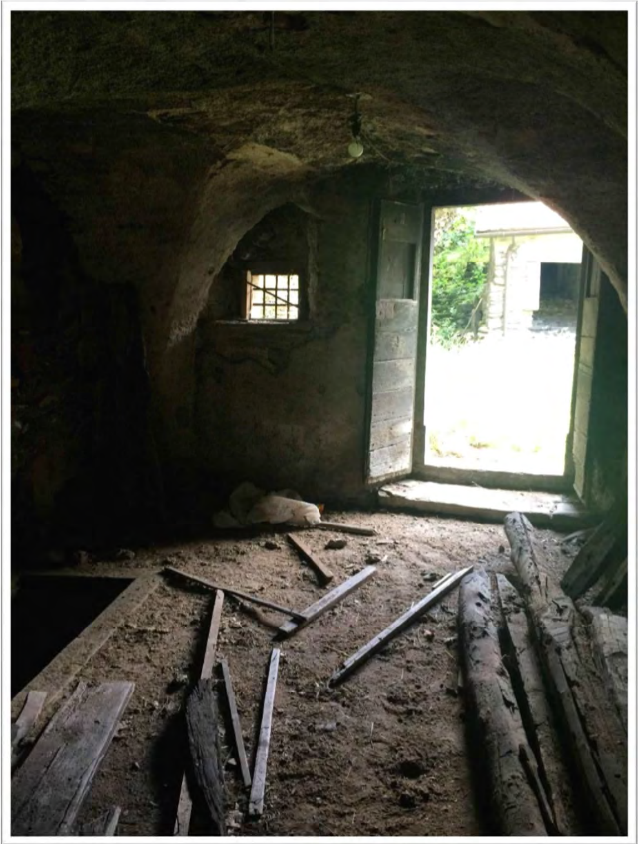
Foto 10—locali piano primo (corpo A)
