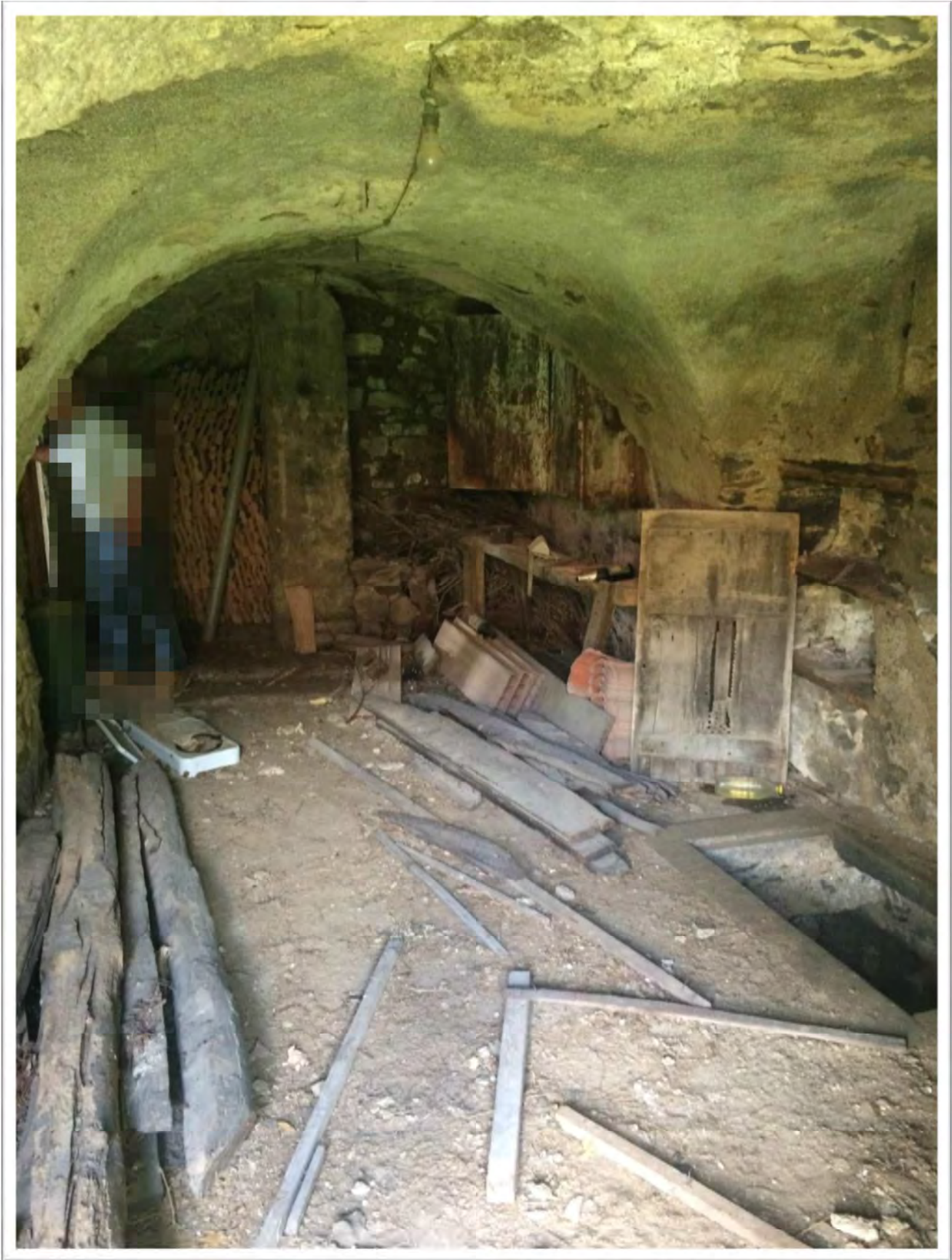
Foto 9 –locali piano primo (corpo A)
