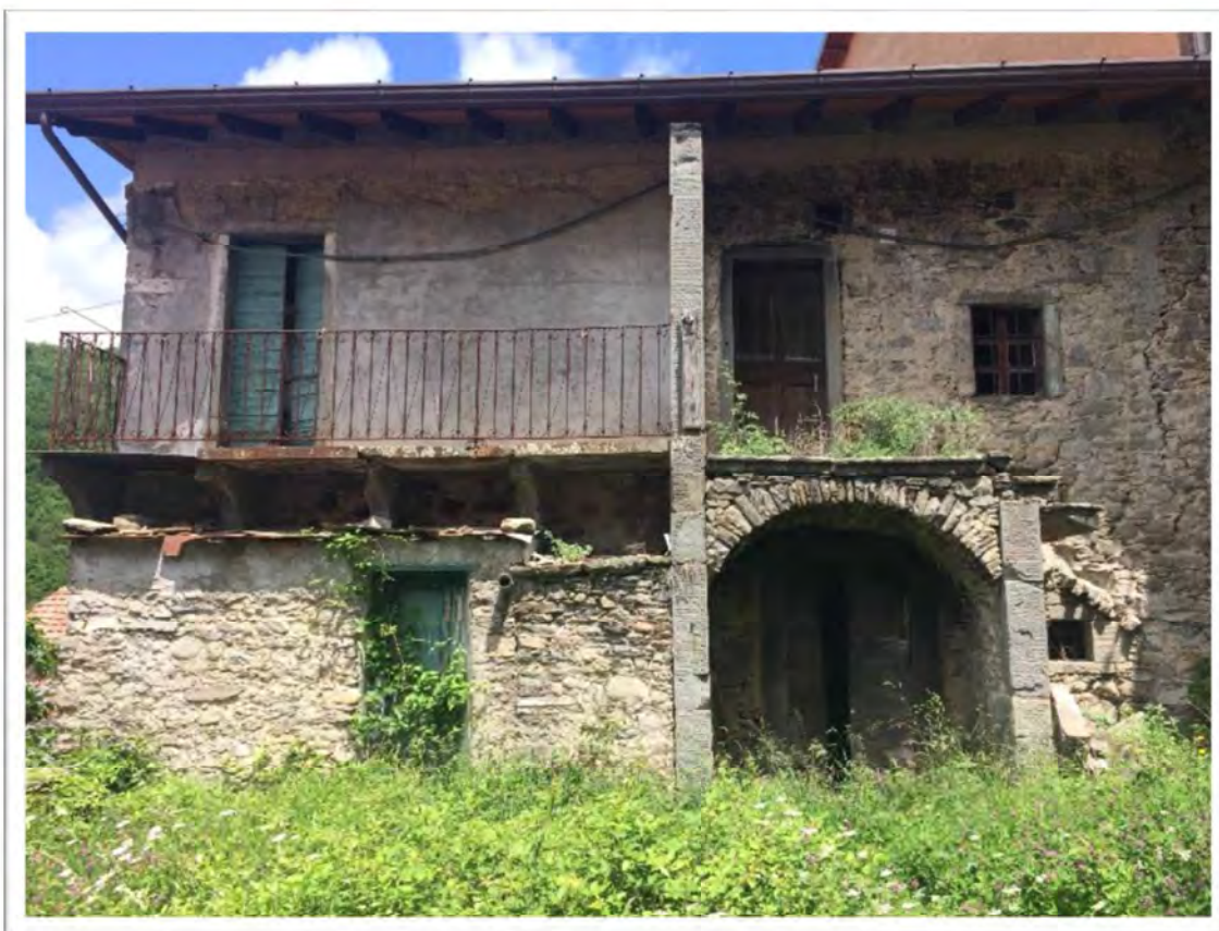
Foto 3 –Fabbricato mappale 310 e corte mappale 311 (corpo A)
