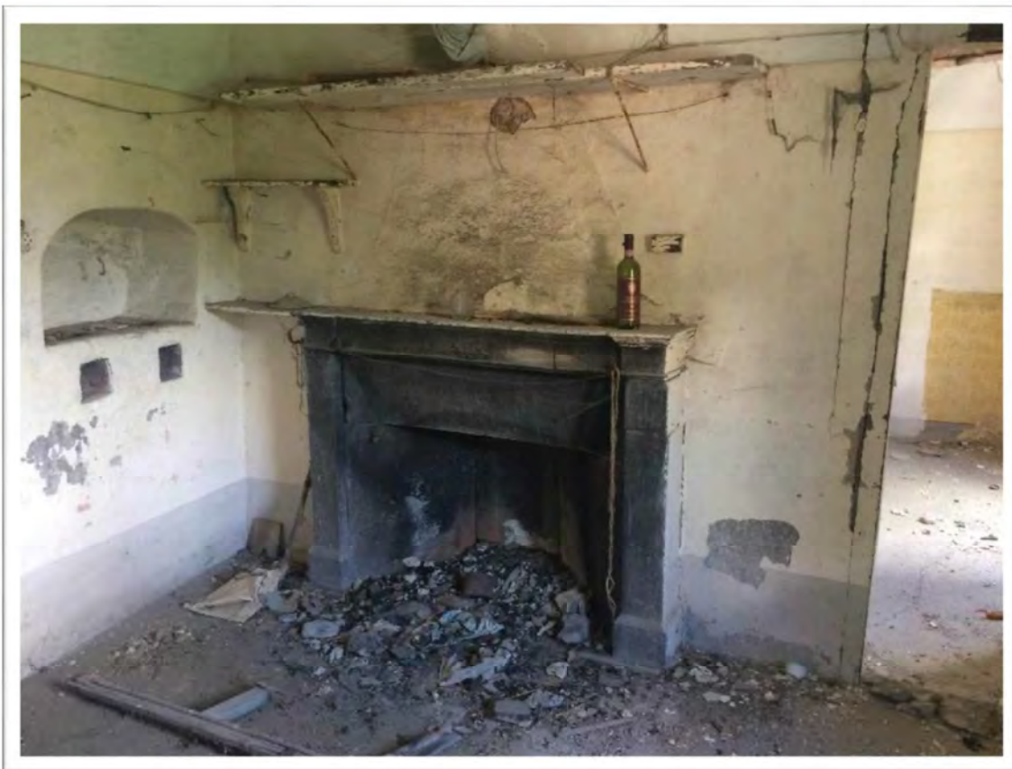
Foto 12—locali piano primo (corpo A)
