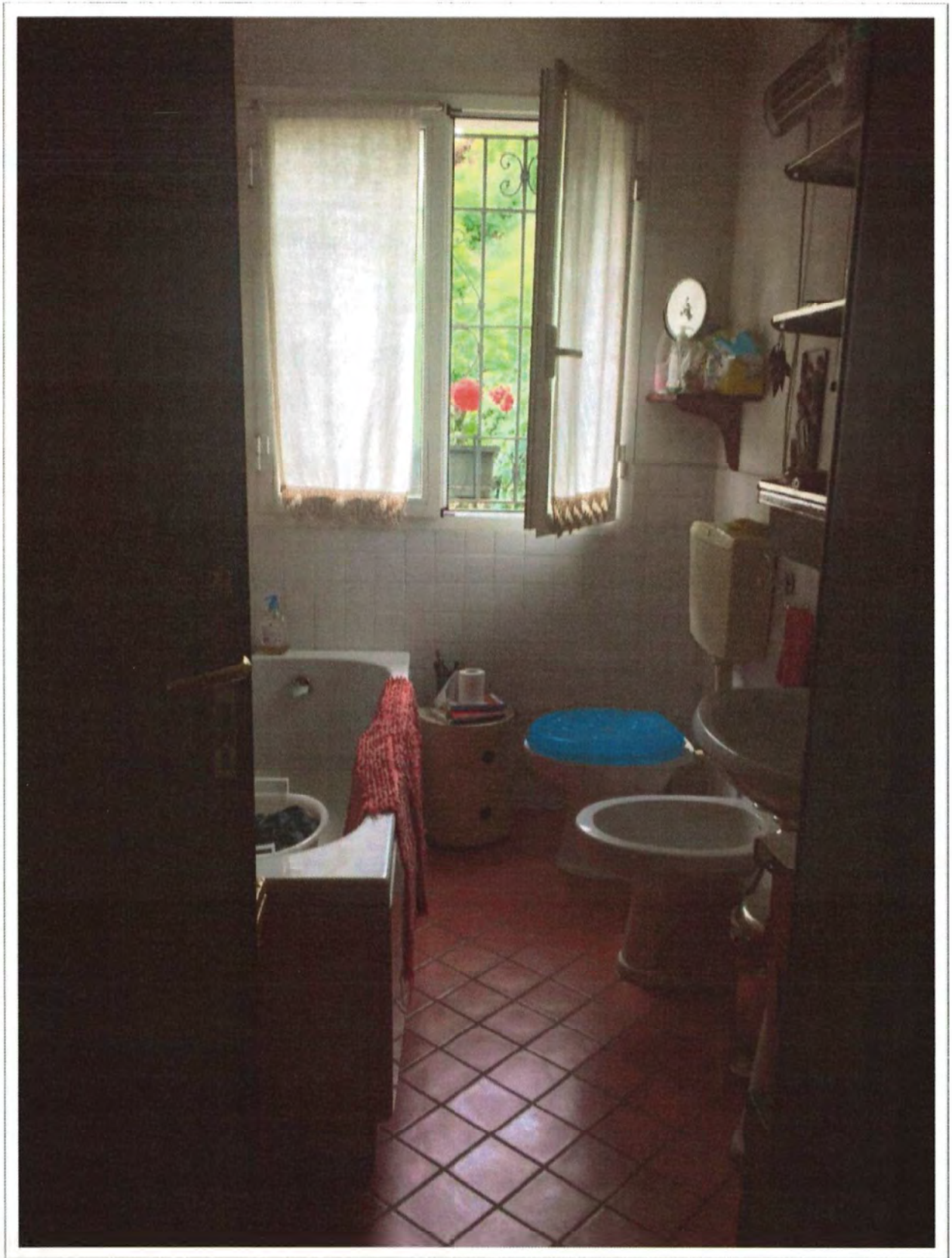
Foto 7 – servizio igienico – Fabbricato mappale 820 (corpo D)
