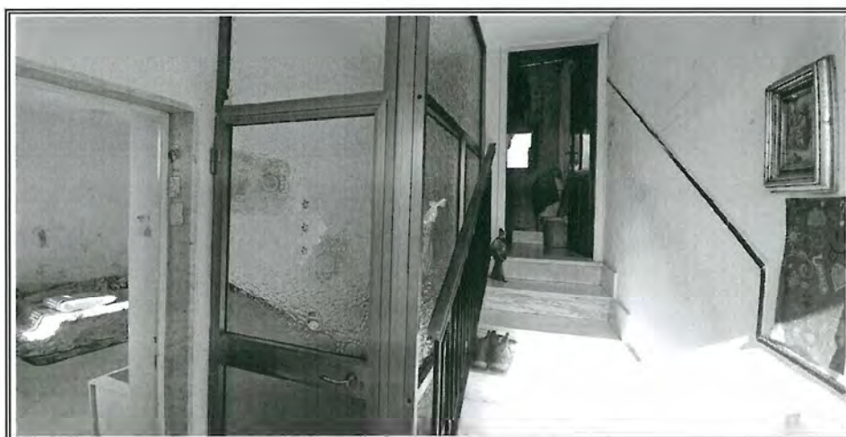
Foto n. 5 – Ingresso all'appartamento al piano secondo
