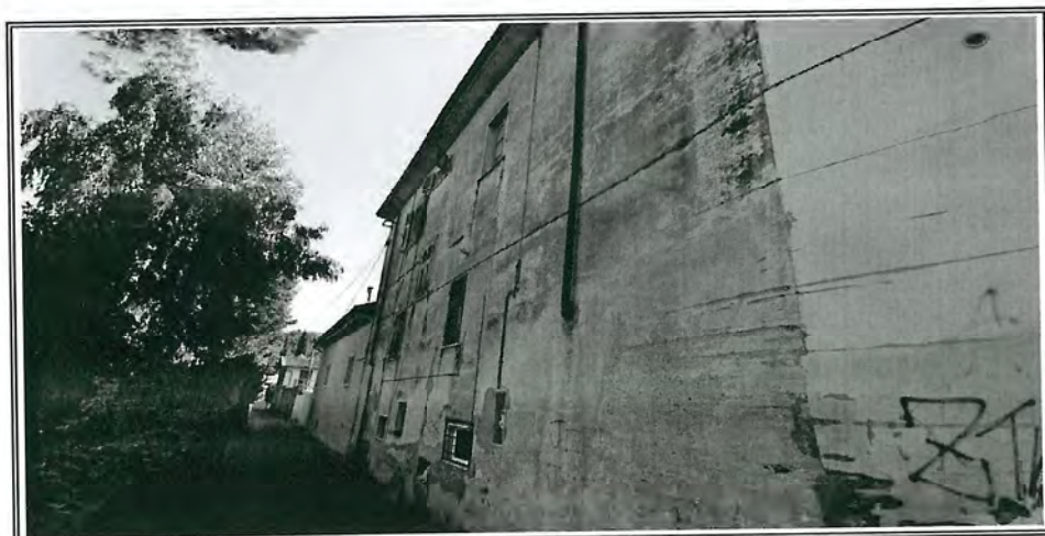
Foto n. 2 – Vista del Fabbricato lato monte su Via Galissano
