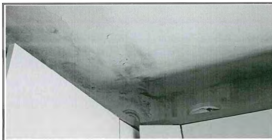
Foto n. 9 – Particolare soffitto del vano pranzo/cottura
