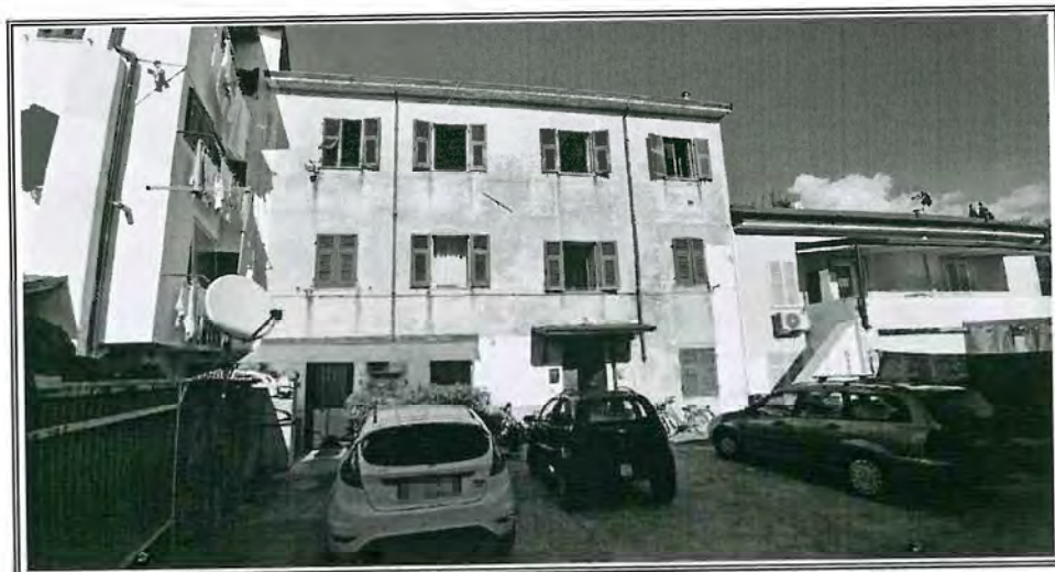
Foto n. 1 – Vista del fabbricato facciata lato mare verso la corte comune
