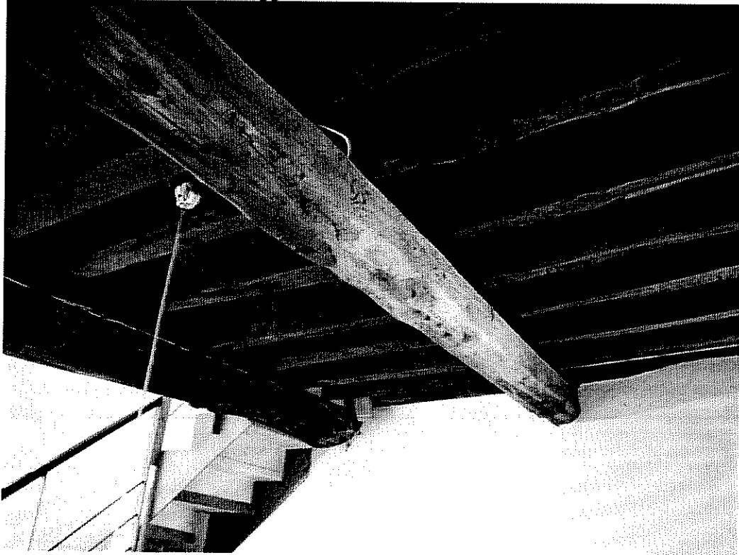
Particolare del soffitto del soggiorno
