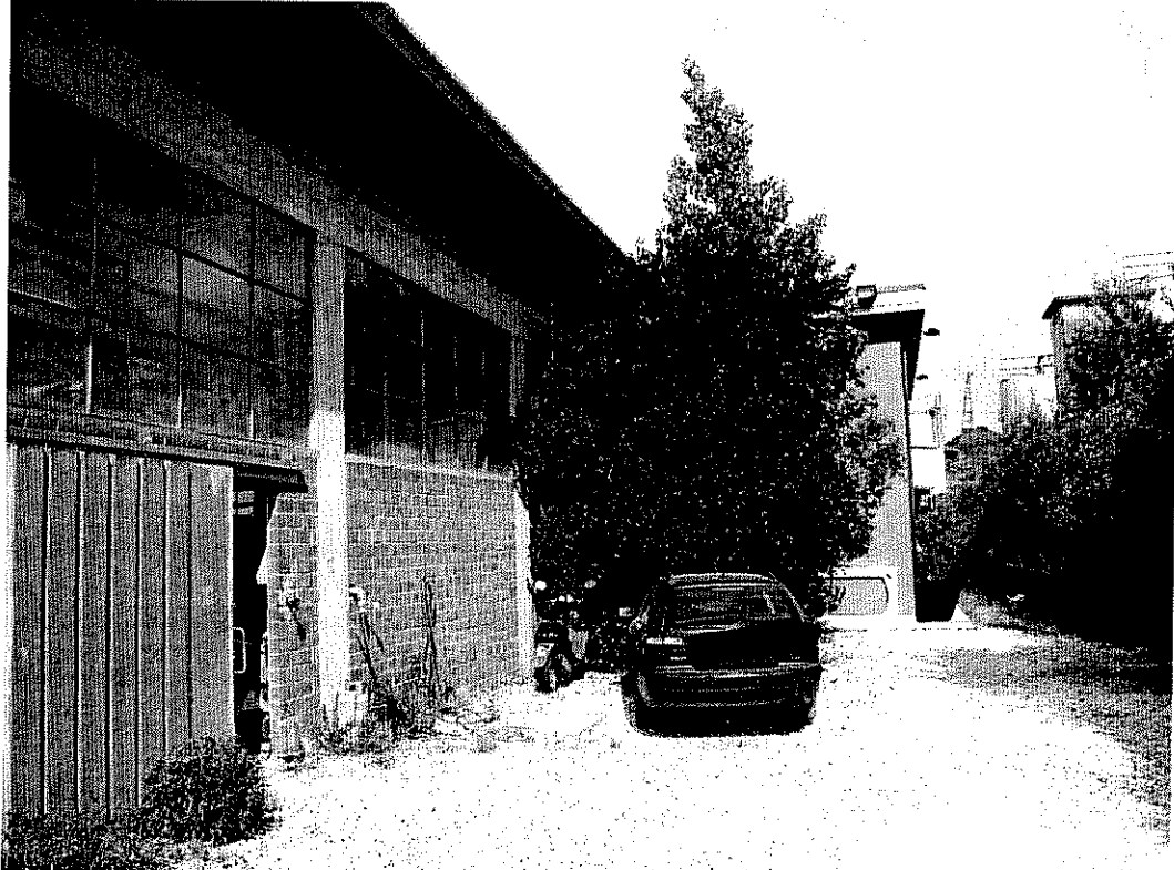
CAPANNONE - A - Vista del lato monti
