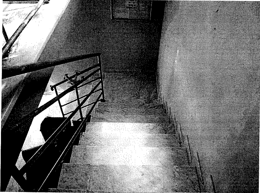
CAPANNONE - A - La scala di accesso ai locali ad uso uffici
