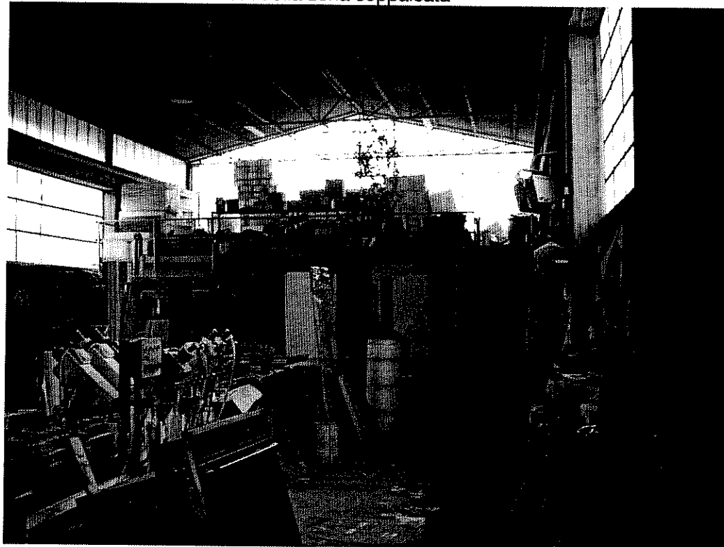
CAPANNONE - A - Vista della zona sopralcata
