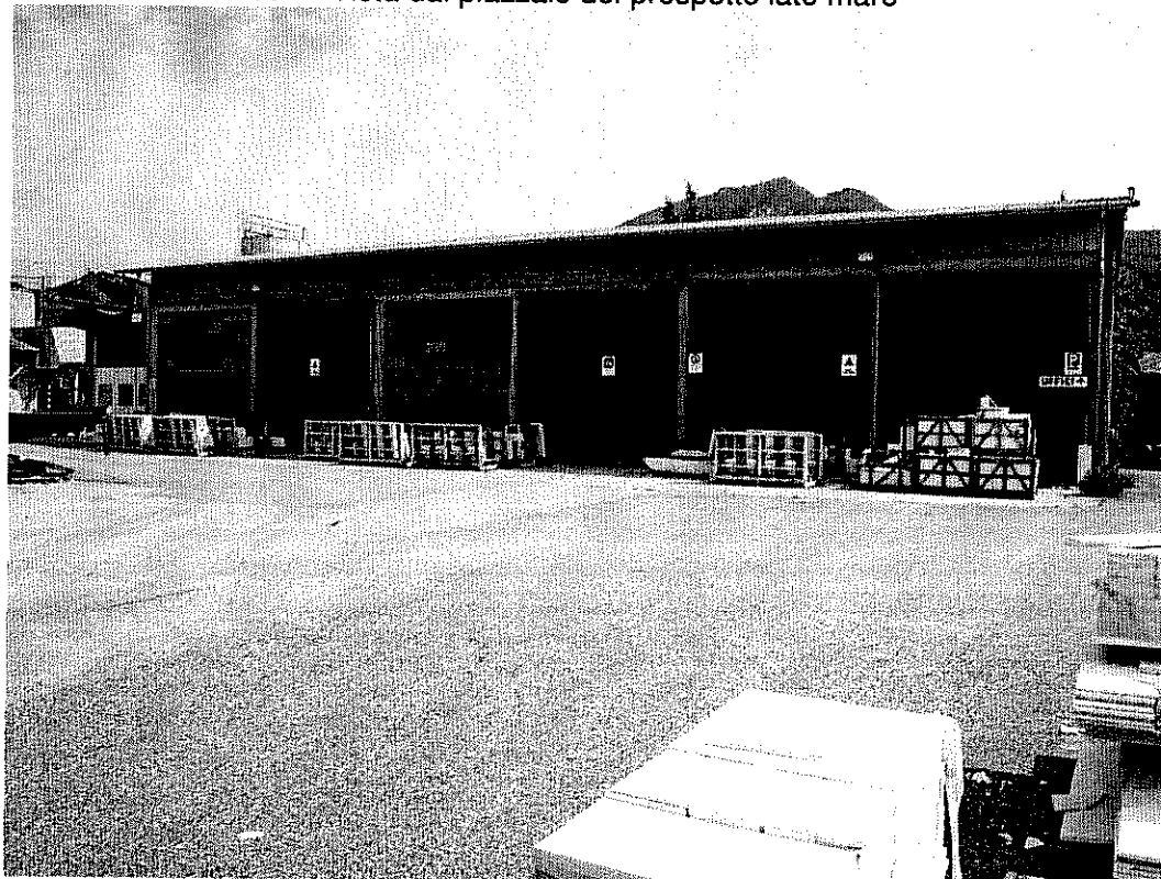
CAPANNONE - A - Vista dal piazzale del prospetto lato mare
