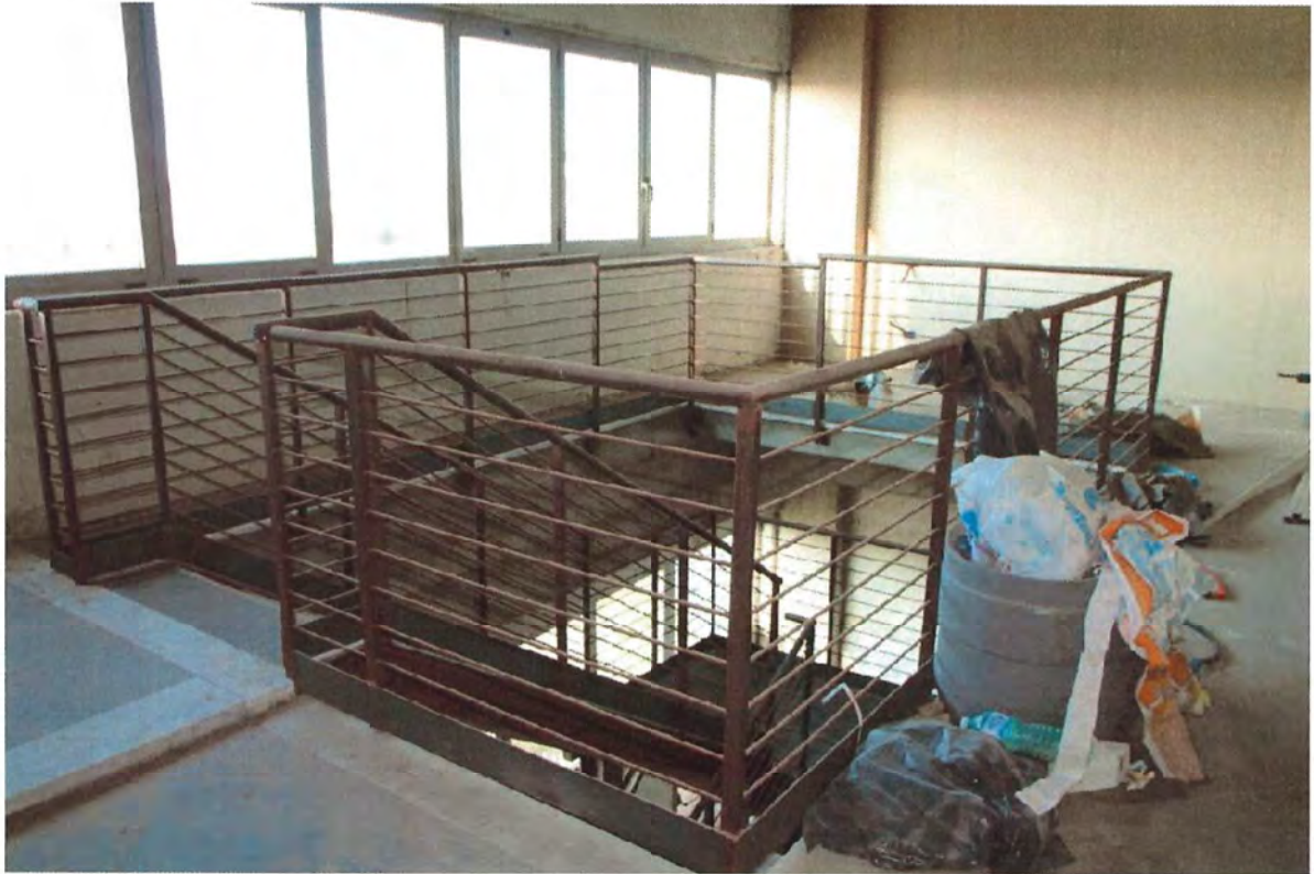
Foto 17. Interno capannone, scala interna
