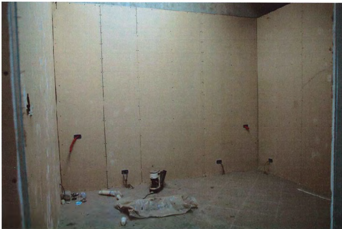
Foto 24. Interno capannone, piano primo, uffici
