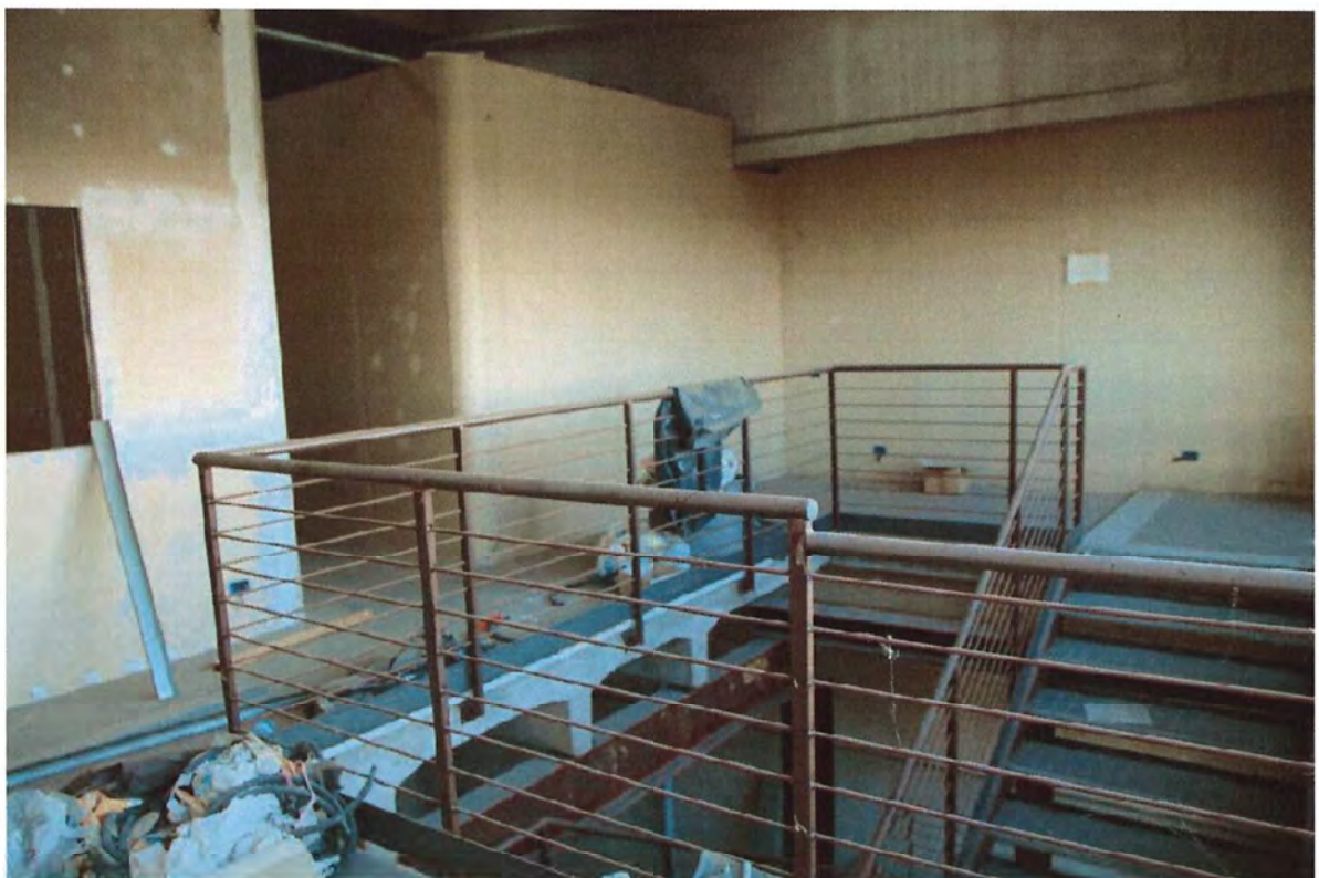
Foto 18. Interno capannone, sbarco scala a piano primo
