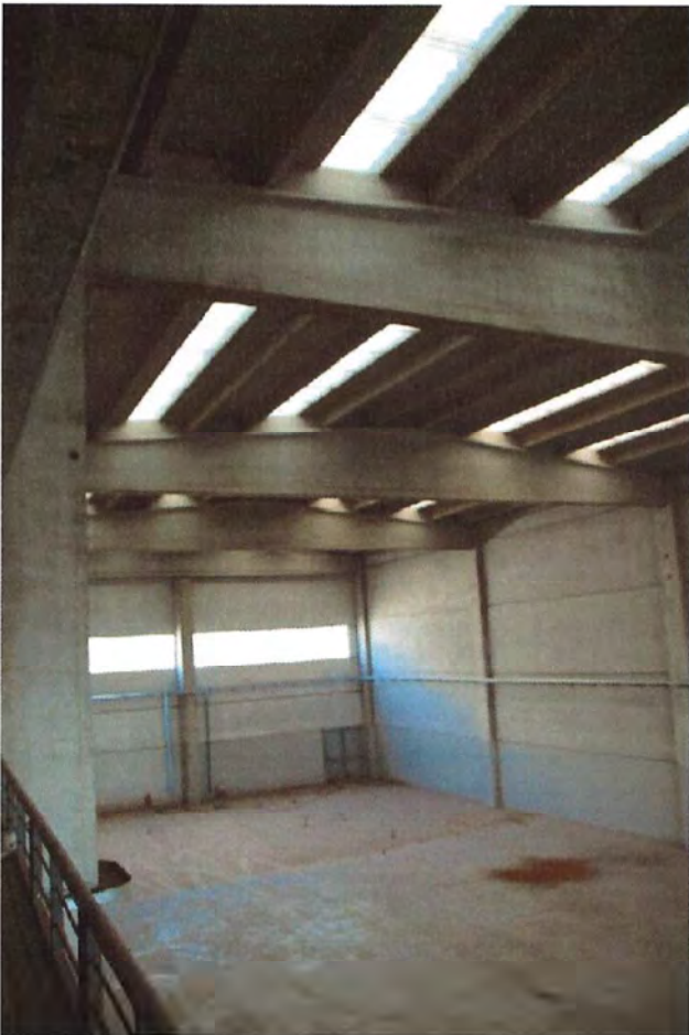
Foto 6. Interno capannone vista da zona di affaccio piano primo su capannone
