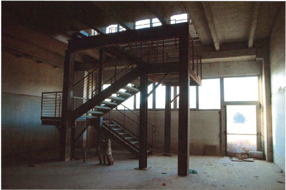
Foto15. Interno capannone, scala interna
