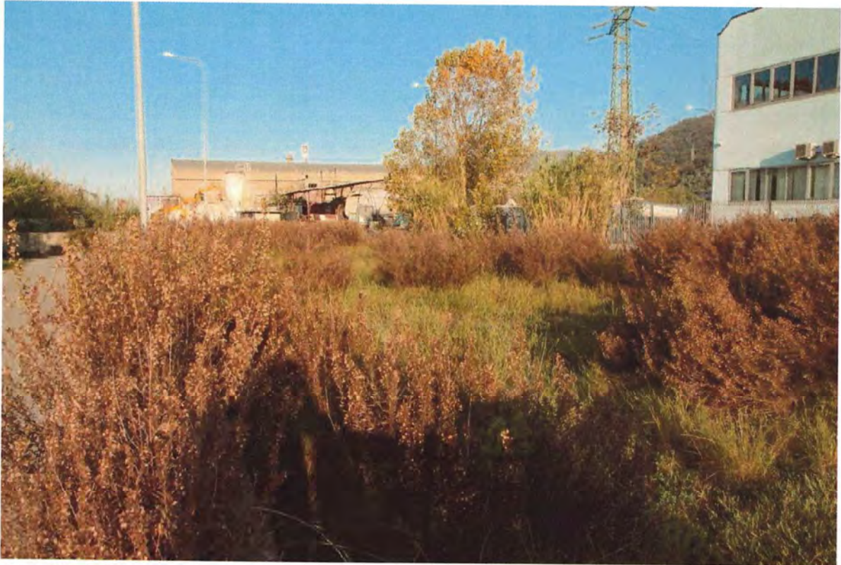
Foto 39. Esterno capannone, area di pertinenza
