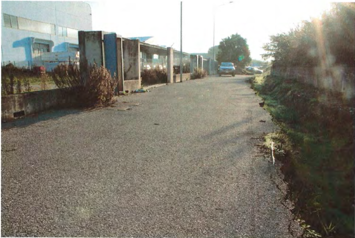
Foto 32. Strada d'accesso a capannone
