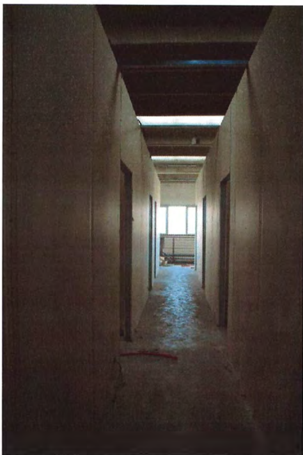
Foto 28. Interno capannone, piano primo, uffici
