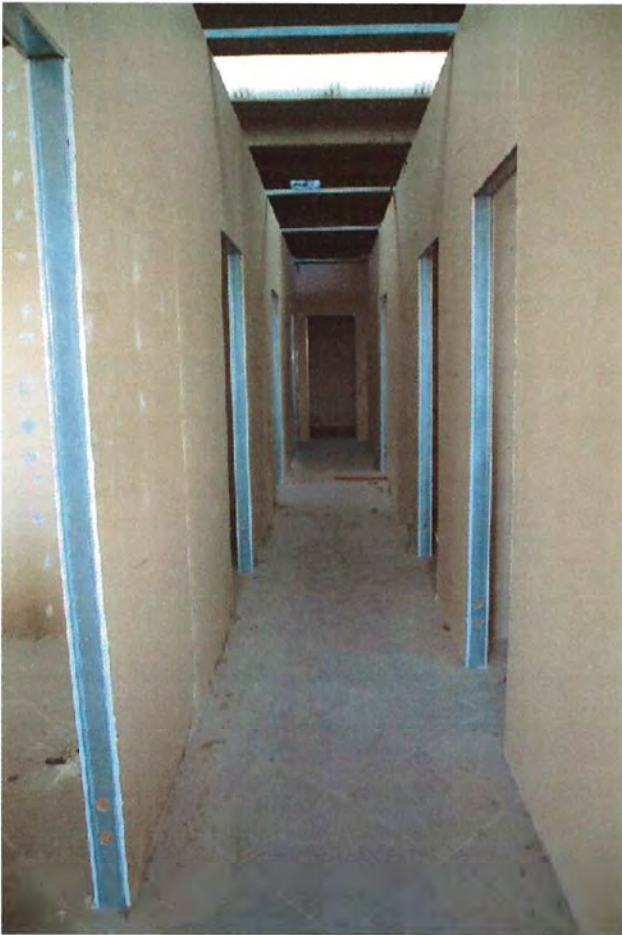
Foto 19. Interno capannone, piano primo, uffici
