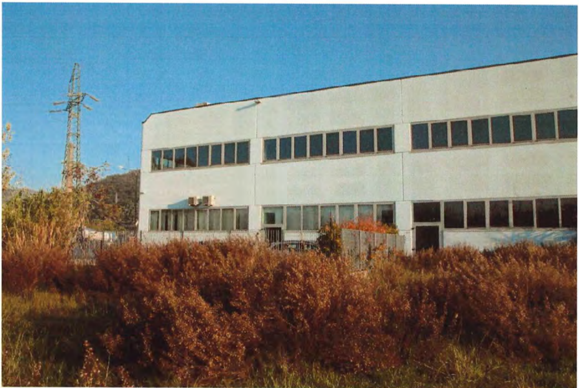
Foto 38. Esterno capannone e capannone confinante
