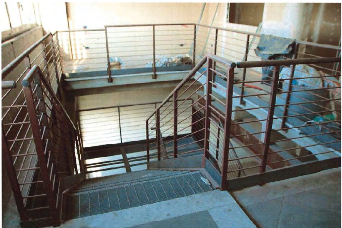
Foto 16. Interno capannone, scala interna
