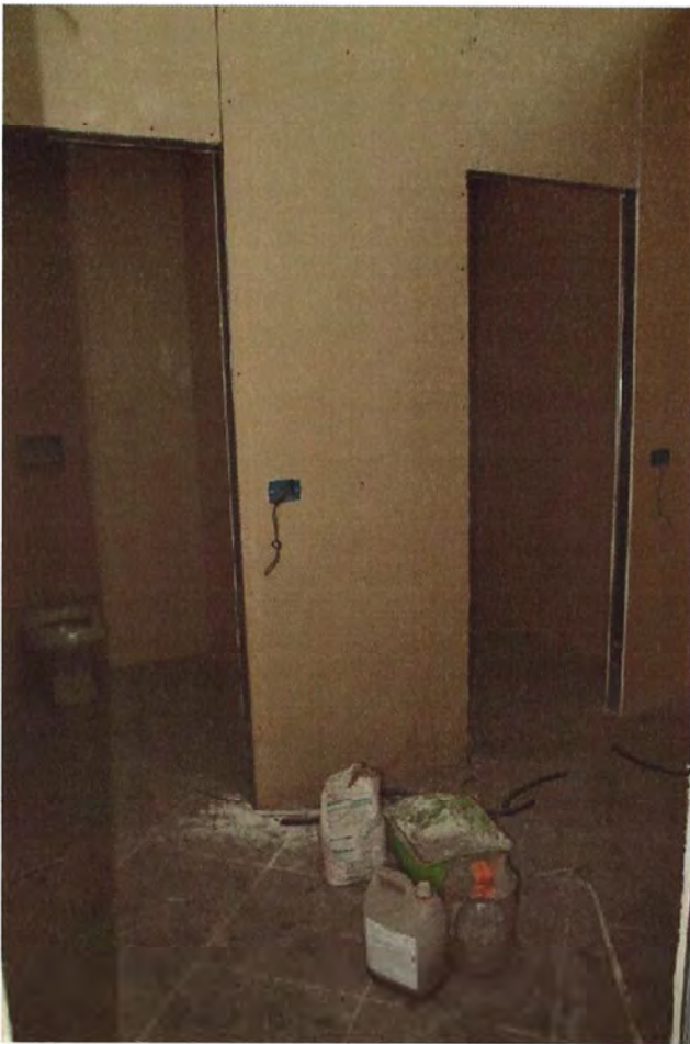
Foto 22. Interno capannone, piano primo, uffici
