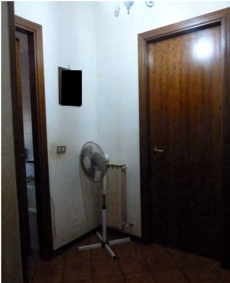
FOTO 22: piano primo – disimpegno
