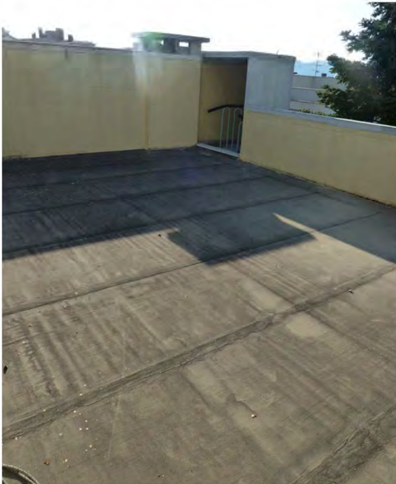
FOTO 29: piano copertura – terrazzo con scala interna collegamento con piano lastrico solare
