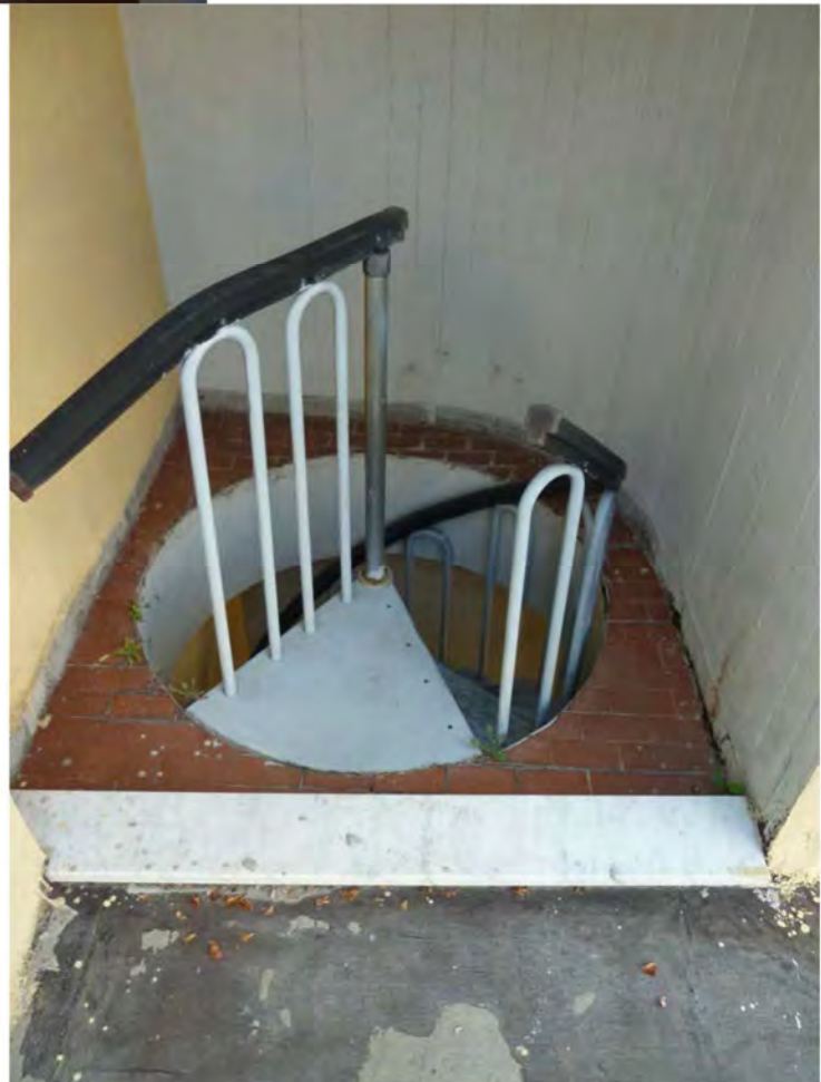
FOTO 28: piano copertura – arrivo scala interna collegamento con piano primo
