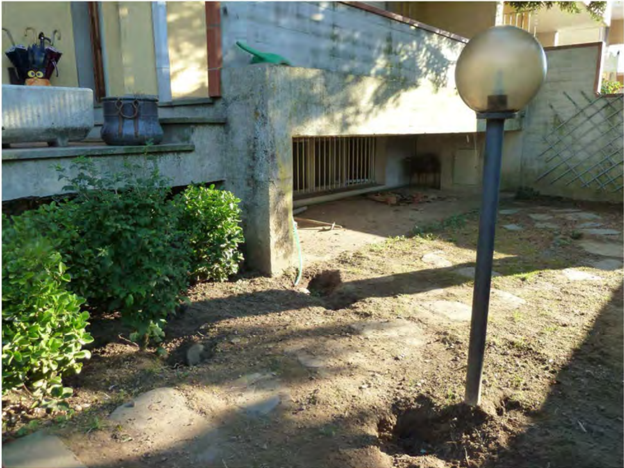
FOTO 15: piano rialzato – vista terrazzo con accesso principale all'immobile
