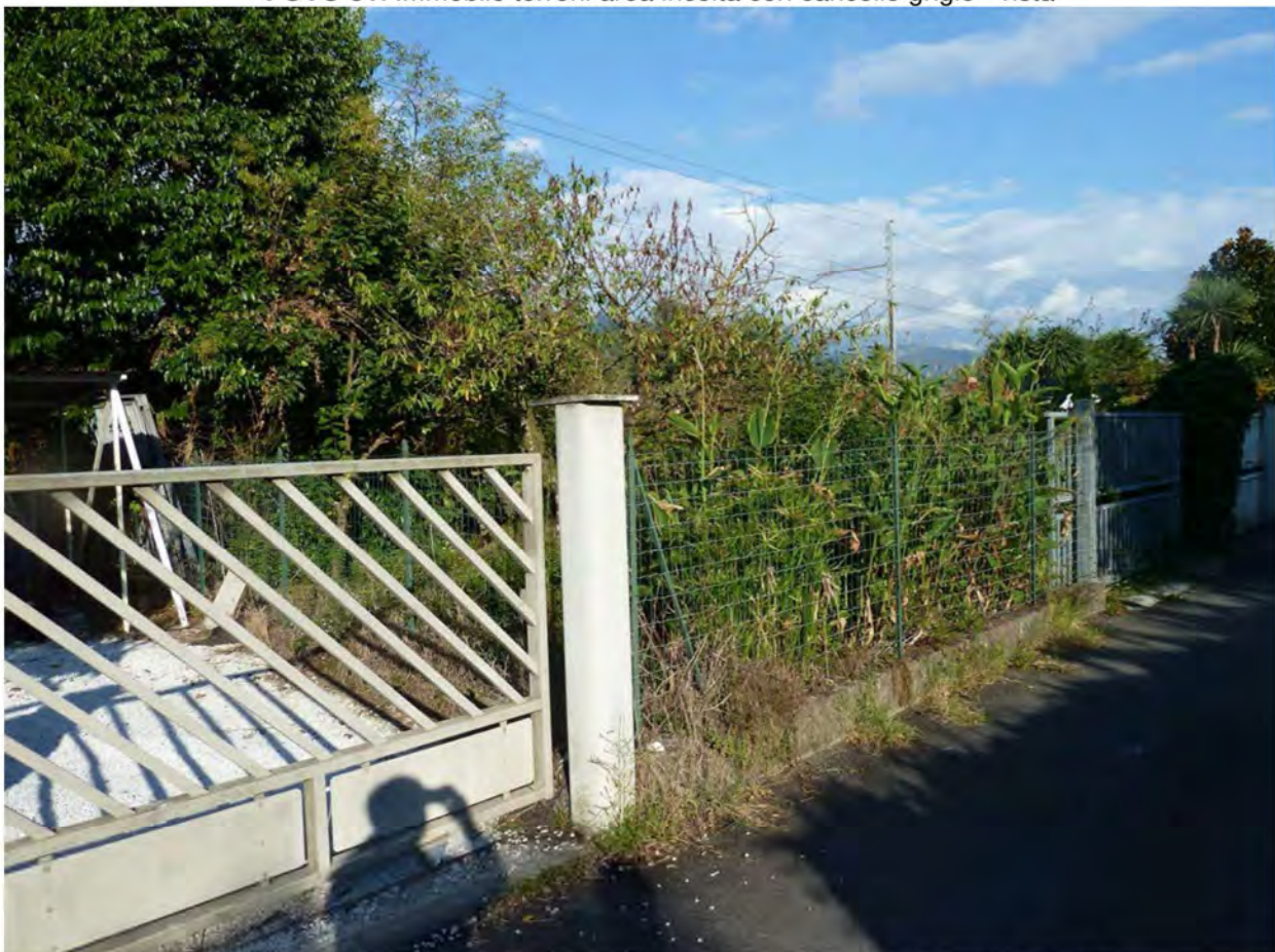
FOTO 32: Immobile terreni – area incolta con cancello grigio particolare
