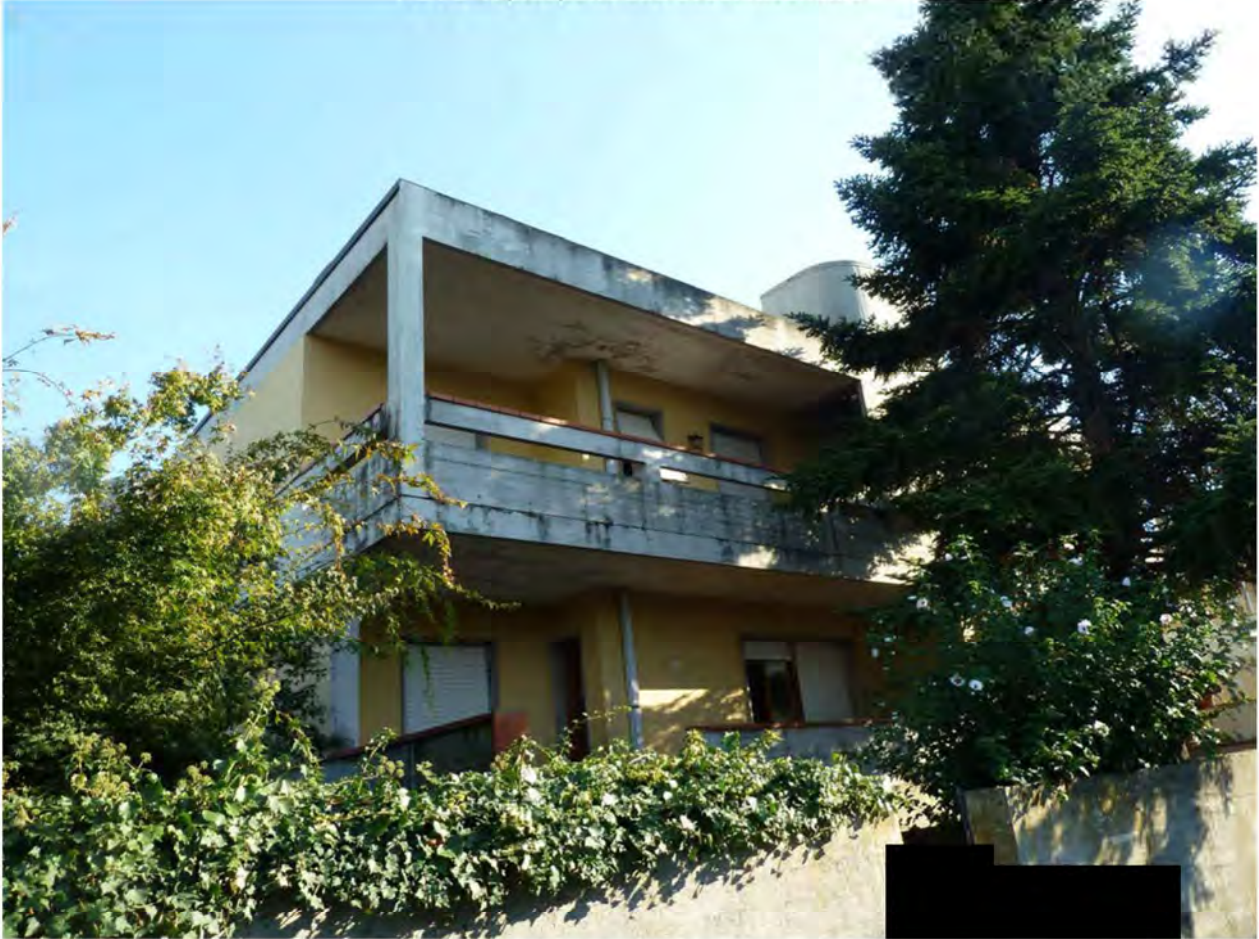
FOTO 1: prospetto sud ovest fabbricato
