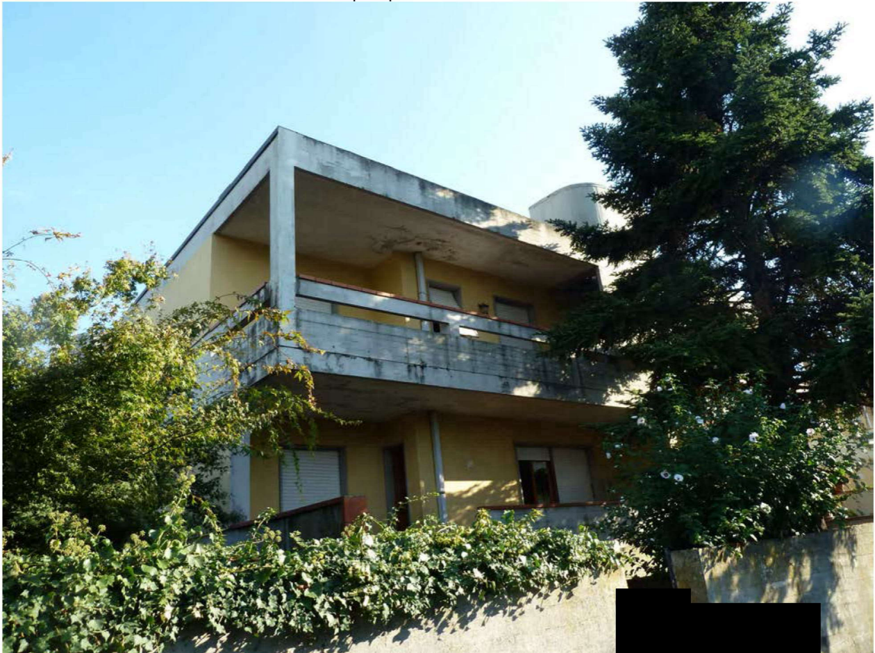
FOTO 1: prospetto sud ovest fabbricato
