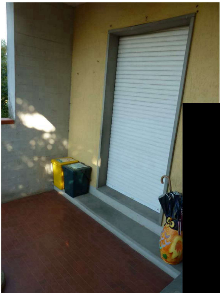
FOTO 13: piano rialzato – terrazzo con accesso principale all'immobile
