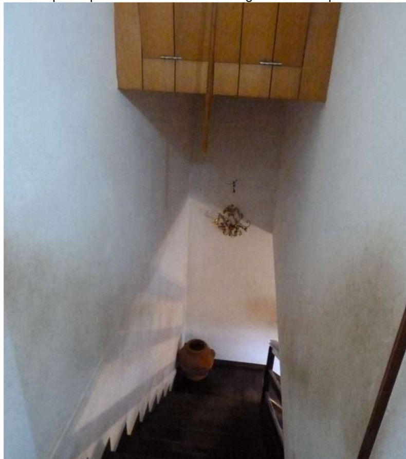
FOTO 21: piano primo— scala interna collegamento con piano rialzato
