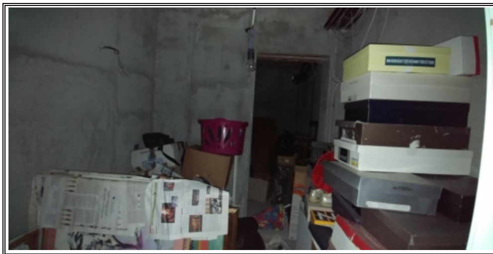
Foto n. 19 – Piano seminterrato - Ripostiglio
