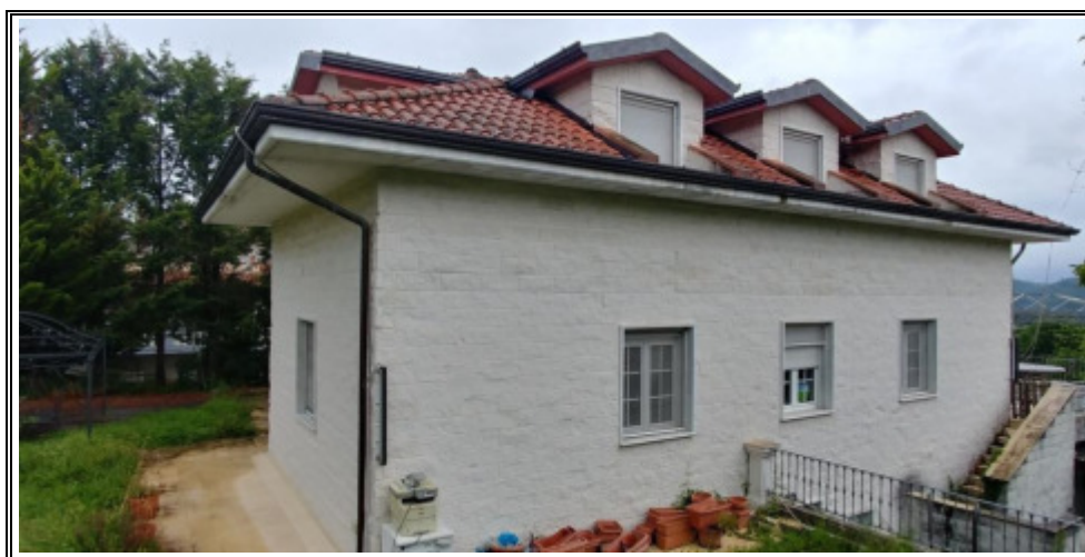
Foto n. 3 – Vista del fabbricato angolo SUD-EST
