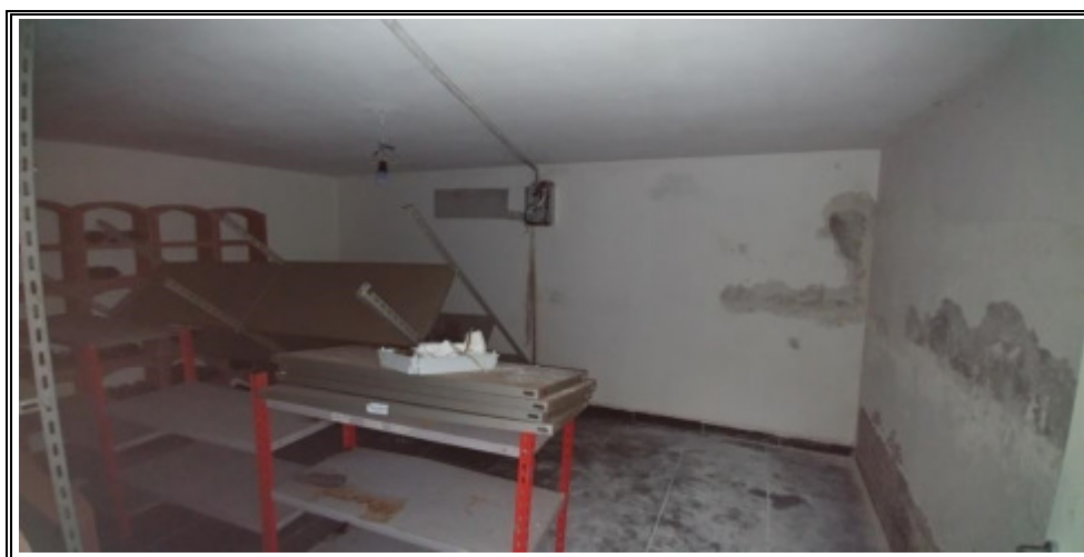
Foto n. 24 – Piano interrato - cantina
