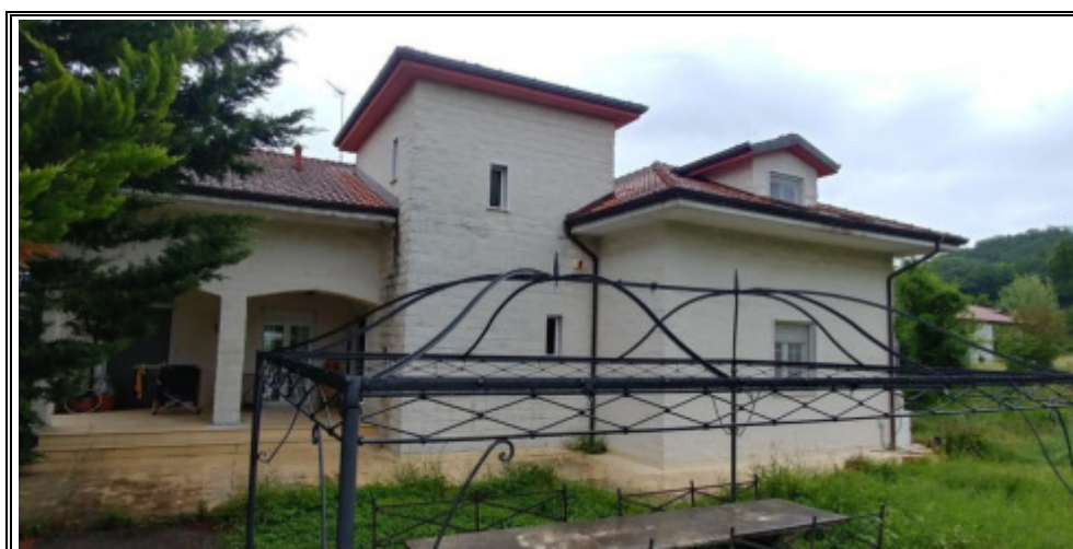
Foto n. 2 – Vista del Fabbricato, facciata lato SUD
