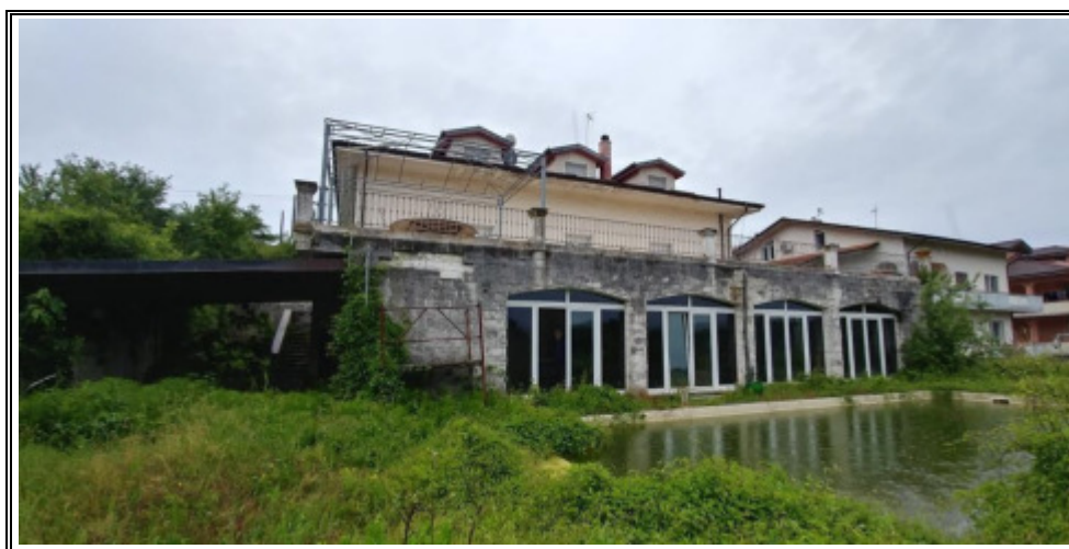
Foto n. 6 – Vista del fabbricato angolo NORD-EST
