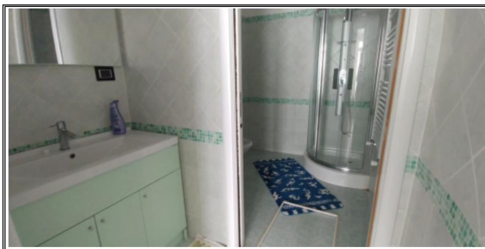
Foto n. 21 – Piano seminterrato - Bagno
