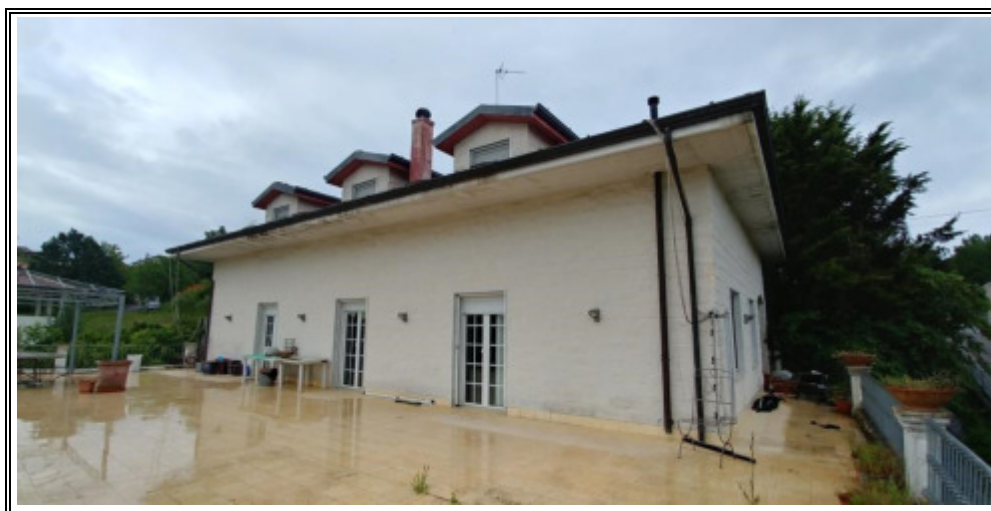
Foto n. 4 – Vista del fabbricato angolo NORD-OVEST – Piano terra
