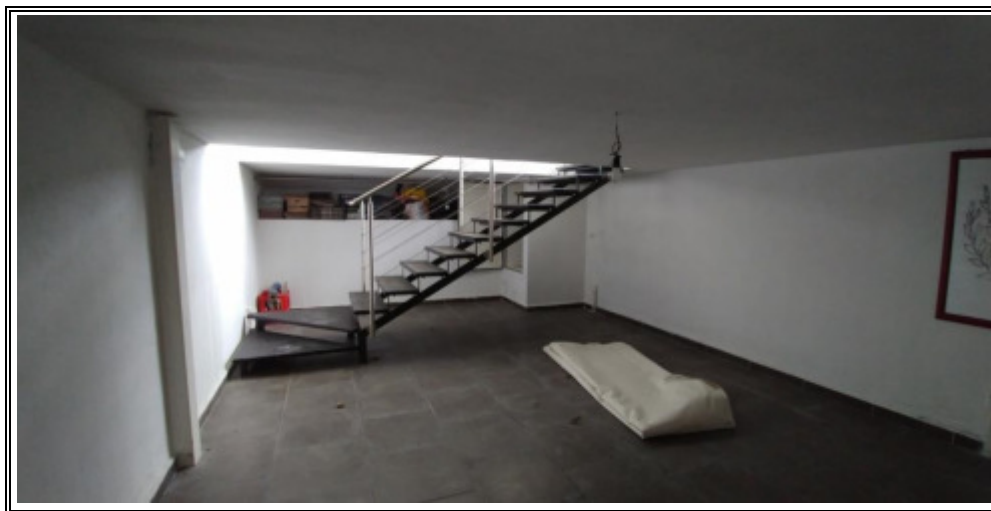
Foto n. 22 – Piano interrato - Cantina
