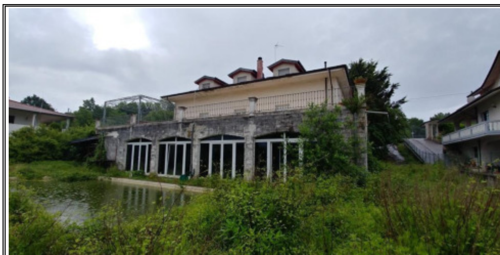
Foto n. 5 – Vista del fabbricato angolo NORD-OVEST
