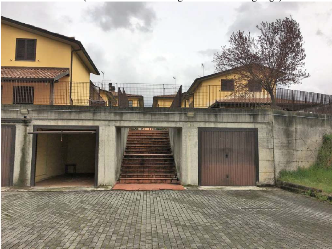
P.V. 14 (Vista scalinata di collegamento con area garage)
