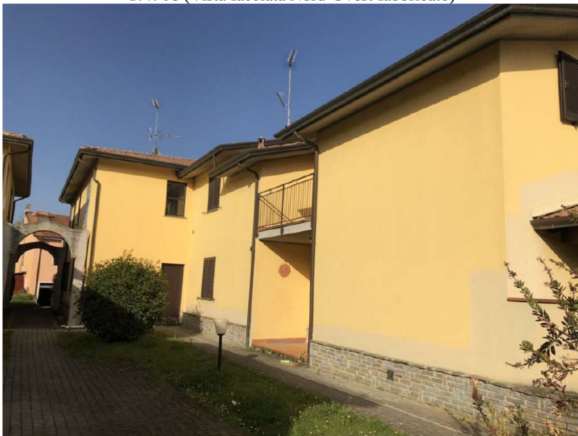
P.V. 08 (Vista facciata Nord-Ovest fabbricato)
