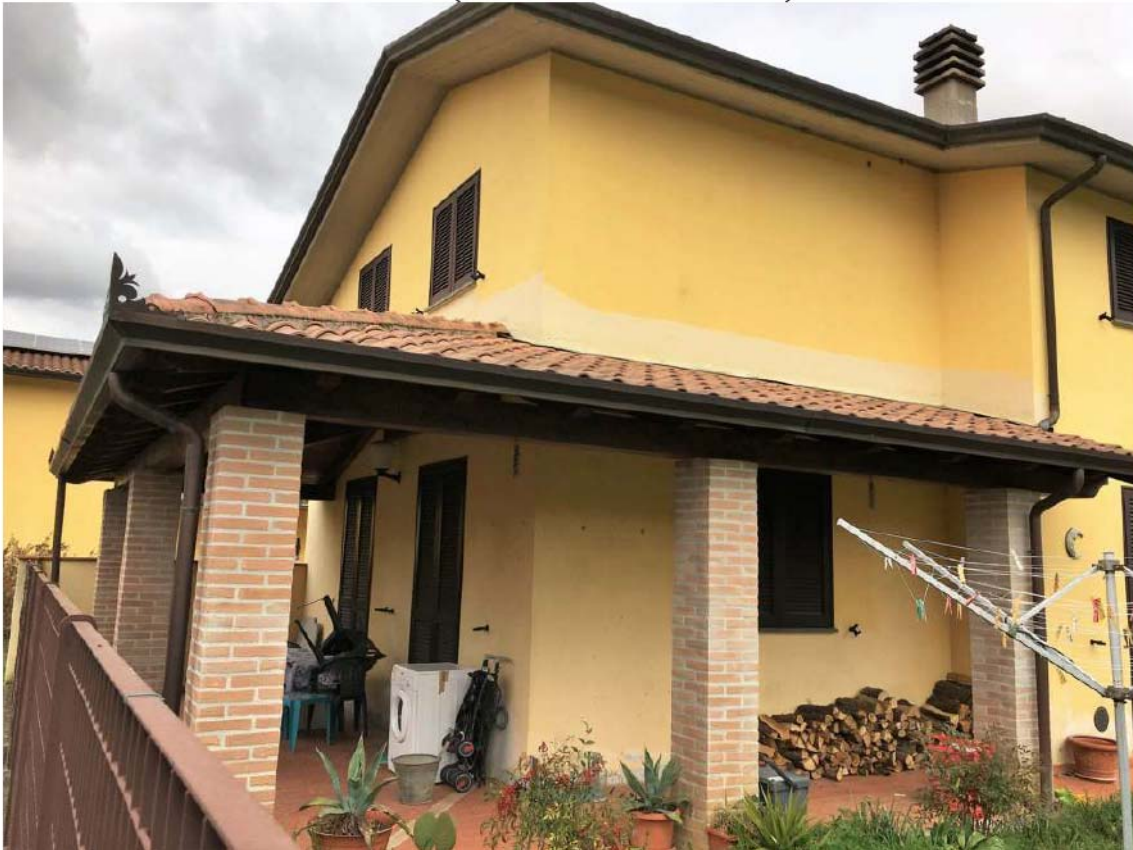
P.V. 11 (Vista fabbricato da Sud)
