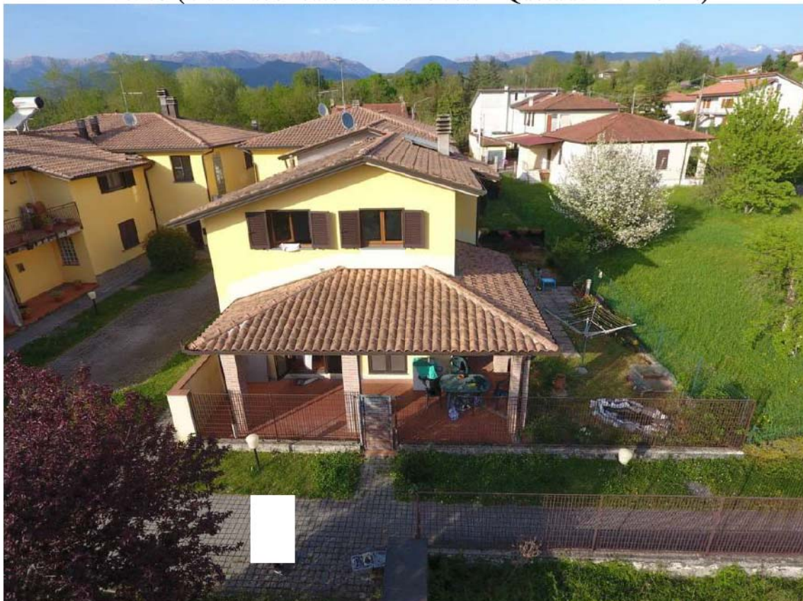
P.V. 03 (Vista fabbricato da Sud-Ovest – Quota s.l.m. 116 Mt)
