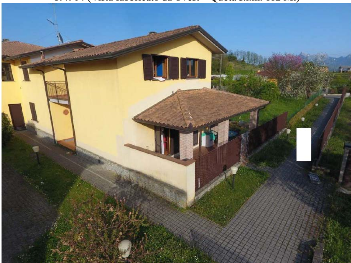
P.V. 04 (Vista fabbricato da Ovest – Quota s.l.m. 112 Mt)
