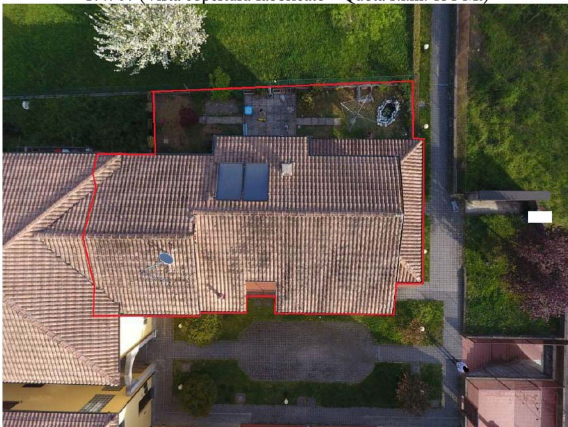
P.V. 07 (Vista copertura fabbricato – Quota s.l.m. 131 Mt)
