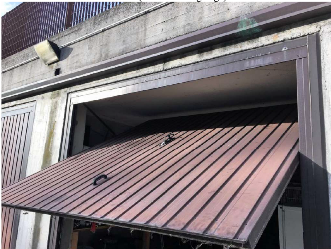
P.V. 40 (Vista esterno garage)
