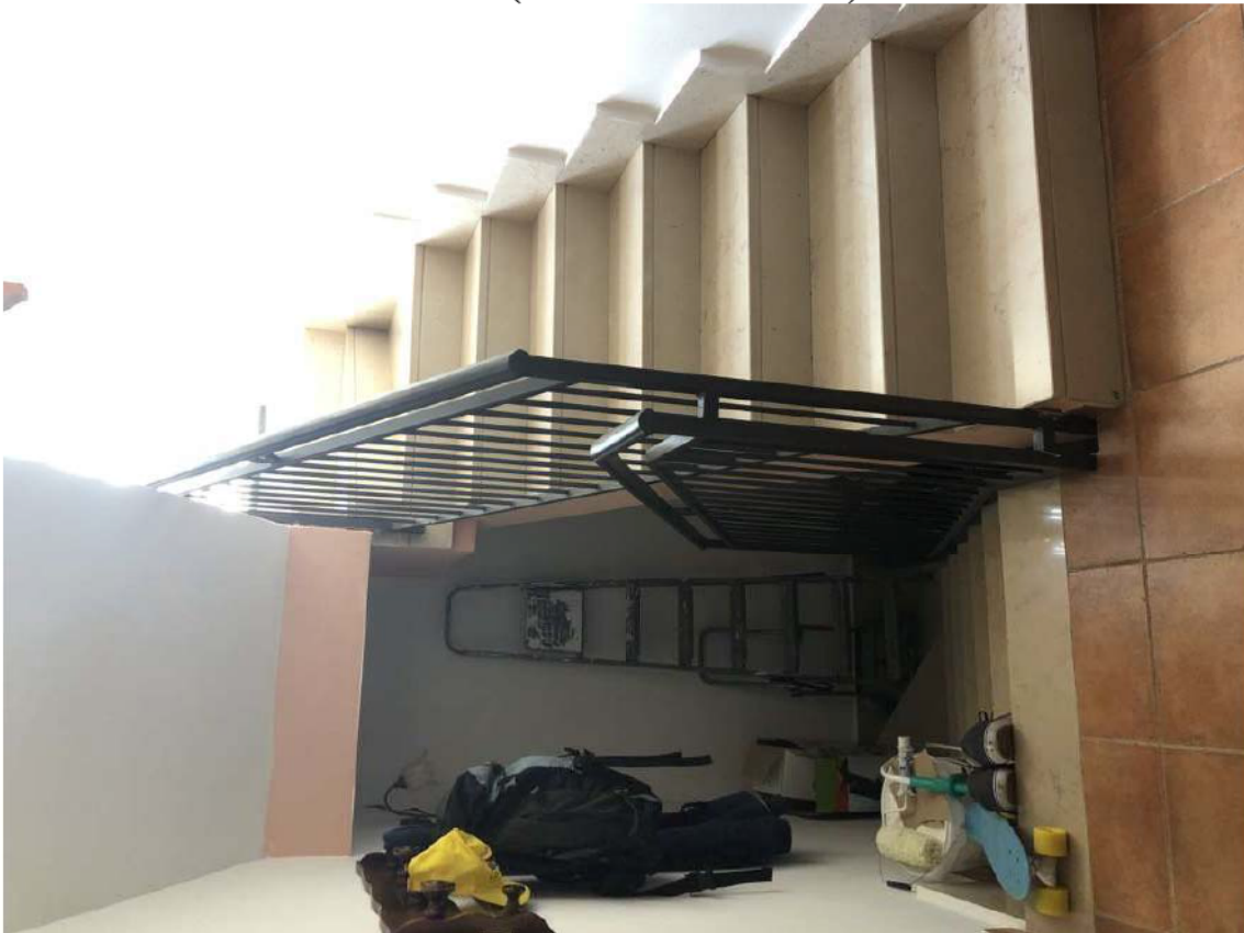
P.V. 20 (Vista vano scala a PT)
