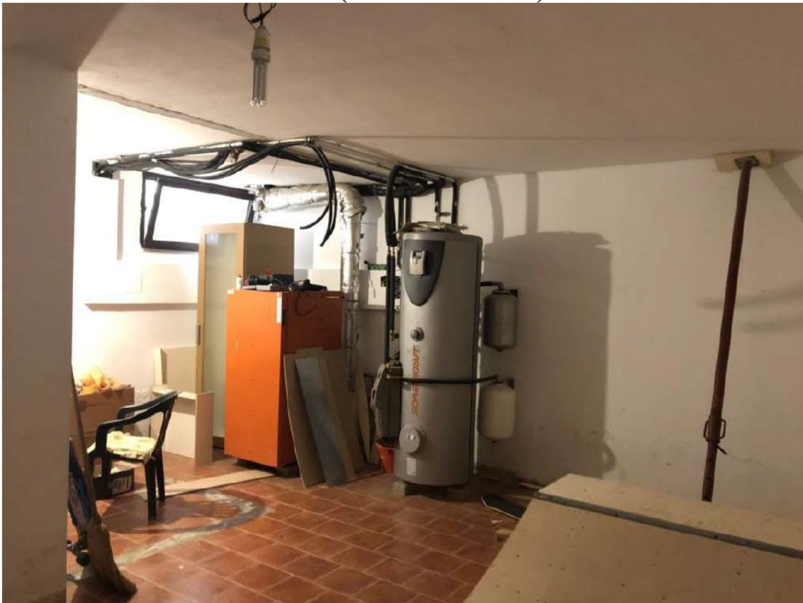
P.V. 36 (Vista cantina a PS1)
