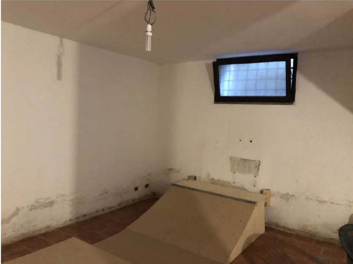
P.V. 35 (Vista cantina a PS1)
