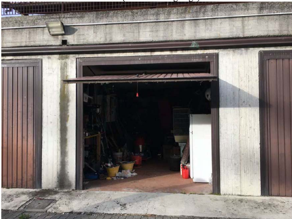
P.V. 39 (Vista esterno garage)
