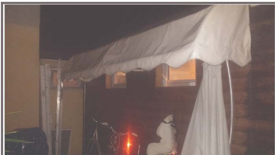
Foto n. 11 – Appartamento A – Corpo abusivo in ampliamento
