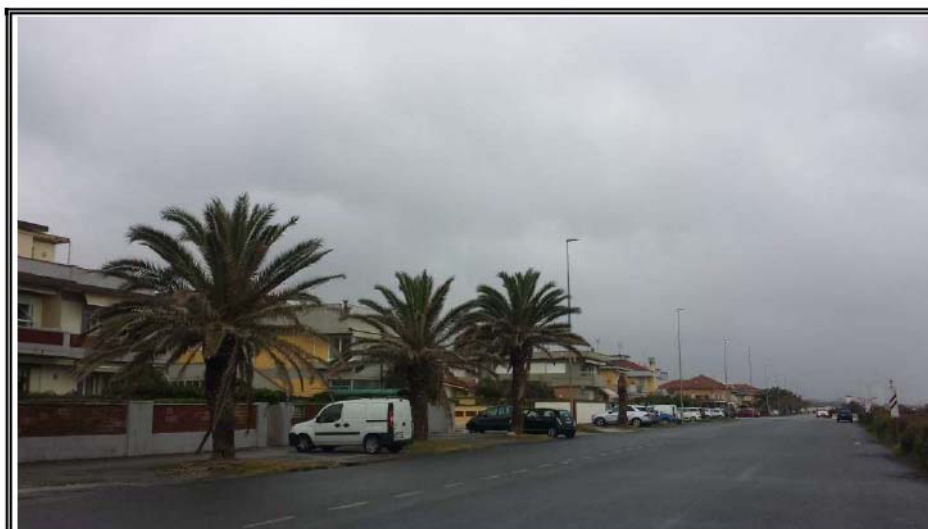
Foto n. 1 – Vista del fabbricato da Viale G. Da Verrazzano
