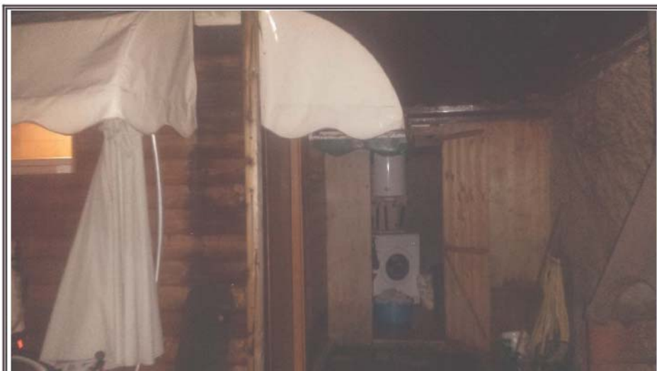
Foto n. 12 – Appartamento A – Corpo abusivo in ampliamento
