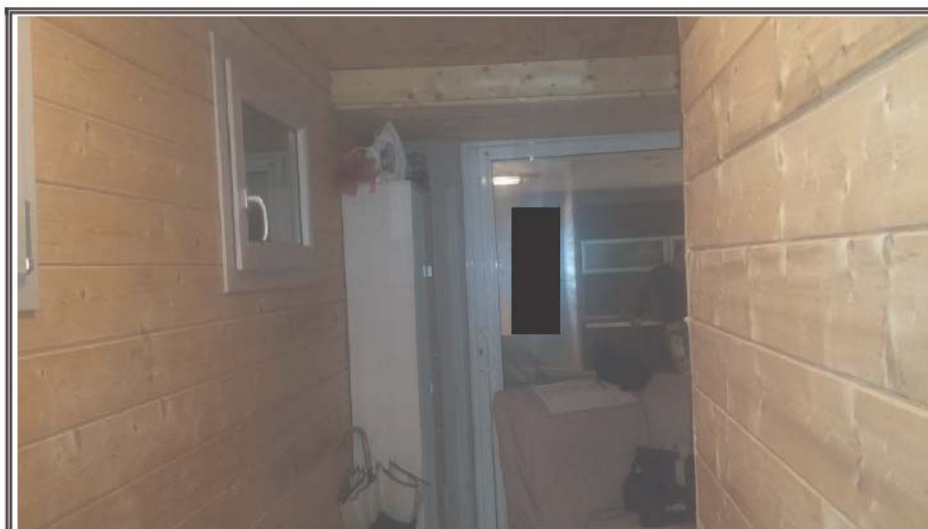
Foto n. 10 – Appartamento A – Ingresso (corpo abusivo in ampliamento)
