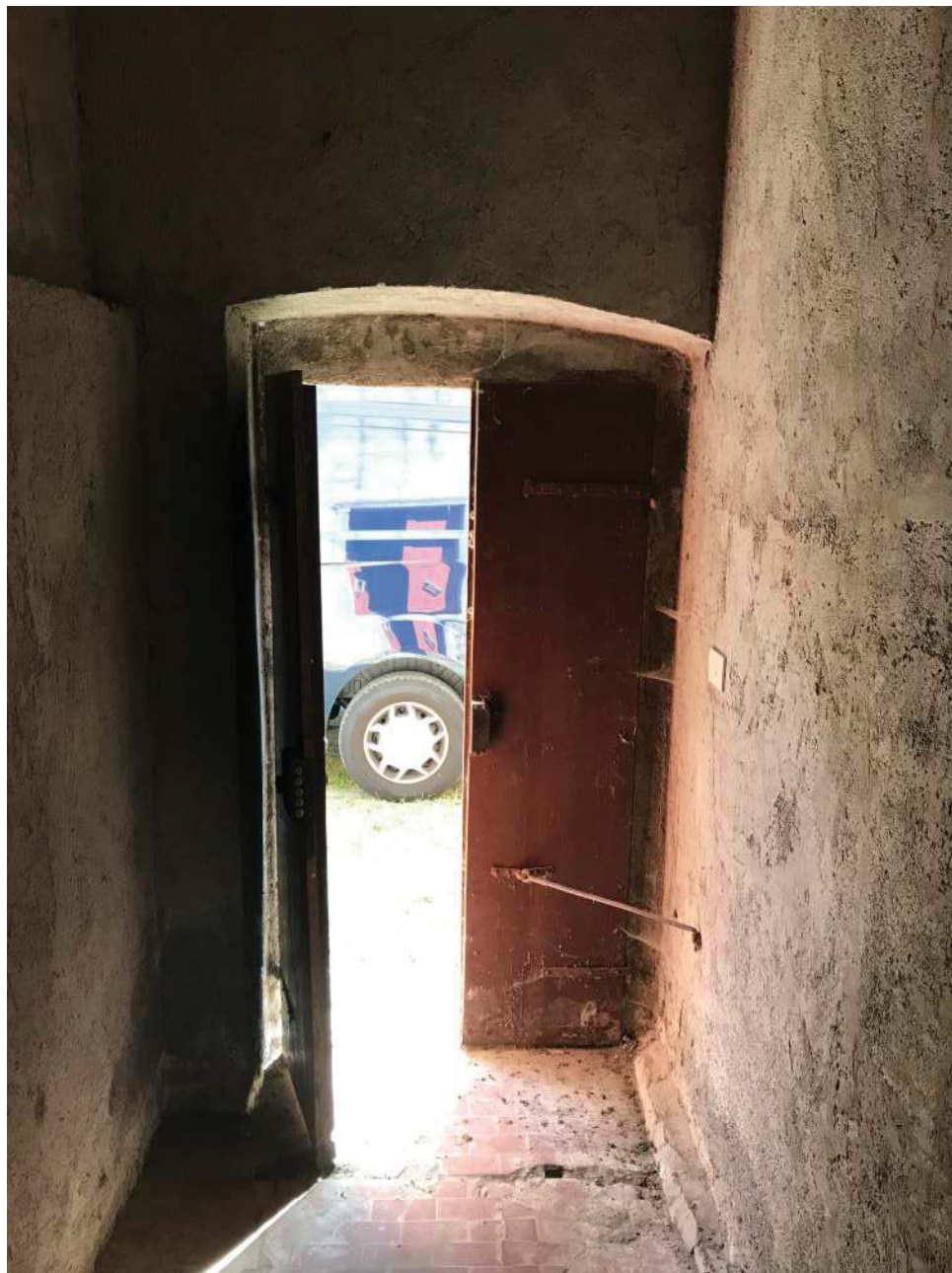
Foto 14: Magazzino. Via S.s. della Cisa, Comune di Pontremoli (MS), Frazione Borgo Santissima Annunziata. Lotto 001.
