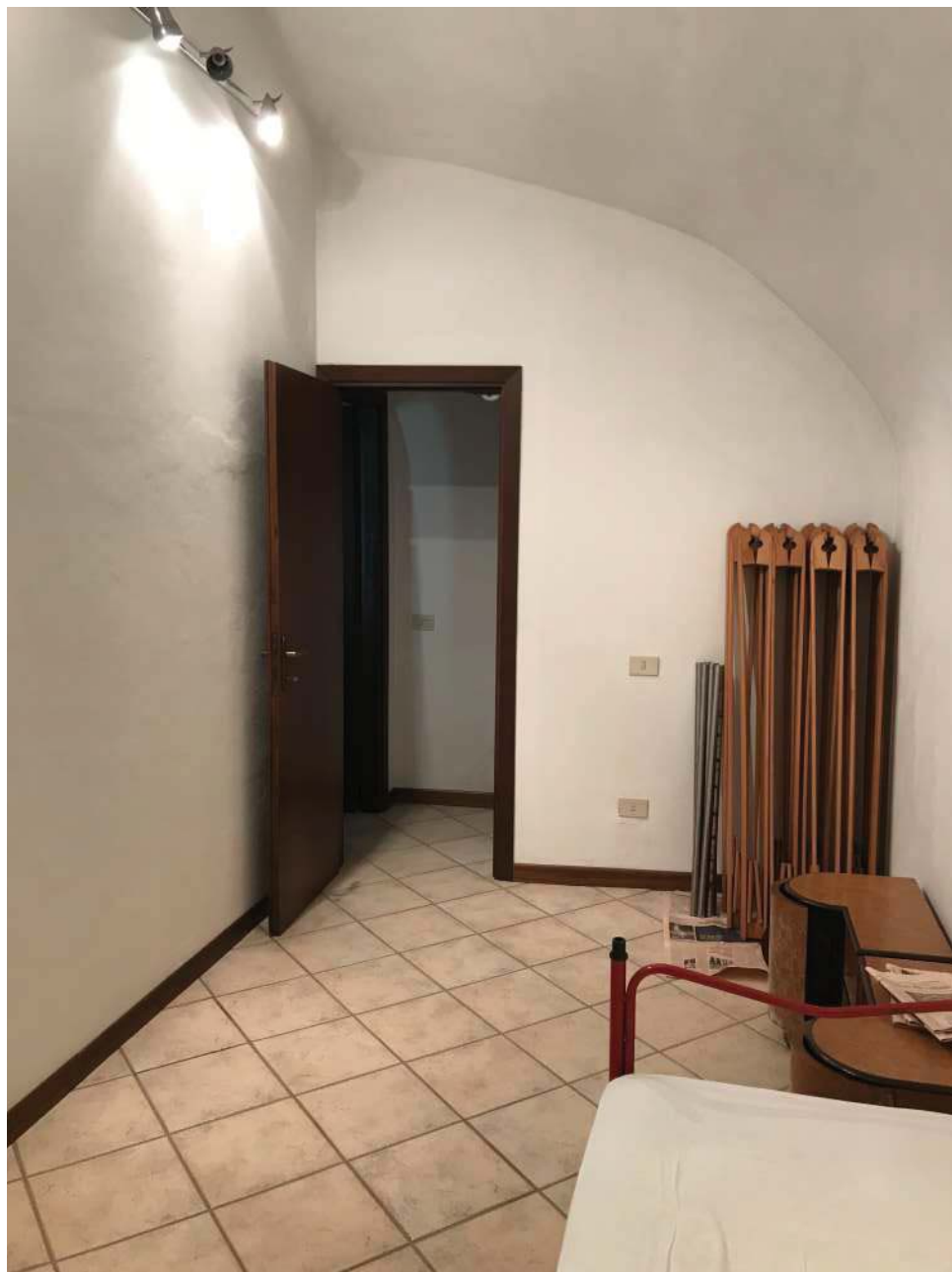
Foto 8: Camera 1. Via S.s. della Cisa, Comune di Pontremoli (MS), Frazione Borgo Santissima Annunziata. Lotto 001.
