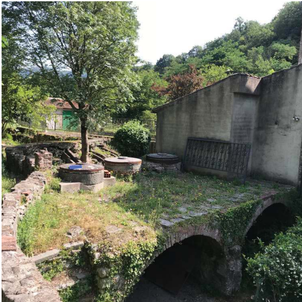
Foto E9: Rudere del mulino e resti delle macine. Via S.s. della Cisa, Comune di Pontremoli (MS), Frazione Borgo Santissima Annunziata. Lotto 001.
