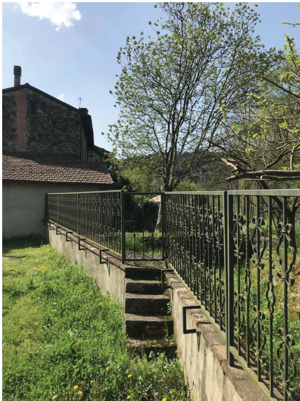
Foto E14: Accesso giardino pertinenziale lato nord. Via S.s. della Cisa, Comune di Pontremoli (MS), Frazione Borgo Santissima Annunziata. Lotto 001.
