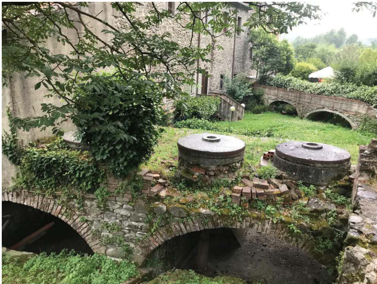
Foto E8: Rudere del mulino e resti delle macine. Via S.s. della Cisa, Comune di Pontremoli (MS), Frazione Borgo Santissima Annunziata. Lotto 001.
