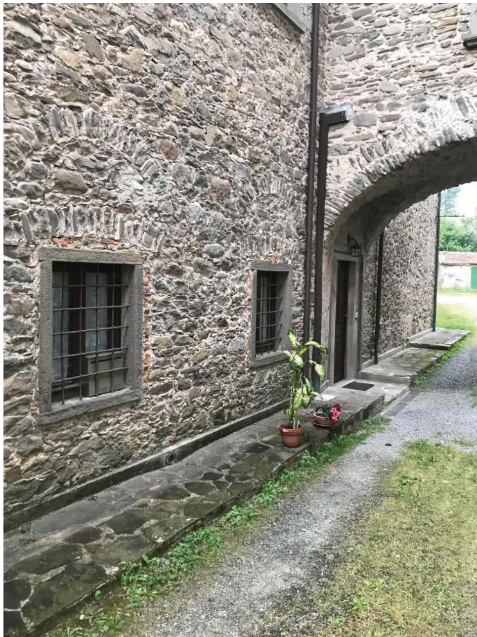
Foto E19: Fronte abitazione sul cortile. Via S.s. della Cisa, Comune di Pontremoli (MS), Frazione Borgo Santissima Annunziata. Lotto 001.
