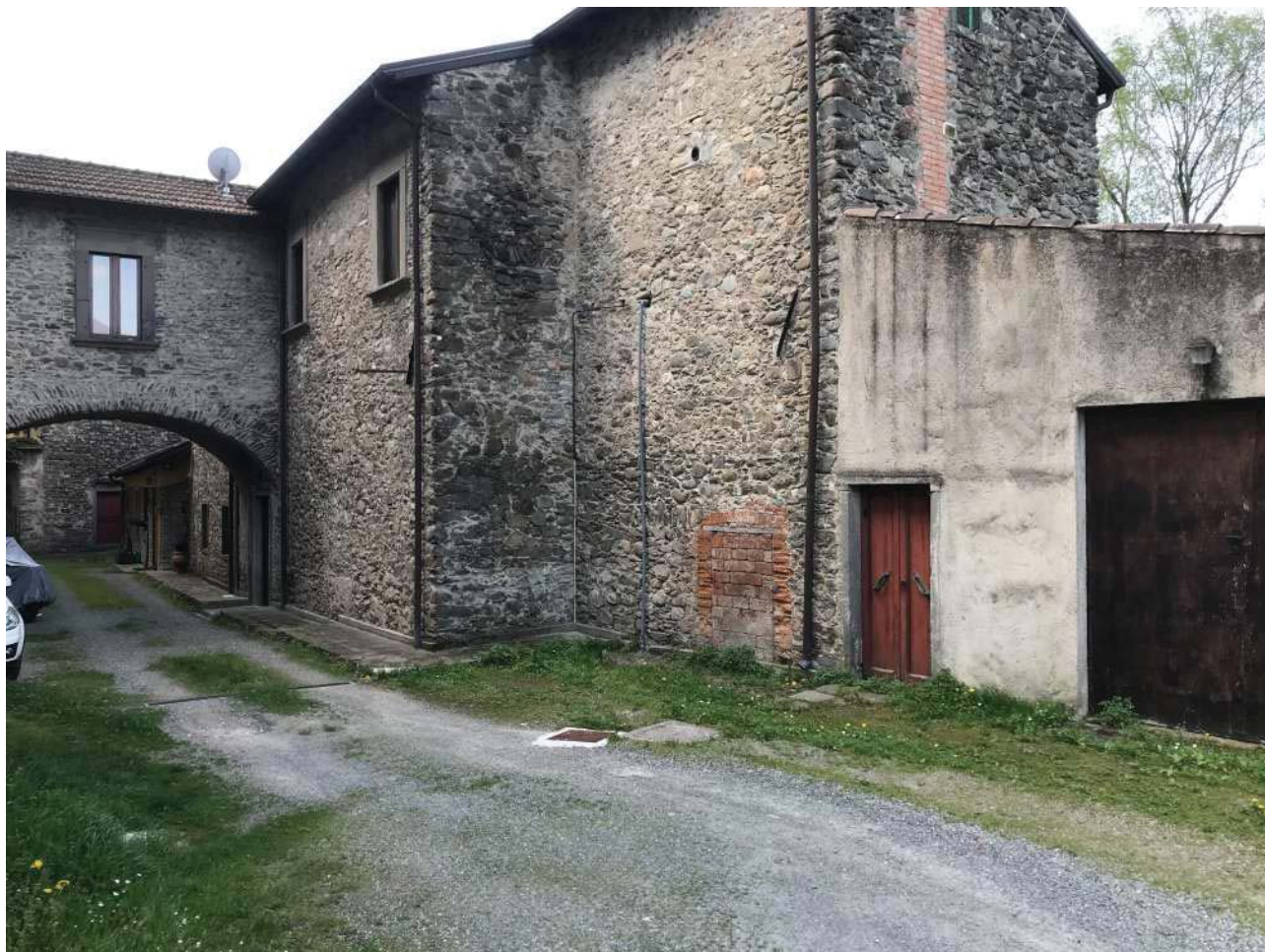
Foto E12: Cortile. Via S.s. della Cisa, Comune di Pontremoli (MS), Frazione Borgo Santissima Annunziata. Lotto 001.
