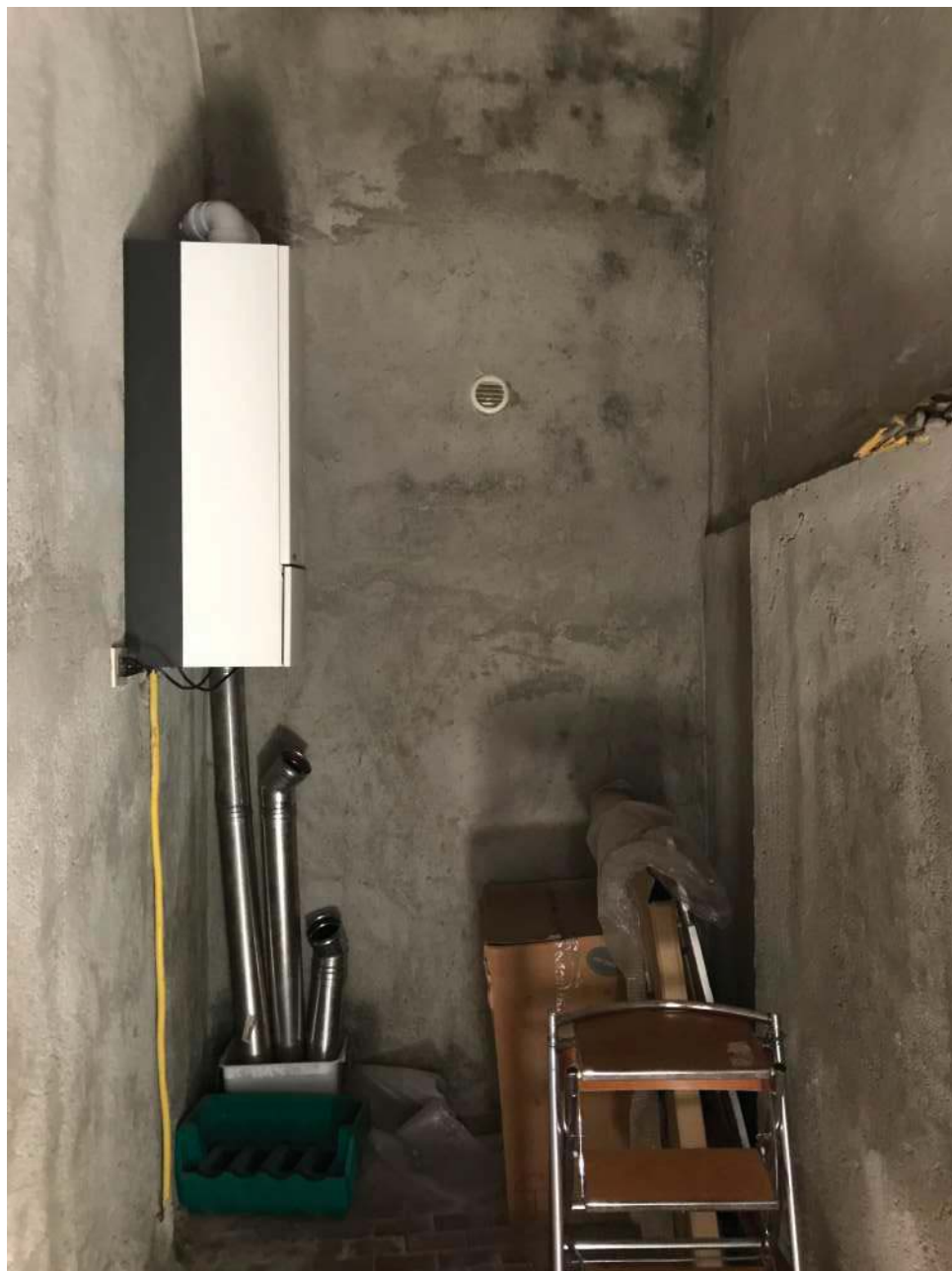
Foto 15: Magazzino. Via S.s. della Cisa, Comune di Pontremoli (MS), Frazione Borgo Santissima Annunziata. Lotto 001.
