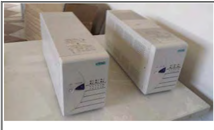
Foto n. 74 - Vano infermeria - Capannone
