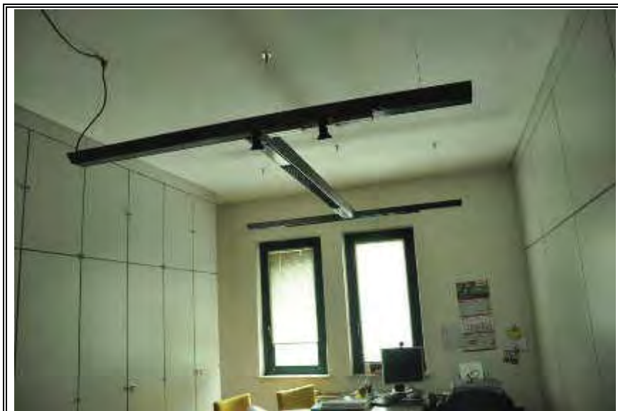
Foto n. 9 - Piano Terra - Vano 1
