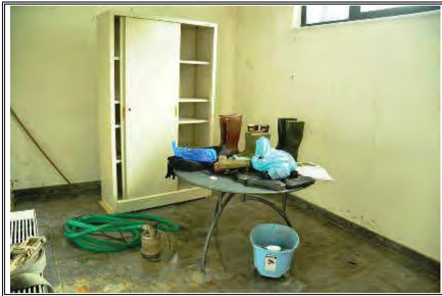
Foto n. 4 - Piano Seminterrato - Vano 4
