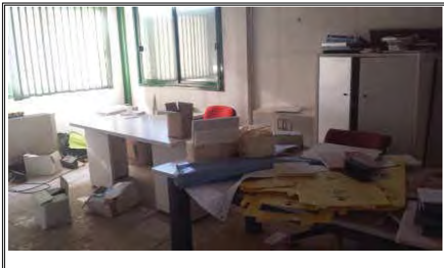
Foto n. 51 - Palazzina uffici secondari – vano 2
