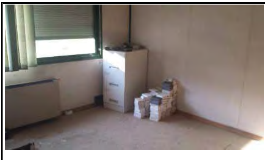
Foto n. 63 - Palazzina uffici secondari – vano 8
