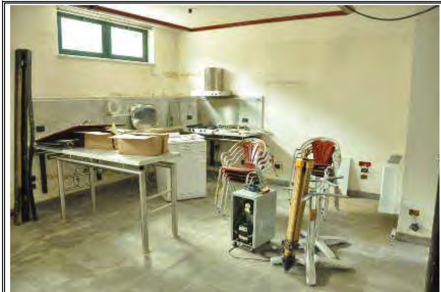
Foto n. 5 - Piano Seminterrato - Vano 5
