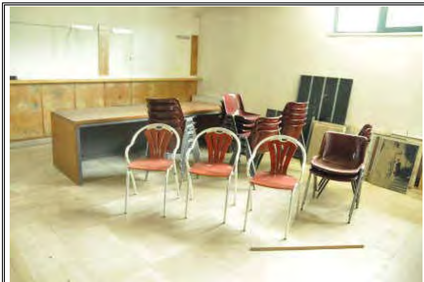
Foto n. 3 - Piano Seminterrato - Vano 3
