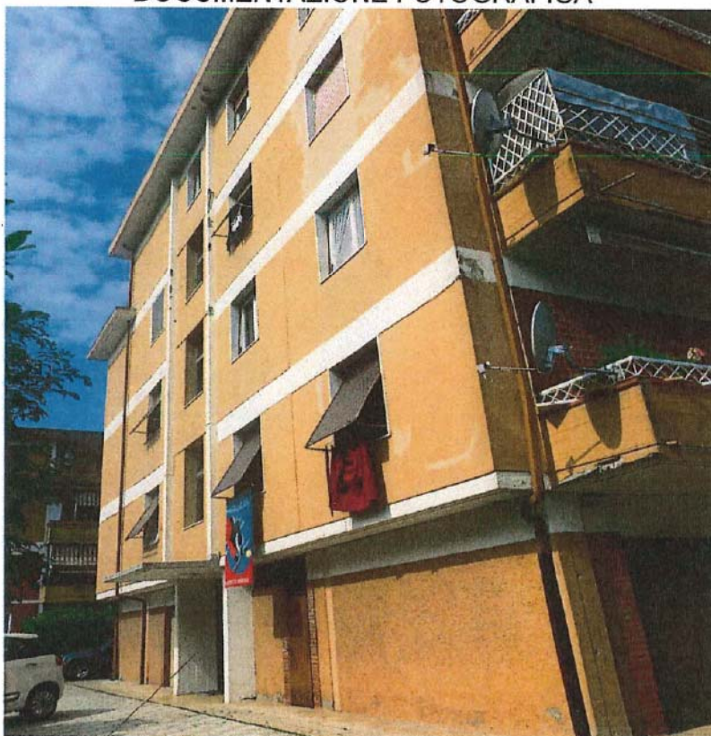
Ingresso all'edificio condominiale – Prospetto est -
