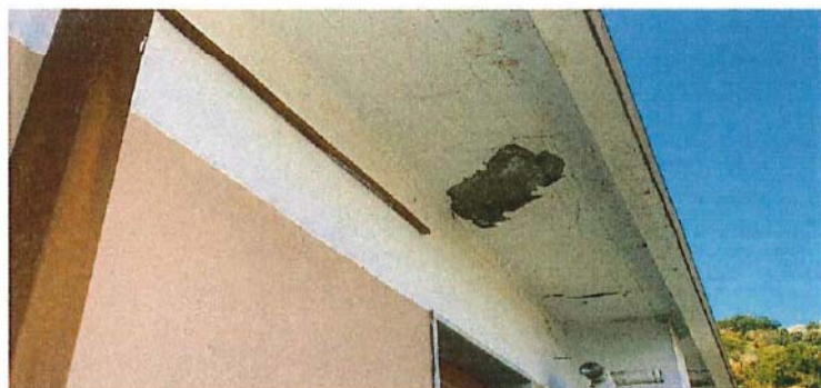
Particolare del sottogronda
